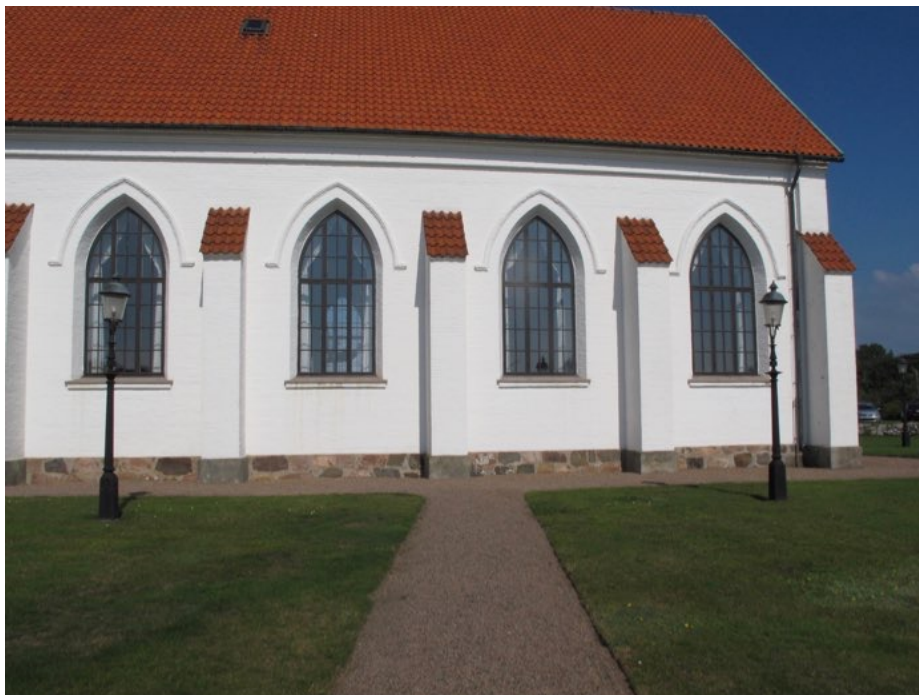
Sydfasaden östra delen
