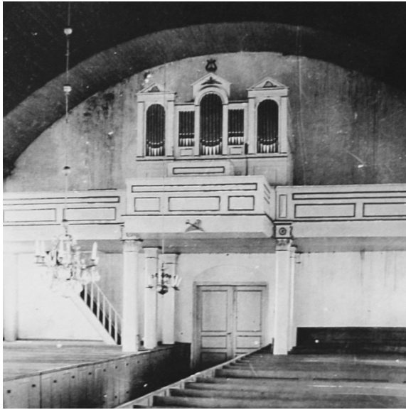
Läktaren efter 1912 och före 1930. Öppen trappa till läktaren. Utbyggnad mitt på läktaren för orgelns spelbord. Det mycket mörka taket är svårt att förklara. Kan det vara sot från kaminerna?
