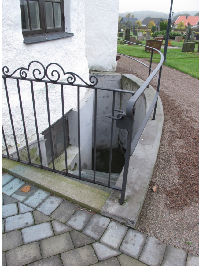
Trappa till pannrummet
