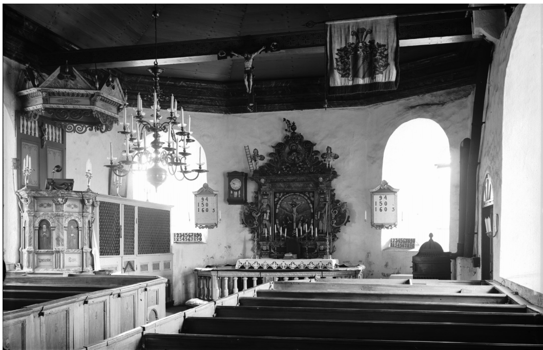
Håltå kyrka innan renoveringen 1950
