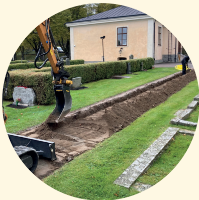
Grävning för fiber på Valbo kyrkogård. Bild: Emelie Forsberg
