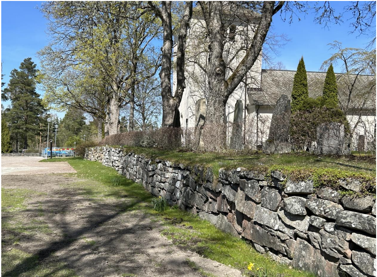
Muren kring kvarteret Gamla Södra, mot nordost.
