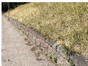
Blockstensmur mot söderlängs Skänningevägen
