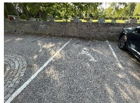
Anvisad parkeringsplats för rörelsehindrade
