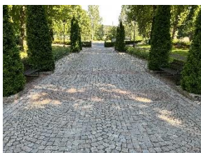
Gången mellan huvudentrén och gravkapellet med smågatstensbeläggning
