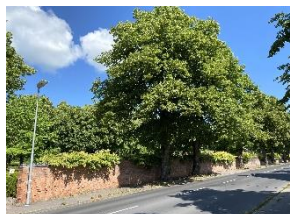
Tegelmur mot norr längs Skänningevägen
