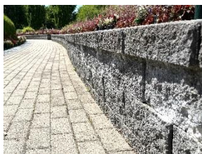
Mur i askgravplats Bäckén
