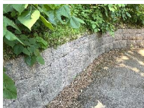
Mur bakom bårhuset
