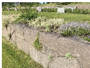
Mur i kv L
