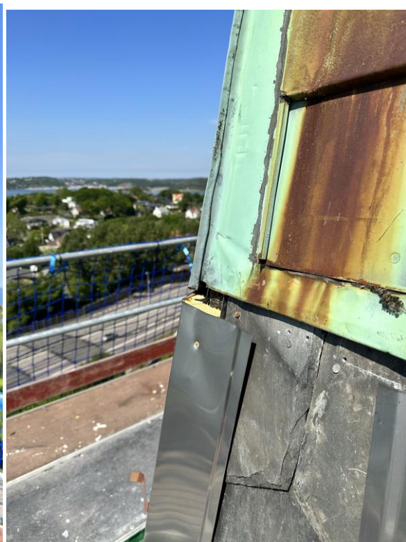
Detaljer på de skadade järnkrokarna samt dess rinningar med rostangrepp.
