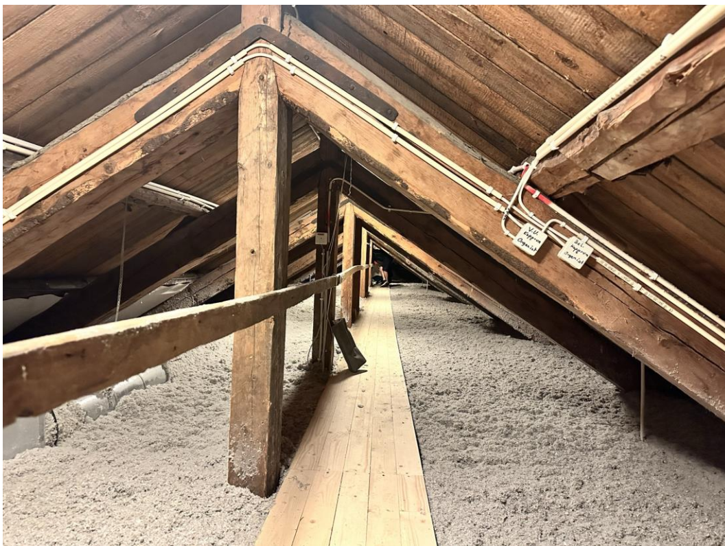
Bild efter ny isolering samt ny gångbrygga byggts och monterats på kyrkvinden.
