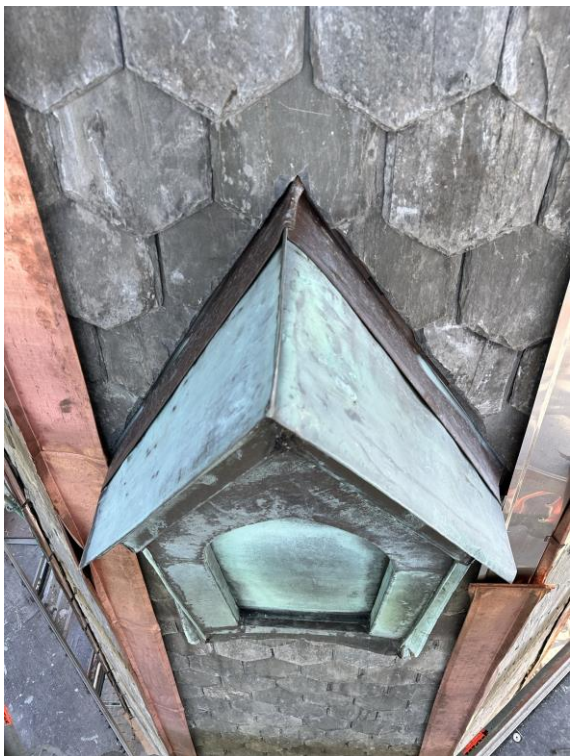
Tornluckor som bevarades med sin äldre kopparplåt.
