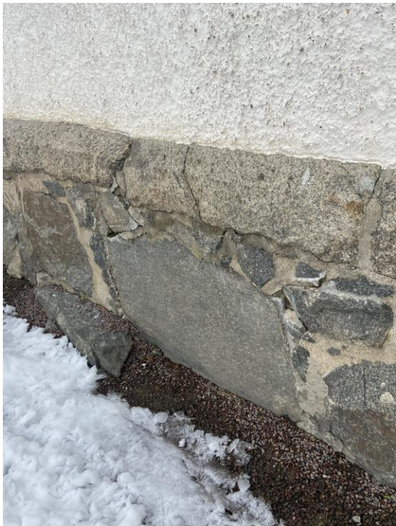
Naturstenssockel och fasad samt solbänk före och efter renoveringen.
