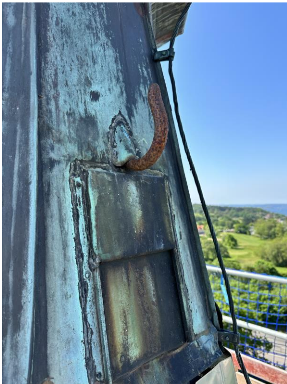
Detaljer på de skadade järnkrokarna samt dess rinningar med rostangrepp.
