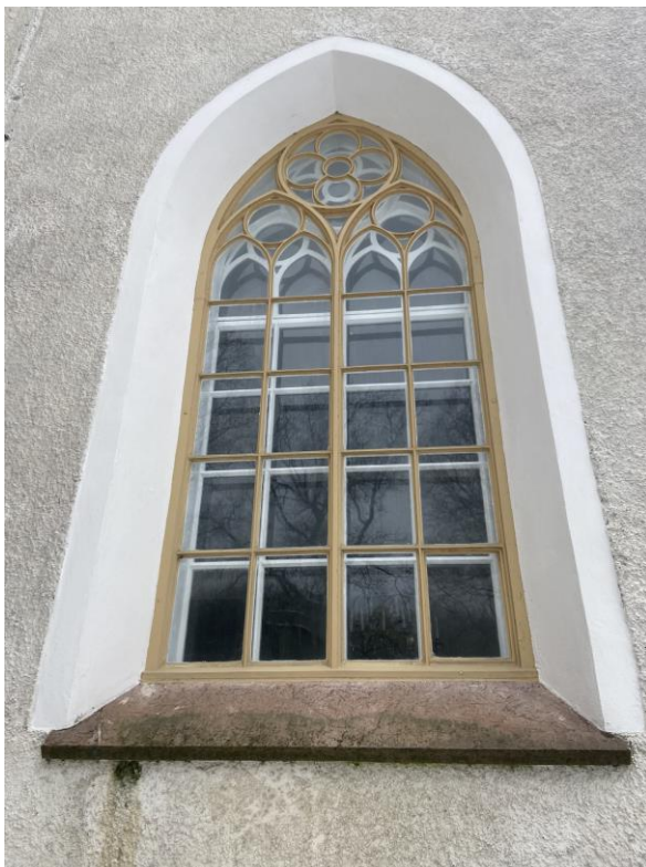
Fönster med solbänkar och triptykfönster av röd och grå kalksten före och efter konservering. Här syns också putsfasader och slätputsade fönsternischer samt omfattningar efter renoveringen.
