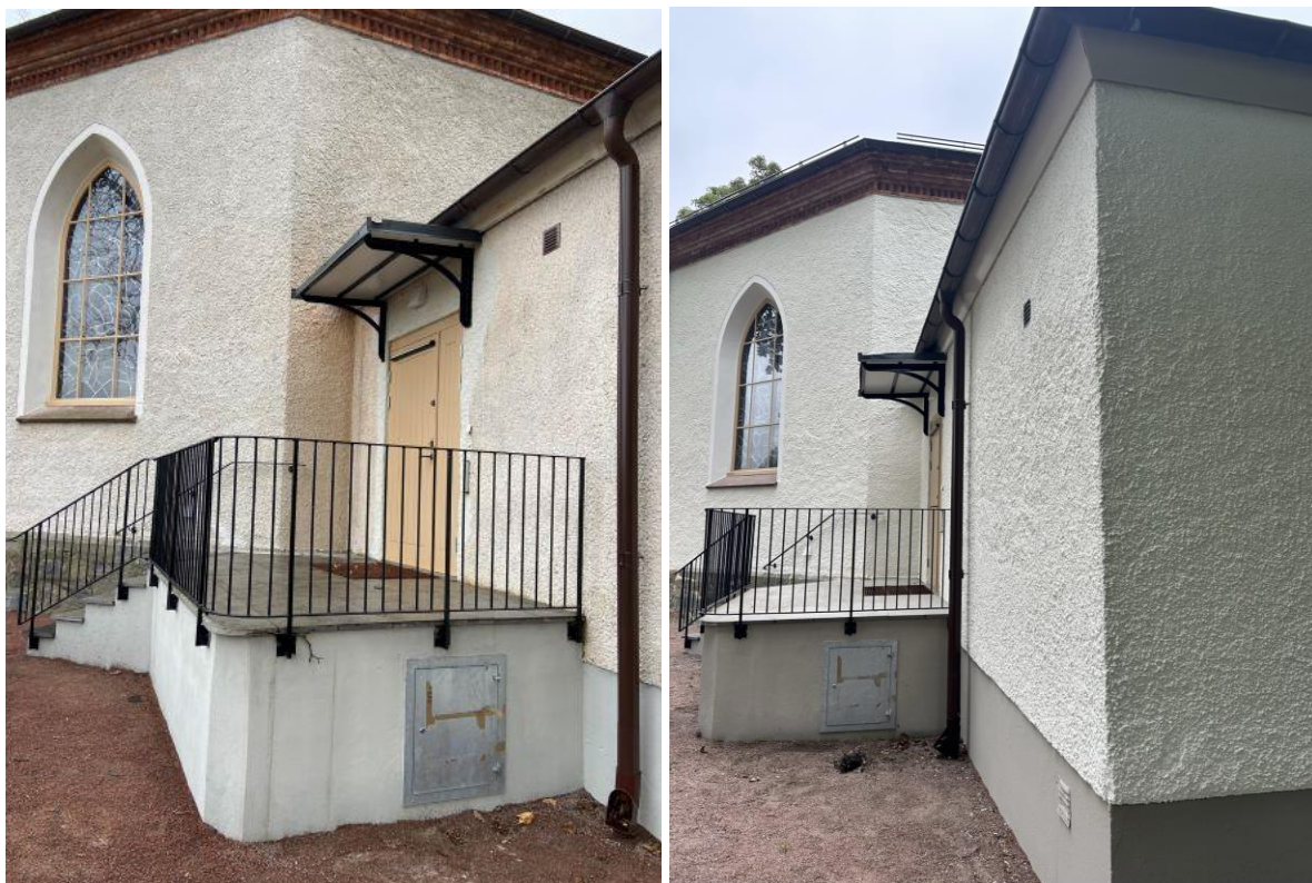
Sakristian före och efter renoveringen. Sockeln och takfoten har målats. Likaså fasaderna.
