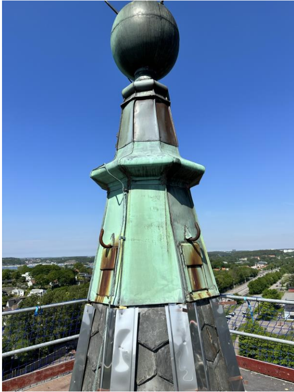
Bilder under arbetets gång med plåtarbetena. Här syns de rostiga krokarna som togs bort då de skapade rostangrepp mellan materialen plåt och järn.
