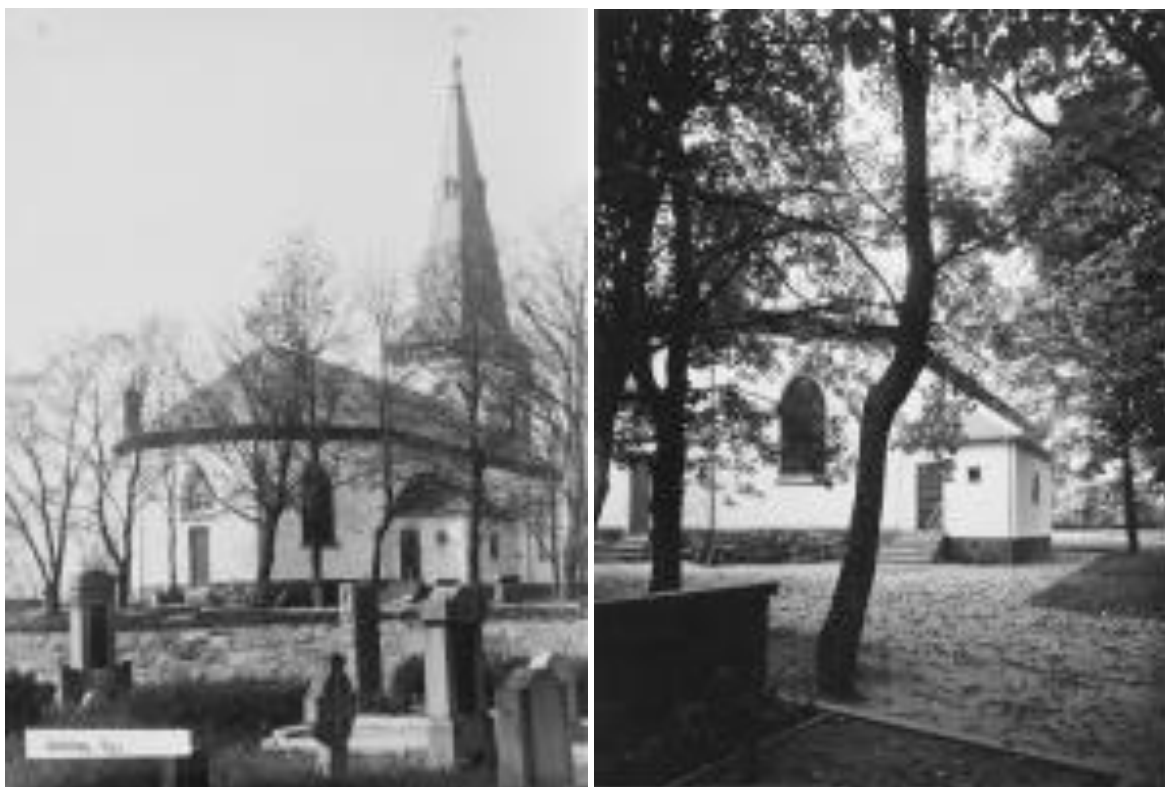
Foto på Askims kyrka med sakristians 1940-talsutseende. (Foto från RAÄ, open arkiv). Entrén då var placerad i söder och ett fönster fanns i östra fasaden.
