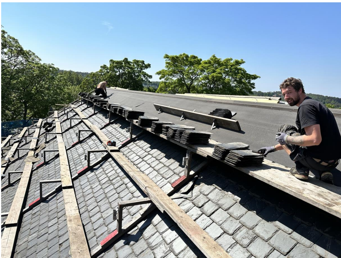
Ny underlagspapp är lagd, likaså utbyte av rötskadat virke och läkt inunder pappen. Skifferarbetet pågår.
