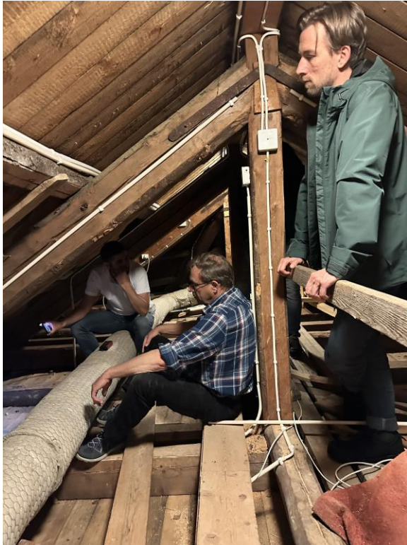
Diskussion pågår gällande lösningen av att uppnå ett släpp mellan ny isolering mot kyrktak och från murkrönen. Bilder efter att sågspånet tagits bort.
