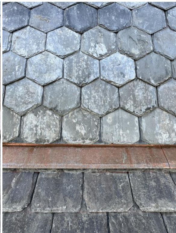
Detaljer av nytt/återanvänt skiffer från Grythyttan som lagts på tornet. Både sexkantigt och rektangulärt i sin utformning finns.
