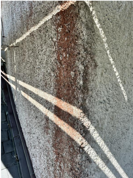
Omfattande rödalgsanfrepp på spritputs i öster. Skador i tornets dekorerade takfris av gult tegel.
