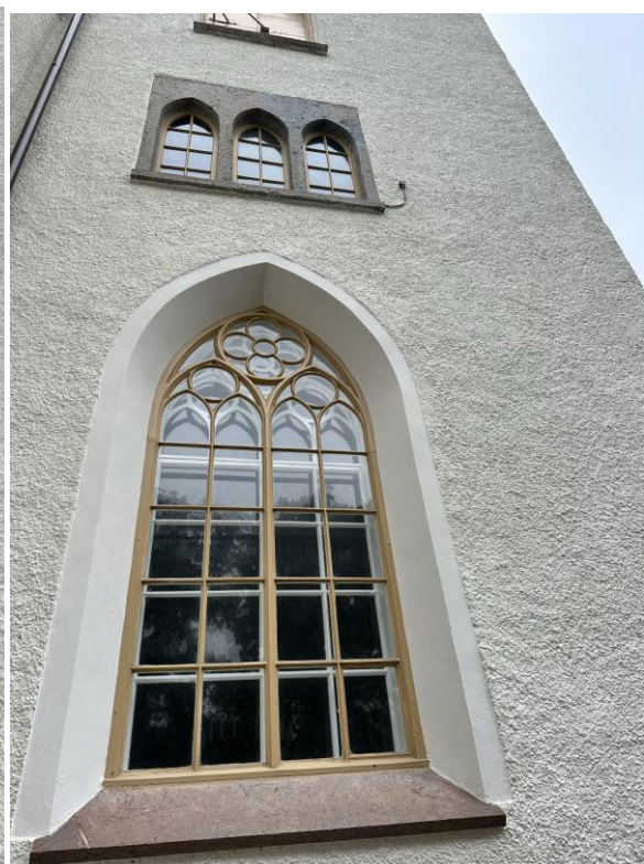
Fönster med solbänkar och triptykfönster av röd och grå kalksten före och efter konservering. Här syns också putsfasader och slätputsade fönsternischer samt omfattningar efter renoveringen.
