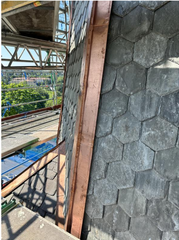
Detaljer på plåtarbetena. Th syns de bearbetade och dekorerade tornluckorna av kopparplåt.
