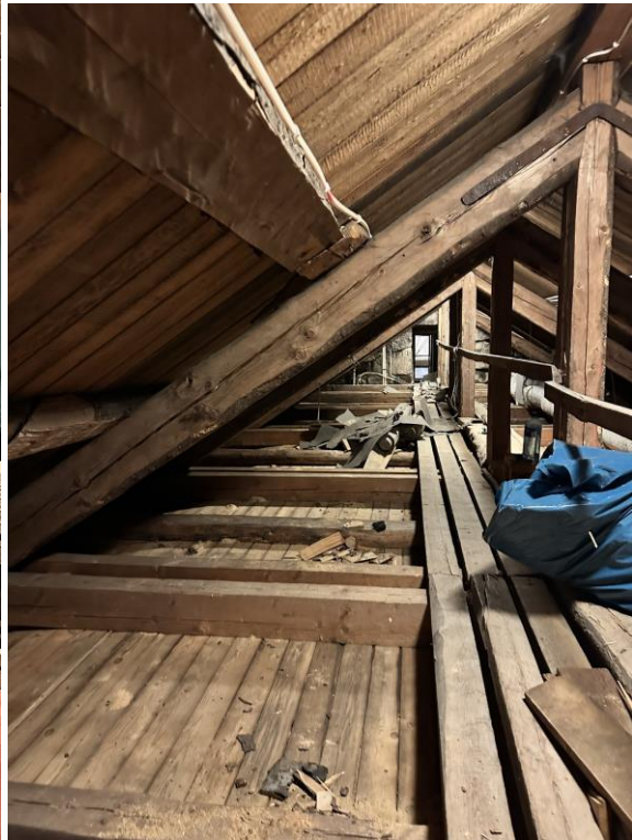
Diskussion pågår gällande lösningen av att uppnå ett släpp mellan ny isolering mot kyrktak och från murkrönen. Bilder efter att sågspånet tagits bort.
