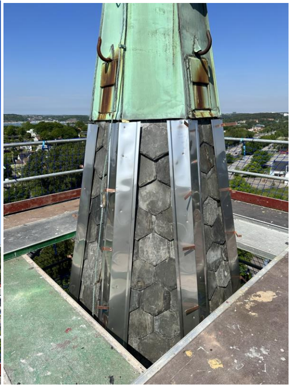
Bilder under arbetets gång med plåtarbetena. Här syns de rostiga krokarna som togs bort då de skapade rostangrepp mellan materialen plåt och järn.
