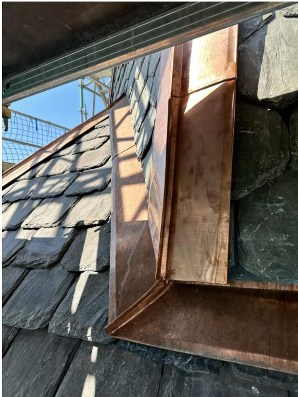
Bilder på ny kopparplåt som lagts på samtliga nockrännor på tornet.
