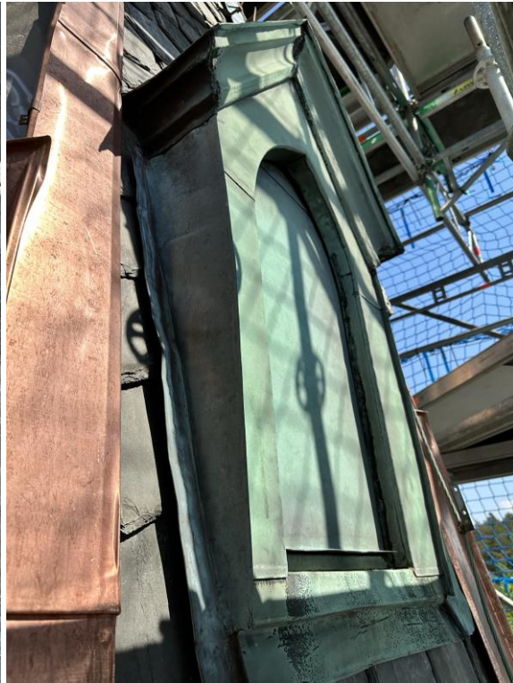
Detaljer på plåtarbetena. Th syns de bearbetade och dekorerade tornluckorna av kopparplåt.
