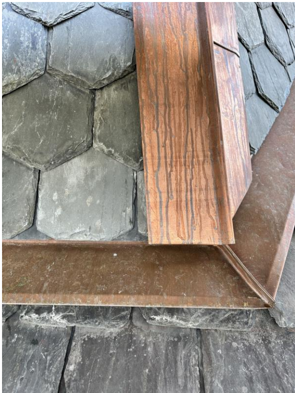
Detaljer av nytt/återanvänt skiffer från Grythyttan som lagts på tornet. Både sexkantigt och rektangulärt i sin utformning finns.
