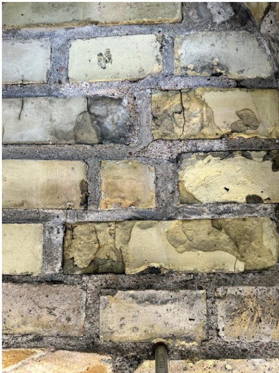
Sprickor och frostskador i teglets ytskikt, fogsläpp. Återanvänt tegel till kompletteringsarbetena.
