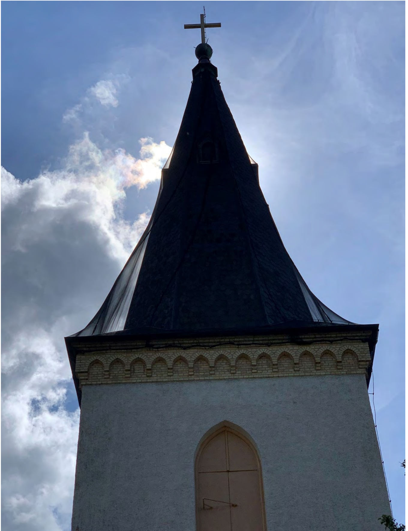
Tornet var inklätt i ett nät under en längre tid, för att minimera risken för nedfallande skiffer.
