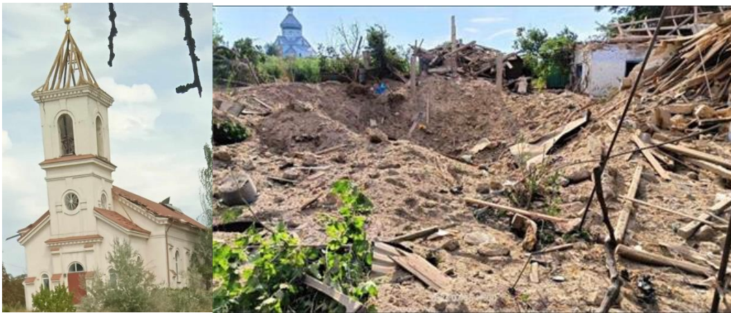
Tyska kyrkan har skadats och dess pastorexpedition är totalförstörd.
