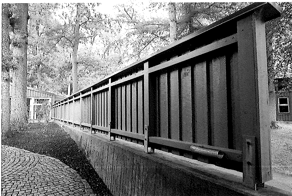
Figur 35 – Planket som löper från Bokens kapells väntrum (syns till vänster i bild) ner mot söder. Här står det på en gjuten cementsockel.
