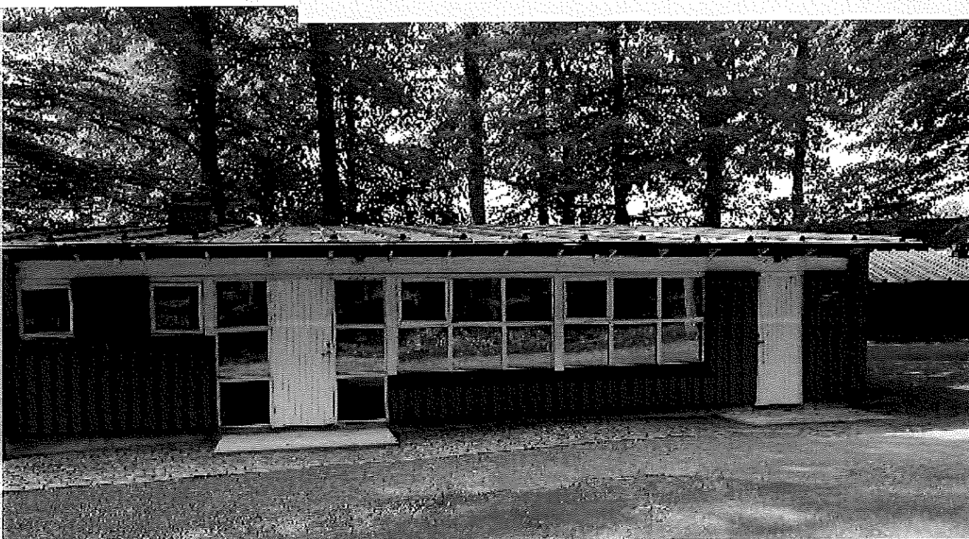
Figur 18 - Expeditionsbyggnadens framsida mot gången som löper längs anläggningens östra sida. Till vänster är ingången till själva expeditionsbyggnaden. Höger dörr utgör ingång till huvudcentralen för el.
