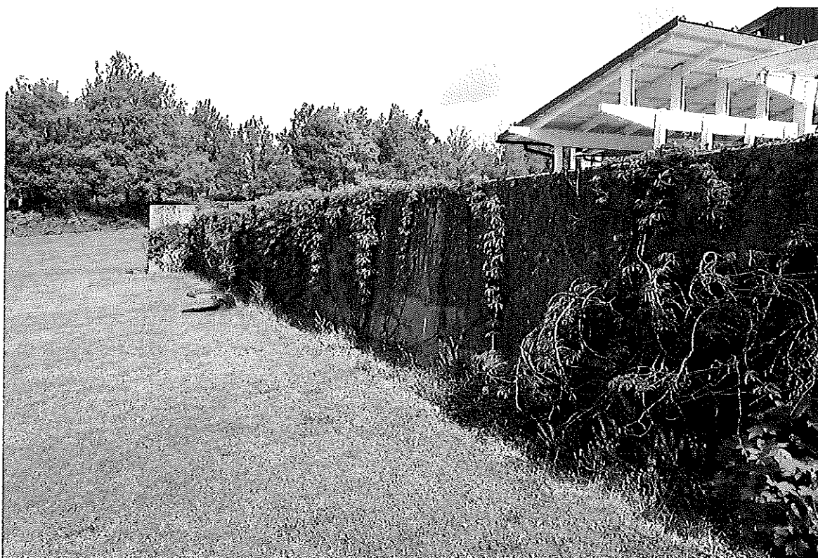
Figur 21 - Gjutna betongmurar vid huvudbyggnaden med rådhusrin.
