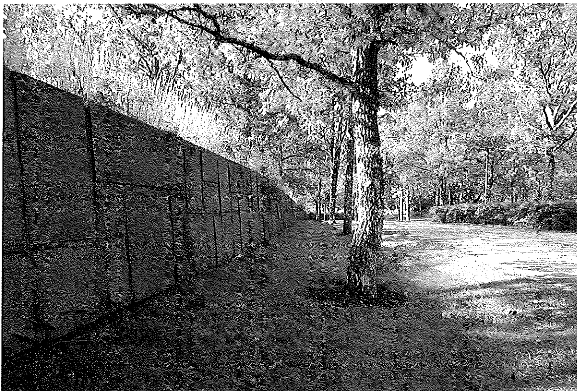
Figur 20 - Stödmur med kvaderstenar som löper längs med infartens västra del.
