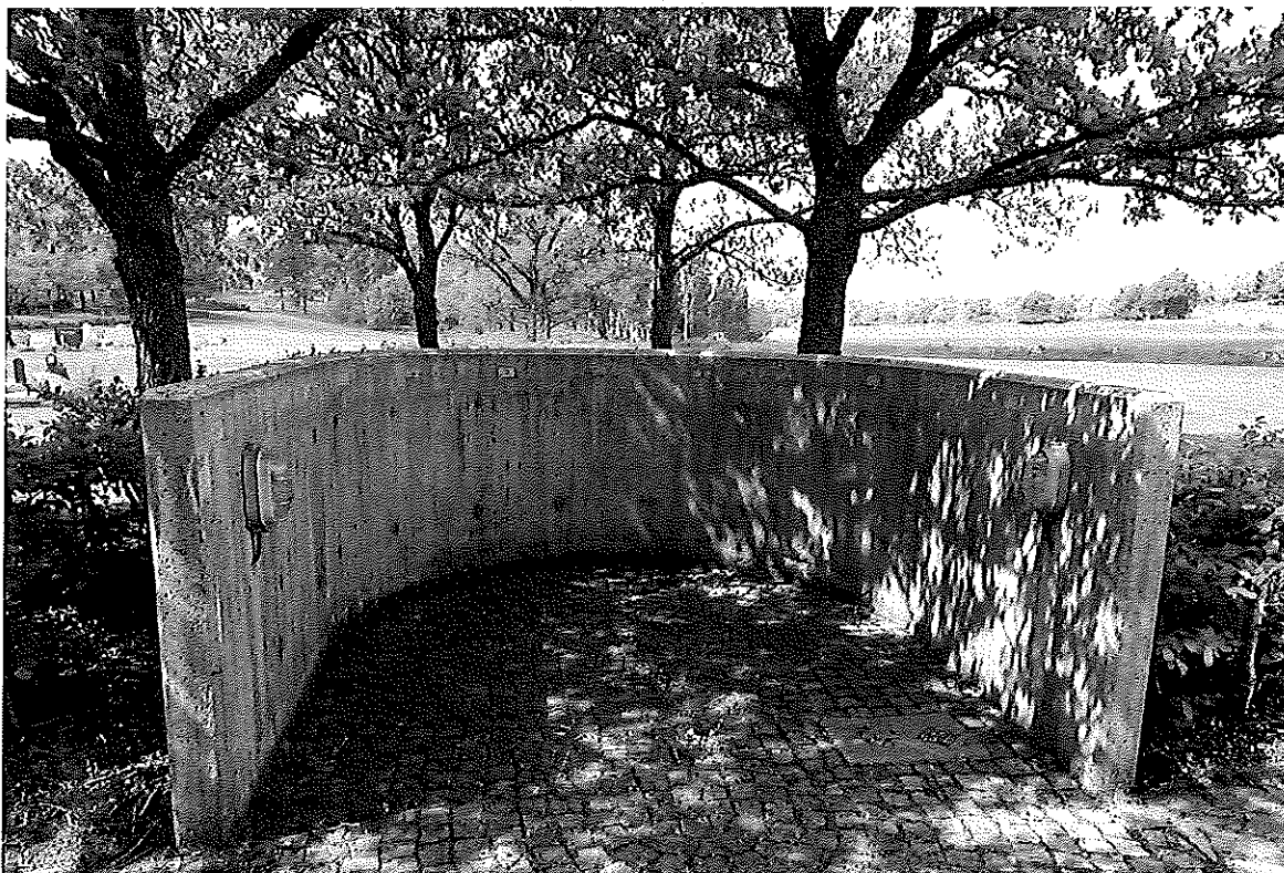
Figur 22 - Gjutna mur kring plats för en servicestation som kan tas i bruk framöver.
