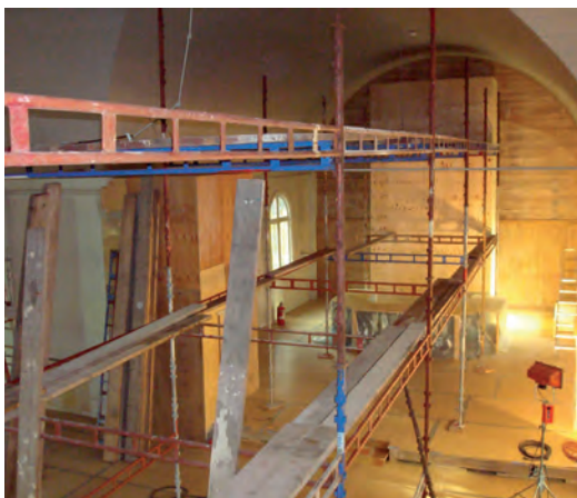
Koret under renoveringen 2007-08. Foto: Bo Hagberg.
