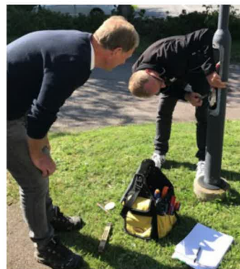
Elsäkerhetsarbete pågår under överinseende av vaktmästaren Curt Fredin (S:t Johannes-kyrkan).
