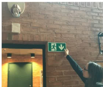
Vaktmästare Sonja Andersson i full färd med skyltning av nödutgångar i S:t Johannes kyrkorum. Det gäller att göra en dold installation, utan synliga kablar etc.
