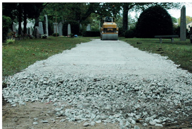
Bärlager på Södra Kyrkogården under komprimering.
