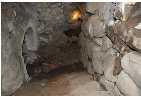
Trappa med till vänster murad vägg mot källaren och till höger kallmurad vägg mot gårdsplanen.
