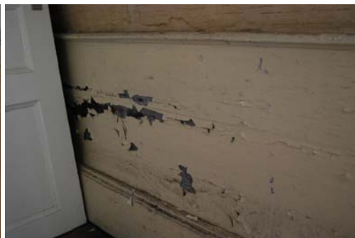
Under flagnande färgskikt syns i många rum en blå färg, som här på bröstpanelen i pigkammaren.
