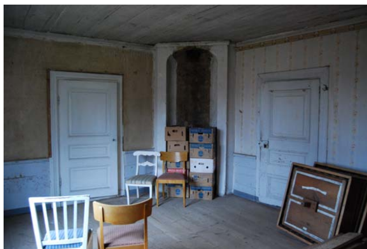
Huset har värmts upp med kakelugnar. Två av dem är nerplockade av rasrisk och förvaras i kartonger.
