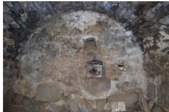
Den inre källarens yttervägg med nischer, däribland ventilationsöppning.
