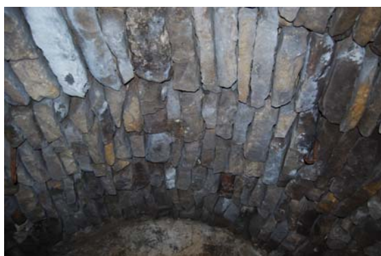
Den inre källarens takvalv.
