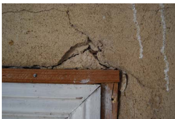
Ett par olika putslager på väggen invid dörren till salen.
