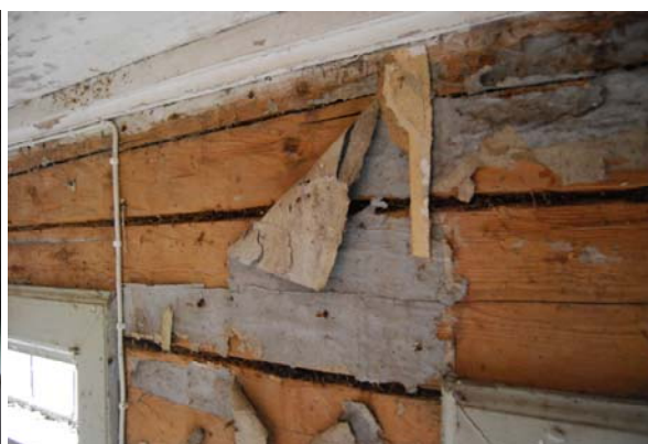
Rester av ursprunglig tapet av lumppapp på ytterväggen.
