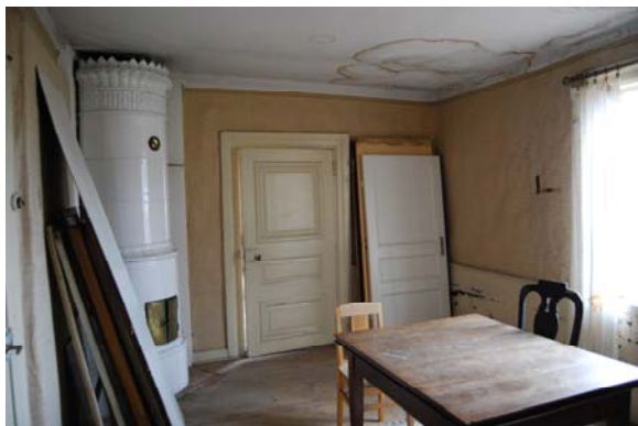
T.v. Vatten- skador i papptaget.
