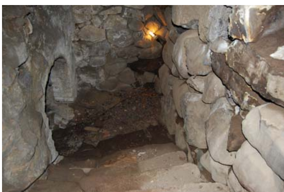
Källartrappan med t.v. den murade väggen.
