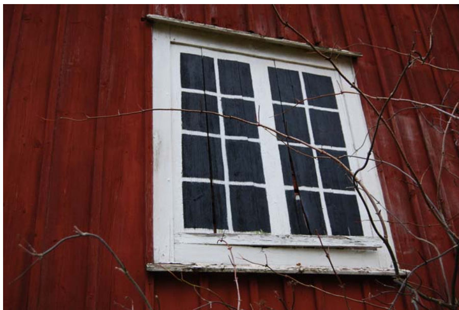
Ett målat blindfönster med 16 små rutor på östra gaveln. Har byggnaden från början haft fönster med dylika smårutor, vilka senare bytts ut mot de nuvarande fönstren med 1800-talsbeslag?
