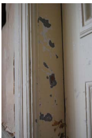
Uppe t.v. Beige tapet från 1920-30-talet. Uppe t.h. Brunröd färg på golvet i hörnen. Nere t.v. Fönsterkarmarna är gjorda för innanfönster. Nere i mitten. Underliggande blå färg på dörrkarm. Nere t.h. Kakelugnen från 1800-talets mitt eller senare del.
