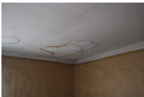
T.v. Vatten- skador i papptaget.
