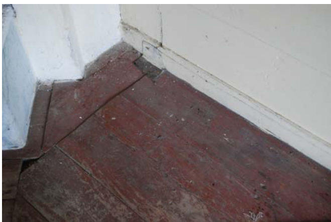
Idag är golven skurgolv men i två rum – salen och sydöstra rummet – finns rester kvar i hörnen, som visar att golven varit målade rödbruna.
