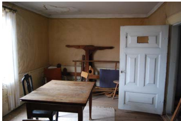
T.v. Vatten- skador i papptaget.
