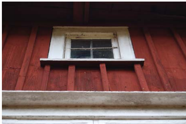
Ett av vindsfönstren, här blyspröjsat med stormjärn.
