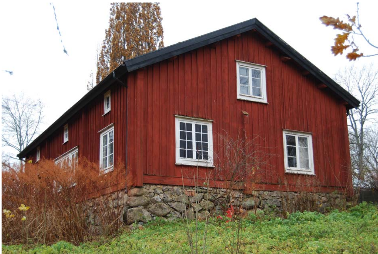
Lundby gamla prästgård från landsvägen. På baksidan syns de tre fönstren i salen.
