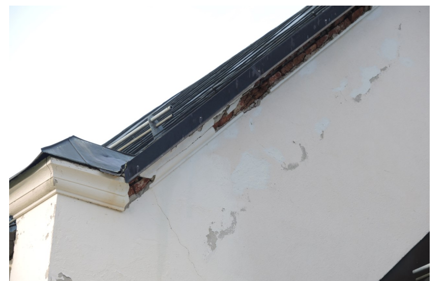
De kommande arbetena på kyrkan omfattar bland annat putslagning och målning av fasader och fönster.
