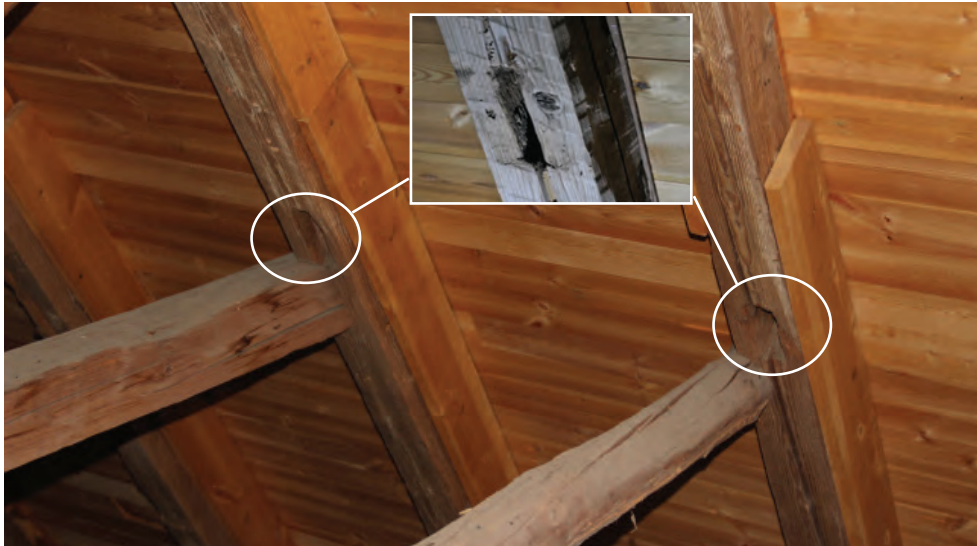
Bilden ovan visar tapphål i höghenen, eventuellt efter intappade saxade stödben från en förmodad äldre konstruktion.
