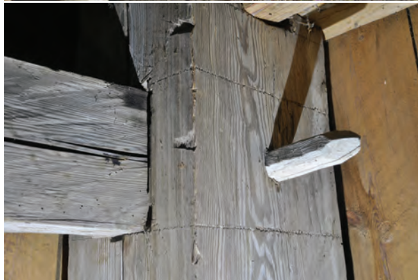
Hörnben och tvärplank upptill i konstruktionen. Foto: Daniel Eriksson.
