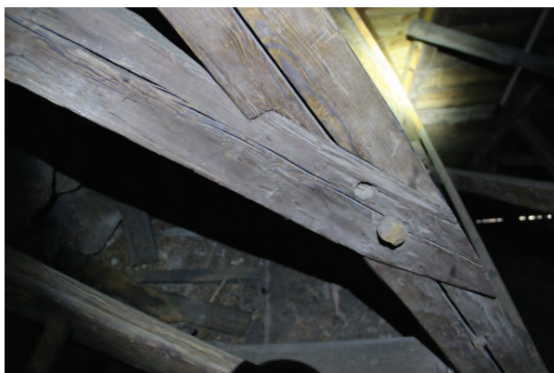
Ovan är en bild på förbindningen saxkryss och högben. Till höger en bild på stödbenets möte med högbenet genom husad knut med nacke.
