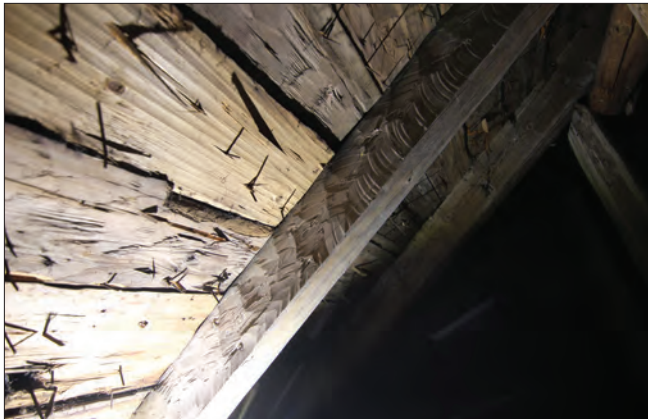
Figur 14. Högben med bebuggning i olika riktningar och tacktrobräda bearbetad med skeave.
