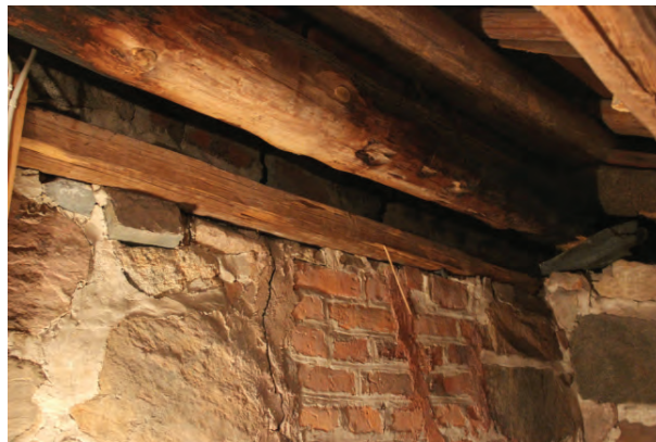
Halvklova som vilar på utskjutande stenar i murverket.
