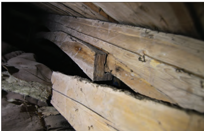
Figur 15. Valvbåge som är L-formad i genomskärning vid infattningen i hanbjälken och högbenet. Här syns också att en fals tältits ut i högbenet för inpassningen.
