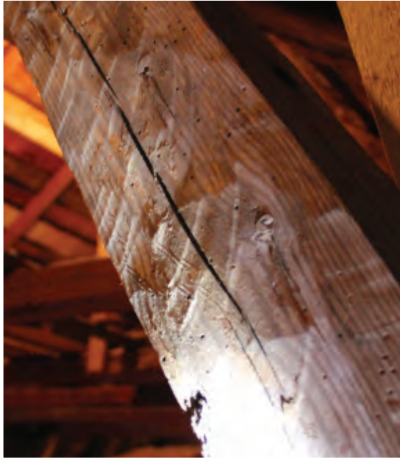
Spröttjält högben med dymlingshål, återanvänt som sträva.
