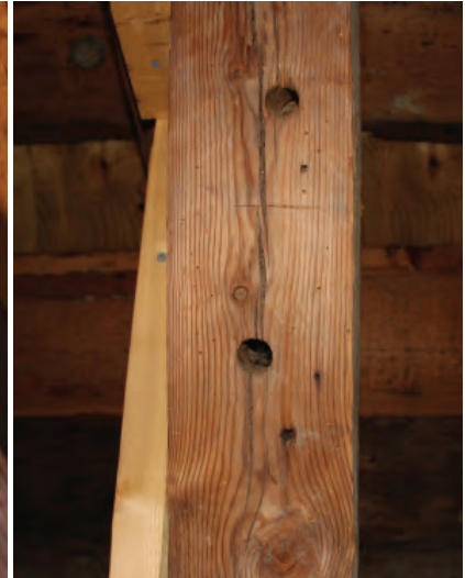
Spröttjält högben med dymlingshål, återanvänt som sträva.
