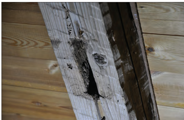
Figur 10. Urtag i högben för de före detta korsande stödbenen. Tapphålet är genomgående och låsning saknas. Tryckmärken efter stödbenet kan urskiljas. Foto Daniel Eriksson.
