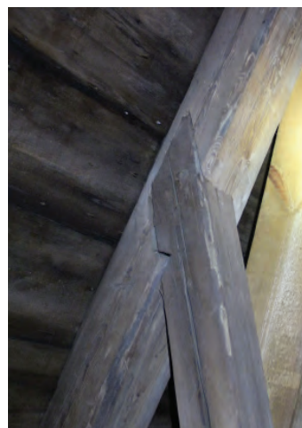
Ovan är en bild på förbindningen saxkryss och högben. Till höger en bild på stödbenets möte med högbenet genom husad knut med nacke.
