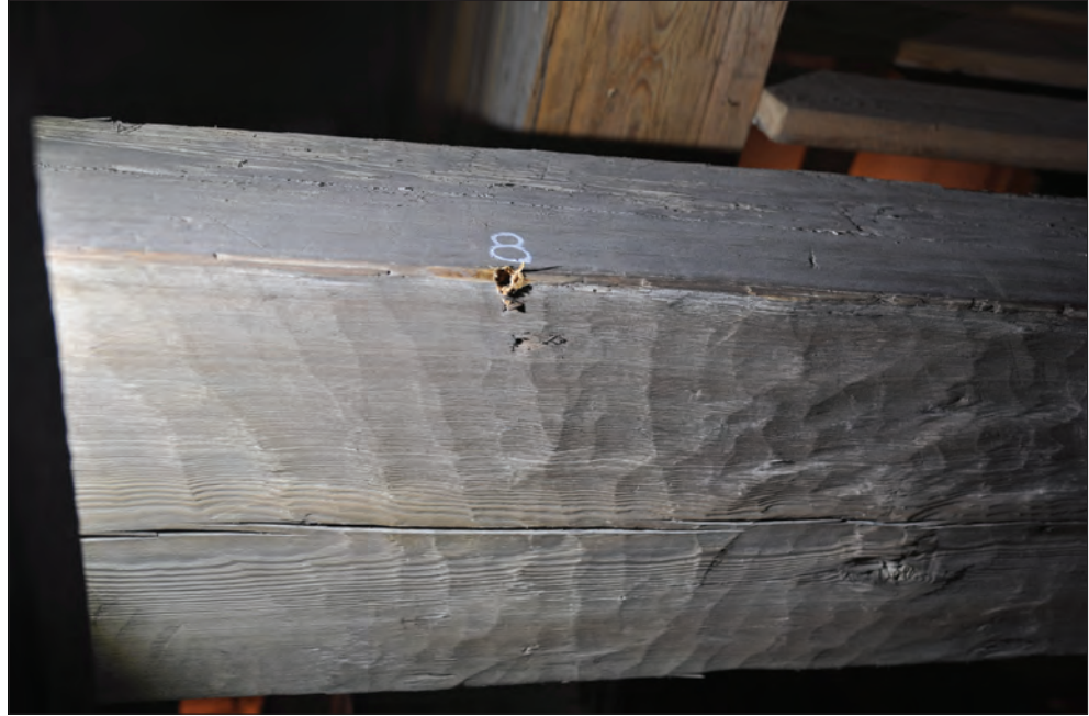
Figur 9. Malungs kyrka. Ytan har bearbetats med med en typ av hyvel, skave. Foto Daniel Eriksson.
