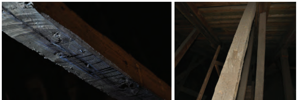
Det f.d. högbenet är sprätttält, i end sidan syns spikhål och på andra sidan ett tapphål. Foton: Daniel Eriksson.
