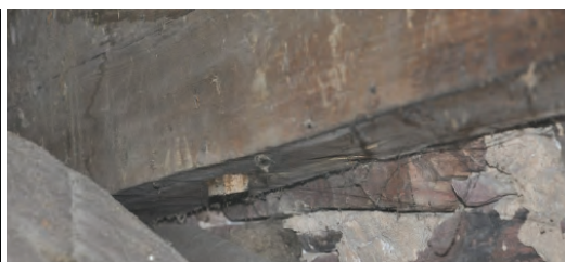
Fotot till vänster visar ett långsgående spår i timret. Man har först borrar sedan huggt rent. Det som troligen varit undersida har en konkav yta. Bilden ovan visar ett rektagulärt hål med dymlingen kvar. Foton: Daniel Eriksson.
