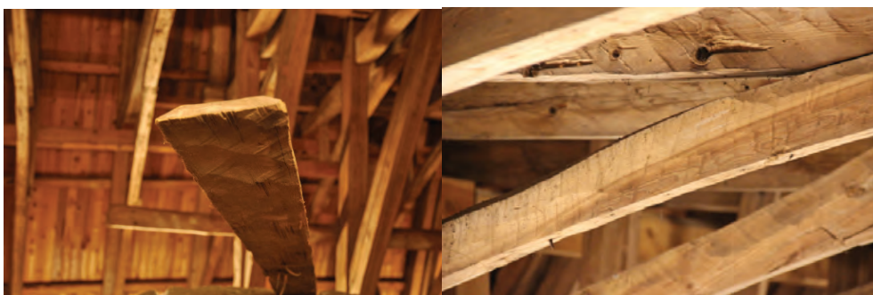
Bilden till vänster visar lösfynd av bräda som kan komma från tunnvalvet. Ena sidan huggen, andra sidan skavd. Foto: Daniel Eriksson. Till höger en närbild på behugningen.
