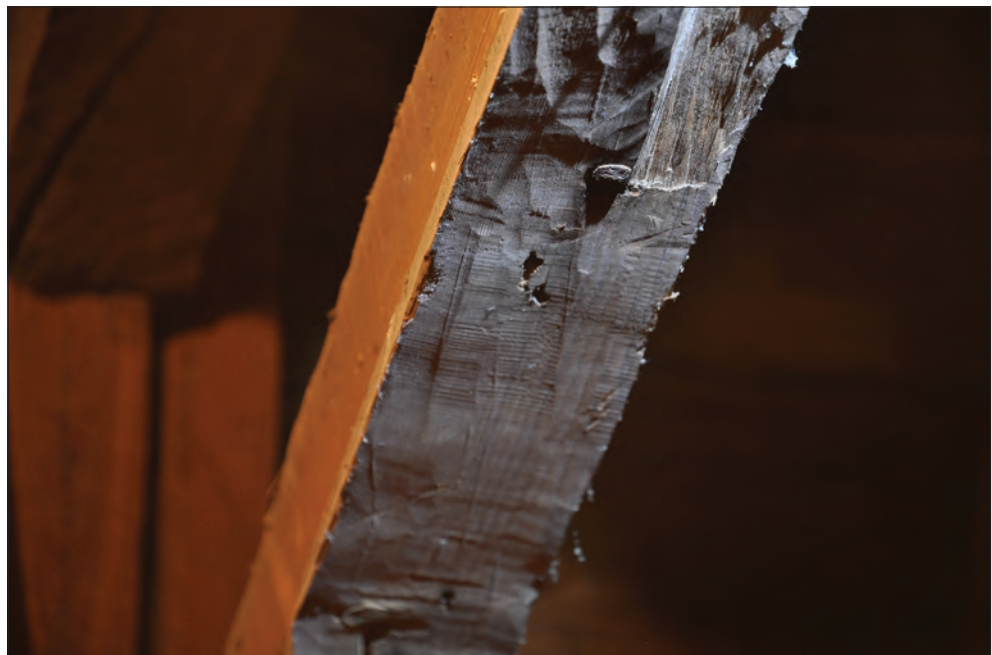
Figur 10. Sala kyrka. Skaven efterlämnar ofta karaktäristiska vibrationsspår. Foto Daniel Eriksson.
