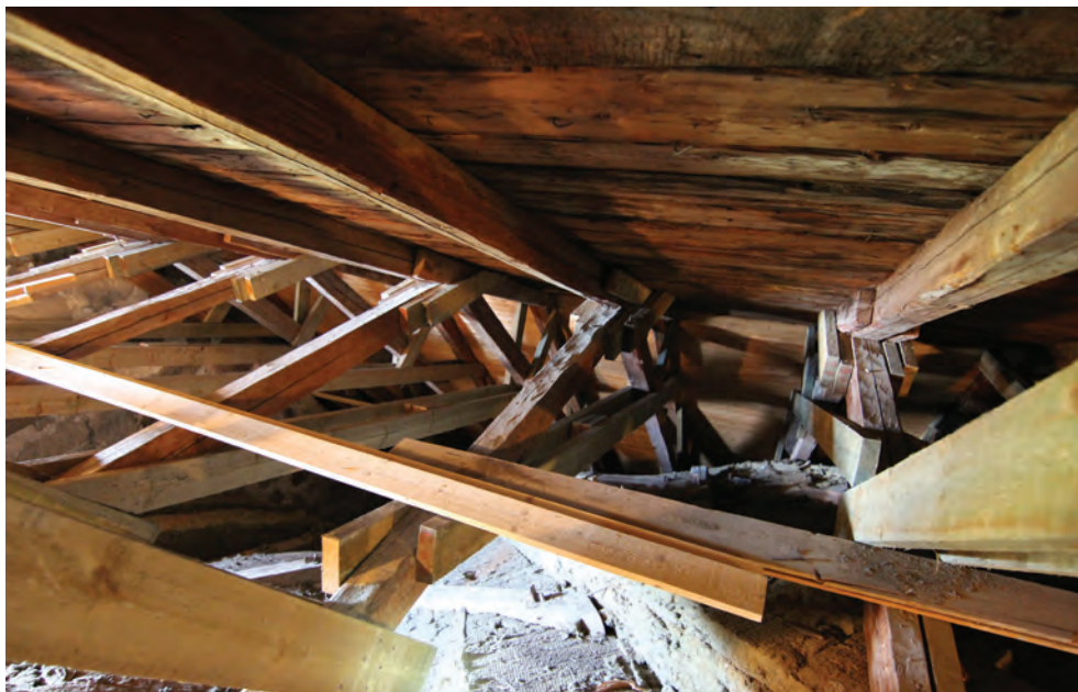
I sydöstra takfallet finns minst tre generationer taktröbrädor; bilade, ramsågade och modern råspont.
