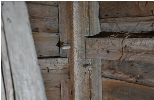
Figur 22. Tvärplank intappade och dymlade i hörnben. Foto Daniel Eriksson.
