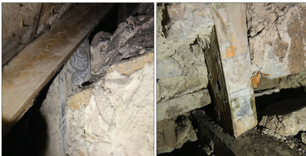
Figur 17. Bemålade bjälkar återanvända som stödben.
