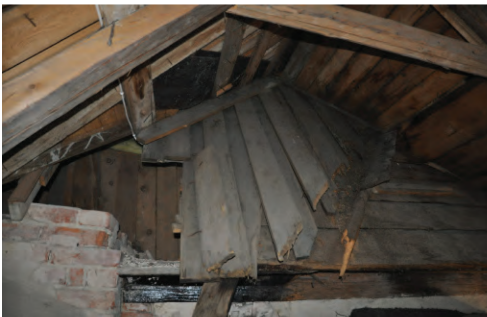
Foto taget på sakristians vind. Det som syns är långhusets äldre brädtak som bevarats. Sakristian är ombyggd, taket har höjts och byggnadskroppen har breddats. Foto: Daniel Eriksson.
