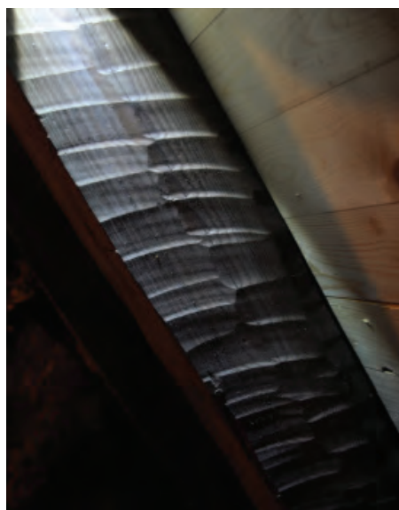
Till vänster, en bit av en sågad bräda med året 1468 inskuret. Skall enligt uppgift ha varit en del av en taktrobräda och förvaras i sakristian. Till höger, sprättält högben. Foto: Daniel Eriksson.
