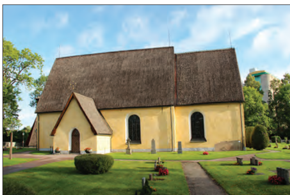
Figur 1. Sala sockenkyrka i augusti 2019. Foto från söder.
