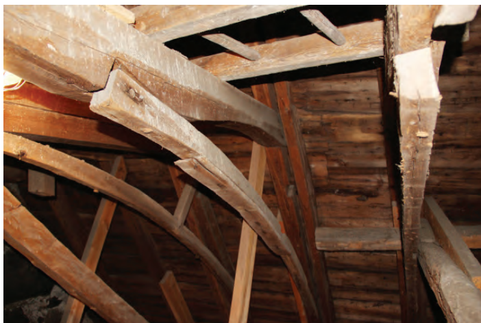
Hanbjälken har en extra bågform på vardera sidan om valvhjässan.
