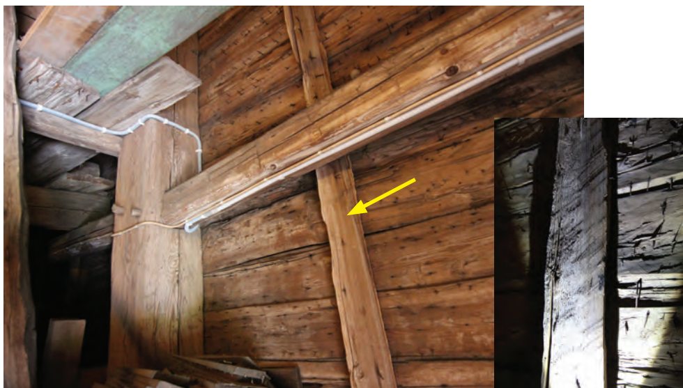
Badelunda klockstapel, konstruktion entréplan. Gula pilen markerar en medeltida sprättäljd bräda som är spikade som stöd åt panelen mellan hörnstolparna. Till höger en detaljbild på behugningen i släpljus.
