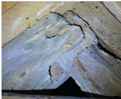
Bilden ovan visar tapphål i höghenen, eventuellt efter intappade saxade stödben från en förmodad äldre konstruktion.
