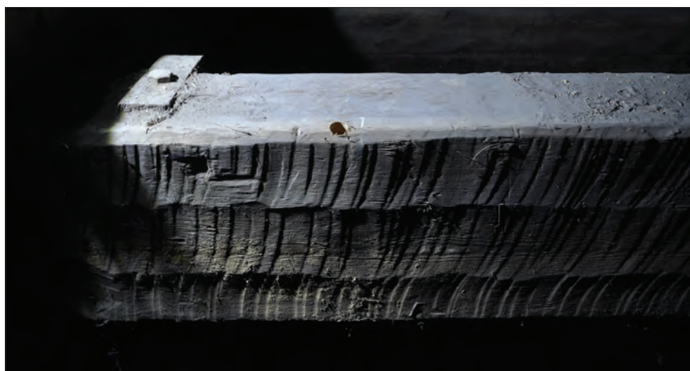
Figur 6. Torsångs klockstapel. Sprätthuggning som är mycket omsorgsfullt utförd i jämna längsgående band. Foto Daniel Eriksson.
