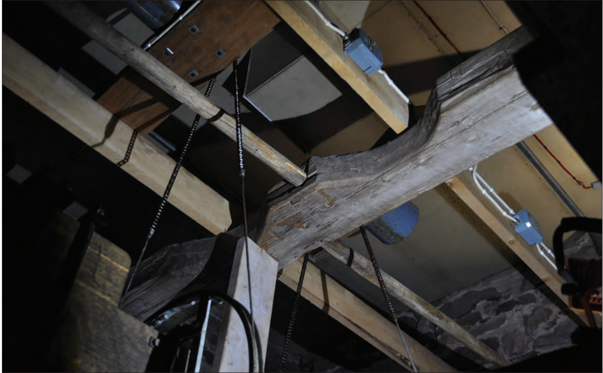
Figur 12. På en centralt monterad bjälke över klockorna finns två kraftiga urhuggningar. Dessa tolkas vara gjorda sekundärt och kanske för att bereda plats att stå vid bjälken för någon tidigare generations fotringning. Urgröpta spår, som tolkas som grepphandtag, finns också på denna stock. Timrets ena bredsida är sprättbuggen och motsatt bredsida bearbetad med skave tvärs över fibrerna. Det finns laxknutar på samma sida som den buggna sidan. Foto Daniel Eriksson.
