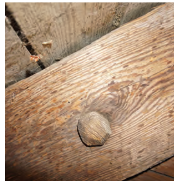
Kor. Spikskalledympling mellan bindbjälke och högben. Foto: T. Mårud.
