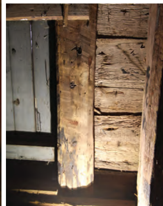
Stolpen närmst panelen mellan ljudluckorna är en återanvänd medeltida sprättäljd bjälke (t.v.). Ljudluckornas foder är av återanvänt medeltida sprättäljt taktrovirke (t.h.).
