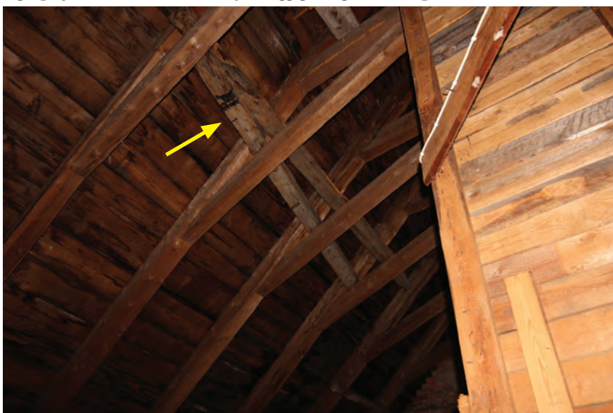
Huggna taktrobräddor upplagda över sakristians takstolar.
