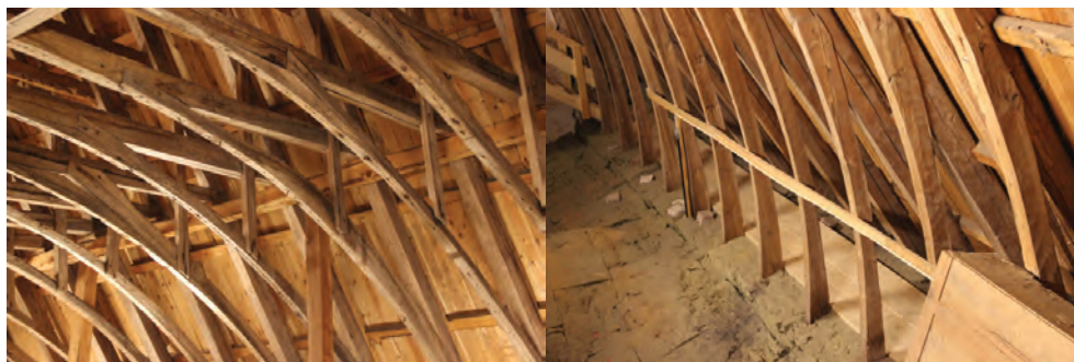
Bilder från taklagets södra sida. Hambjälkar och valvbågar respektive knäböcker med urbildade stödben.
