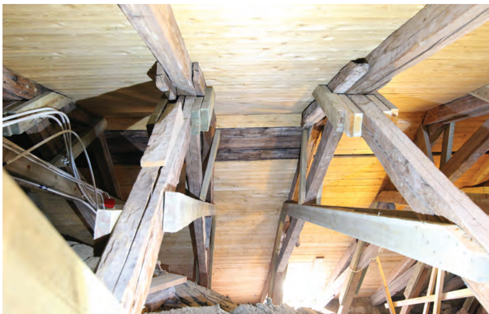
Dingtuna kyrka, långhusets nordvästra takfall. Återanvända medeltida delar i en yngre konstruktion tillsammans med sentida förstärkningar. I stort sett hela taktron mot nordväst är utbytt mot modern råspont.
