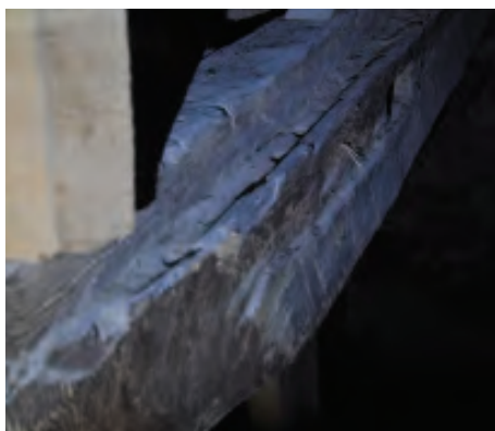
Fotot till vänster visar ett långsgående spår i timret. Man har först borrar sedan huggt rent. Det som troligen varit undersida har en konkav yta. Bilden ovan visar ett rektagulärt hål med dymlingen kvar. Foton: Daniel Eriksson.
