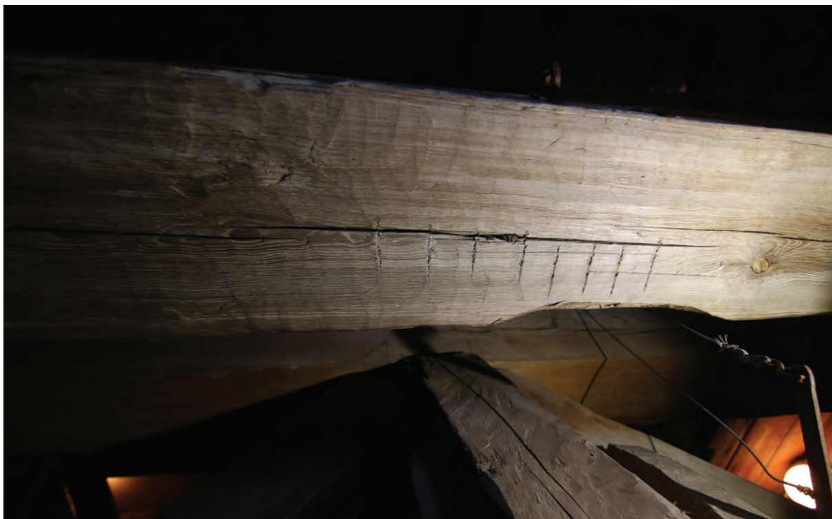
Figur 14. Flera av timren är märkta och det är gjort med yxa, som raka inbygg efter varandra. Kanske gjordes de i samband med att den tidigare byggnaden plockades ner. En kartläggning av dessa skulle kunna tydliggöra ordningen på en del av väggtimret i den tidigare konstruktionen.
