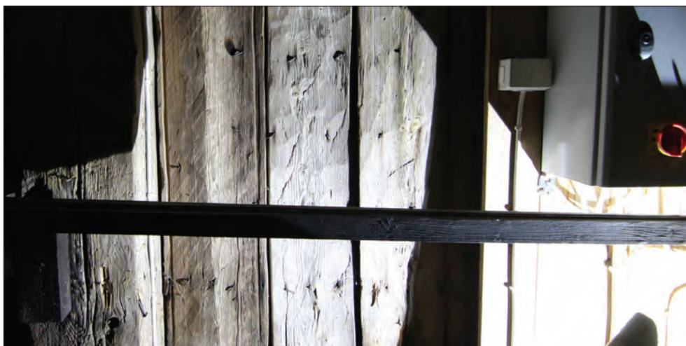
Figur 27. Bilden är tagen i klockvåningen och panelbrädan (till vänster) har medeltida behuggning. Den är sprätthuggen på båda sidorna och på insidan finns huggna, fasade ytor och vatthylvade spår i ytterkanterna.
