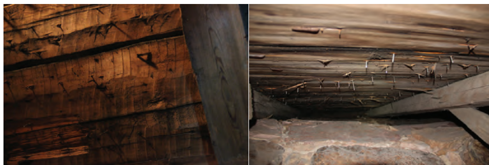
Taktrö som är sprättäljd respektive bearbetad med skave i Malung.
