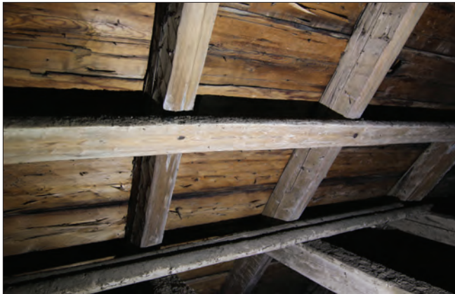
Figur 8. Långdförstyvningar finns från resningen av taklaget. De är omkring 9,60 meter långa, 3,5 cm höga och 12 cm breda.
