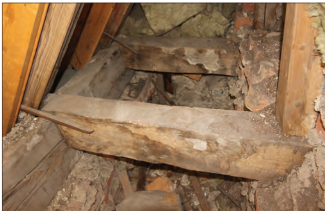
Figur 7. Stickbjälkarna utgjorde tidigare bindbjälkar i en äldre konstruktion. Bjälkarna högs av vid valvslagningen. Virket utgörs av skarpkantad sprätthuggen ek i såväl remstycken som stickbjälkar/bindbjälkar. Högbenen har att glidit ifrån förbindningen, därför har timmerhakar slagits i vid något tillfälle.
