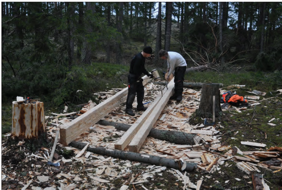
Figur 11. Rekonstruktionen av Södra Råda gamla kyrka. Daniel Eriksson och Karl-Magnus Melin tillverkar sparrar/bögben genom att klyva fram fyra ämnen ur en grövre stock. Foto Daniel Eriksson.
