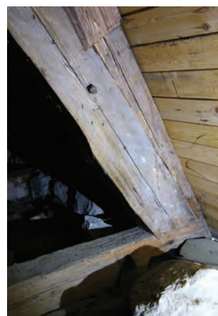
Höghen med kraftigare dimension nedtill och knut med nacke.
