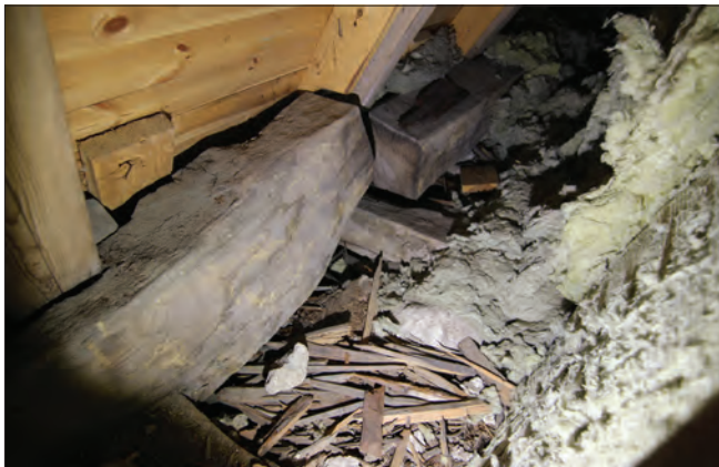
Figur 6. De två styrbjälkarna möts vid takstol 17. De är grovt huggna i trapezoid form och stammens naturliga oregelbundenhet är delvis kvar.
