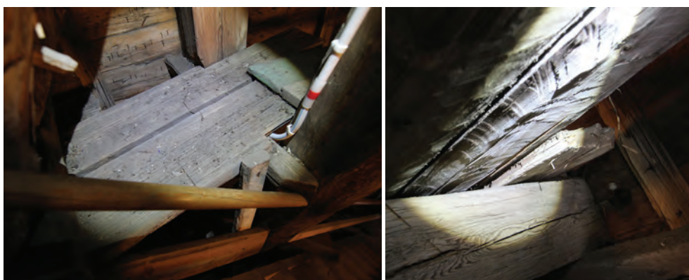
Några av golvplanken, på höger sida ovanför första trappan, är också medeltida. Till höger en detaljbild av deras undersidor och behugningen i släpljus.
