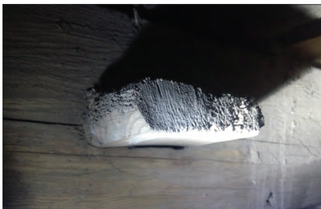
Figur 10. Kvarsittande dymling/tapp. Foto Bengt Bygdén.
