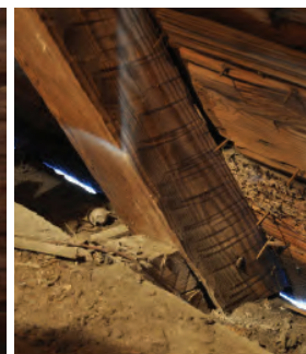
Högbenets möte med stick-hjälken. Sammanfogning genom tapp och slits med spik. Foto: Daniel Eriksson.
