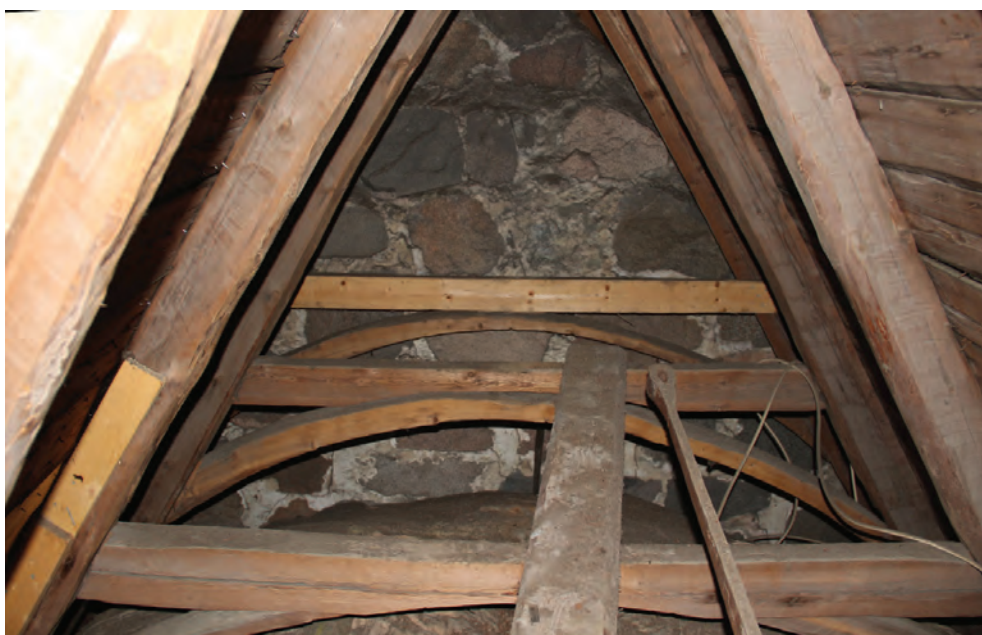
Takstolar över vapenhuset. De två borte valvbågarna är utförda i ett stycke.
