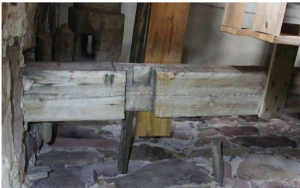
En av de återanvända timmerstockarna i Malung kyrkas torn. Timret har sprätthuggna och skavda ytor.
