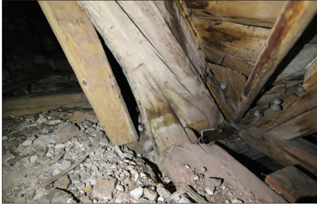
Figur 7. Del av gaveltakstolen i 1300-talskyrkan med en påspikad förstärkning av kraftigare virke på högbenets insida.
