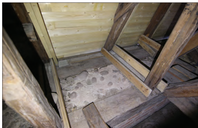
Figur 2. Remstycken i tornet, sannolikt från uppförandetiden.
