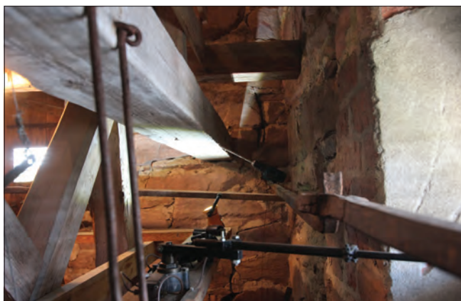
Figur 5. Medeltida bjälke i böjd med klockorna dendrobarras. Foto från norr.
