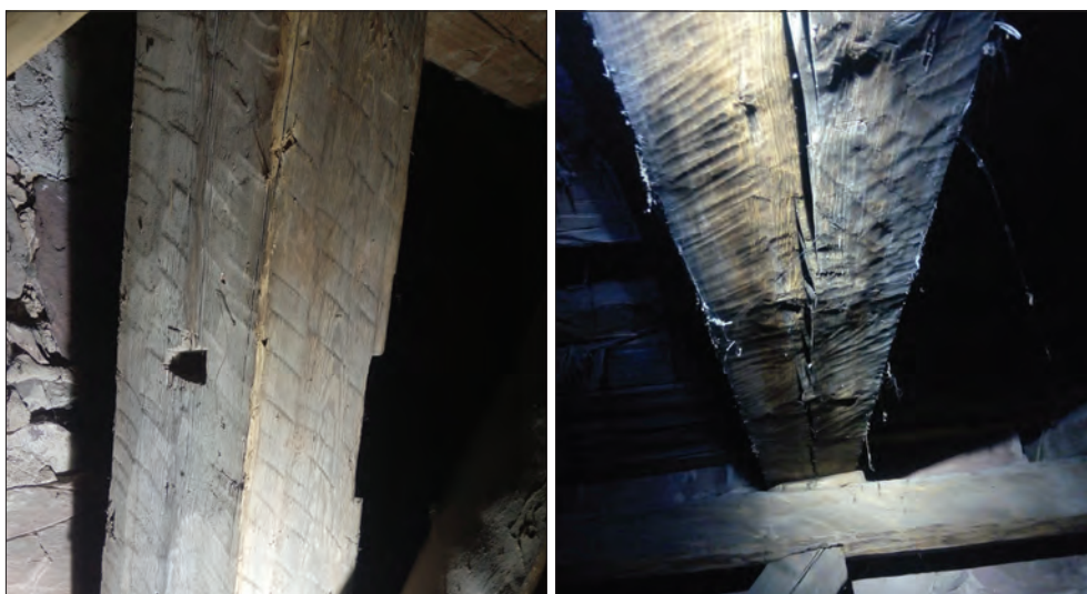
Figur 16. Till vänster syns sprätthugget timmer under klockvåningens bjälklag. Behugningen är utförd i flera jämna band utmed stockarnas sidor och någorlunda vinkelrätt. Till höger syns en timmerstock monterad i klockvåningens bjälklag som liksom flera andra har sin ena bredsida bearbetad med skave. Foto Bengt Bygdén.
