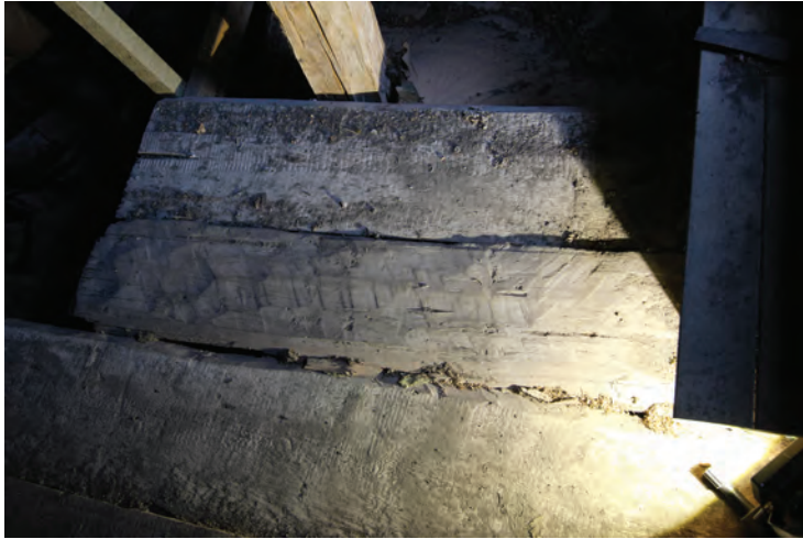
Orsa kyrka, vind över sakristia. Sprättäljd trobräda återanvänd i landgången.
