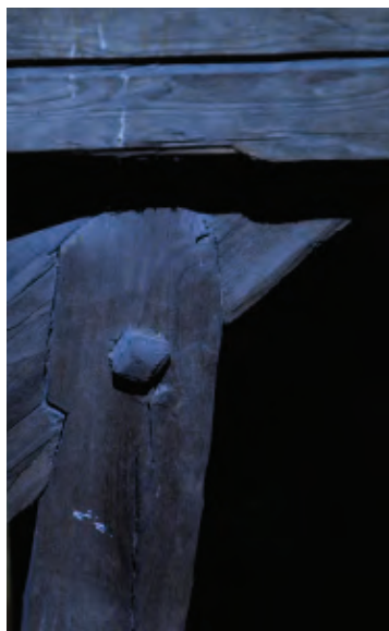
Del av den medeltida takstolskonstionen, långstolen är inte skissad.
