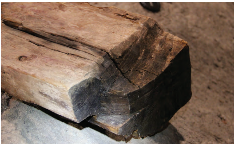
Samma del som ovan. I ändträet finns spåren efter ett hak med en sned och en rak sida samt en huggen avfasning i det som utgjort bjälkens ovankant.
