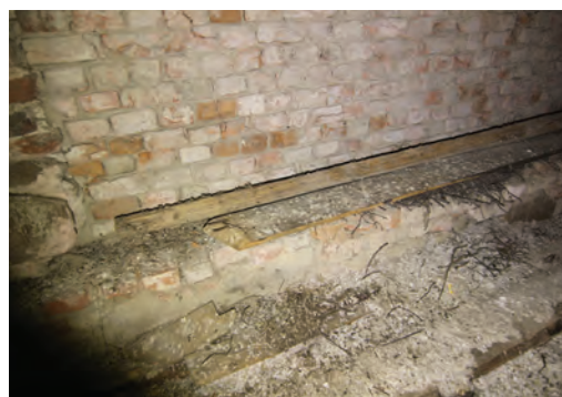
Löst liggande f.d. högben från medeltida takkonstruktion upplagt utmed västra väggen.
