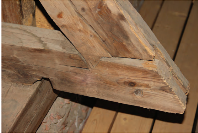
Munktorp långhus. Knut med nacke i förbindningen högben och stickbjälke.
