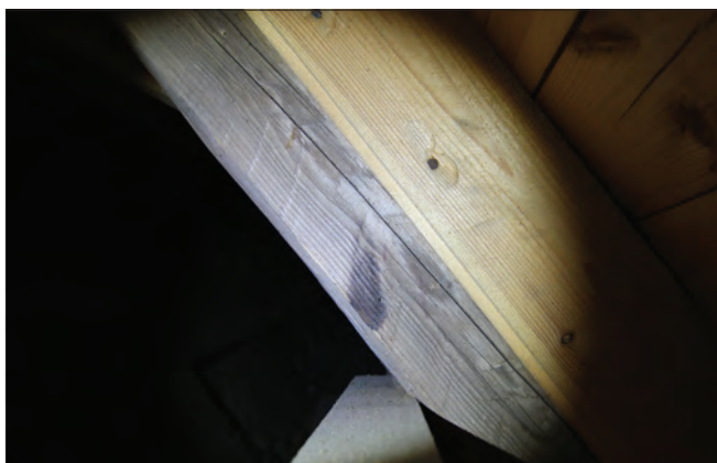
Figur 12. Skyddsbränning.
