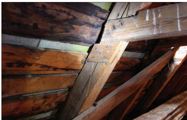
Figur 14. I högbenet på takstol nr 6, södra takfallet, syns spåren efter var delar tidigare suttit. I det medeltida urtaget för hanbjälken har en brüdlapp spikats fast och över den sitter en sekundär hanbjälke. Under det äldre urtaget syns en tunn urskärning i virket där en förmodad konstruktionsdel till treklövernvalvet varit infäst.
