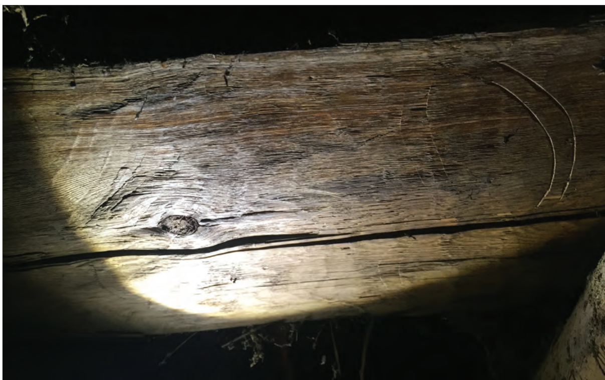
Figur 15. En annan typ av märkning påträffades på ett av timren under klockvåningens hjälklag. Det är en bågformad skärning (till höger i bild). Två liknande bågformade ritsar är synliga i anslutning till skärningen. Vad de representerar har inte undersökts vidare inom projektet. Foto Daniel Eriksson.
