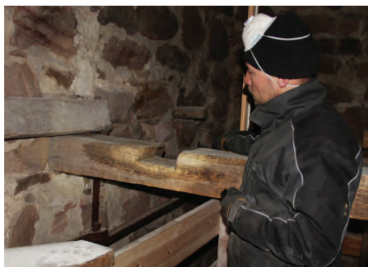
Foto till vänster, flera snedfasade urtag finns på ett timmer. Foto: Daniel Eriksson. Fotot ovan visar urtag på timrets bredsida med en rak och en sned kant. Ett likadant urtag finns i andra änden. I bild syns Daniel Eriksson.
