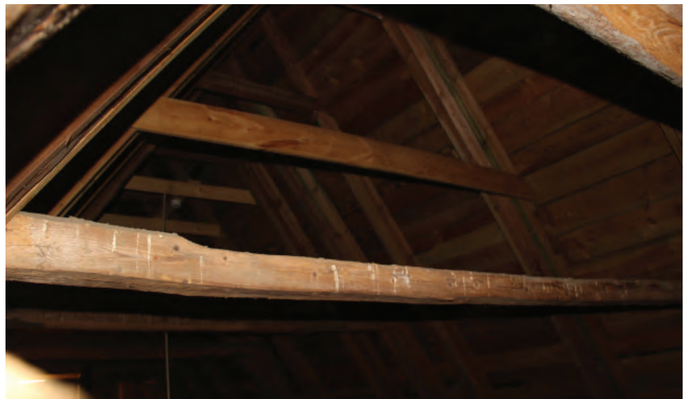
Före detta avsmalnat högben återanvänt som hanbjälke över långhusvinden.
