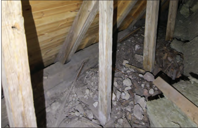
Figur 5. Styrbjälke utmed norra murkrönet. De ligger närmast högbenen och har urtag för inpassningen mot högbenen och griper över stickbjälkarna (före detta bindbjälkar) med ett hak. Mot remstycket har en av bjälkarna passats in genom en urbuggen fals.
