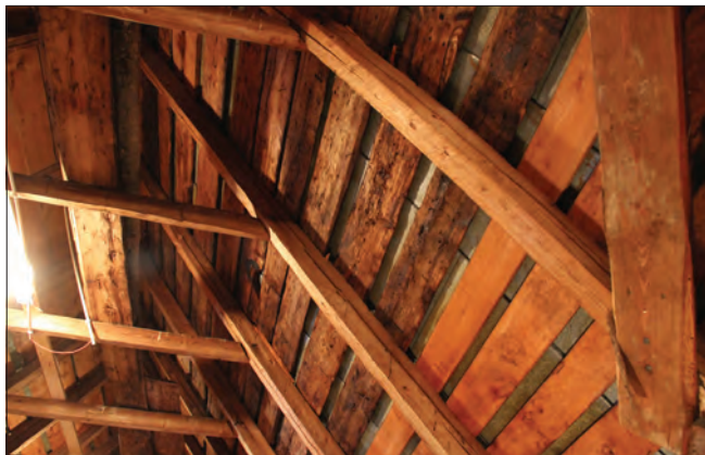
Figur 8. Högben och övre banbjälkar samt äldre och yngre taktra.
