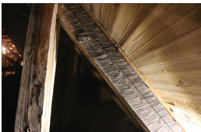
Figur 9. Sprätthugget högben och stödben i långhusets södra takfall.
