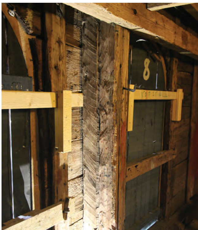
Stolpen närmst panelen mellan ljudluckorna är en återanvänd medeltida sprättäljd bjälke (t.v.). Ljudluckornas foder är av återanvänt medeltida sprättäljt taktrovirke (t.h.).
