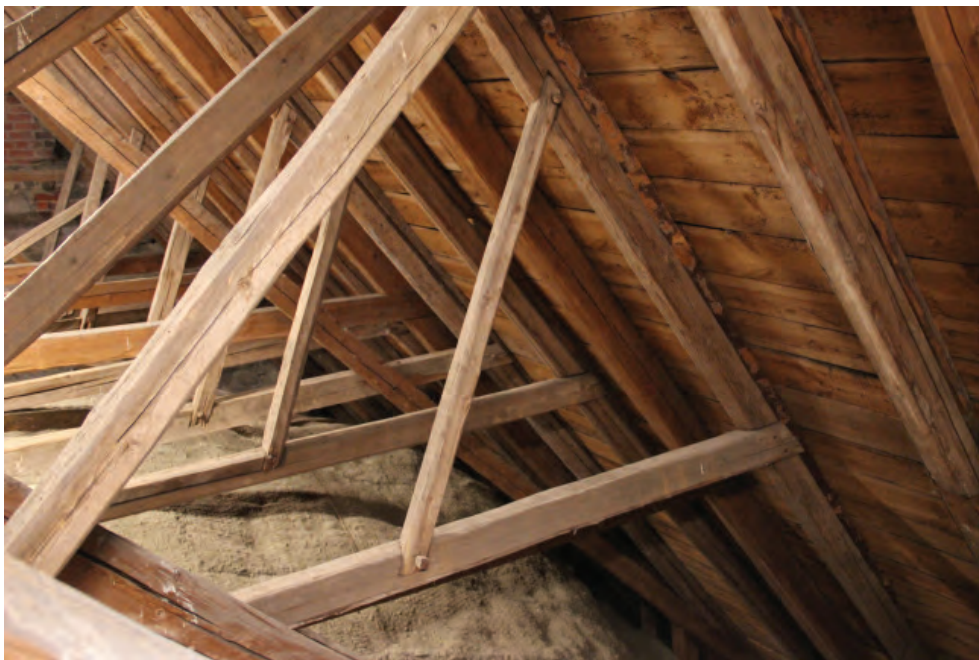
Del av taklaget i långhuset.
