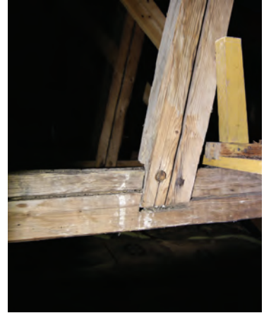
Husad knut med dymling och spik, östra delen av långhuset.
