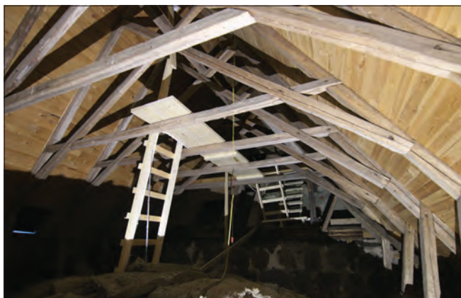
Figur 17. Takstolar över sakristian, sedda från norr.
