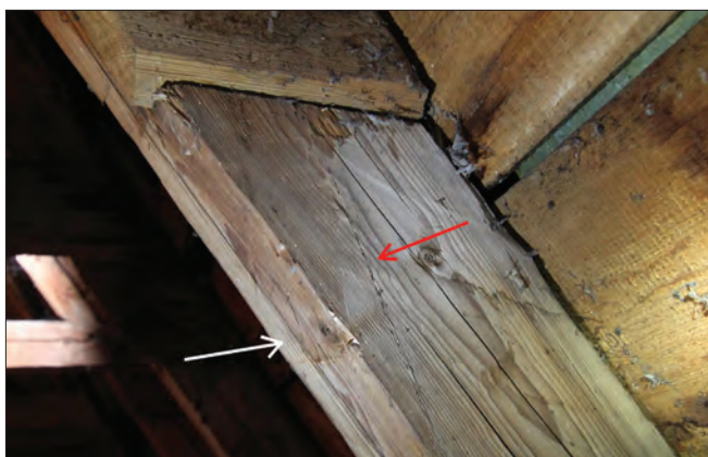
Figur 15. I högbenet på takstol nr 26, norra takfallet, syns en tunn rits (röd pil) i virket samt klämmärken och färgskiftning (vit pil) där en konstruktionsdel till treklövernvalvet varit infäst.
