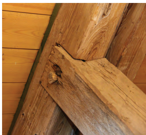
Husad knut. Flera knutar har både spik och dymling.
