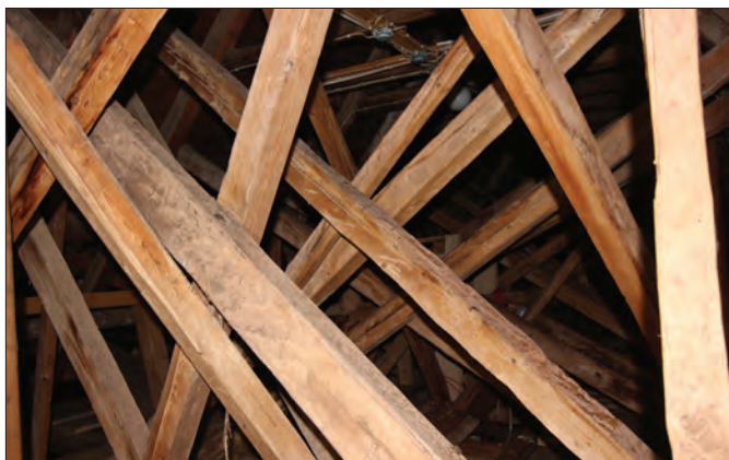
Figur 15. Bjälkar kors och tvärs på Rättviks kyrkvind. Vid inventeringen har byggnadsdelar synats av efter medeltida kännetecken. Foto Lisa Skanser.
