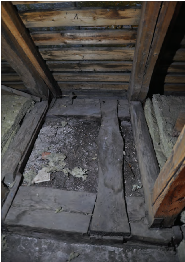
Figur 9. Inlaxad kortling av plank mellan yttre och inre remstycke infäll takstol nr 27, södra murkerönet. Foto Daniel Eriksson.
