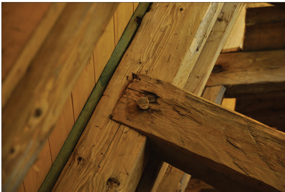
Figur 12. Ångsö kyrka. Exempel på husad knut där bladningen inte löper rakt över mötande bjälke. Ganska vanligt i tidigmedeltida taklag. Foto Daniel Eriksson.
