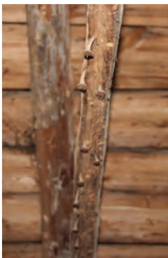
Dubbla rader av spik i valvribba. Tyder på att geeralskarv funnits i tunnvalvet.
