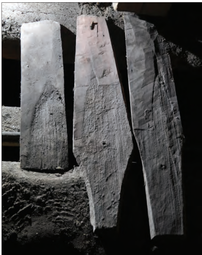
Figur 19. Lösfynd av stavspån av olika modell. Behuggning och överliggande skift syns tydligt i släpljus. Foto Daniel Eriksson.
