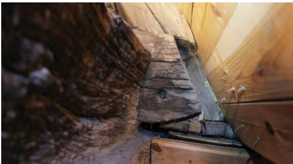
Stickhjalke av ek med uppsvängd undersida.
