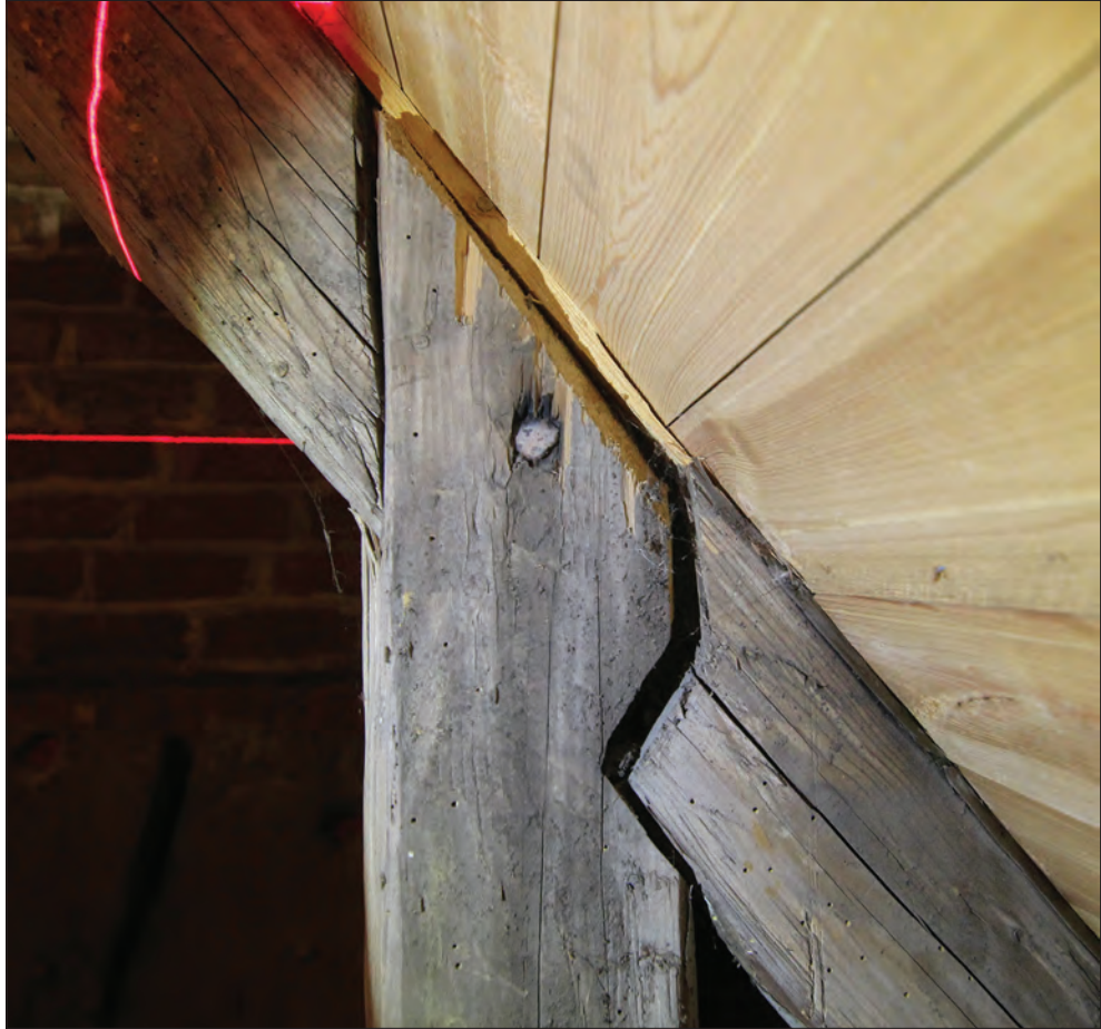
Figur 13. Badelunda kyrka. Exempel på knut med nacke som är vanlig under senare medeltid. Foto Daniel Eriksson.
