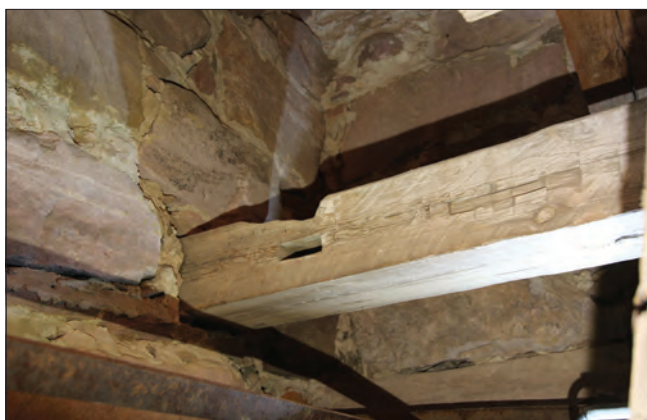
Figur 9. Väggtimmer med flackt längdrag och rektangulärt tapphål.
