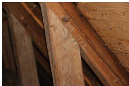
Timmermansmärkning i mötet stödben och bögben.
