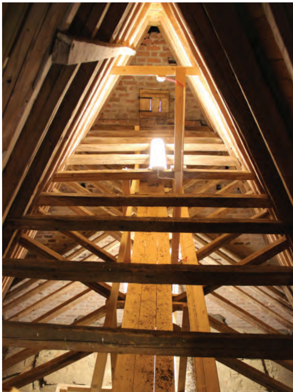
Fotot visar takkonstruktionen över södra korsarmen.
