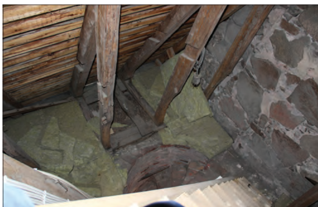
Figur 12. Takstolsdelar i sydvästra delen av taklaget. Spår efter borttagna konstruktionsdelar finns i knäbockens bögben och stödben.
