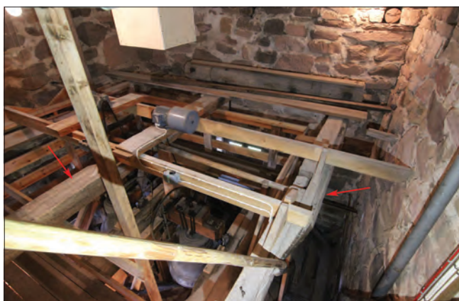
Figur 4. Två av de undersökta bjälkarna över klockorna är markerade med röda pilar. Foto från sydöstra hörnet av tornet.
