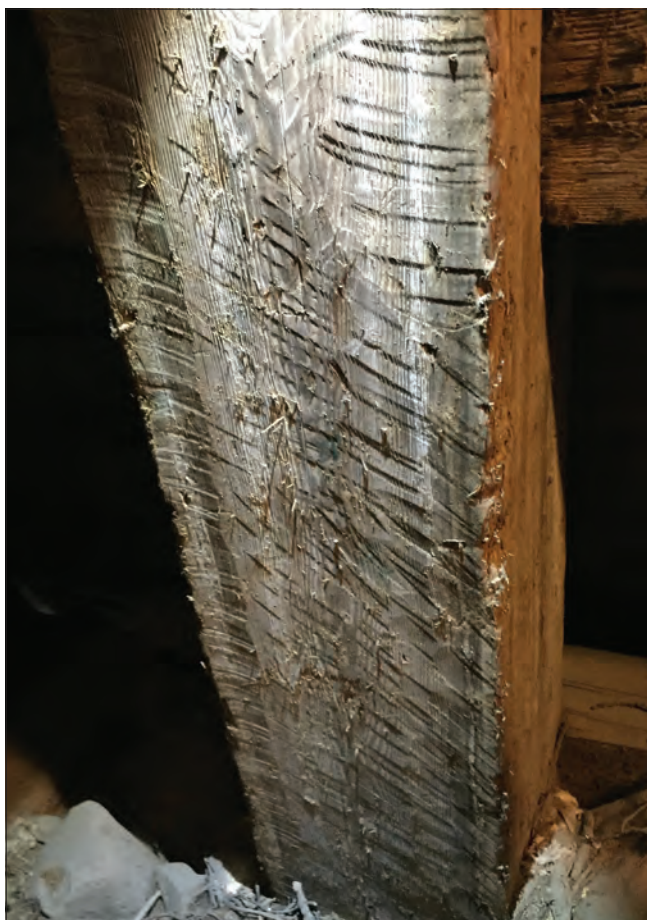
Figur 25. Sprätthuggning i flera parallella band på ett av stommens kraftiga ben. Foto Daniel Eriksson.
