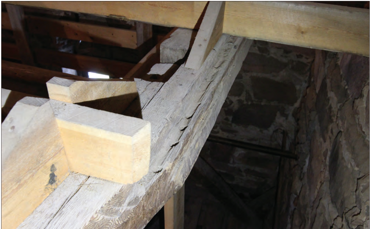
Figur 13. Över klockorna och närmast östra väggen finns ett väggtimmer upplagt i gluggar mellan norra och södra murverken. Delar har buggits bort för att ge plats åt en trappa. Timret är bilat på samtliga sidor. Det finns ett spår eller slags fals utmed ena bredsidan och på motsatt bredsida finns två laxknutar. Falsens funktion diskuterades och teorier kring om den gjorts för en takfotsbräda, anfang för tunnvalv eller fals för innertak framfördes. Verktygsspåren visar att spåret/falsen, med största sannolikhet, har gjorts med stocken på plats i väggen. Laxknutarna förefaller också ha gjorts i stående kyrkan varför teorin om takfotsbrädan inte verkar trolig. Navare har använts för att borra genom fibrer och underlätta urhuggningen. Eventuellt har någon form av krokjärn använts för att karva ut formen.
