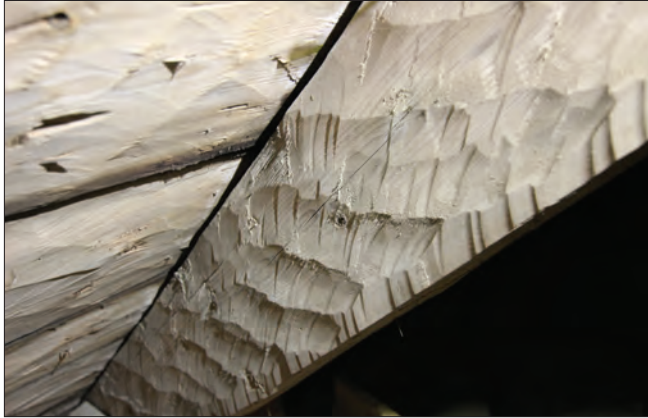
Figur 13. Högben som först sprättbuggs i längsgående band och sedan har man tält en gång till, diagonalt över fiberriktningen.
