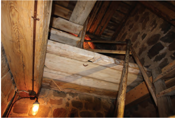
Björskogs kyrka. I tornet finns en återvänd, troligen senmedeltida, bjälke två trappor upp i trappans vilplan.
