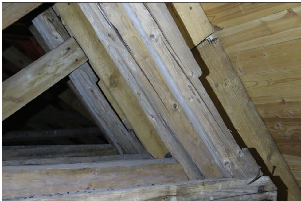
Figur 13. I bilden syns de mellersta urtagen i högbenens yttersidor.
