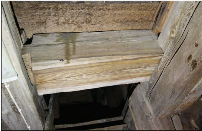
Figur 21. Kortling mellan hammarband och bindhjulke i övre ramen.
