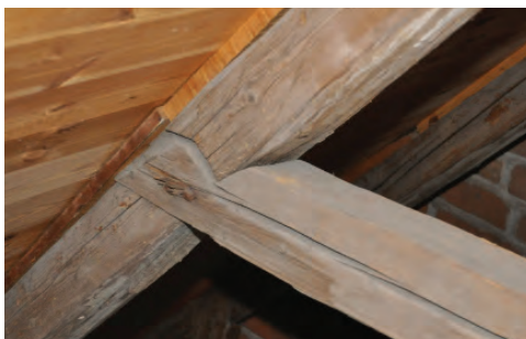
Knutning med nacke i vapenhuset från tidigt 1400-tal. Skyddsbränning på en av höghenen över koret. Foton: Daniel Eriksson.
