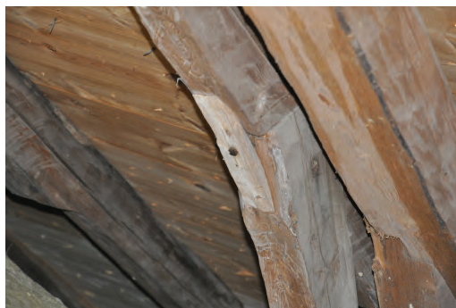
I övergången mellan högben och stödben har man i många fall att fylla ut med en liten löt eller kloss, för att fylla radien till tunnvalvet. Foto: Daniel Eriksson.
