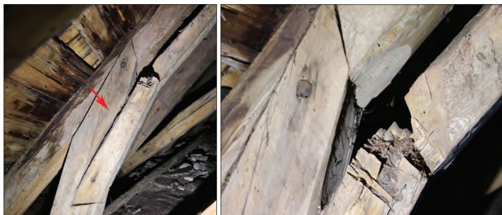
Figur 3. Avsiktligt anbuggen valvbåge. Den röda pilen markerar fasningen av högbenets kant.
