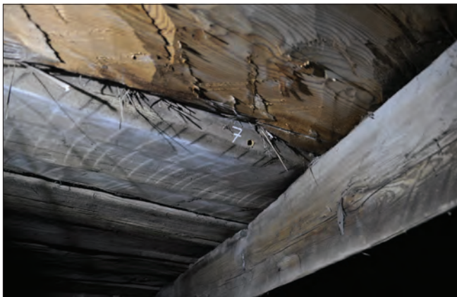
Figur 8. Sprättbuktat plank i klockvåningens bjälklag, borrarat för dendroprov nr 7.
