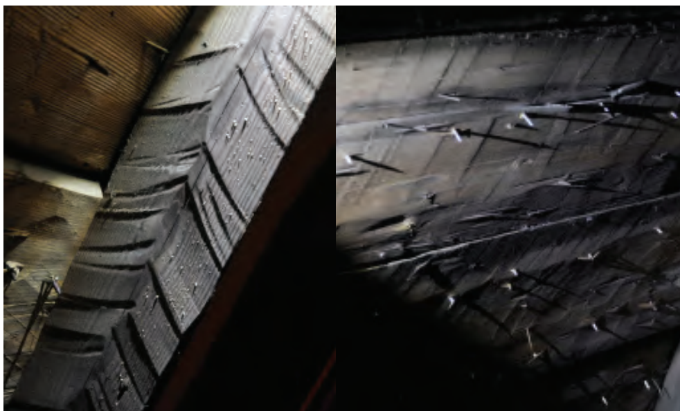
Sprätttält höghen till vänster och sprättäljd taktro perforerad med för långa spik till böger. Foton: Daniel Eriksson.
