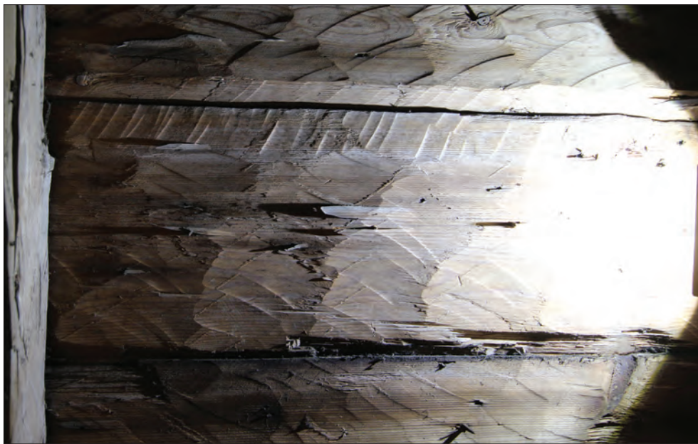
Figur 18. Taktrobrädor uppvisar sparsamt med spikhål.
