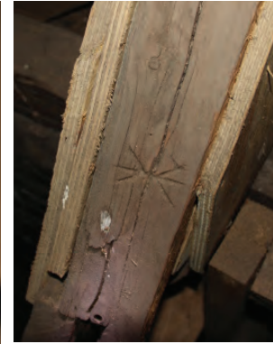
Munktorp långhus. Bomärke eller timmermansmärkning på högben. Notera att träskivor skruvats i dess sidor.
