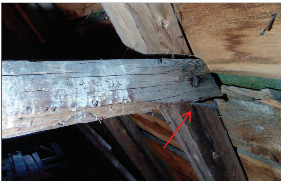
Figur 10. Uppslagsspik berättar att hantverkaren troligen jobbade ensam vid infästningen av hanbjälken i högbenet. Foto Bengt Bygden.
