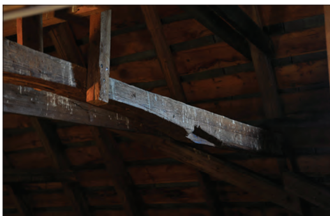
Figur 11. Hanbjälken på takstol nr 14 har huggits ur för valvhjässan och det finns även en rits. Foto Daniel Eriksson.
