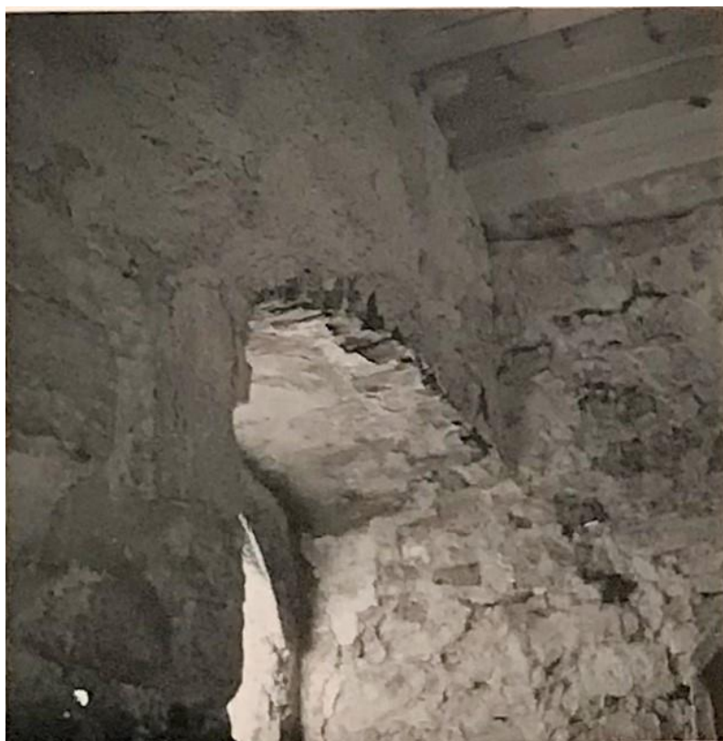
Västfasadens fönster (i Säves teckning portal). T.h. källaringång från väster med huggen bågomfattning. Foto troligen Gunnar Svahnström 1939, GMA.
