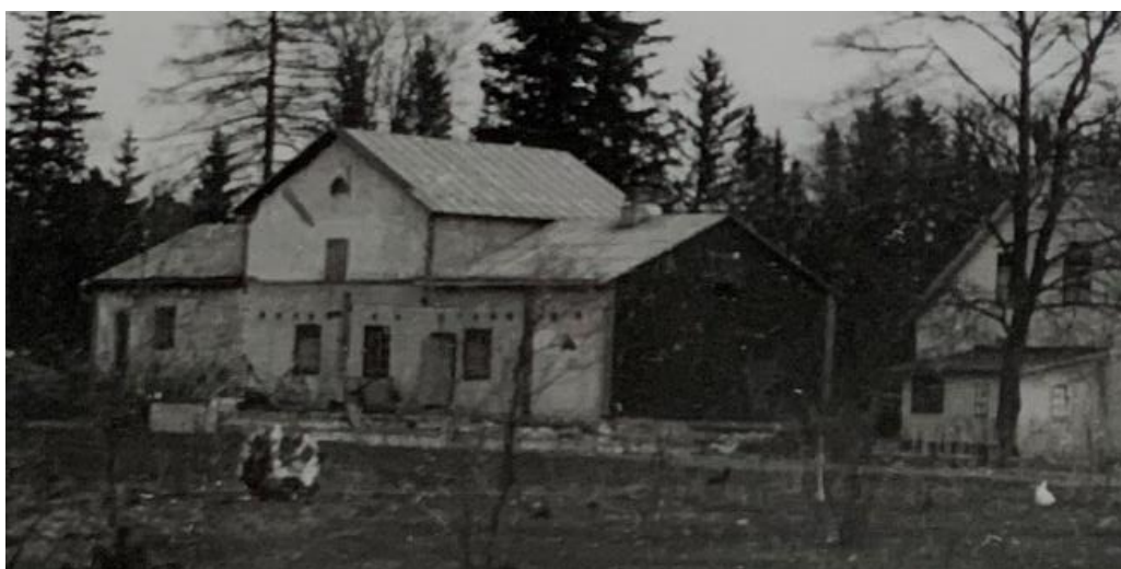
Flygeln från sydväst. Stensalen belägen i byggnadens borte del. Detalj av föregående foto.
