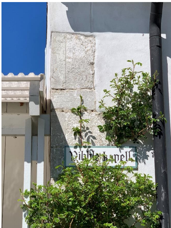
Hörnkedja med putsrand i kapellets sydöstra hörn. T.h. ingången i östfasadens norra del. Foto JL 2020.
