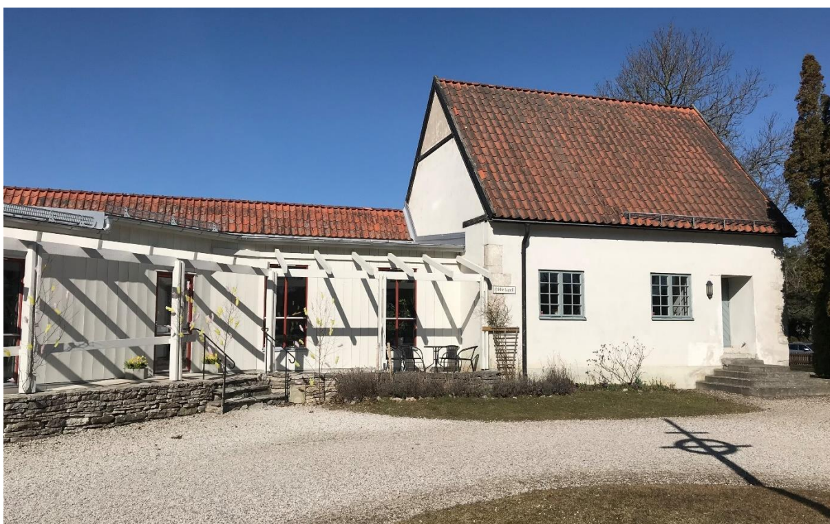
Exteriör från sydöst innan pergolan på tillbyggnaden övertäcktes av transparent skyddstak. Foto JL 2018.
