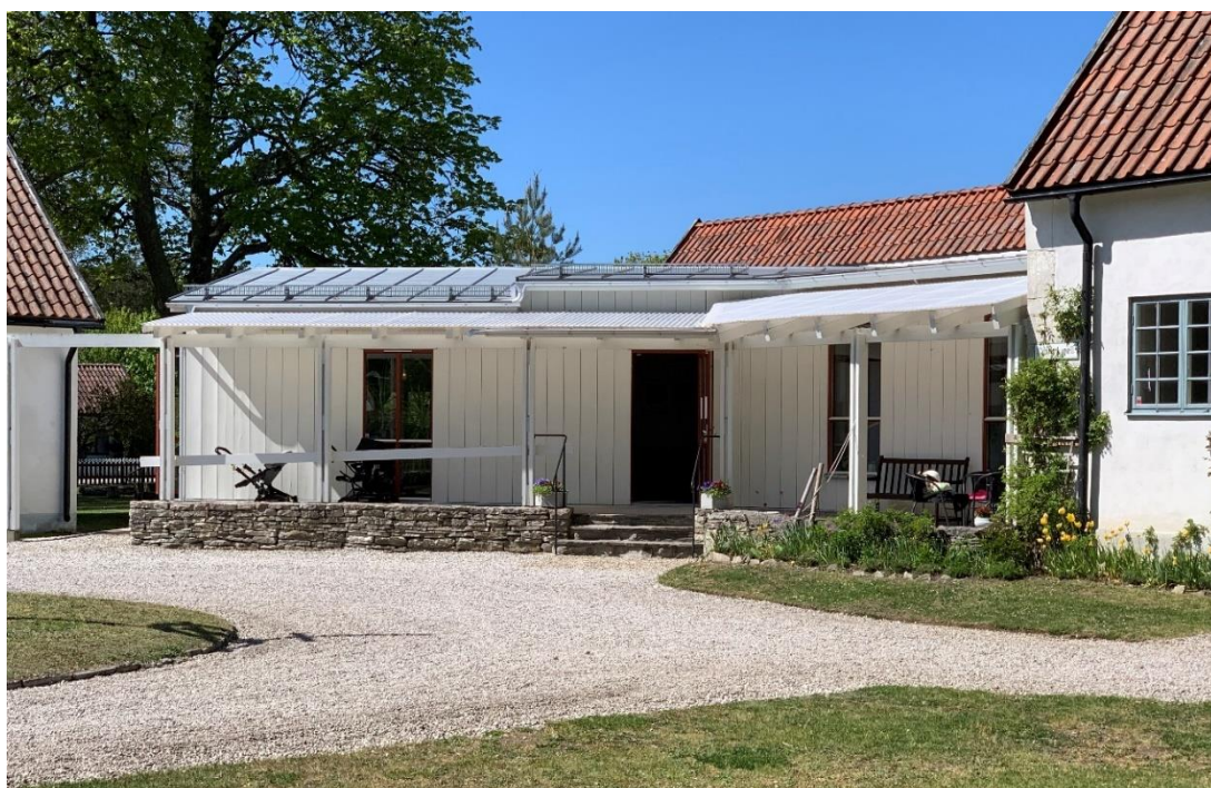
Exteriör av entrébyggnaden från nordöst. Foto JL 2020.
