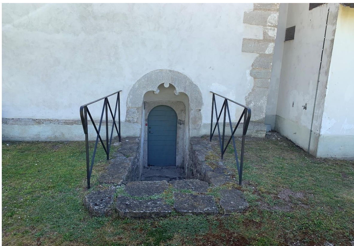
Portal i västra murens södra del med ingång till källaren. Foto JL 2020.
