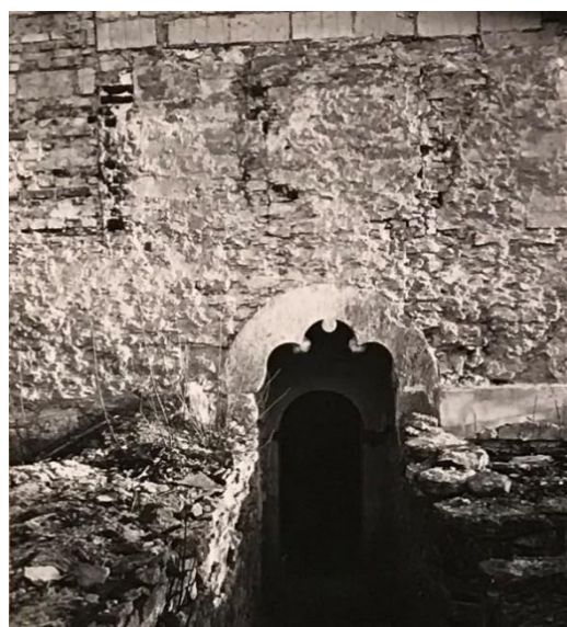
Källaringången i västfasaden med medeltida bågkrön. Placeringen är rimligen sekundär, men murverket förefaller relativt orört. Murarna framför portalen sannolikt från den mörka källargång som Säve tecknade av portalen i år 1868. Foto Waldemar Falck 1968, GMA (980-265, 980-264).
