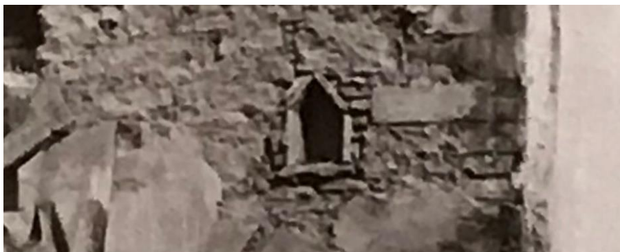
Nisch, detalj av ovanstående. Murverkets små stenar antyder att den möjligen ej var ursprunglig.
