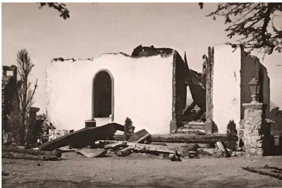
Stensalen från öster efter branden. Foto Gunnar Svahnström 1943, GMA (980-231). Det rundbågiga fönstret, som fick sin form i slutet av 1930-talet, är i dag igensatt och ersatt av två rekonstruerade rektangulära fönster på var sida.
