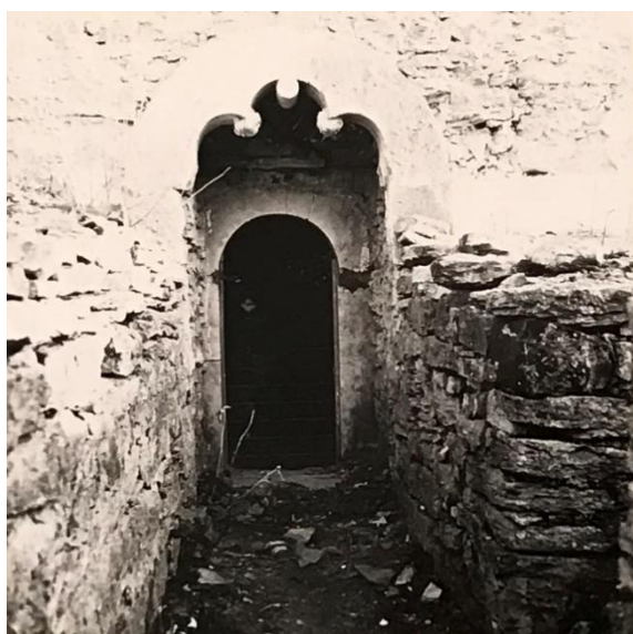
Källaringången i västfasaden med medeltida bågkrön. Placeringen är rimligen sekundär, men murverket förefaller relativt orört. Murarna framför portalen sannolikt från den mörka källargång som Säve tecknade av portalen i år 1868. Foto Waldemar Falck 1968, GMA (980-265, 980-264).
