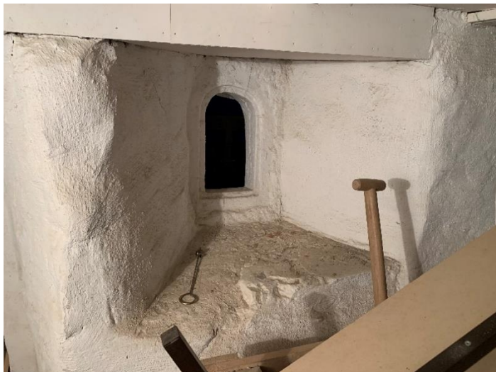
Det inre, mindre källarrummet mot söder med rundbågig glugg ut mot yttre rummet. Den yttre omfattningen, ligger i liv med murens andra sida, men muren är svår att tolka som en tidigare yttervägg. Foto JL 2020.
