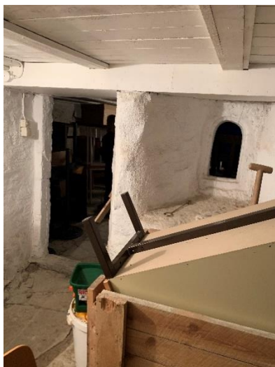
Det inre, mindre källarrummet mot söder med rundbågig glugg ut mot yttre rummet. Den yttre omfattningen, ligger i liv med murens andra sida, men muren är svår att tolka som en tidigare yttervägg. Foto JL 2020.
