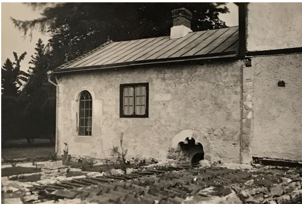
Stensalen från väster under pågående restaurering. Foto troligen Gunnar Svahnström 1939, GMA.
