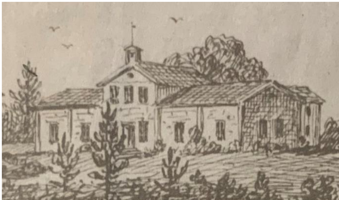
Flygeln från nordöst. Detalj av Säves teckning. Stensalen belägen i den lägre byggnadskroppen till höger om det förhöjda mittpartiet. En byggnadskropp i bildens högerkant antyder att flygeln hade en bakbyggnad, möjligen framför den nuvarande källaringången, eftersom Säve fick betrakta dess huggna omfattning från en "kolmörk källargång".
