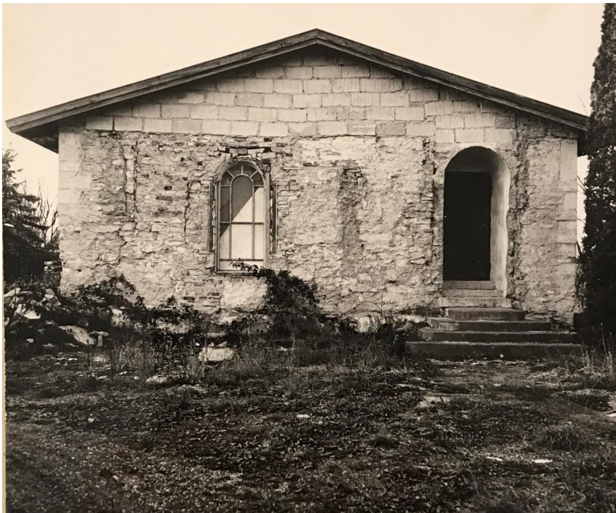
Exteriör från öster 25 år efter branden. Sadeltaket från 1943 är lagt på annan riktning än tidigare och idag, vilket försvårar orienteringen. På var sida om fönstret avtecknar sig de rektangulära fönster som återupptogs vid ombyggnaden 1969–70. Putsen från omkring 1940 i föregående bild är nästan helt borta. Foto Waldemar Falck 1968, GMA (980-257).
