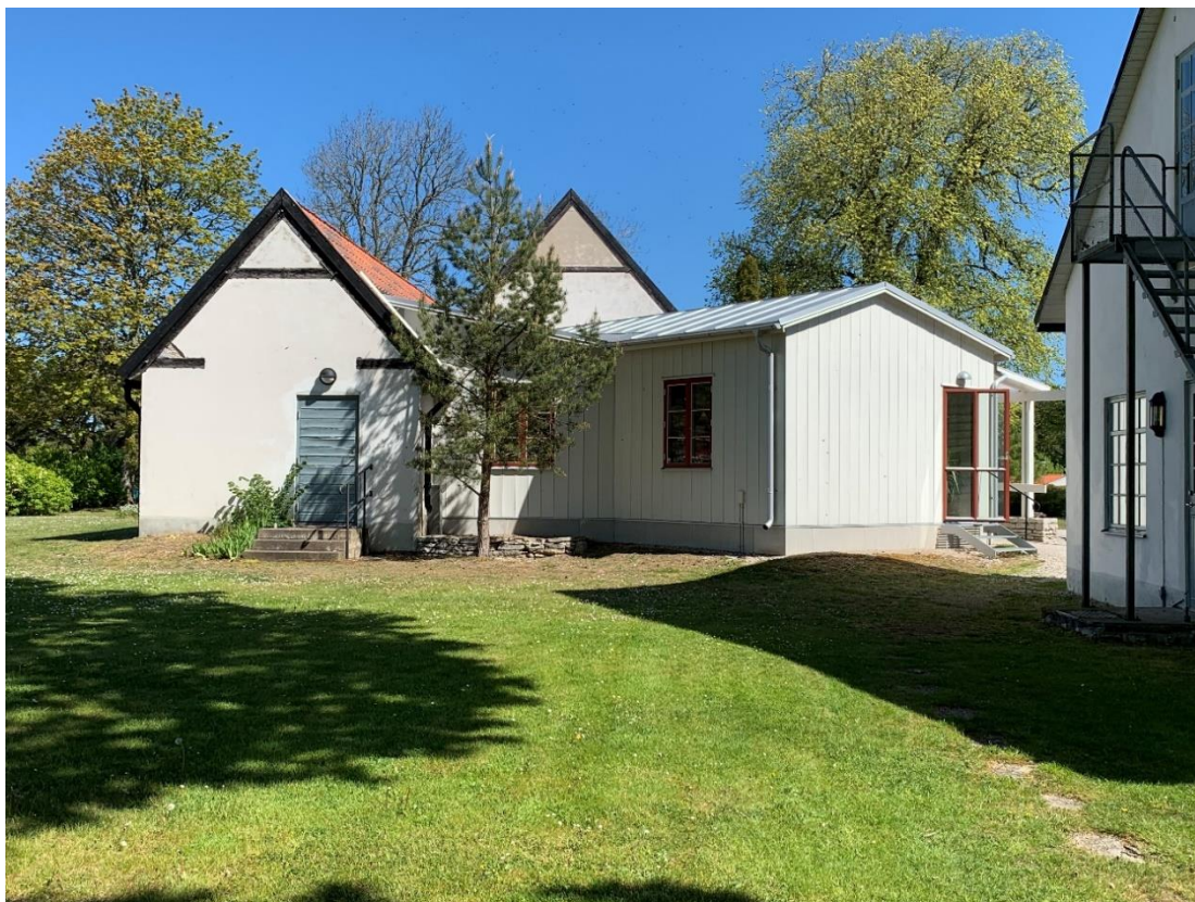
Södra flygeln från söder. Foto JL 2020.
