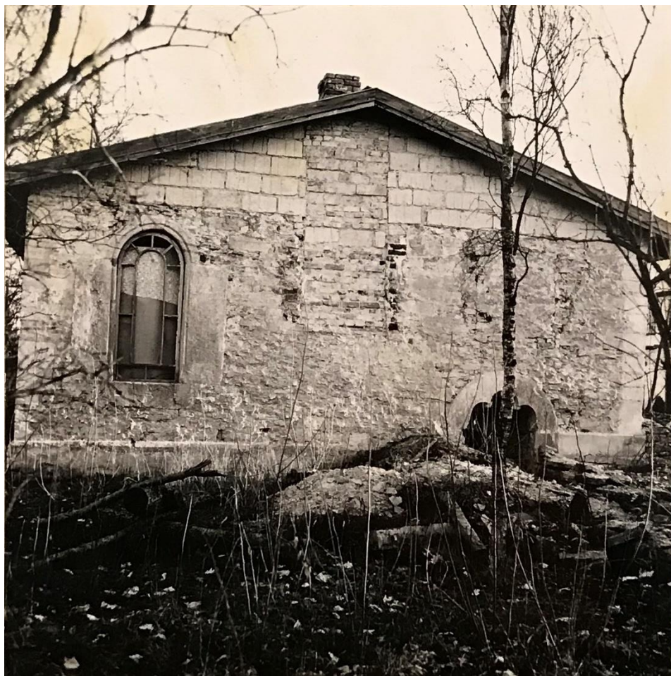
Exteriör från väster. Det rektangulära fönstret som tidigare satt mitt i fasaden är igenmurat med tegel som utgör en skorstensstock upp genom gavelröstet av lättbetong. Foto Waldemar Falck 1968, GMA (980-262).
