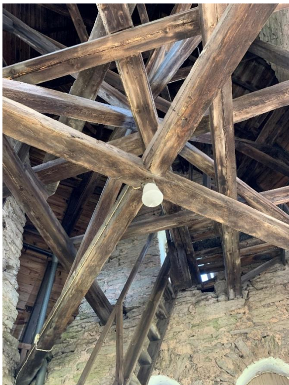
Tornhuven sedd inifrån. Foto JL 2020.
