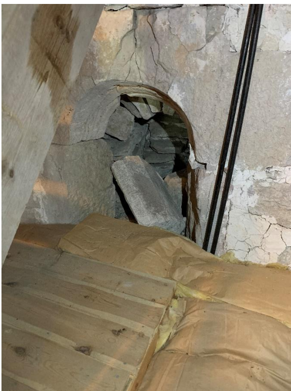
Ursprunglig fönsteröppning i korets norra mur, yttre omfattning, sedan 1200-talet endast synligt från sakristievinden. Skadorna kan ha uppstått genom eldsvåda, troligen av sakristietaket. Foto JL 2020.
