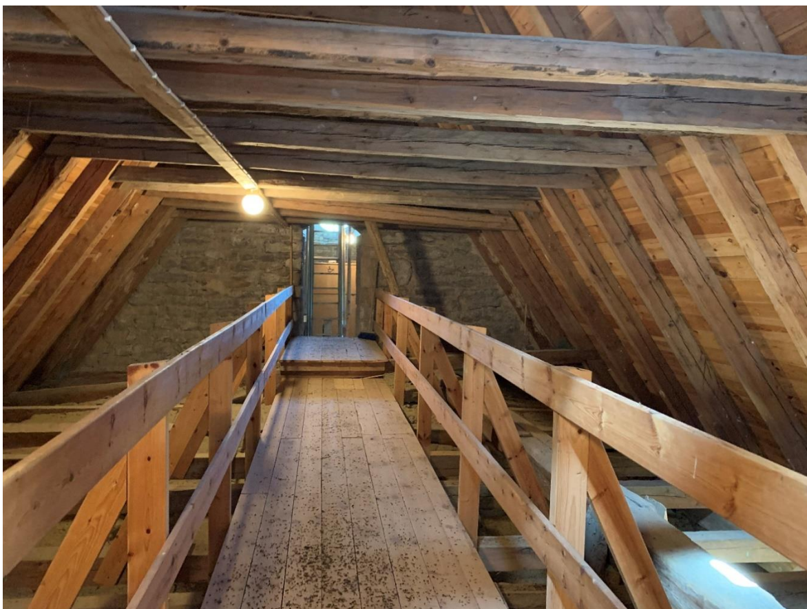
Långhusvinden sedd mot väster. Foto JL 2020.
