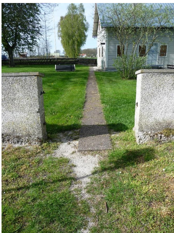
Öppning i muren i den nordöstra delen. Foto ES 2020.
