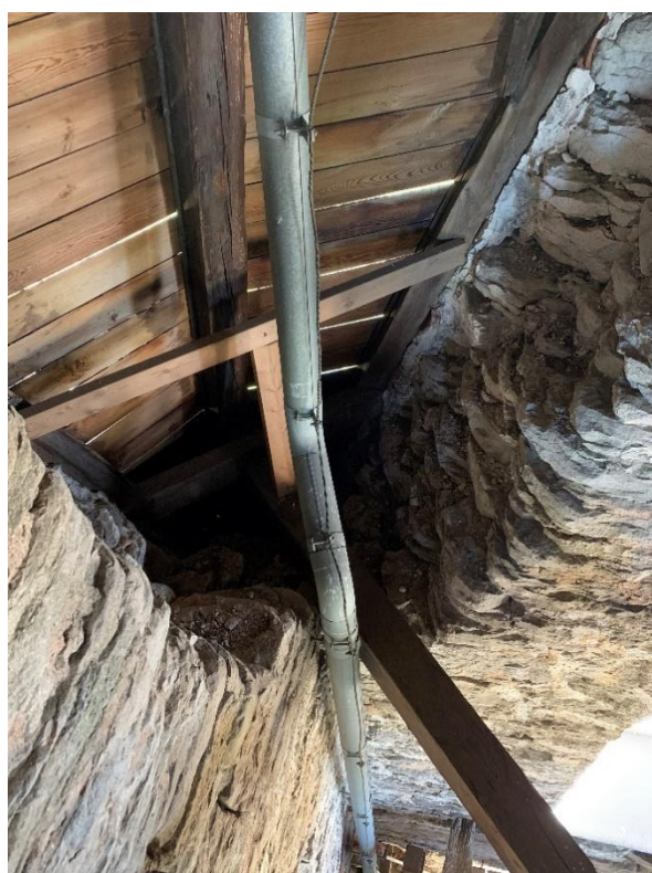
Tornets gavelrösten sedda inifrån. Den övre delen av röset till höger påmurades 1873. Foto JL 2020.
