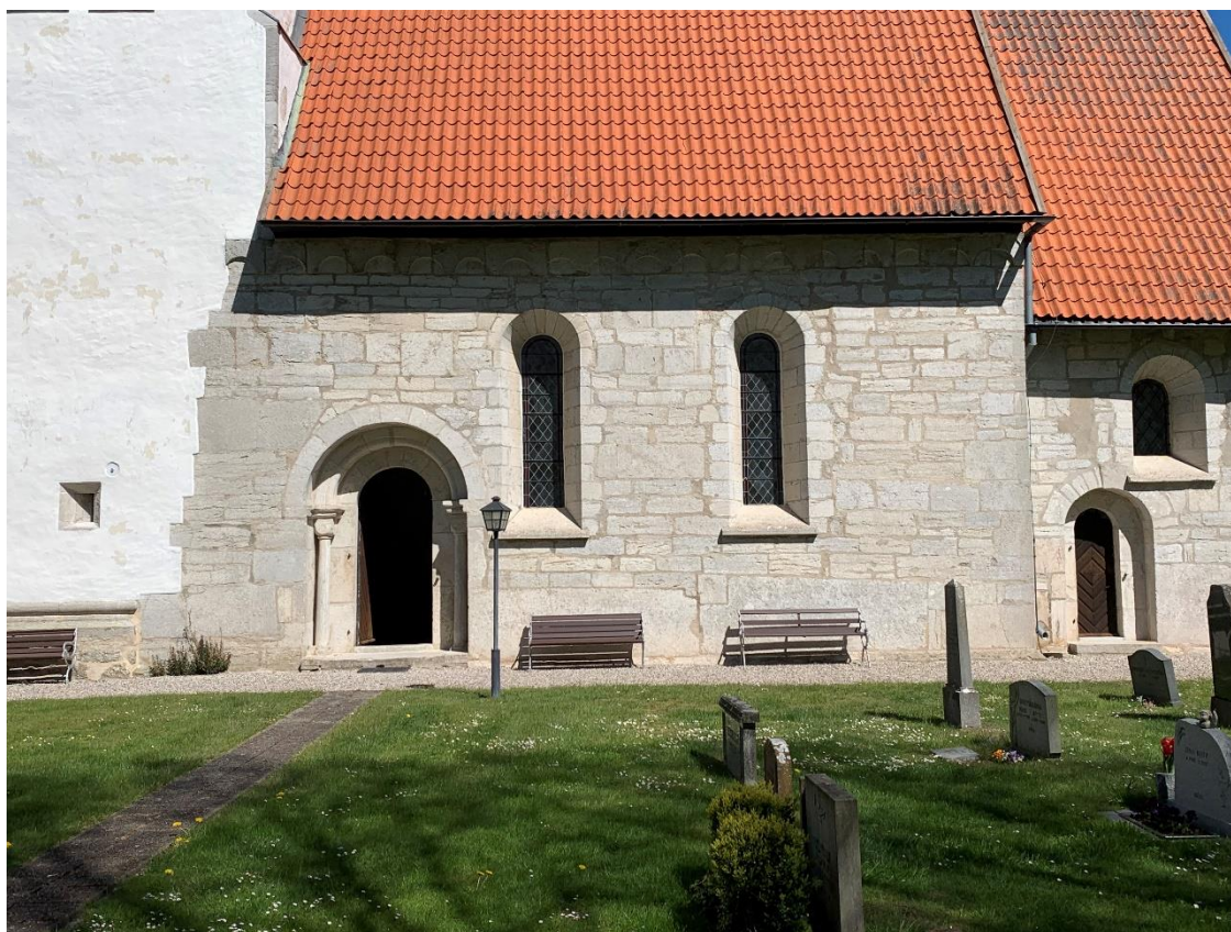
Långhusetets sydfasad. Foto JL 2020.
