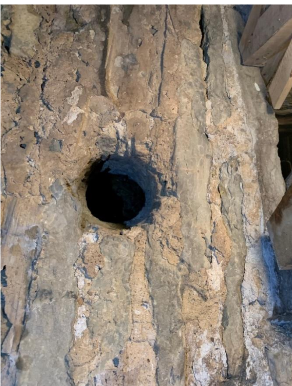
Tornets andra övervåning. Hål i valvet för klocklina och passage, båda ursprungliga. Foto JL 2020.
