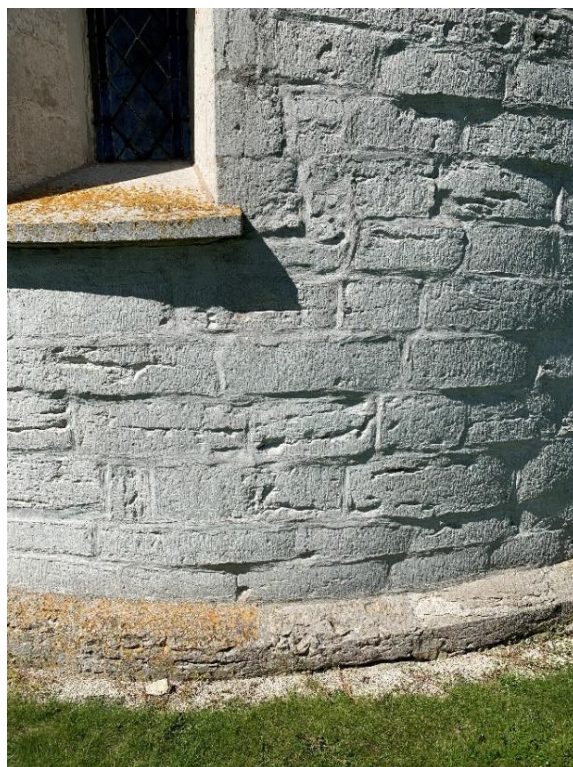
Murverket i korets och absidens sydfasad. Till höger detalj av absidens murverk. Stenblocken har en snävare rundning än absidens grundplan. Foto JL 2020.
