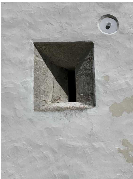
Murcell på tornets södra sida. Öppningar i fasaden och in mot ringkammaren. Foto JL 2020.
