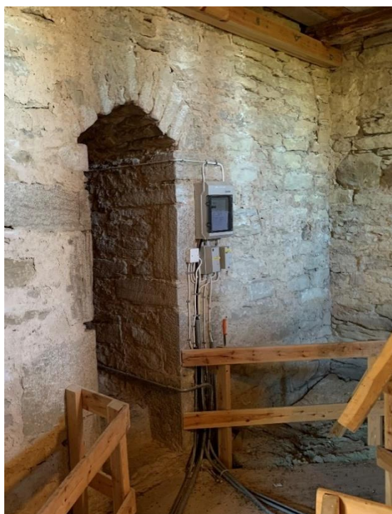
Tornets första övervåning. Ingång till kyrkvinden i den östra muren. Till höger samma öppning sedd från kyrkvinden, där omfattningen är skadad, möjligen genom en brand. Foto JL 2020.
