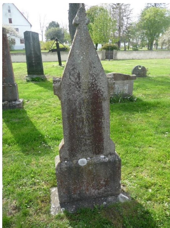
Stående kalkstensvård på hög sockel från 1905. Utpekad som kulturhistoriskt värdefull genom sin utformning. Foto ES 2020.
