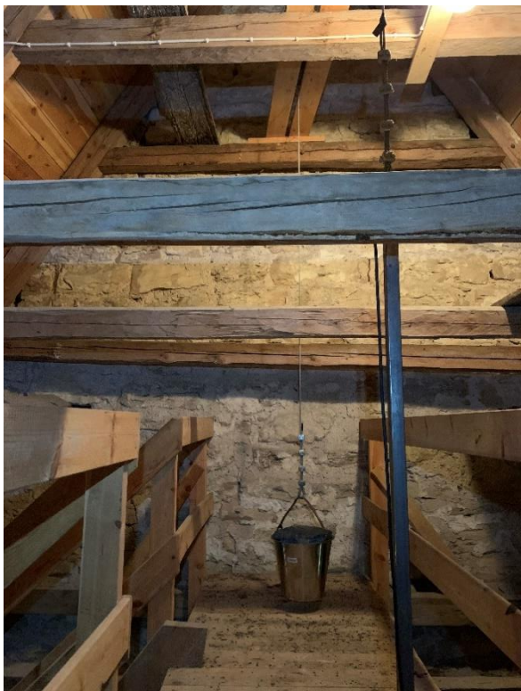
Korvinden. Insidan av det östra gavelröste sett från väster. I bilden till höger ett hål, troligen från ställningsvirke i form av en bräda. Foto JL 2020.
