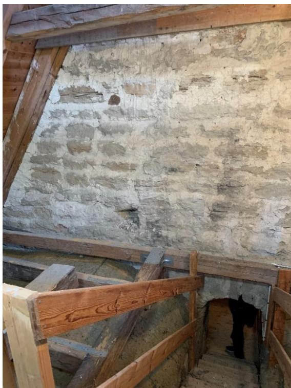
Långhusvinden. Till vänster långhusets östra gavelröste med passage till korvinden. Till höger takstolen på långhusvindens södra sida. Foto JL 2020.
