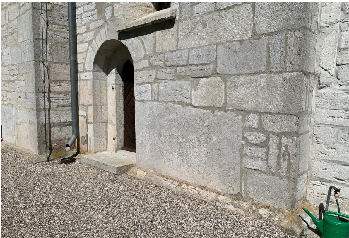
Murverk i korets sydfasad. Foto JL 2020.
