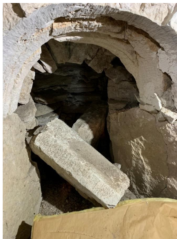
Ursprunglig fönsteröppning i korets norra mur, yttre omfattning, sedan 1200-talet endast synligt från sakristievinden. Skadorna kan ha uppstått genom eldsvåda, troligen av sakristietaket. Foto JL 2020.
