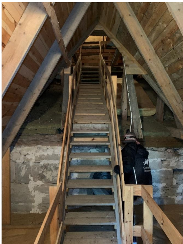
Sakristians vind mot söder och norr med det på 1980-talet murade gavelröset. Foto JL 2020.
