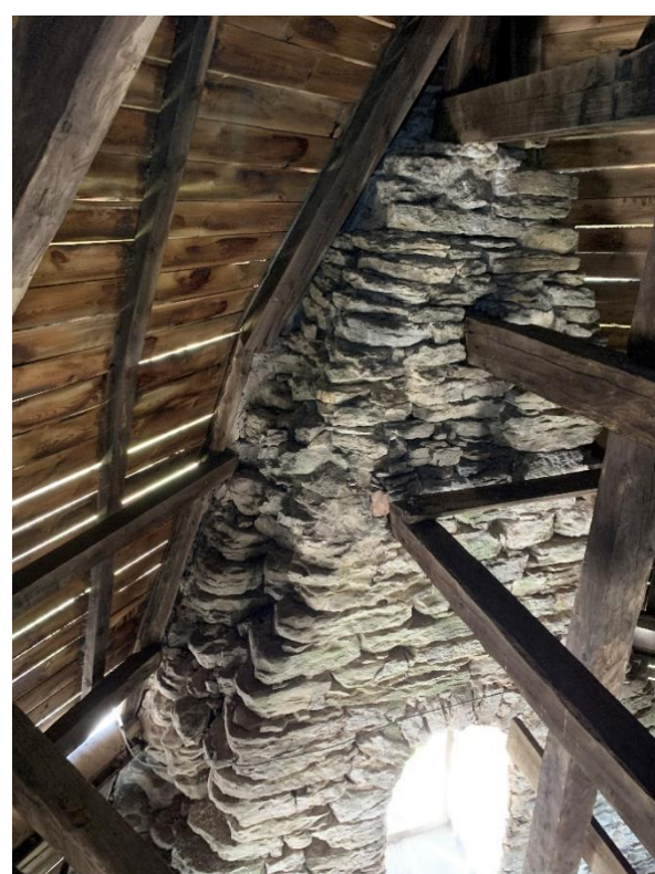
Tornets gavelrösten sedda inifrån. Den övre delen av röset till höger påmurades 1873. Foto JL 2020.
