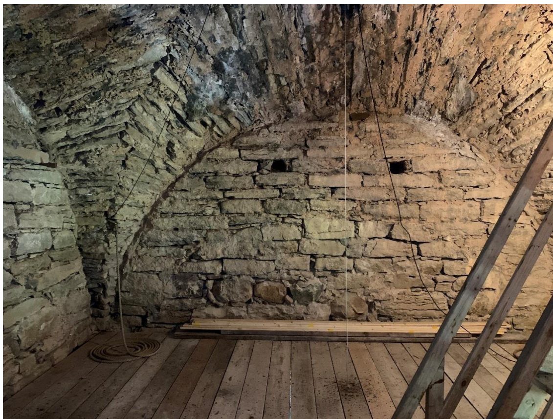
Tornets andra övervåning mot söder, i höjd med galliets tak. Sköldbågen för ett tidigare, lägre placerat valv avtecknar sig i murverket. Foto JL 2020.
