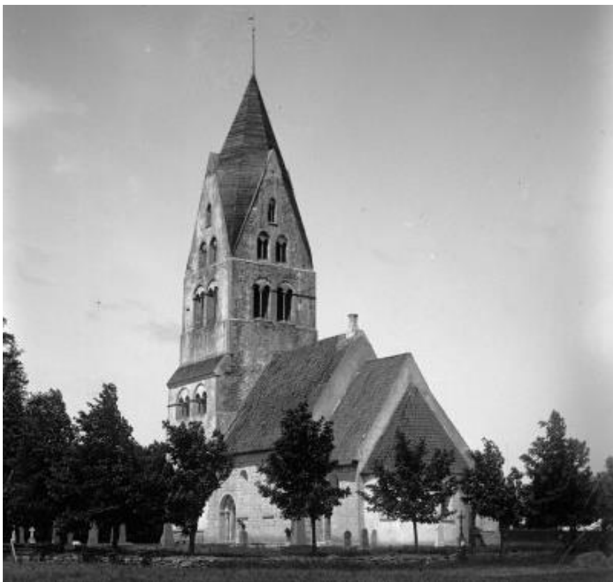
Exteriör från sydöst. Foto I. Wallmark 1917. RAÄ, Kulturmiljöbild. Tornet i behov av omputsning. Gavelspetsarnas komplettering från 1873 avtecknar sig tydligt.
