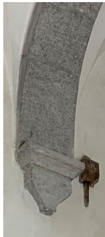
Långhuskolonnens bas från sydväst. Till höger konsol på långhusets norra mur samt en av flera bjälkänder. De är placerade på murkrönen och utgör sannolikt kapade tidigare bindbjälkar som sträckt sig över rummet. Foto JL 2020.
