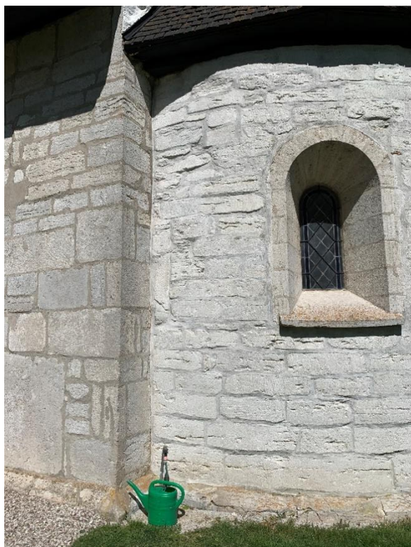
Murverket i korets och absidens sydfasad. Till höger detalj av absidens murverk. Stenblocken har en snävare rundning än absidens grundplan. Foto JL 2020.
