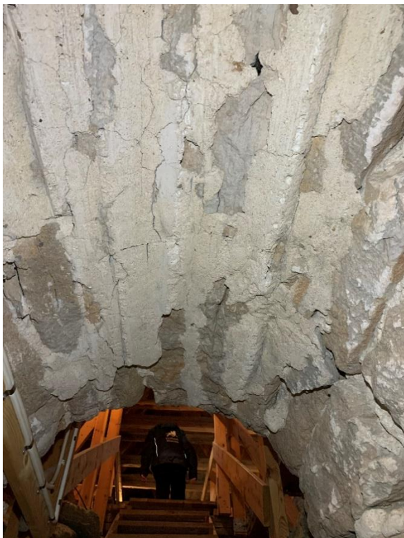
Passage genom triumfbågmuren, mellan långhusets och korets vindar. Valvet med avtryck av skälbrädor sett mot väster och passagen sedd från korvinden. Foto JL 2020.
