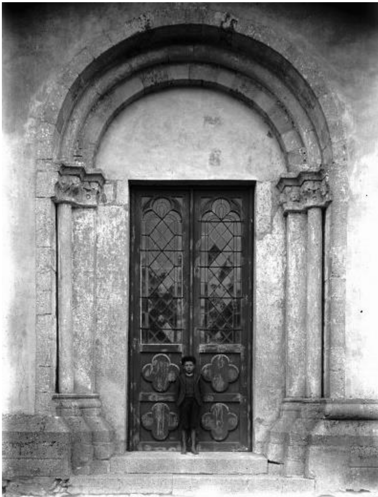
Tornets norra portal med glasparti från 1873. Foto sannolikt från 1800-talets slut. RAÄ, Kulturmiljöbild.
