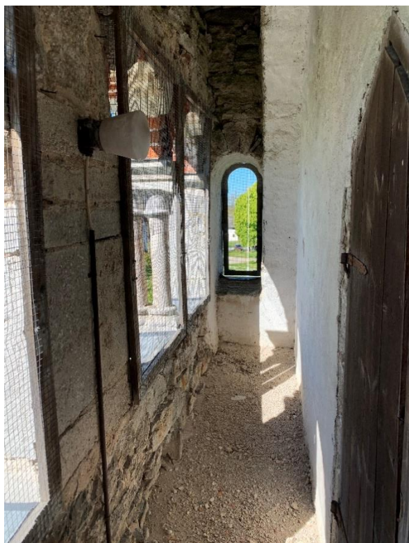
Tornets södra sidogalleri. Vy mot väster och detalj av kolonnetterna. Det vitputsade fältet till höger om gluggen i fonden övergår uppåt i en avlastningsbåge. Foto JL 2020.
