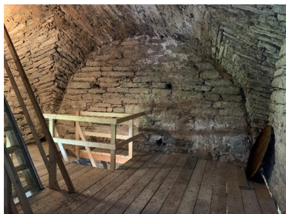
Tornets andra övervåning, sedd mot väster, norr och öster. Det tidigare planerade lägre valvet avtecknar sig svagt i murverket. Fram till 2016 saknades bjälklag och den runda skivan täckte rundfönstret i väster. Foto JL 2020.
