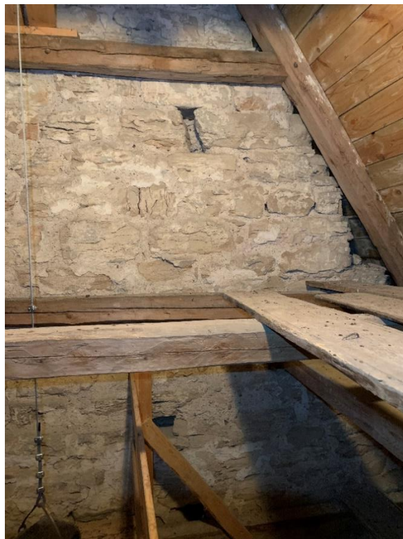
Korvinden. Insidan av det östra gavelröste sett från väster. I bilden till höger ett hål, troligen från ställningsvirke i form av en bräda. Foto JL 2020.
