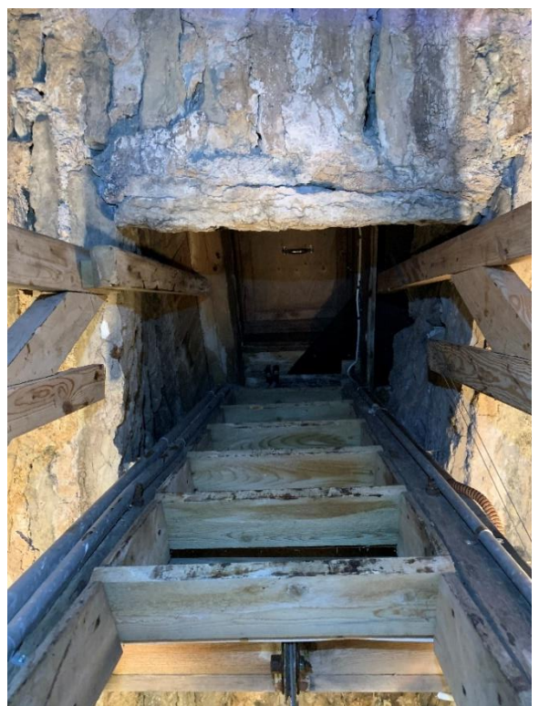
Tornets andra övervåning. Hål i valvet för klocklina och passage, båda ursprungliga. Foto JL 2020.
