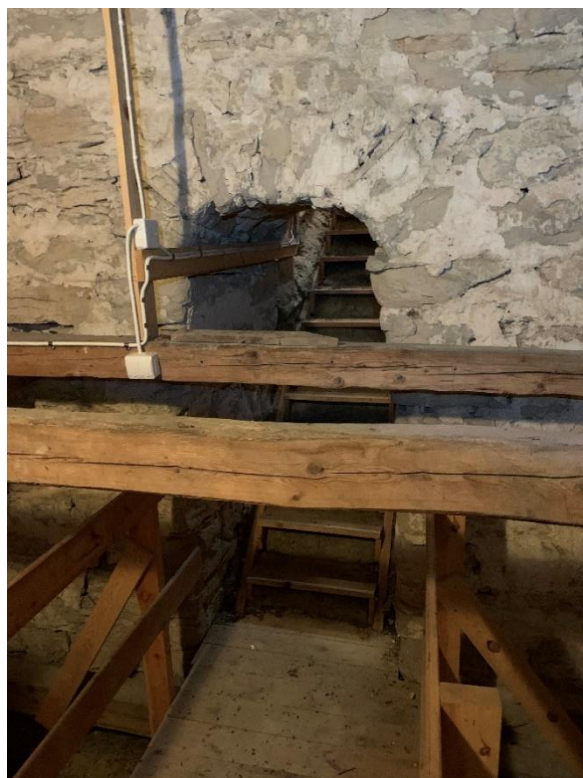
Passage genom triumfbågmuren, mellan långhusets och korets vindar. Valvet med avtryck av skälbrädor sett mot väster och passagen sedd från korvinden. Foto JL 2020.
