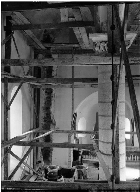
Kaminens rökrör bilas in i triumfbågmuren, nära nordöstra hörnet 1926. Vy från väster och närbild som enligt uppgift vid bilden visar spår av kalkmålningar. Foto Alfred Edle 1926. RAÄ, Kulturmiljöbild.
