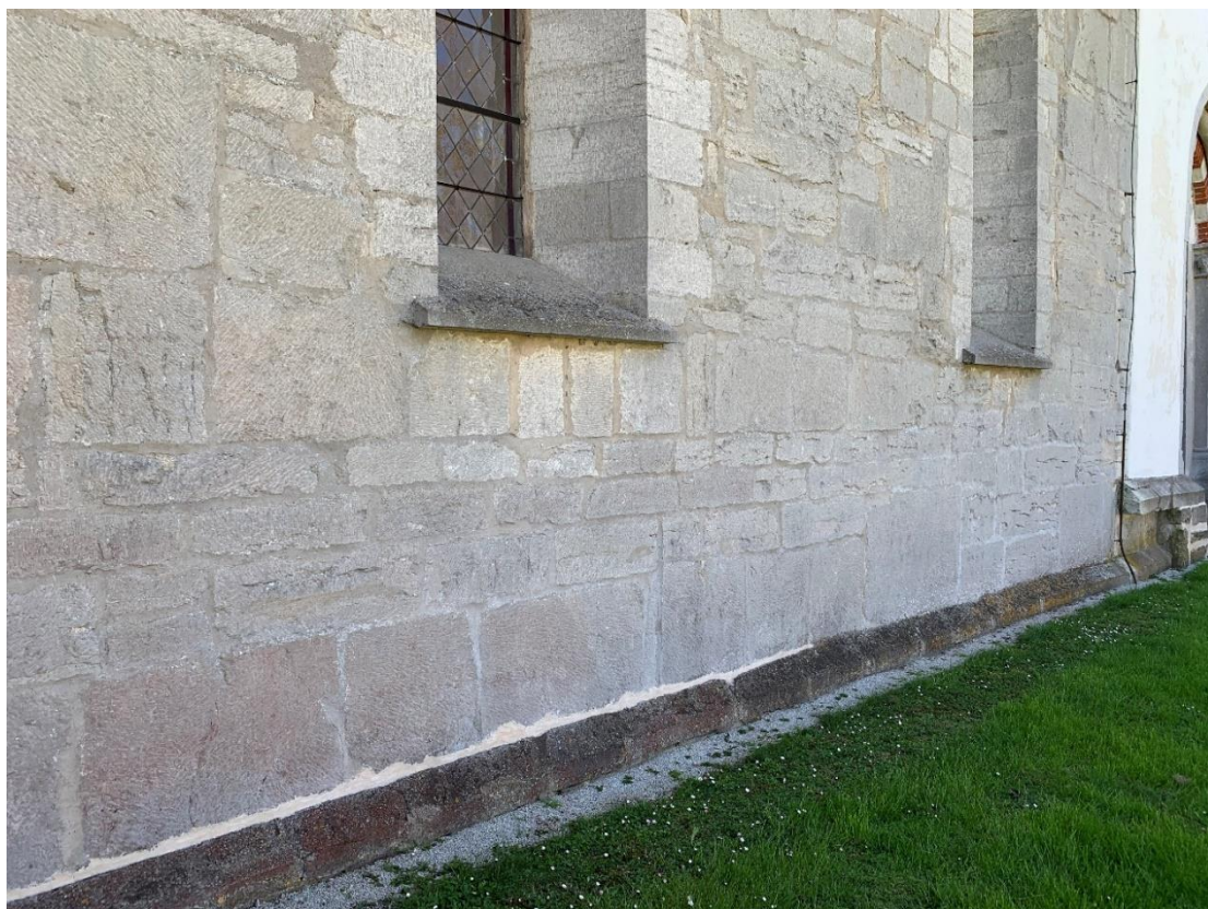
Detalj av nordfasadens murverk och stenbehandling. Foto JL 2020.
