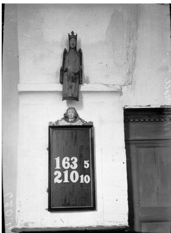
Ovan, Viklaumadonnan, kopia i gips av Alfred Nilsson omkr. 1930. Foto JL 2020. Till vänster madonnabilden innan den såldes till Statens historiska museum 1928, utan den förkomna nederdelen av stolen, placerad på triumfbågens norra anfangslist ovanför nummertavlan. Foto Einar Erics 1914, Riksantikvarieämbetet, Kulturmiljöbild.
