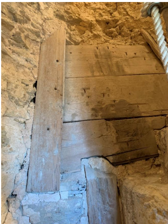
Igensättning med bräder i torntrappan, ett stycke ovanför trappdörrens västra post. Foto JL 2020.
