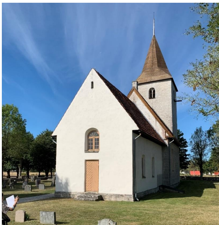
Exteriör från nordöst. Foto JL 2020.
