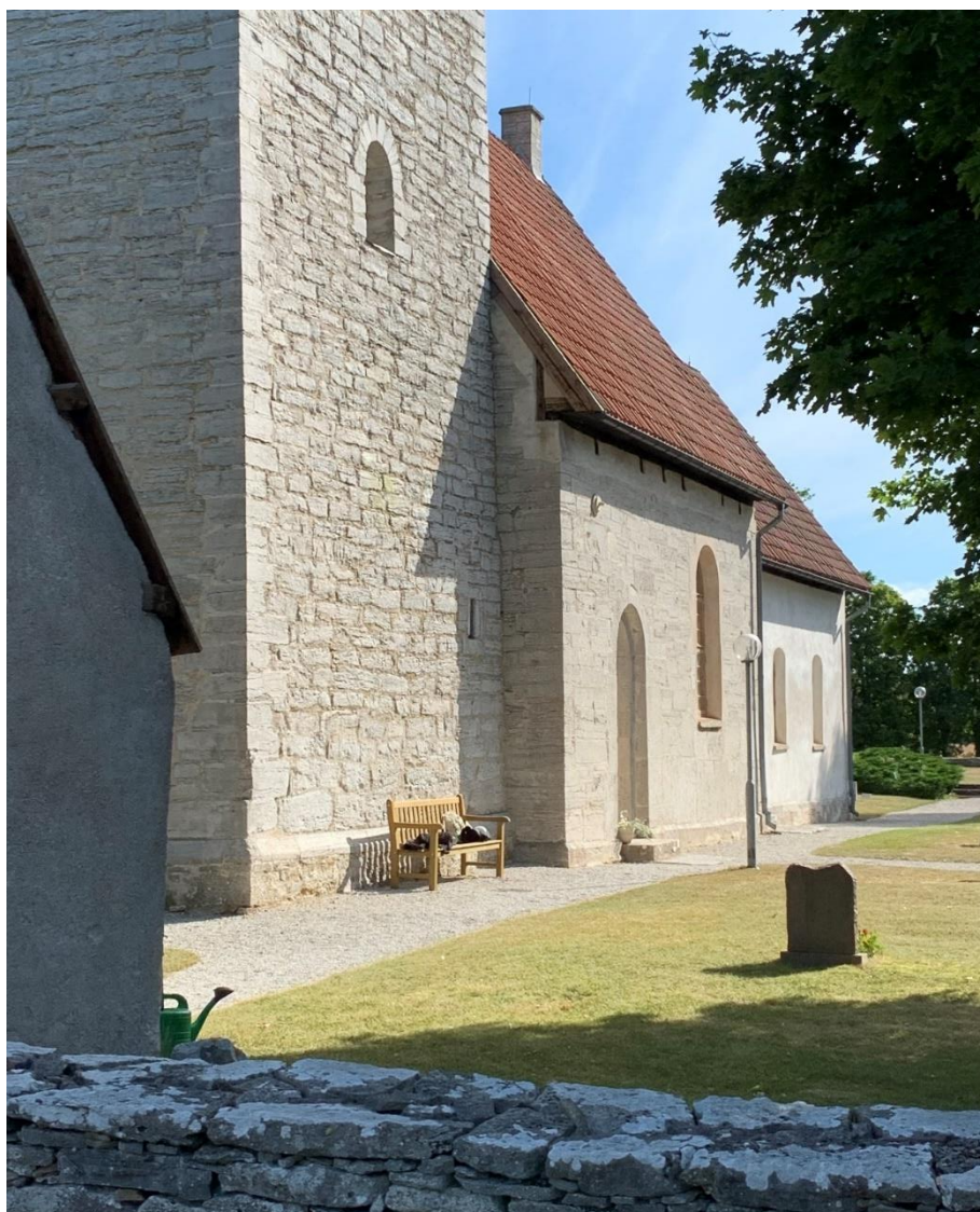
Exteriör längs sydfasaden sedd från väster. Foto JL 2020.
