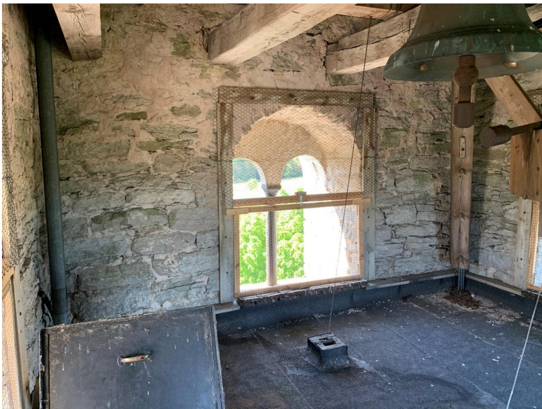
Klockvåningen mot söder. Foto JL 2020.
