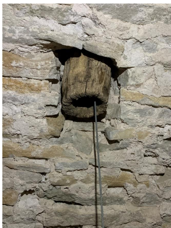
Hål för klocklina i valvet över tornets tredje övervåning, till höger med sturk (träskoning), möjligen medeltida. Foto JL 2020.
