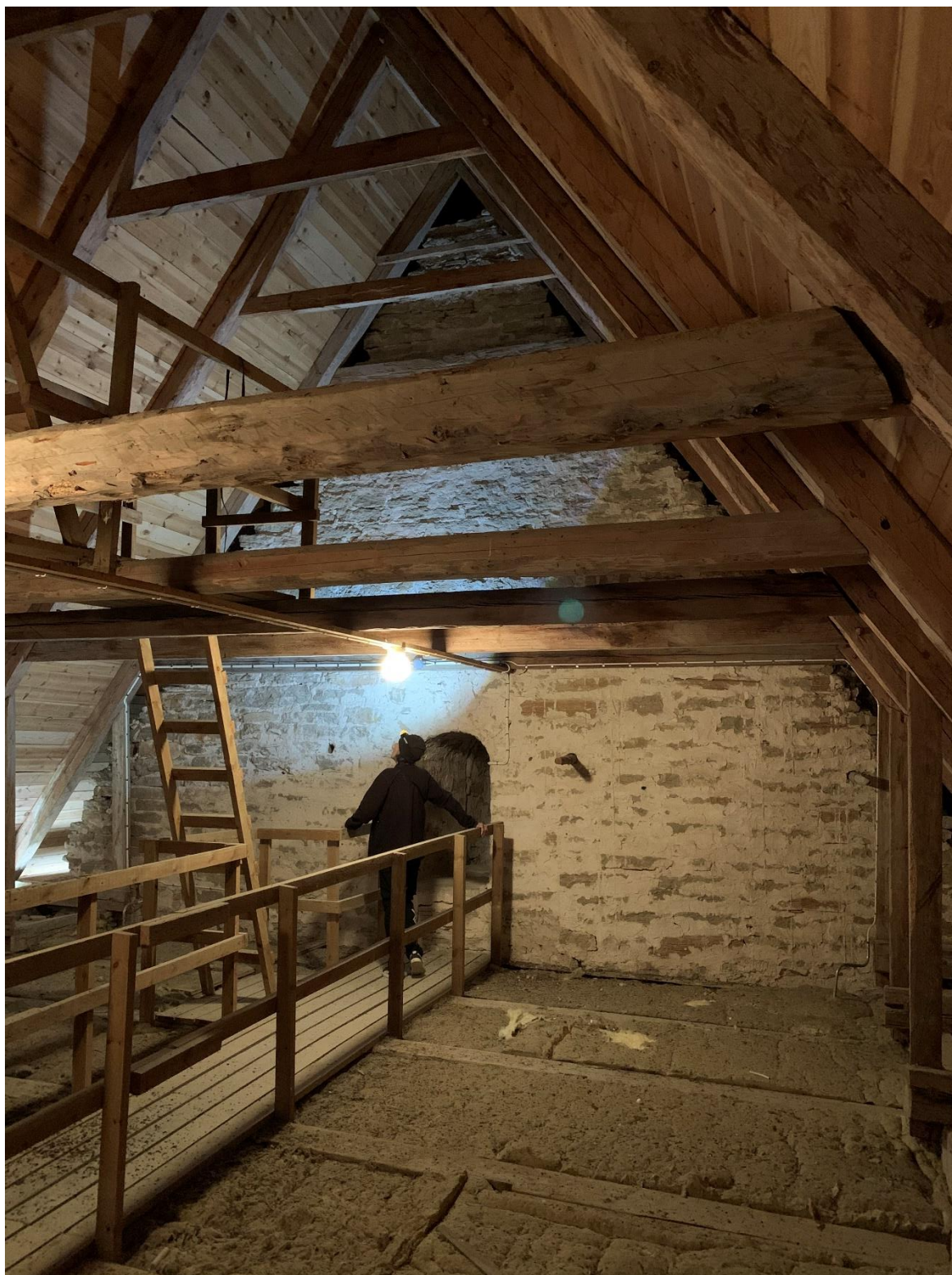
Långhusvinden sedd mot väster.
