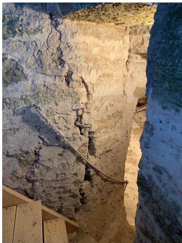
Murtrappans mynning i tornets första övervåning med spår av ingrepp i murverket. Foto JL 2020.
