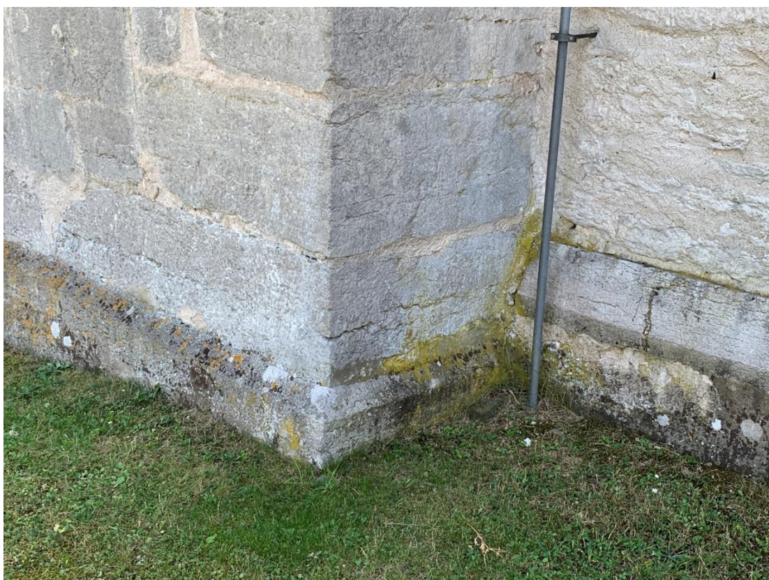
Sockeln i långhusets nordvästra hörn vid mötet med tornets sockel till höger. Foto JL 2020.
