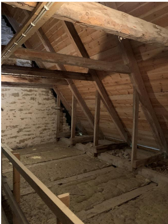
Långhusvinden mot nordväst och norr. Några av bjälkarna för innertakets bjälklag är försedda med urtag och har möjligen utgjort bindbjälkar för en tidigare takstol. Foto JL 2020.
