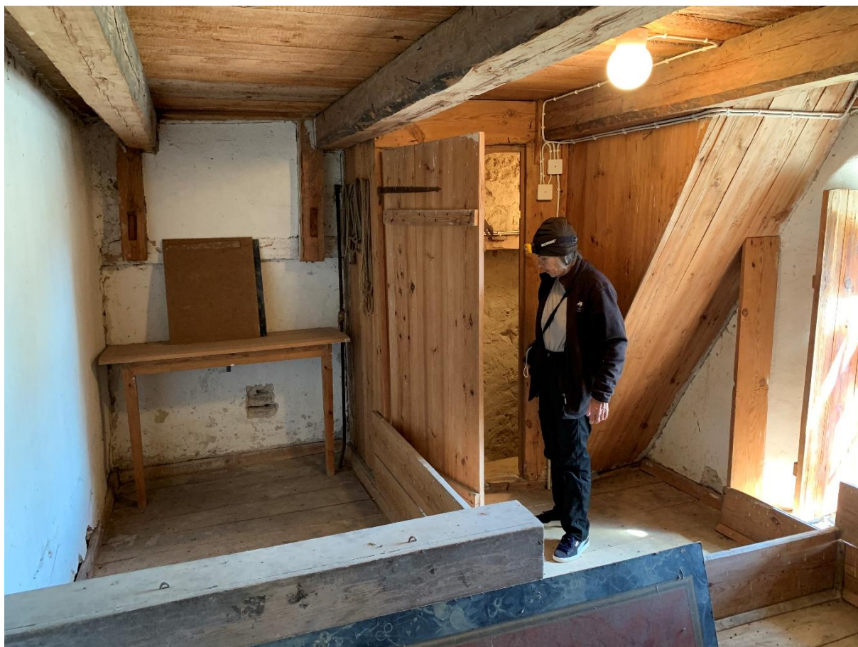
Magasinssrum i våningen över sakristian, sett mot norr med dörr från trapphuset. Foto JL 2020.
