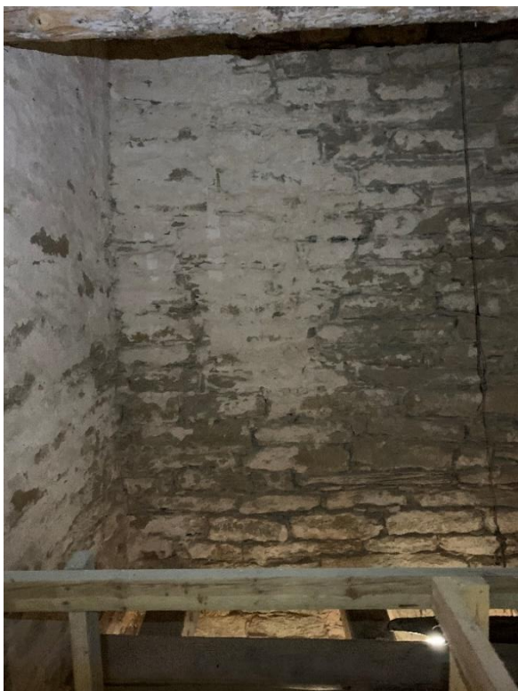
Tornets andra övervåning sedd mot söder vid sydöstra hörnet samt mot sydväst. Ljuset nedtill i vänstra bilden kommer från den kolonnettförsedda gluggen i våningen under. Våningen saknar eget ljusinsläpp. Murarna har kvarsittande puts. Till höger syns de parställda bjälkar som går över rummet i öst-västlig riktning. Foto JL 2020.
