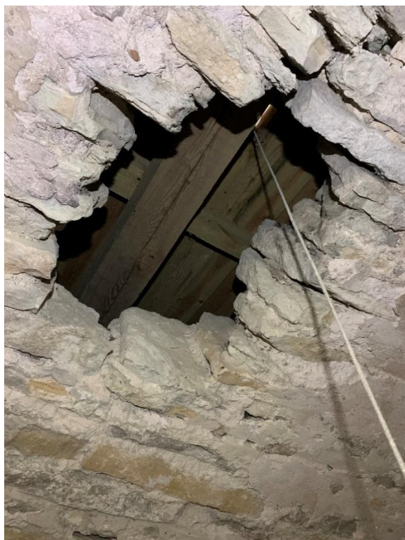
Hål för klocklina i valvet över tornets tredje övervåning, till höger med sturk (träskoning), möjligen medeltida. Foto JL 2020.
