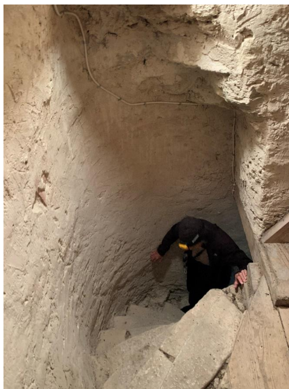
Trappan till magasinet i sakristians övervåning, byggd på 1850-talet med trappsteg av murstenar från den rivna absiden. Foto JL 2020.
