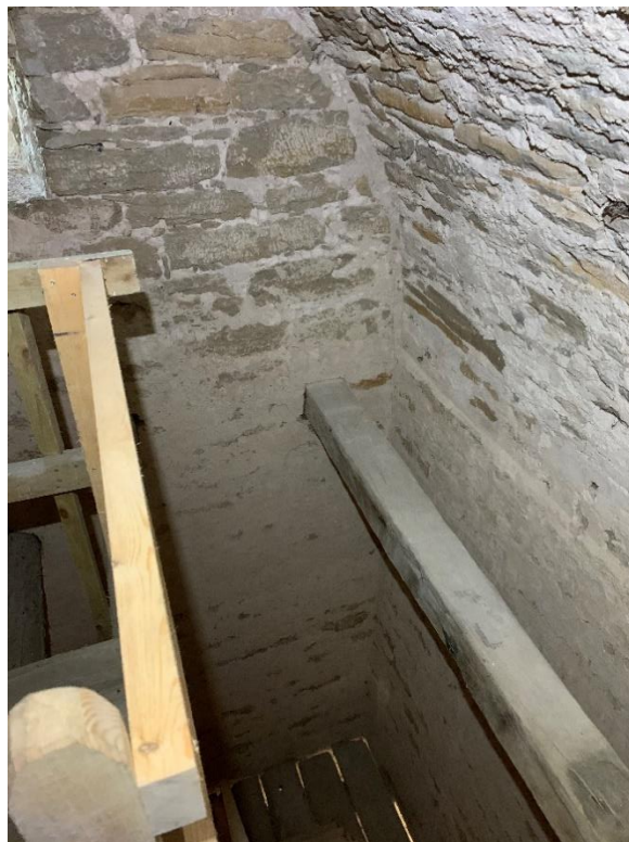
Tornets tredje övervåning. Tunnvalvets anfang i sydöstra resp. nordvästra hörnet. Valvet kragar över sköldmuren. Skarp putsgräns saknas mellan våningarna vilket tyder på att heltäckande bjälklag saknas. Foto JL 2020.
