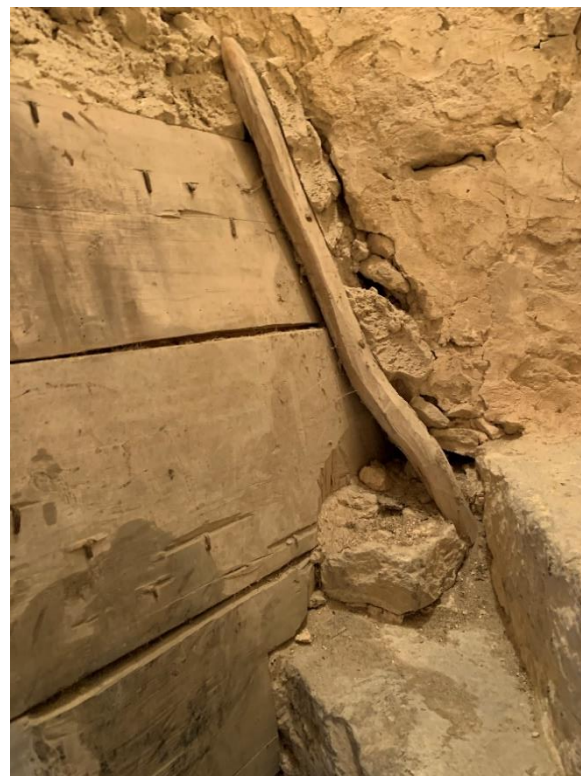
Igensättning med bräder i torntrappan, ett stycke ovanför trappdörrens västra post. Foto JL 2020.
