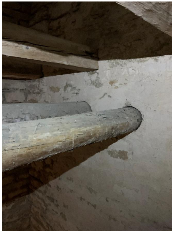
Tornets andra övervåning sedd mot söder vid sydöstra hörnet samt mot sydväst. Ljuset nedtill i vänstra bilden kommer från den kolonnettförsedda gluggen i våningen under. Våningen saknar eget ljusinsläpp. Murarna har kvarsittande puts. Till höger syns de parställda bjälkar som går över rummet i öst-västlig riktning. Foto JL 2020.
