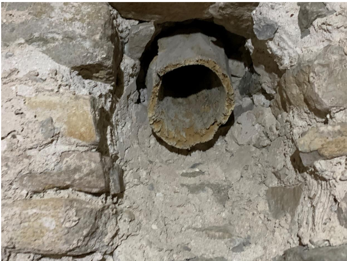
Kvarsittande sturk i ett äldre klockhål i tornets tredje övervåning. Foto JL 2020.
