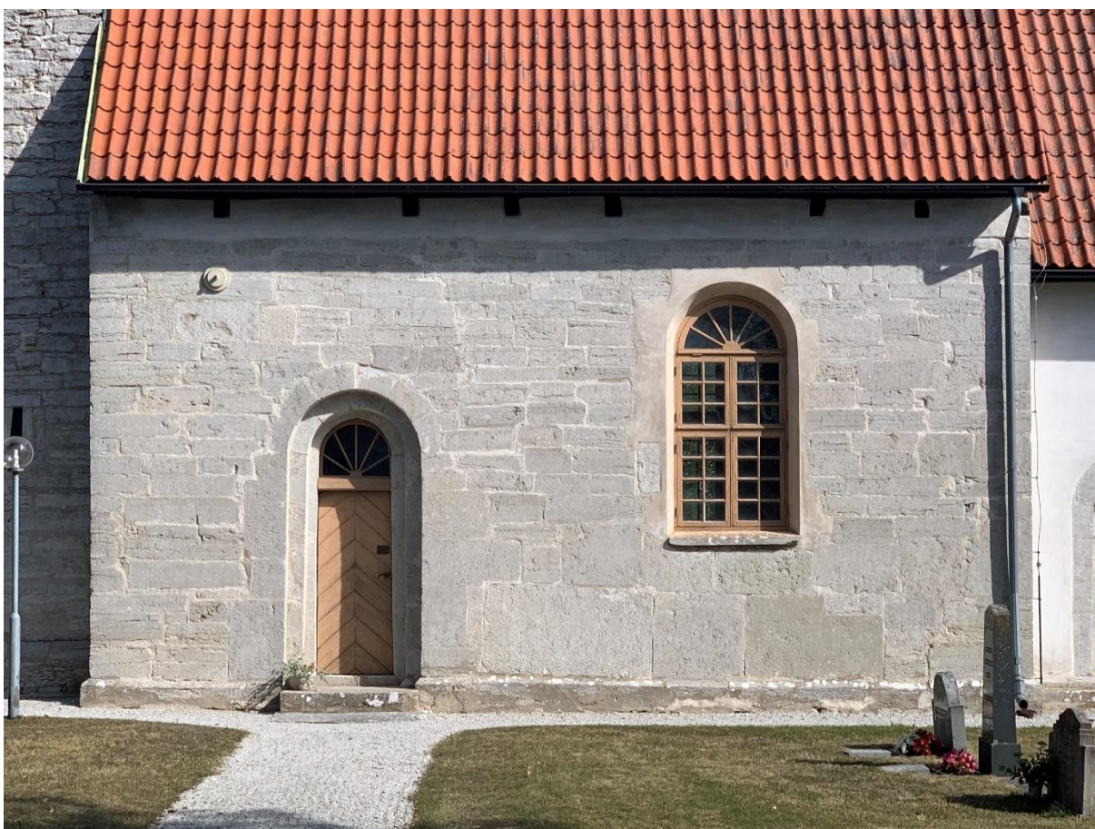
Långhusets sydfasad. Foto JL 2020.
