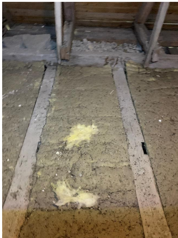
Långhusvinden mot nordväst och norr. Några av bjälkarna för innertakets bjälklag är försedda med urtag och har möjligen utgjort bindbjälkar för en tidigare takstol. Foto JL 2020.
