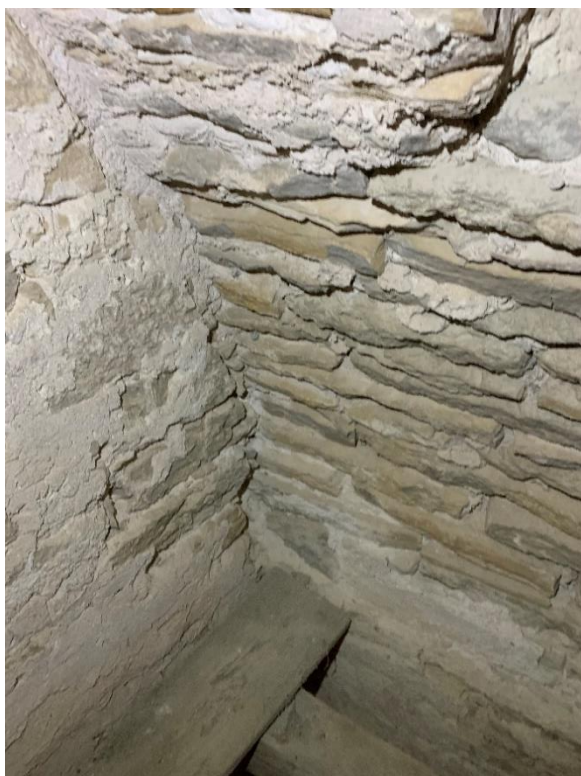
Tornets tredje övervåning. Tunnvalvets anfang i sydöstra resp. nordvästra hörnet. Valvet kragar över sköldmuren. Skarp putsgräns saknas mellan våningarna vilket tyder på att heltäckande bjälklag saknas. Foto JL 2020.
