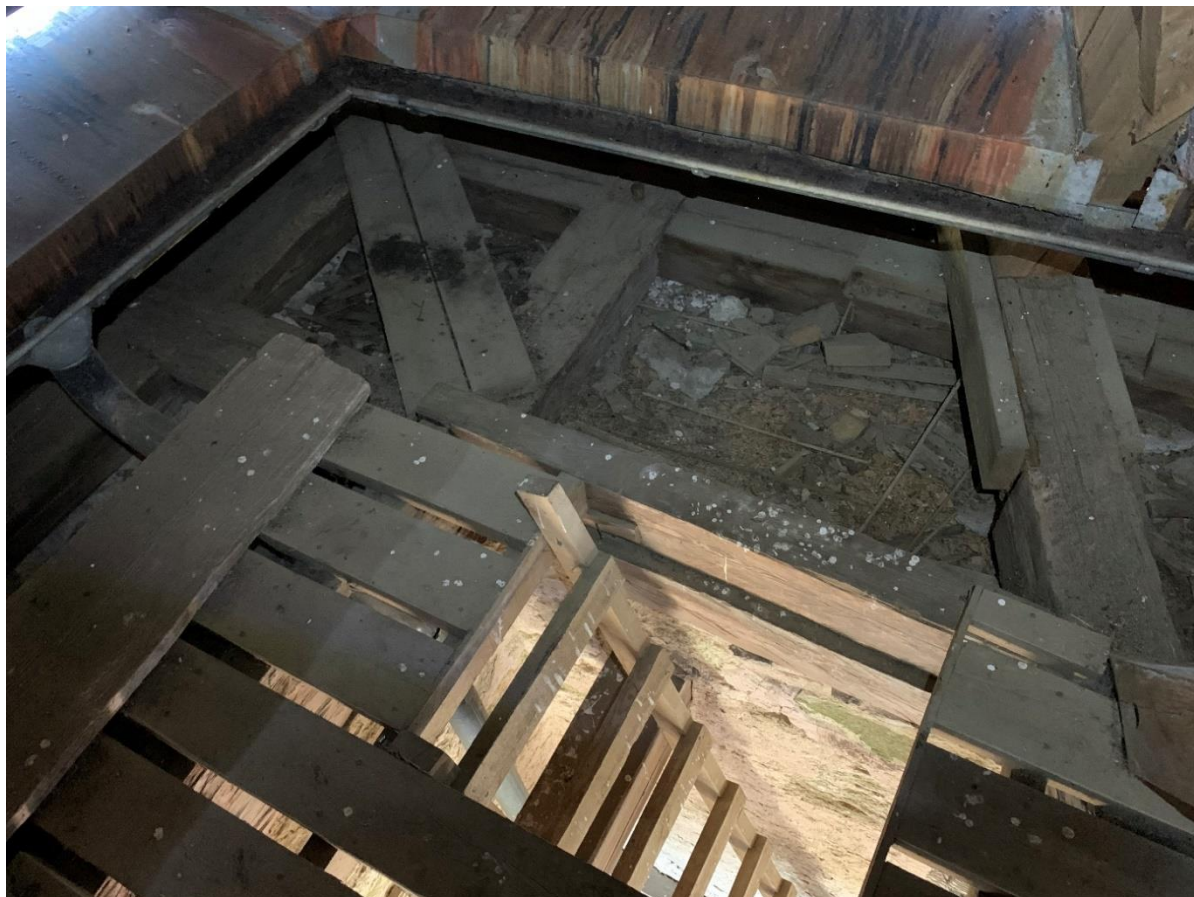
Tornhuvens syllar på murkrönet, sedda mot nordväst. Foto JL 2020.
