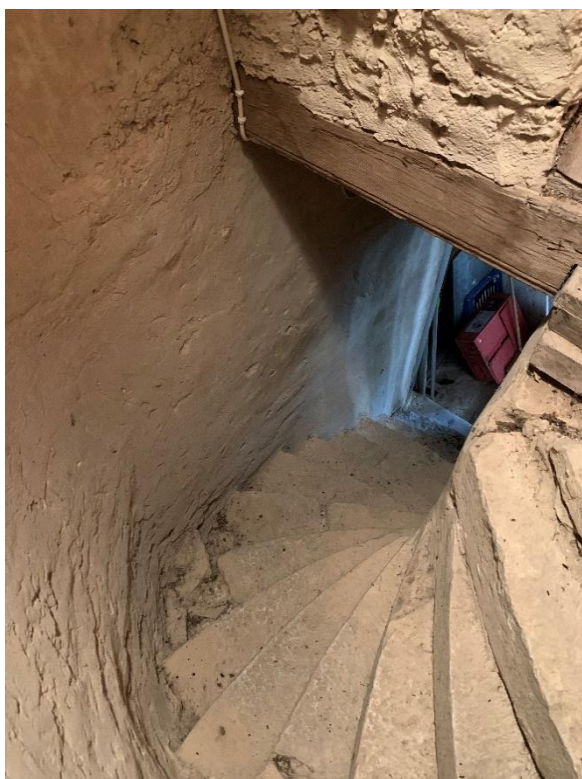
Trappan till magasinet i sakristians övervåning, byggd på 1850-talet med trappsteg av murstenar från den rivna absiden. Foto JL 2020.
