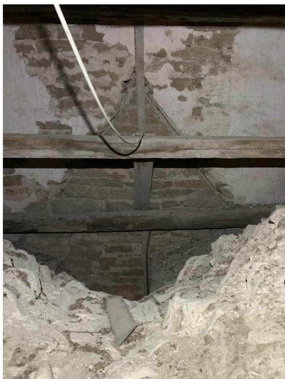
Avtryck av det äldre långhusets takfall i tornets murverk. Tornets östra mur restes emot det äldre långhusets takstol. Vy från långhusvinden mot väster. Foto JL 2020.
