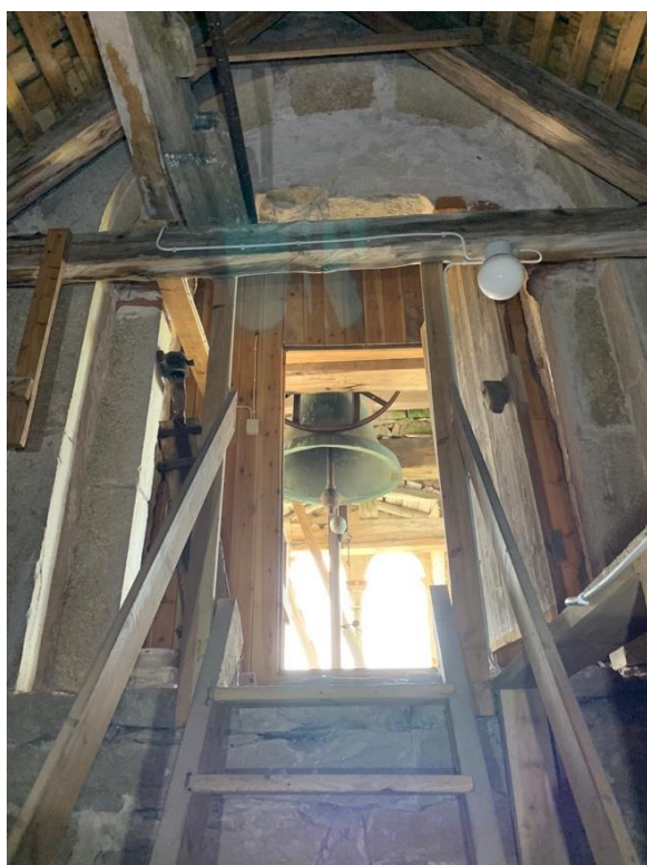
Tornets nedre östra ljudglugg sedd från öster, omgjord till passage till långhusvinden. Till höger långhusvinden mot sydväst visande tornets östra mur med kvarsittande 1200-talsputs sedan tiden före nuvarande långhusets tillkomst. Det grövre murade partiet utgör den södra delen av nuvarande långhus västra mur. Foto JL 2020.
