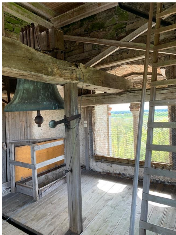
Klockvåningen i tornets tredje ovanvåning, sedd mot sydöst. Till vänster den trävägg med dörr som genom våningens tidigare östra ljudglugg leder in på kyrkvinden. Bilden till höger visar våningens västra ljudglugg med kvarsittande träkonstruktion för valvslagningen. Foto JL 2020.
