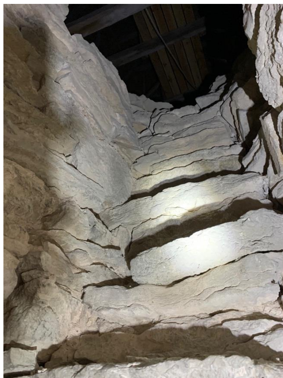
Passage till kyrkvinden från tornets första övervåning. Ledde tidigare till den äldre kyrkans vind men försågs med brant trappa till förbi nuvarande långhusets valv. Till höger trappan sedd underifrån mot öster. Foto JL 2020.
