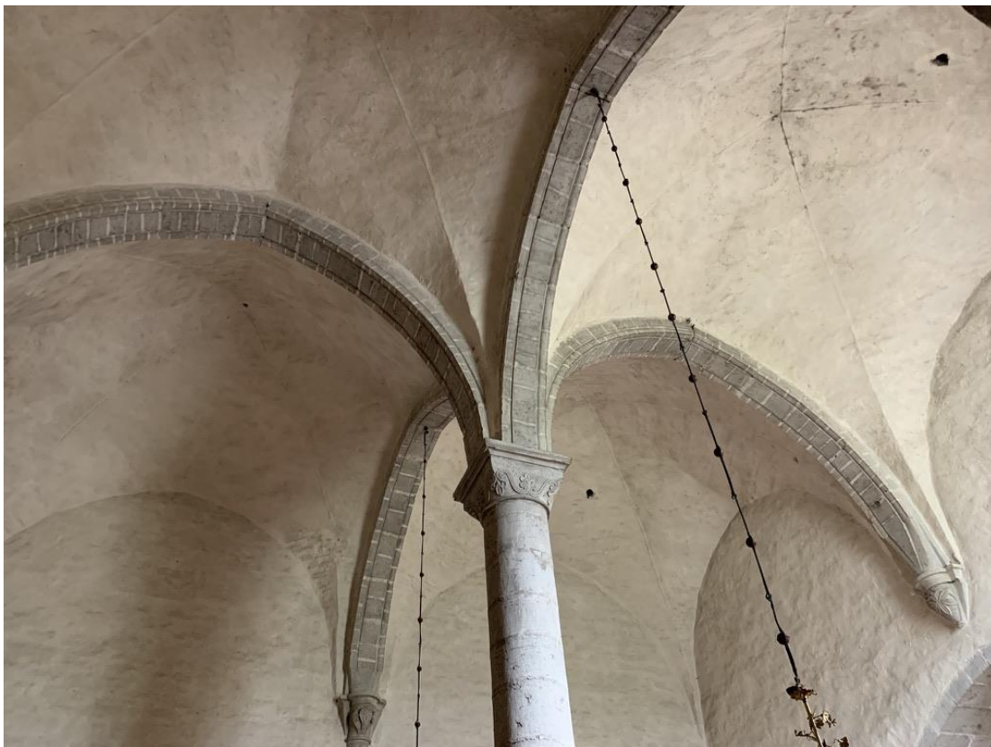
Långhusets valv sedda underifrån mot nordöst. Foto JL 2020.
