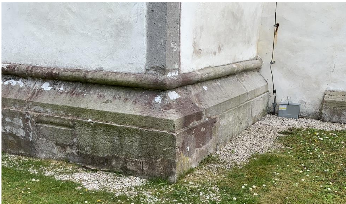
Sockeln i långhusets nordvästra hörn. Till höger tornets sockel som ansluter på visst avstånd både på södra och norra sidan. Till vänster sannolikt återanvänd detalj från äldre kyrkan, sannolikt sockeln eller en omfattning. Foto JL 2020.
