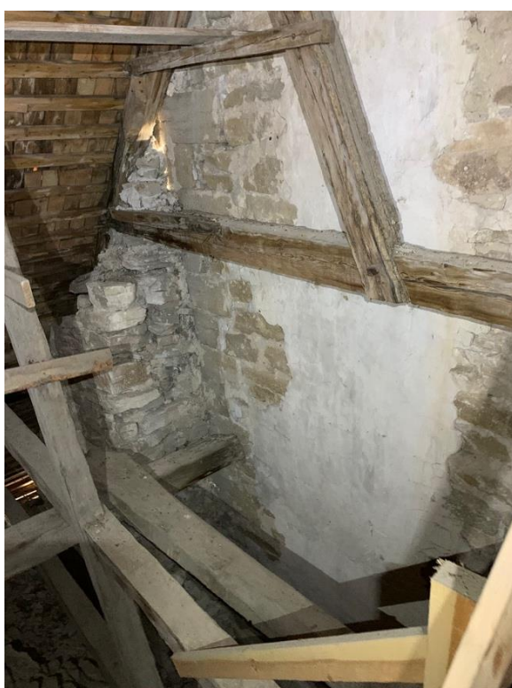
Tornets nedre östra ljudglugg sedd från öster, omgjord till passage till långhusvinden. Till höger långhusvinden mot sydväst visande tornets östra mur med kvarsittande 1200-talsputs sedan tiden före nuvarande långhusets tillkomst. Det grövre murade partiet utgör den södra delen av nuvarande långhus västra mur. Foto JL 2020.
