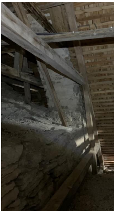
Öppningen mellan långhusets och korets vind, sedd från sydöst. Vid sänkningen av yttertaket tangerar taklinjen båglinjen. Foto JL 2020. Till höger detalj med avtryck av skållbräder (formbräder) från det att bågen slogs över öppningen. Avtrycket i putsen tyder på att bräderna kom från väderbitet faltak med skåror. Foto ES 2020.
