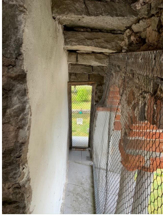
Passagen från tornets andra övervåning till norra galleriet. Till höger galleriet sett mot väster. Golvet sannolikt höjt. Delar av innertaket av flata hällar bevarat under yttertaket av trä. Foto JL 2020.
