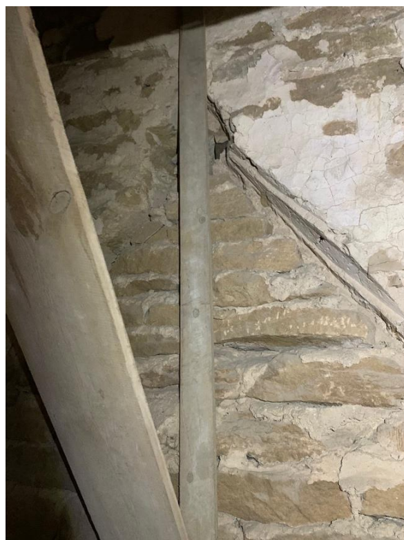
Avtryck av det äldre långhusets takfall i tornets murverk. Tornets östra mur restes emot det äldre långhusets takstol. Vy från långhusvinden mot väster. Foto JL 2020.
