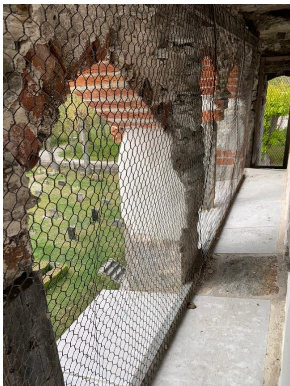
Tornets södra galleri sett mot väster. Golvet sannolikt höjt. Till höger galleriets inre avtäckning av flata hällar under vttertaket av trä, sett mot väster. Foto IL 2020.
