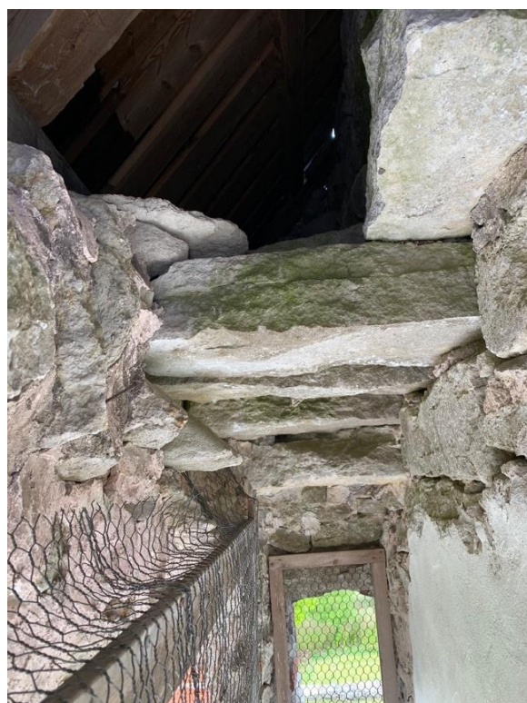
Tornets södra galleri sett mot väster. Golvet sannolikt höjt. Till höger galleriets inre avtäckning av flata hällar under vttertaket av trä, sett mot väster. Foto IL 2020.
