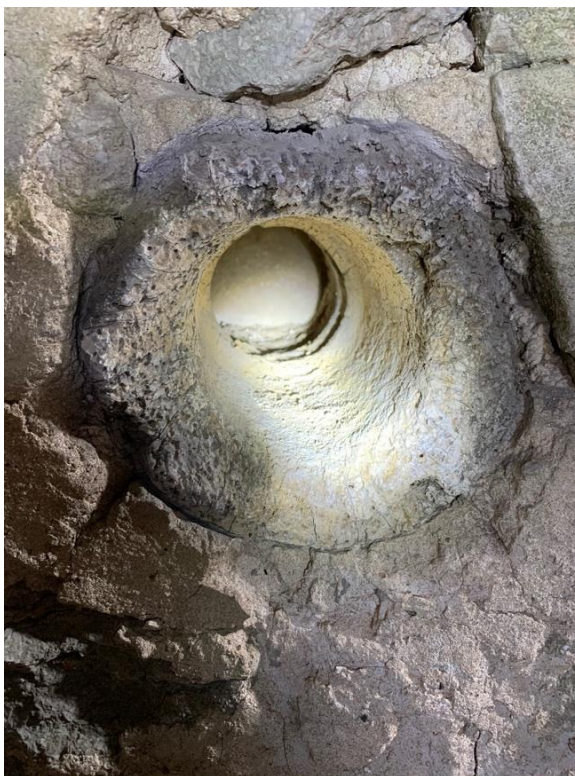
Hål med träskoning i östra muren till tornets första övervåning. Foto JL 2020.
