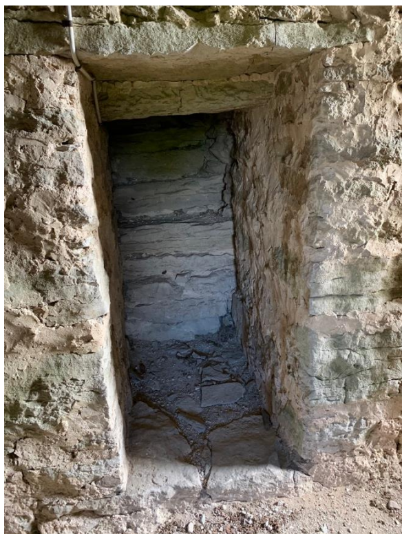
Passage till kyrkvinden från tornets första övervåning. Ledde tidigare till den äldre kyrkans vind men försågs med brant trappa till förbi nuvarande långhusets valv. Till höger trappan sedd underifrån mot öster. Foto JL 2020.
