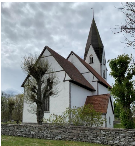
Exteriör från nordöst. Foto JL 2020.
