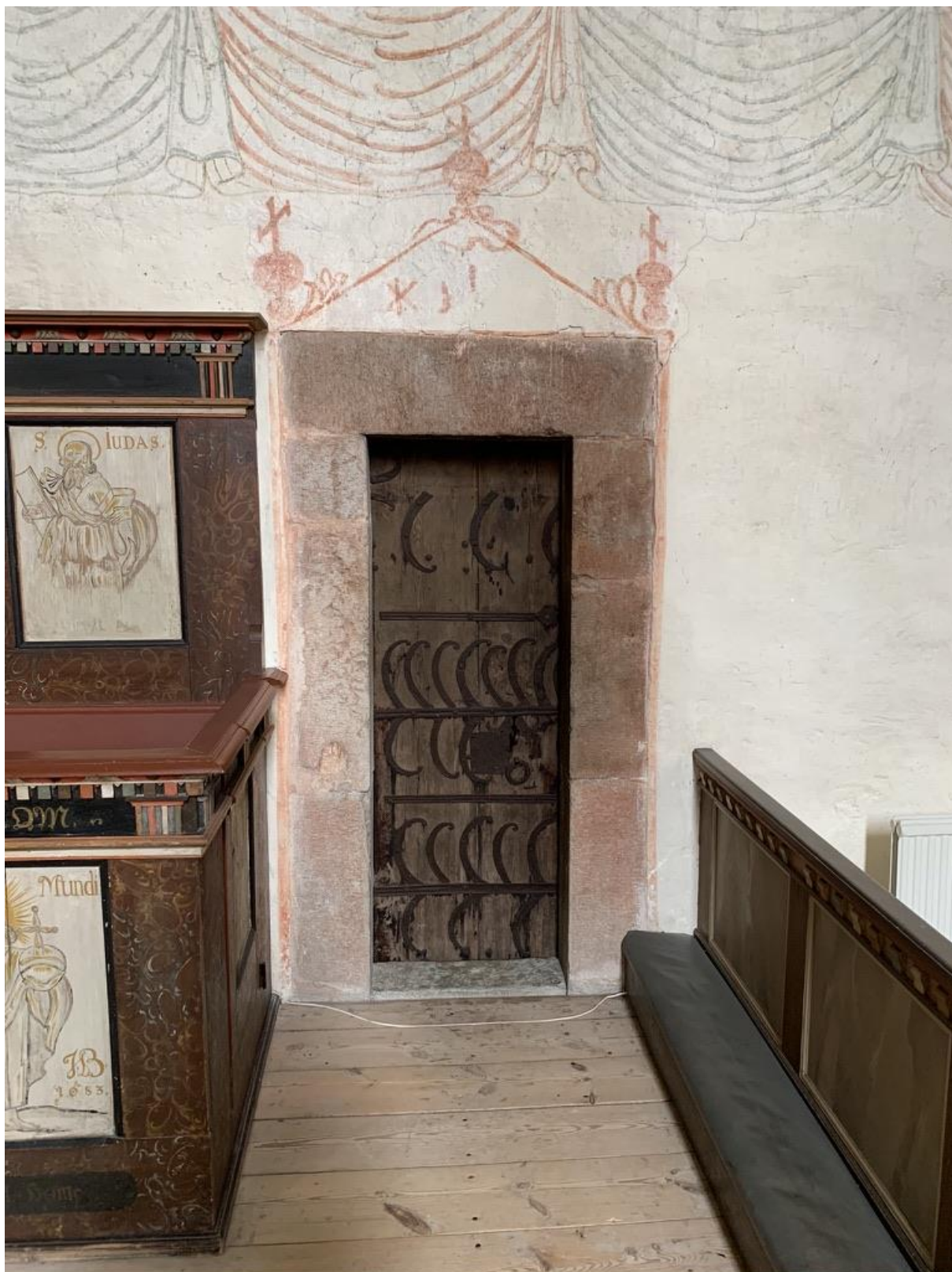
Ingång till sakristian med medeltida beslag på dörren och målad omfattning, sannolikt från 1600-talet. Dörren återinsattes 1952 efter att ha använts i trägolvet mellan tornets övervåningar. Foto JL 2020.
