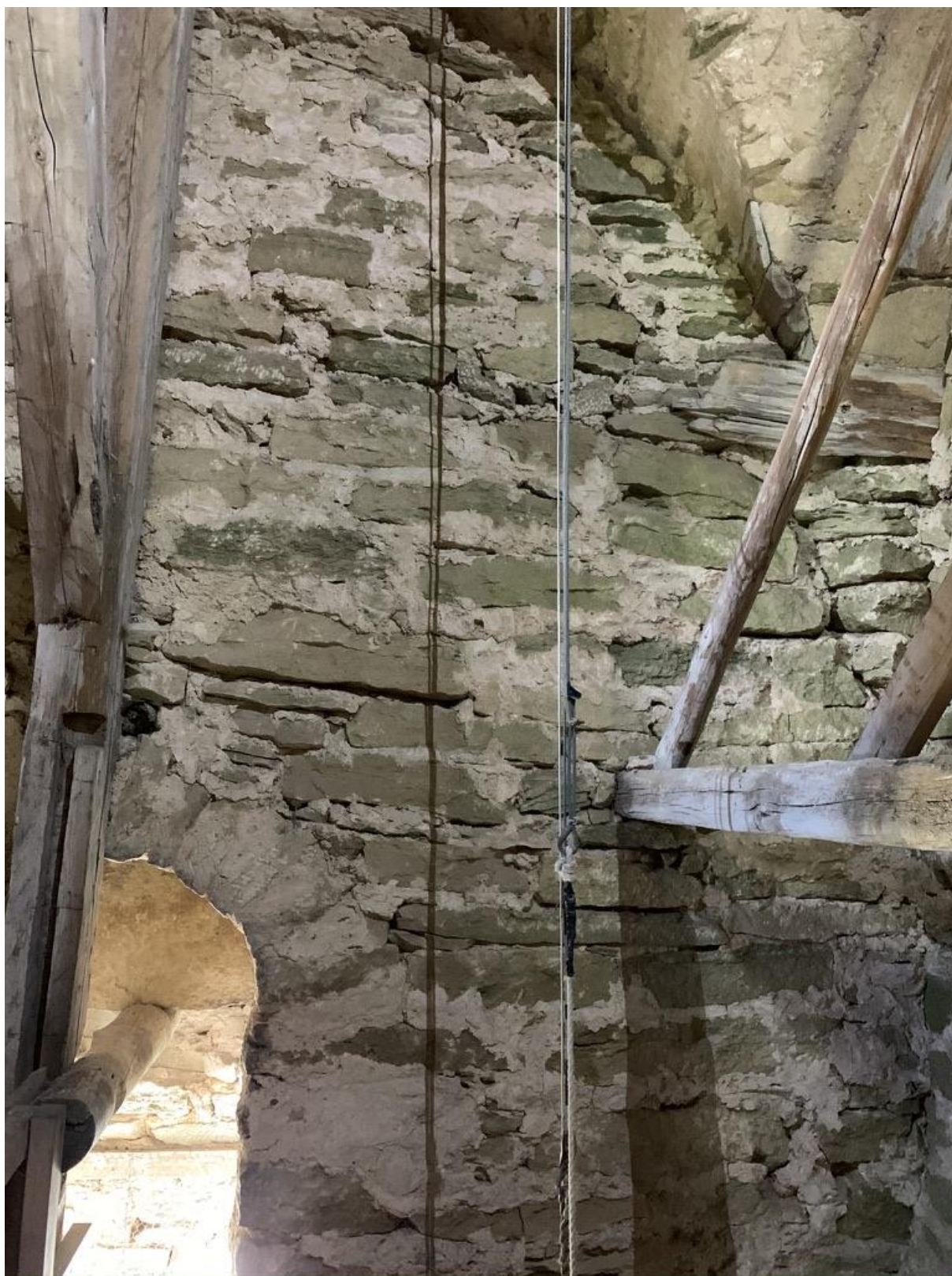
Tornets andra övervåning mot norr. Öppningen leder till norra galleriet. Stolpen till vänster ingick i magasinets skiftesverksvägg. Muren visar att valvet planerades ligga något lägre och förbereddes med en hörnkonsol, några stenskiift hög. Ett par skälbräder från valvslagningen sitter kvar. Foto JL 2020.
