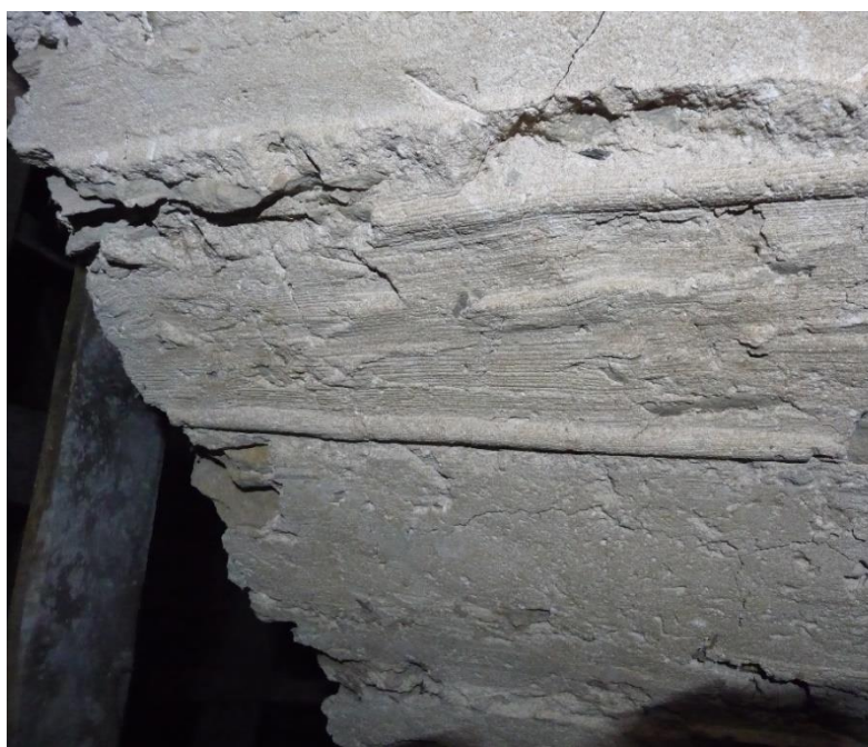
Öppningen mellan långhusets och korets vind, sedd från sydöst. Vid sänkningen av yttertaket tangerar taklinjen båglinjen. Foto JL 2020. Till höger detalj med avtryck av skållbräder (formbräder) från det att bågen slogs över öppningen. Avtrycket i putsen tyder på att bräderna kom från väderbitet faltak med skåror. Foto ES 2020.
