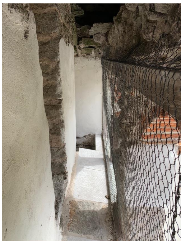
Tornets södra galleri sett mot öster. Öppningarnas bågar ommurade vid okänd tid. Till höger trappan upp till tornets andra övervåning, nu ej i bruk. Foto JL 2020.
