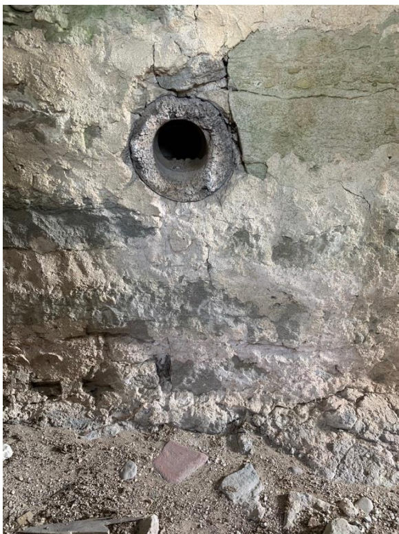
Hål med träskoning i östra muren till tornets första övervåning. Foto JL 2020.
