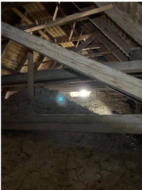
Korvinden mot öster från vindens södra del. Foto JL 2020.
