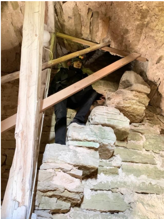
Trappan av utskjutande stenar i östra muren av tornets andra övervåning. Till höger sedd uppåt mot söder med ursprunglig passage genom valvet upp till nästa våning. Foto JL 2020.
