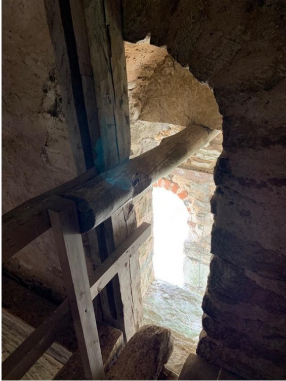
Passagen från tornets andra övervåning till norra galleriet. Till höger galleriet sett mot väster. Golvet sannolikt höjt. Delar av innertaket av flata hällar bevarat under yttertaket av trä. Foto JL 2020.
