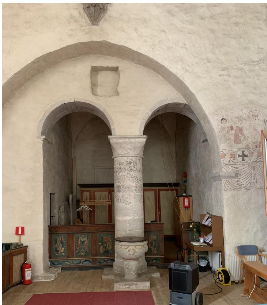
Arkadbågar till ringkammaren. Nischen ovanför kolonnen sannolikt urtag för planerad valvkonsol i det äldre långhuset. Foto JL 2020.
