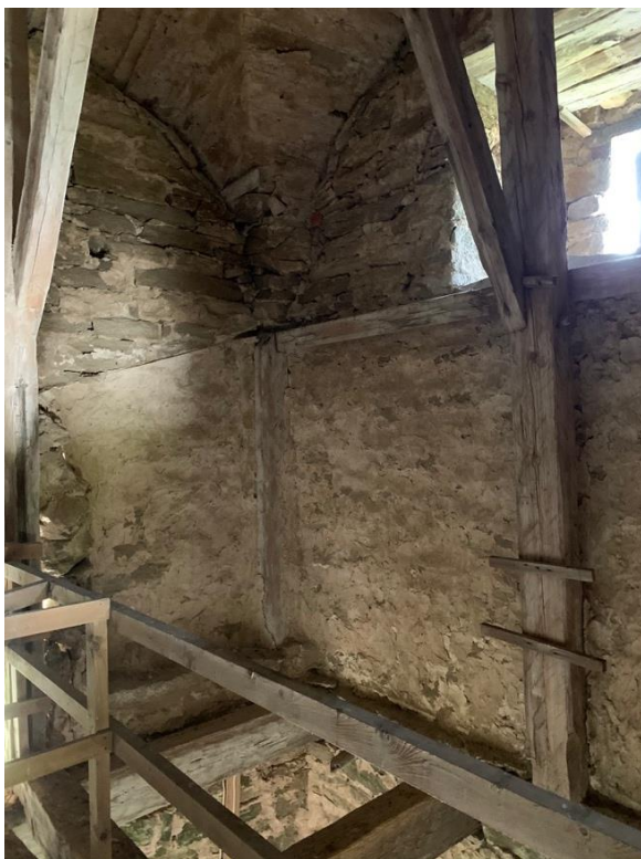
Tornets andra övervåning mot sydväst och nordväst. Väggarna visar spår av inbyggnad med putsade innerväggar, invändigt tak samt vägg, utförd i skiftesverksteknik. Sannolikt ett magasin. Foto JL 2020.
