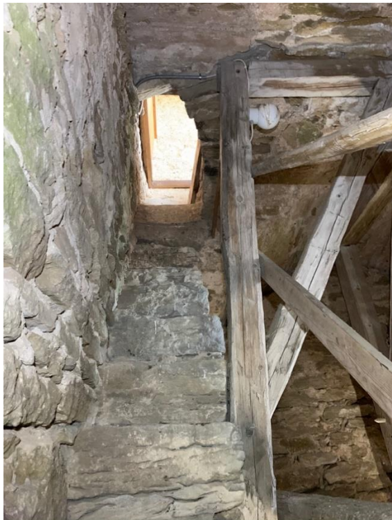
Trappan av utskjutande stenar i östra muren av tornets andra övervåning. Till höger sedd uppåt mot söder med ursprunglig passage genom valvet upp till nästa våning. Foto JL 2020.
