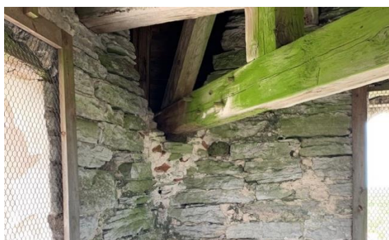
Tornets övre södra ljudglugg med kvarsittande stödkonstruktion från valvslagningen. Svicklar mellan tornets gavlar, sedda ovanifrån och från sidan. Foto JL 2020.
