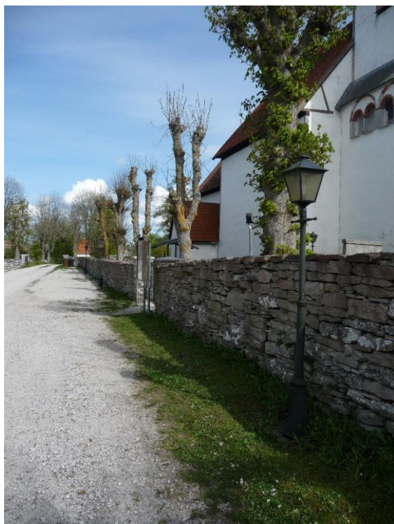
Den norra mursträckningen. Foto Es 2020.
