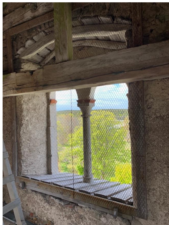
Klockvåningen i tornets tredje ovanvåning, sedd mot sydöst. Till vänster den trävägg med dörr som genom våningens tidigare östra ljudglugg leder in på kyrkvinden. Bilden till höger visar våningens västra ljudglugg med kvarsittande träkonstruktion för valvslagningen. Foto JL 2020.
