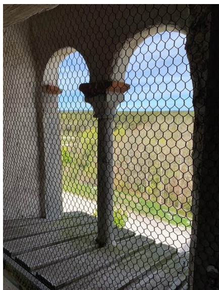
Klockvåningens norra ljudglugg. Ovanför öppningen anses rester av ett tidigare bjälklag, troligen för att bära klockorna, och ovanför det en sannolik skarv mot tornets yngre påbyggnad. Foto JL 2020.
