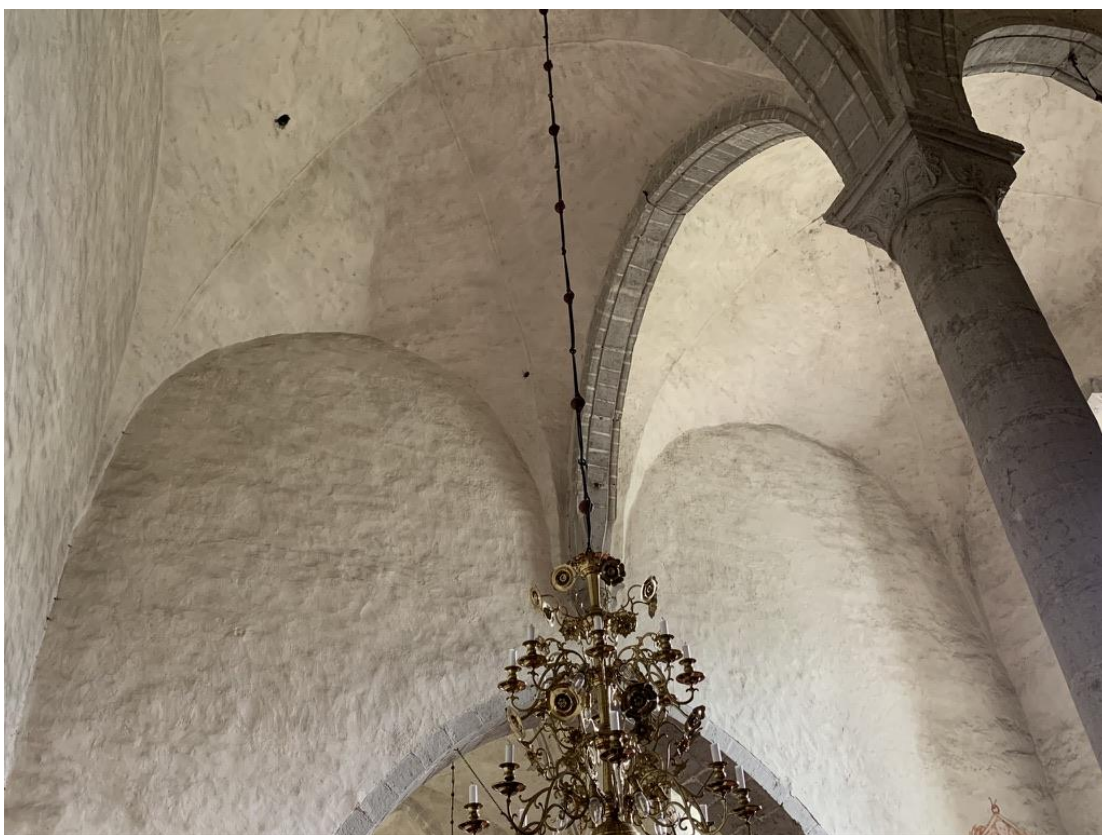
Långhusets valv sedda underifrån mot öster. Foto JL 2020.
