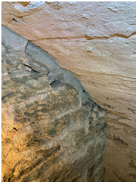
Tornets andra övervåning mot nordöst med avtryck av skälbräderna som användes när valvet slogs. Avtrycken visar att de var takbräder, sannolikt återanvända. Foto JL 2020.
