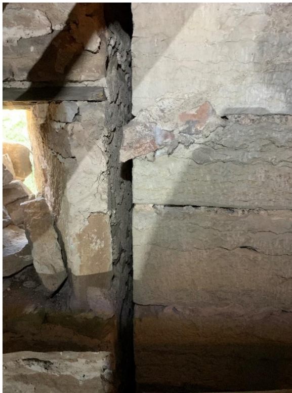
Långhusvindens sydvästra hörn med tornmurens släta murverk samt långhusets västra gavelmur, söder om tornet. T.h. springa mellan de båda murpartierna. Foto JL 2020.
