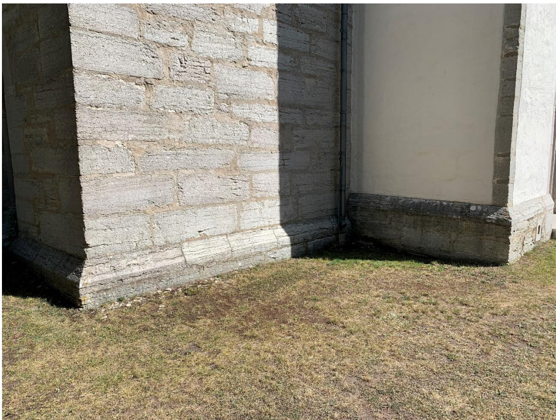
Tornets nedre del från sydväst. Foto JL 2020.
