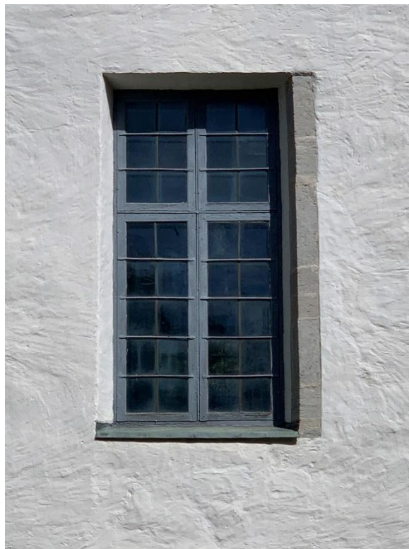
Långhusets sydfasad, östra delen, samt långhusets södra fönster med murad post från omfattningen innan fönstret förstörades. Foto JL 2020.
