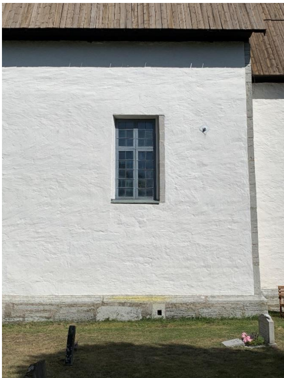
Långhusets sydfasad, östra delen, samt långhusets södra fönster med murad post från omfattningen innan fönstret förstörades. Foto JL 2020.
