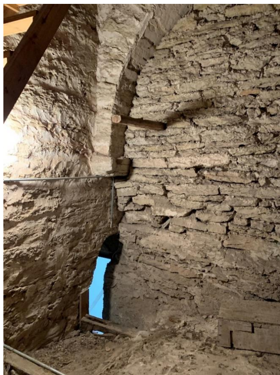
Uppgången uppe på långhuset mur norr om tornbågen, återöppnad 1961-62. T.h. tornets första övervåning sedd mot nordöst med uppgången från långhuset och igenmurad båge. Foto JL 2020.
