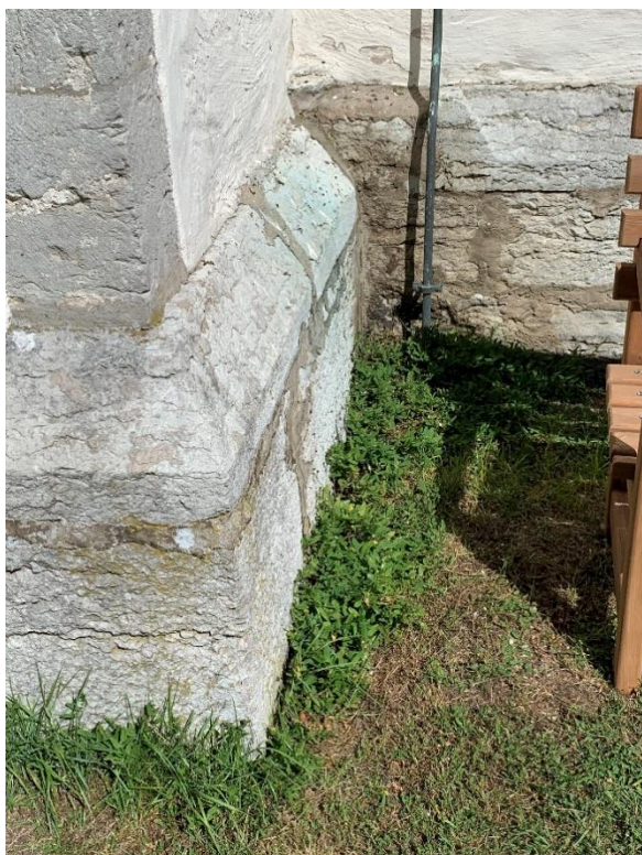
Sockeln vid långhusets sydöstra hörn och vid mötet med korsockeln. T. h. närbild. Sockeln på koret har en förtagning för långhusets sockel i ett annat läge, vilket visar att ett uppehåll skett innan korbygget följdes av långhuset.
