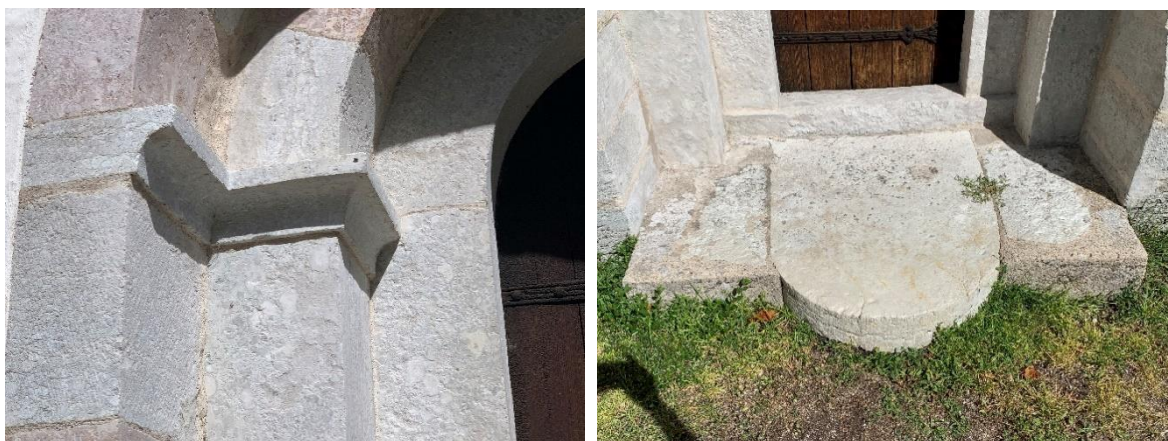
Korportalens västra kapitälband och trampstenen. Foto JL 2020.
