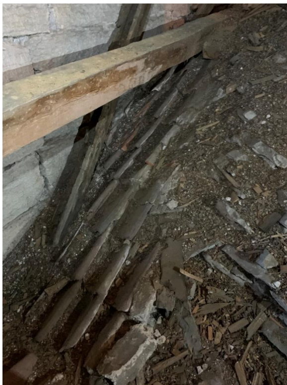
Springa mellan tornet och långhusets västra gavelmur norr om tornet. T.h. tegel utlagt, sannolikt för avrinning för att skydda valvet från dropp. Foto JL 2020.
