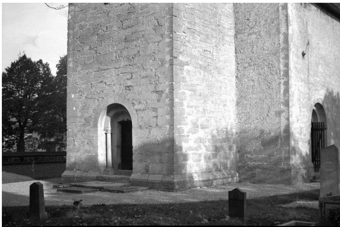
Tornets nedre del och långhusets sydvästra hörn. Foto Johnny Roosval 1947, Riksantikvarieämbetet, Kulturmiljöbild.
