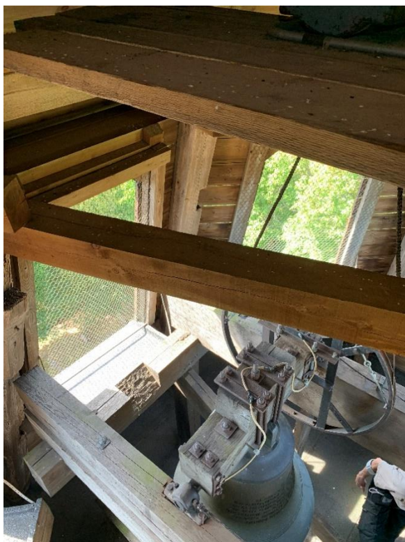
Klockvåningen i tornhuven med klockornas upphängning sedd ovanifrån. Foto JL 2020.
