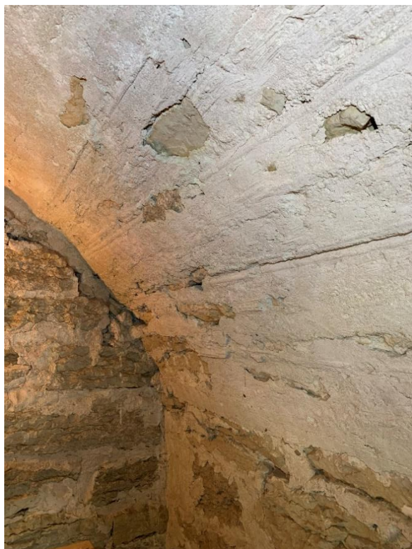
Tornets andra övervåning mot nordöst med avtryck av skälbräderna som användes när valvet slogs. Avtrycken visar att de var takbräder, sannolikt återanvända. Foto JL 2020.
