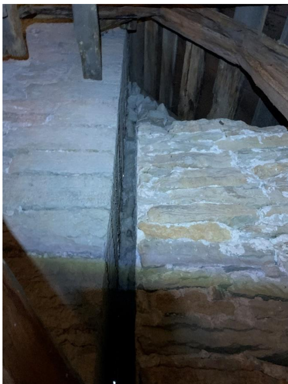
Springa mellan tornet och långhusets västra gavelmur norr om tornet. T.h. tegel utlagt, sannolikt för avrinning för att skydda valvet från dropp. Foto JL 2020.
