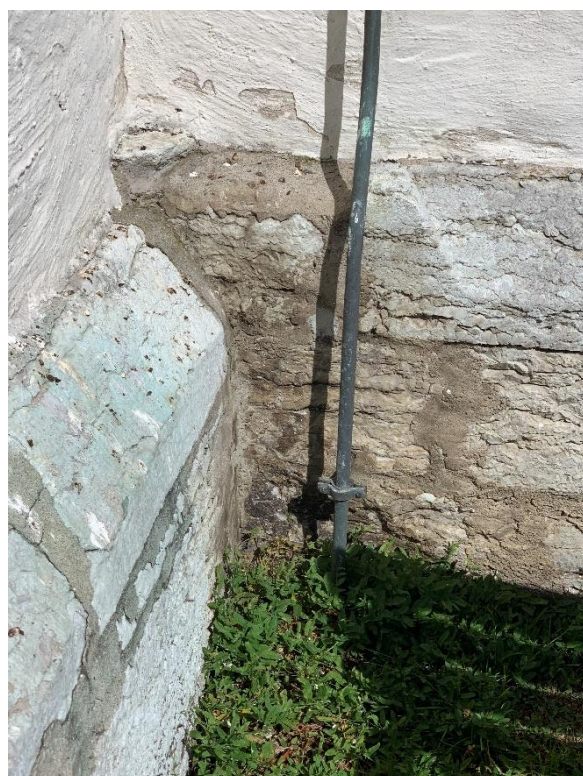
Sockeln vid långhusets sydöstra hörn och vid mötet med korsockeln. T. h. närbild. Sockeln på koret har en förtagning för långhusets sockel i ett annat läge, vilket visar att ett uppehåll skett innan korbygget följdes av långhuset.
