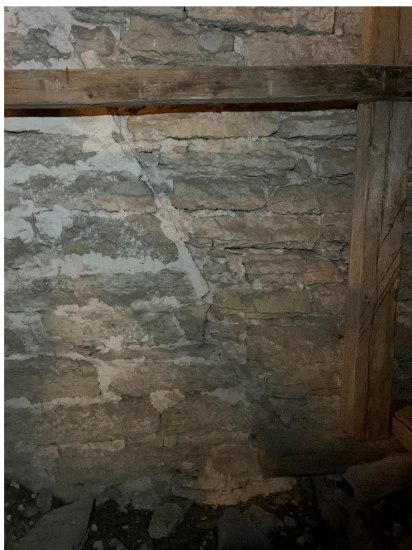
Långhusvindens sydöstra hörn där triumfbågsmuren visar att korets västra gavel, till vänster om skarven, byggdes innan långhusets gavelpåbyggnad. T.h. korvinden mot väster med den rundvälvda passagen mellan vindarna synlig. Gavelrösten blir något tunnare närmast yttertaket. Foto JL 2020.
