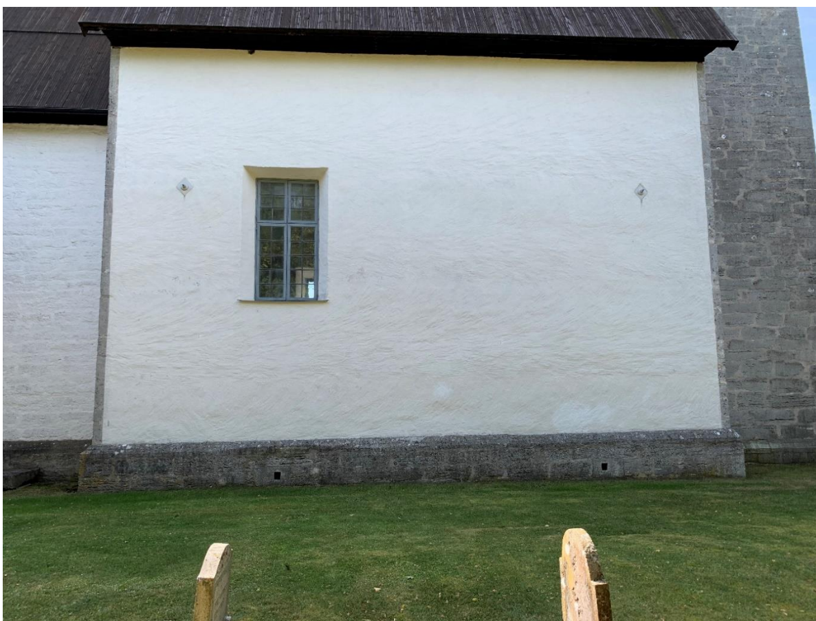
Långhusets nordfasad. Foto JL 2020.
