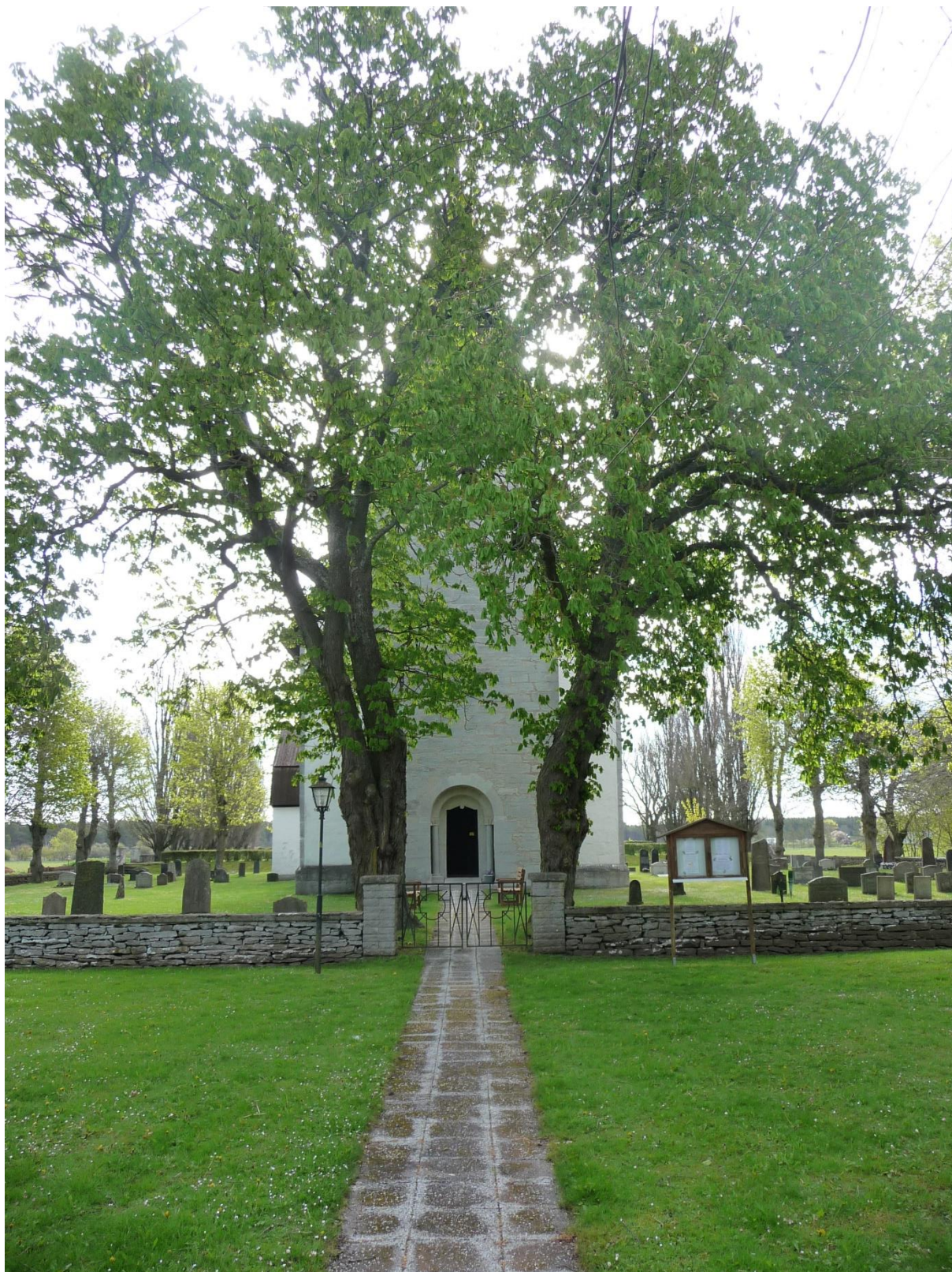
Huvudingången från väster. Gången är belagd med cementplattor. Vid ingången finns en järngrind med murade stolpar. Den flankeras av hästkastanjer. Foto ES 2020.
