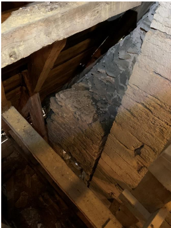
Långhusvindens sydvästra hörn med tornmurens släta murverk samt långhusets västra gavelmur, söder om tornet. T.h. springa mellan de båda murpartierna. Foto JL 2020.
