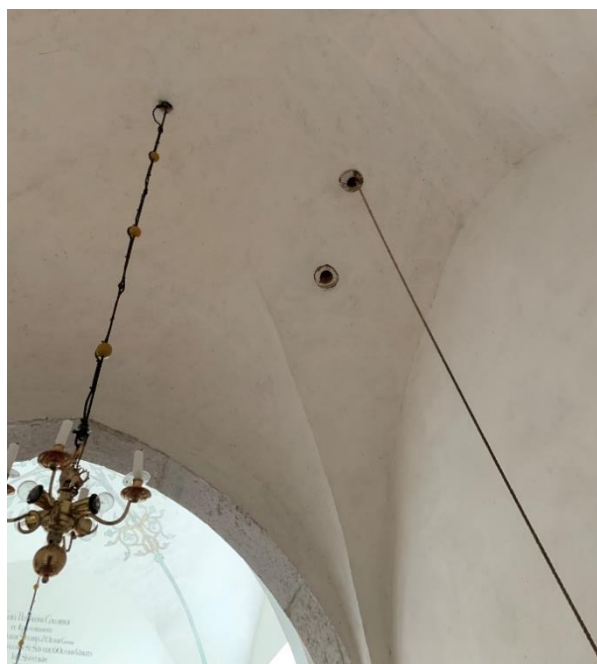
Valvet över ringkammaren i tornet sett mot sydöst med två linhål, försedda med sturkar i trä. Foto JL 2020.
