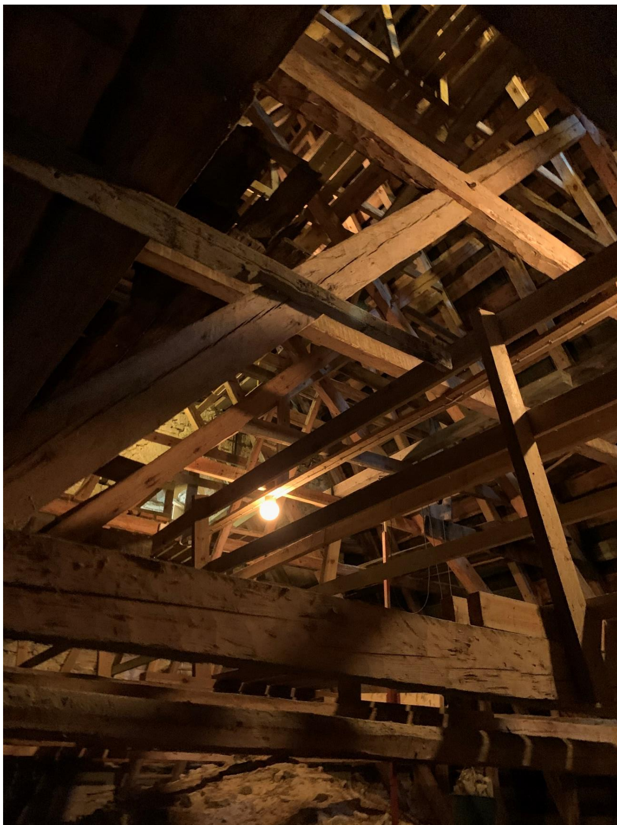
Långhusvinden sedd mot nordväst. Foto JL 2020.
