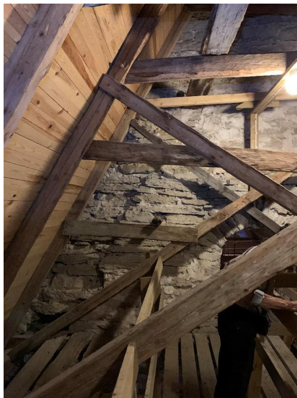
Långhusvindens sydöstra hörn där triumfbågsmuren visar att korets västra gavel, till vänster om skarven, byggdes innan långhusets gavelpåbyggnad. T.h. korvinden mot väster med den rundvälvda passagen mellan vindarna synlig. Gavelrösten blir något tunnare närmast yttertaket. Foto JL 2020.
