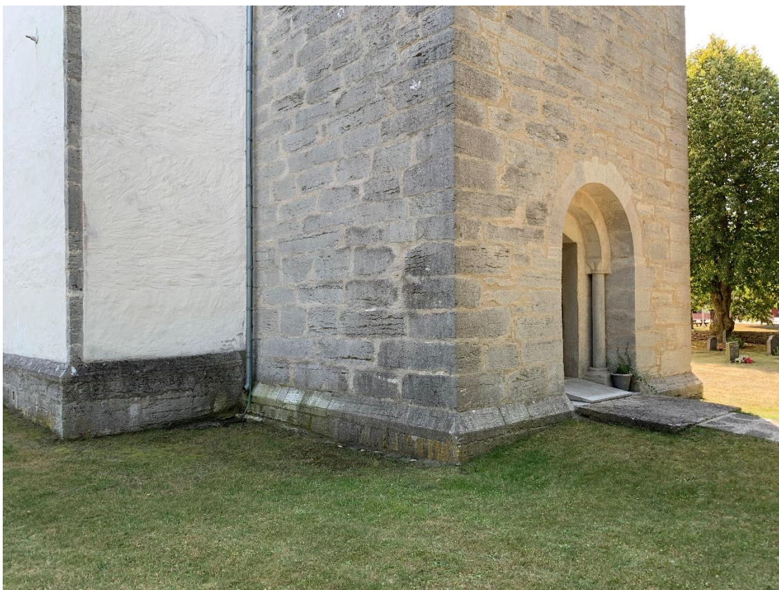
Tornets nedre del från nordväst. Foto JL 2020.
