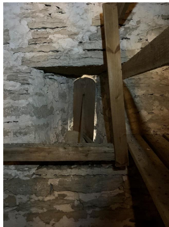
Långhusvindens sydöstra hörn där triumfbågsmuren visar att korets västra gavel, till vänster om skarven, byggdes innan långhusets gavelpåbyggnad. T.h. korvinden mot väster med den rundvälvda passagen mellan vindarna synlig. Gavelrösten blir något tunnare närmast yttertaket. Foto JL 2020.
