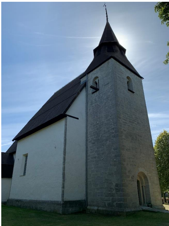
Exteriör från nordväst. Foto JL 2020.
