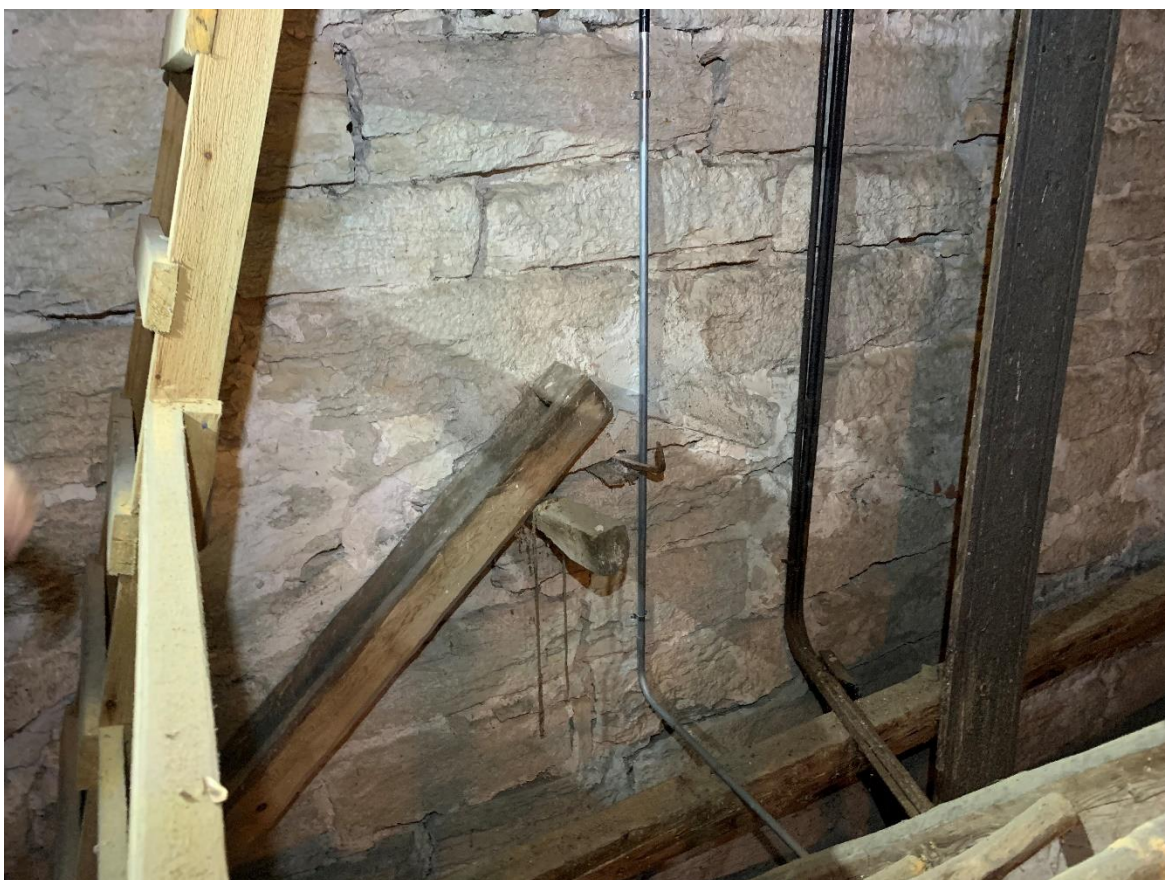
Tornets östra mur strax ovanför långhusvalvet med avtryck av tidigare, mycket flackt sadeltak, troligen skydd för valvet vid takdropp snarare än t.ex. den romanska kyrkans takfall. Foto JL 2020.
