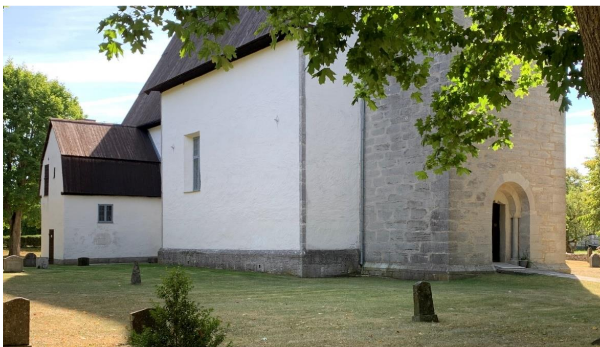
Exteriör från nordväst av kyrkans norra sida och tornets nedre del. Foto JL 2020.
