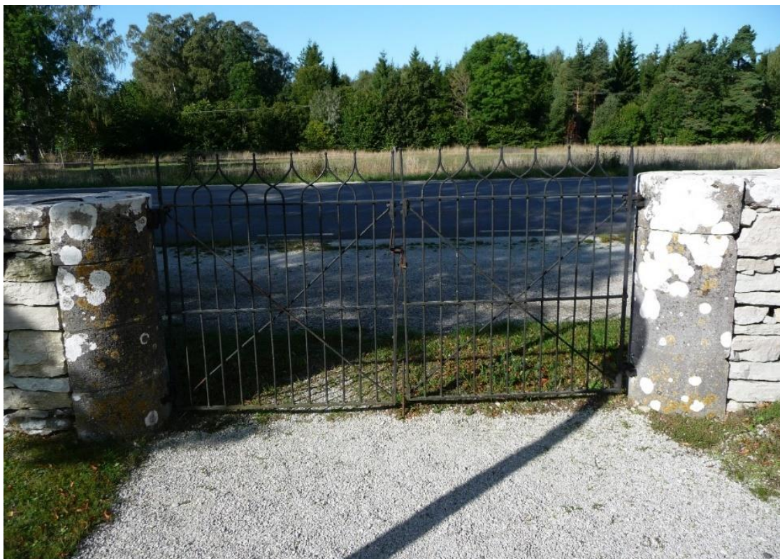
Huvudingången fotograferad från norr. En grind i svartmålat smidesjärn omges av halvcirkelformade stolpar vilka är en del av långhusets mittkolonn som togs bort 1838. På muren närmast grindstolparna ligger delar av altarskivor. Foto ES 2019.
