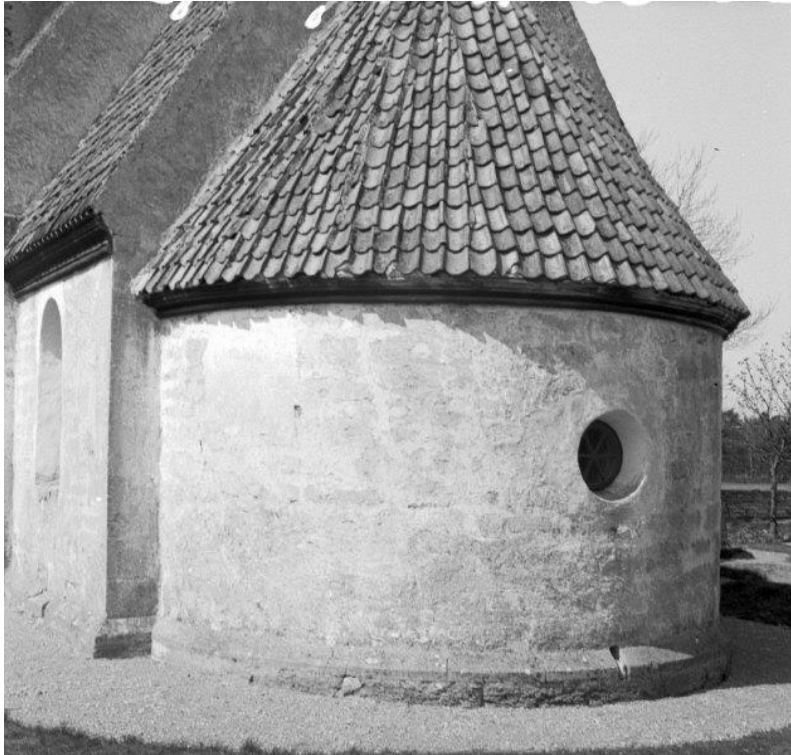
Absiden sedd från sydöst före den yttre restaureringen 1950, med tegeltak från 1800-talets förra hälft. Foto i RAÄ, Kulturmiljöbild.
