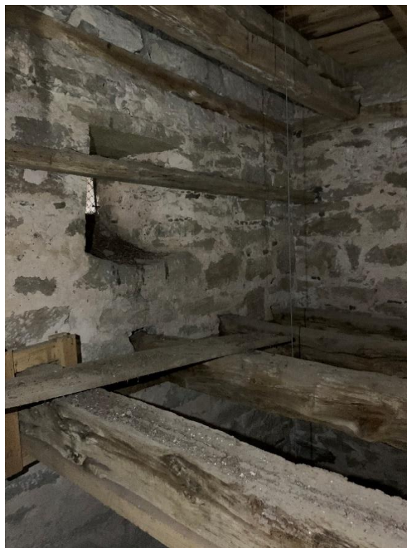
Till höger: Löst träföremål, sannolikt träskoning av linhållet genom valvet. Till vänster: Bjälklag och ljuglugg till en mellanvåning i tornet under klockvåningen, sedd mot nordväst. Foto JL 2020.
