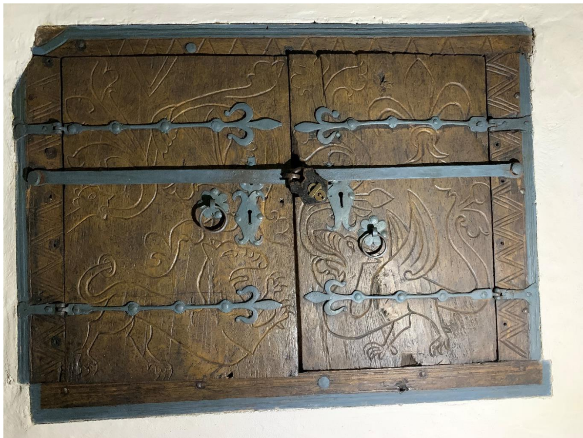
Väggsåp på absidens södra sida. Dörrar från 1200-talets andra fjärdedel. Foto JL 2020.
