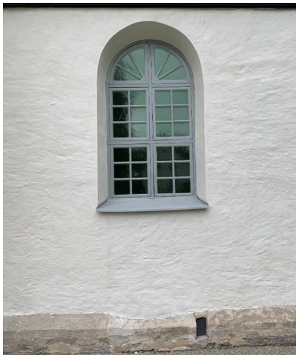
Korets sydfasad. Lagningen i sockeln visar läget för den tidigare korportalen, igensatt 1839-40. Den insatta stenen, se bilden nedan, utgörs av fönsterbänken från det tidigare korfönstret eller västfönstret. Foto JL 2020.
