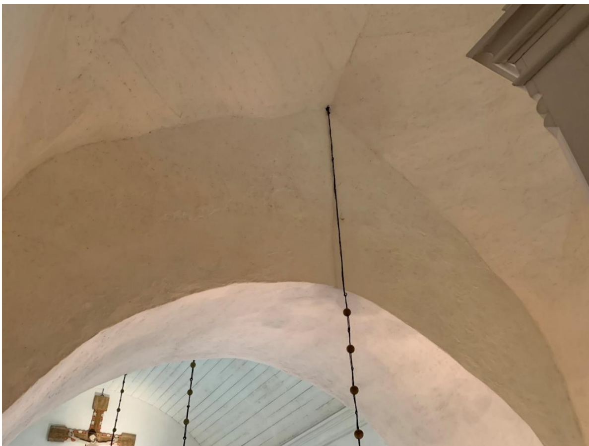
Murpartiet ovanför tornbågen sett från väster. Spår antyder att tornbågen delvis kan vara ommurad. Brunius uppger omkring. 1860 att den var spetsbågig. Foto JL 2020.
