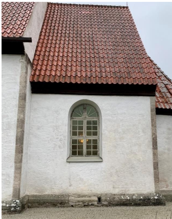
Korets sydfasad. Lagningen i sockeln visar läget för den tidigare korportalen, igensatt 1839-40. Den insatta stenen, se bilden nedan, utgörs av fönsterbänken från det tidigare korfönstret eller västfönstret. Foto JL 2020.
