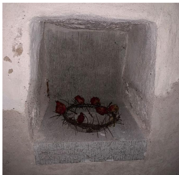
Till vänster: Nisch med piscina i muren på absidens södra sida. Medeltida, återöppnad 1965 efter att ha varit igenmurad. Foto JL 2020. Till höger: Nischen innan den bildsten som använts i nischen togs ut och ersattes av nyhuggna kalkstensblock. Foto Erik Olsson 1965. RAÄ, Kulturmiljöbild.
