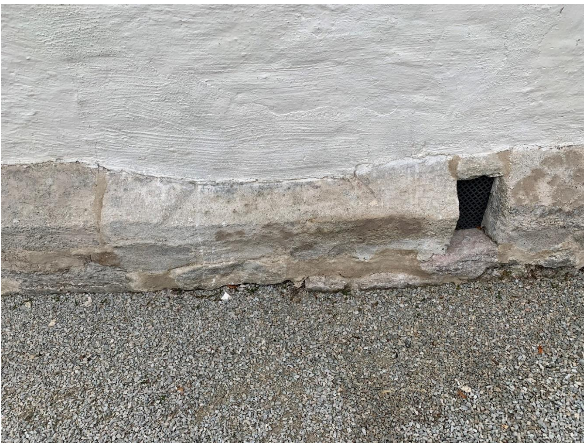
Korets sydfasad. Lagningen i sockeln visar läget för den tidigare korportalen, igensatt 1839-40. Den insatta stenen, se bilden nedan, utgörs av fönsterbänken från det tidigare korfönstret eller västfönstret. Foto JL 2020.
