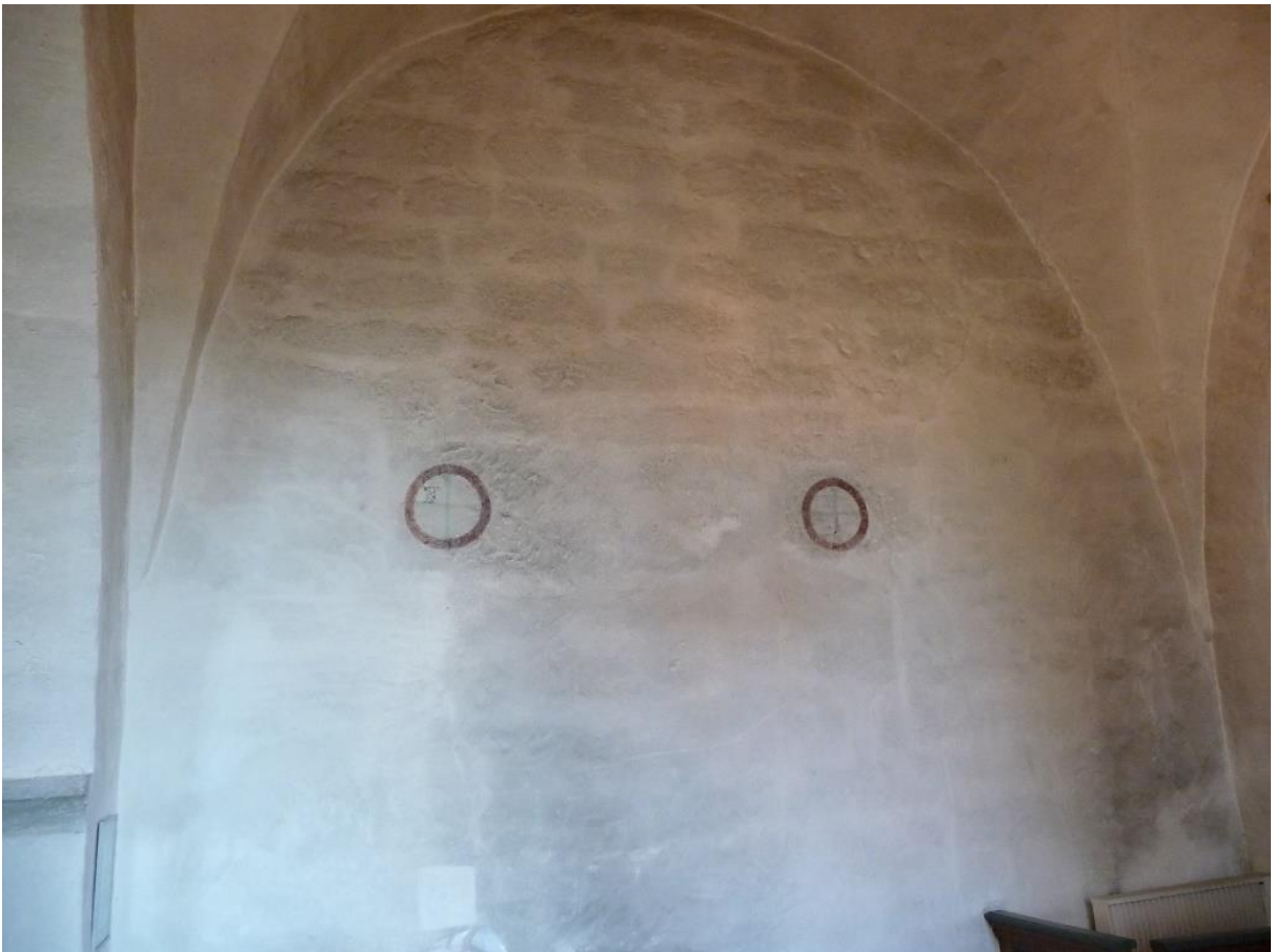
Korets norra mur, sedd från söder. Foto ES 2020. Platsen för murtrappan till predikstolen, upptagen 1839-40 och igensatt 1964, synlig som ljusare fält till höger i bild.
