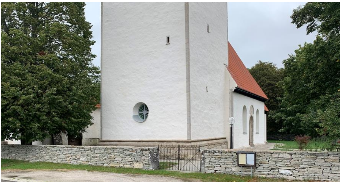
Detalj av kyrkans exteriör från sydväst. Foto JL 2020.
