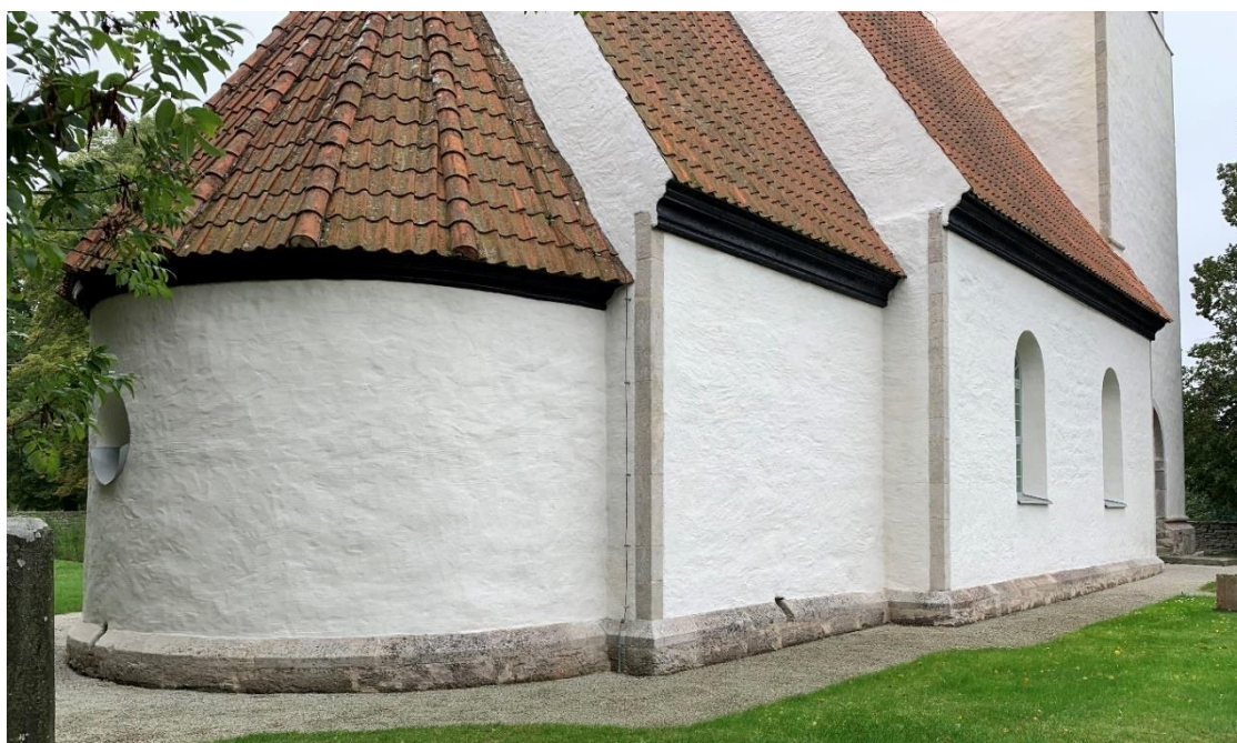
Kyrkans norra fasad, sedd från nordöst. Långhusets norra fönster togs upp 1844, första några år efter fönstren i söder. Foto JL 2020.
