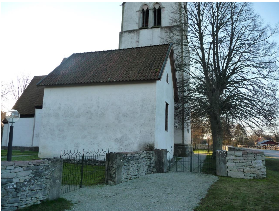
Sockenmagasinet, byggt ca 1820. Foto ES 2019.
