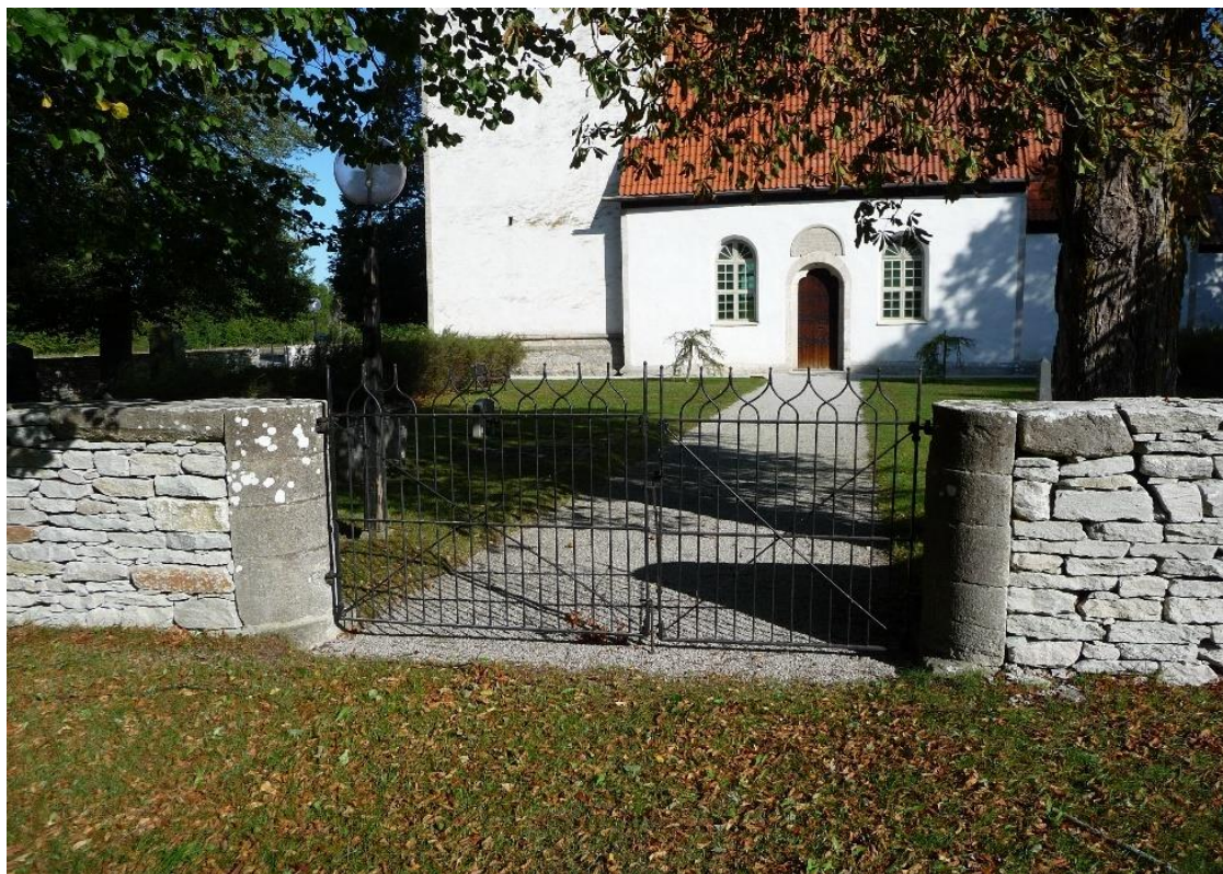
Den södra ingången fotograferad från norr. En grind i svartmålat smidesjärn omges av halvcirkelformade stolpar vilka är en del av långhusets mittkolonn som togs bort 1838. På muren närmast grindstolparna ligger delar av altarskivor. Foto ES 2019.
