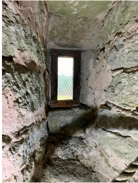
Till vänster: Murtrappan i tornets södra mur, sedd uppifrån mot öster. Till höger: Ljusglugg i tornets västra mur till murtrappan. Foto JL 2020.
