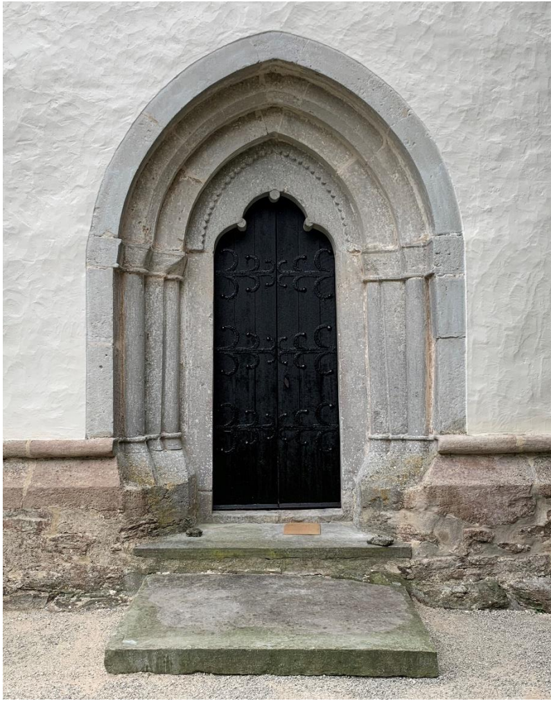
Tornets nordportal. Foto JL 2020.
