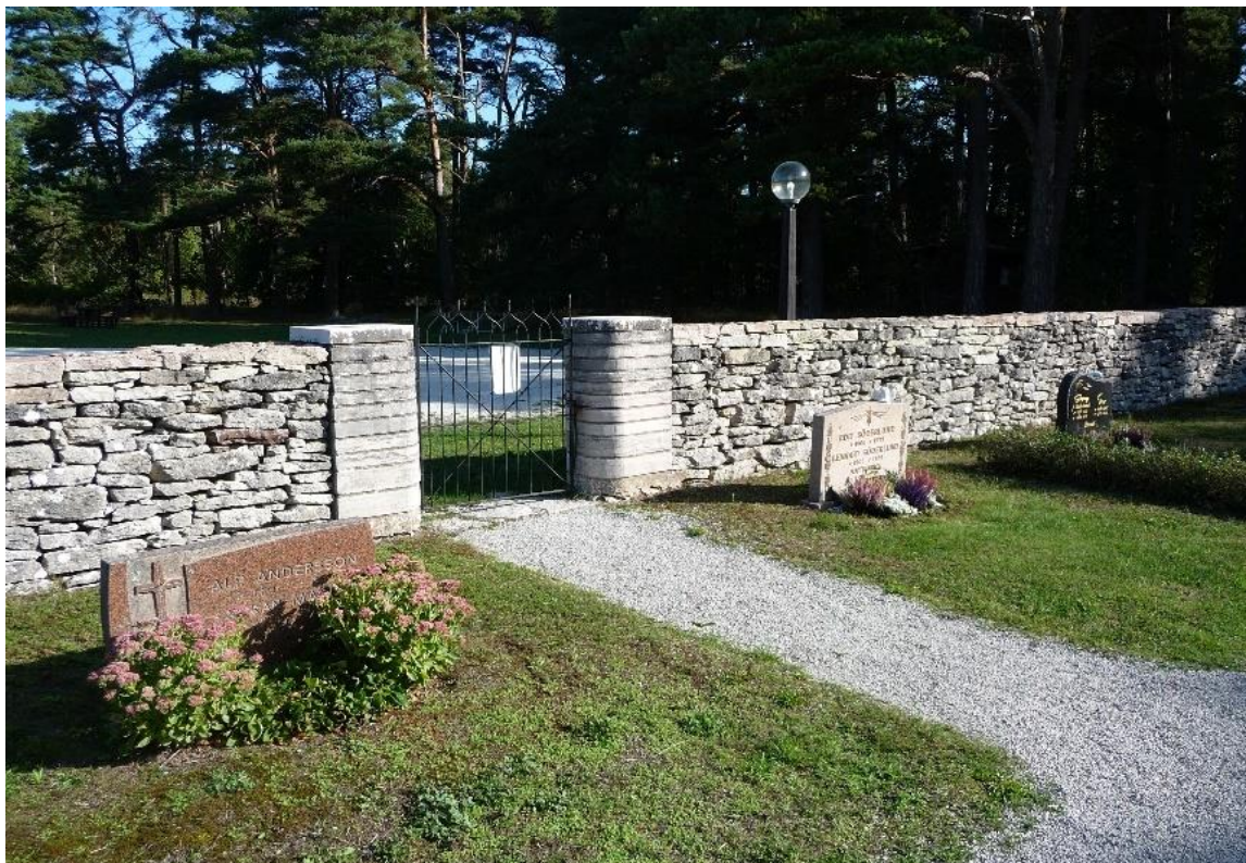
Den norra ingången till den yngre kyrkogården. En grind i svartmålat smidesjärn flankeras av fyrkantiga stolpar av murad kalksten. Foto ES 2019.
