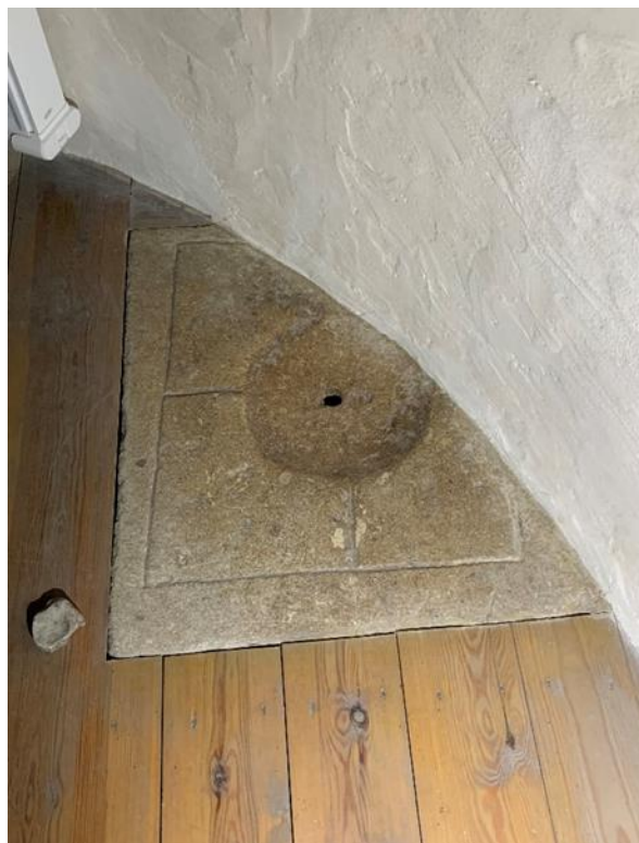
Till vänster: Väggsåpet öppet. Foto Bo Göran Kristoffersson, Visby stift, 2002-05. Till höger: Sten i absiden golv med urskälning, rännor och uttömningshål. Foto JL 2020.
