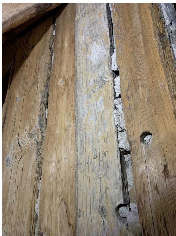
Till vänster: Panel i öppningen mellan korets och absidens vindar, södra sidan. Troligen från korets byggnadstid. Till höger: Absidens vind sedd mot söder med igensatt träskonad öppning. Foto JL 2020.
