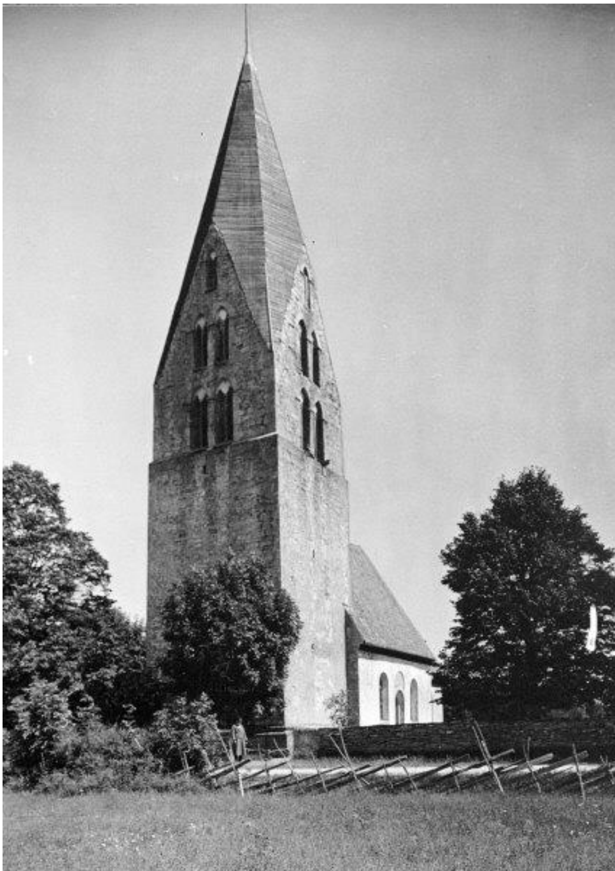
Exteriör från sydväst före den yttre restaureringen 1950. Foto Gustav Sundén 1926. RAÄ, Kulturmiljöbild.
