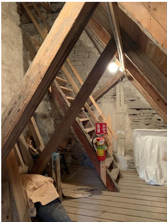
Sakristians vind mot väster med trappa till kyrkvinden. Foto JL 2019.
