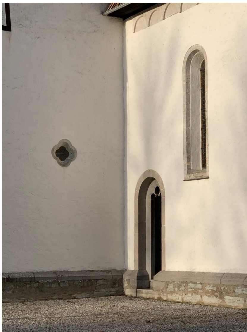
Hörnet mellan korets södra och långhusets östra fasad, från sydöst. Foto JL 2019.
