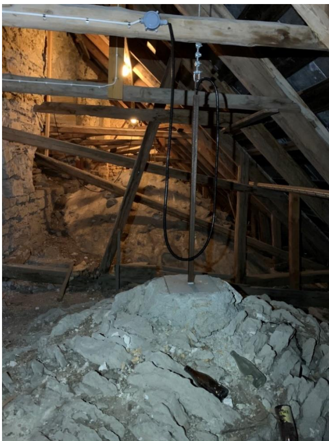
Vinden över södra sidoskeppet sedd mot öster. Foto JL 2019.
