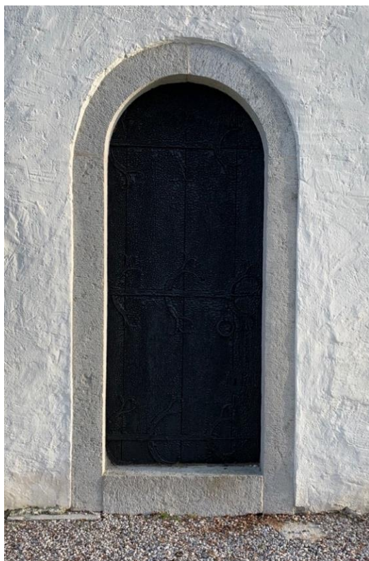
Mittskeppets västportal, sannolikt överflyttad från gamla kyrkan. Omfattningen nyhuggen 1902. Foto JL 2019.
