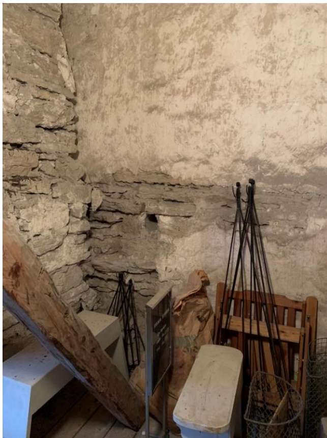
Sakristians vind mot sydöst. Muren i fonden hör till koret och dess nedre del mot sakristian torde utgöra det äldre korets nordmur. Foto JL 2019.
