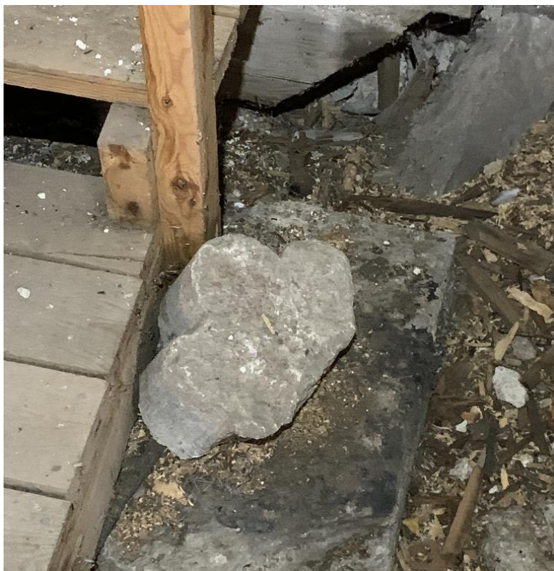
Arkitekturdetalj från 1300-talet, sannolikt avsedd för knekt eller valvribba i det planerade tornet. I kyrkan förekommer fastmurade och lösa detaljer både från den rivna kyrkan och från det utförda tornet. Foto JL 2019.
