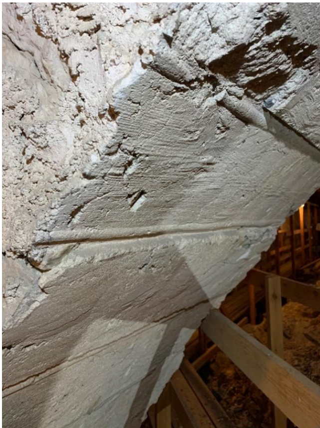
Båge i triumfbågsmuren mellan kor och långhus. Här och i de samtida och likadant utförda bågarna mellan långhusets sidoskepp är avtrycken tydliga från de bräder som använts i ställningen för bågen när den slogs. Flera av dem har skårar av det slag som är vanliga på faltak. Sannolikt är bräderna hämtade från taket på den gamla kyrkan som revs. Foto JL 2019.
