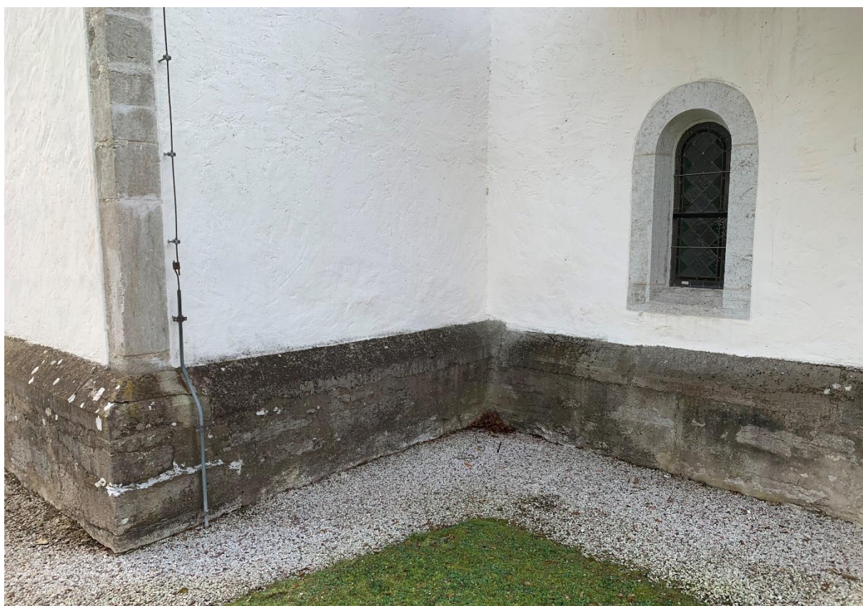
Hörnet mellan korets norra mur och sakristians östra mur. Fönstrets omfattning från 1902. Foto JL 2019.
