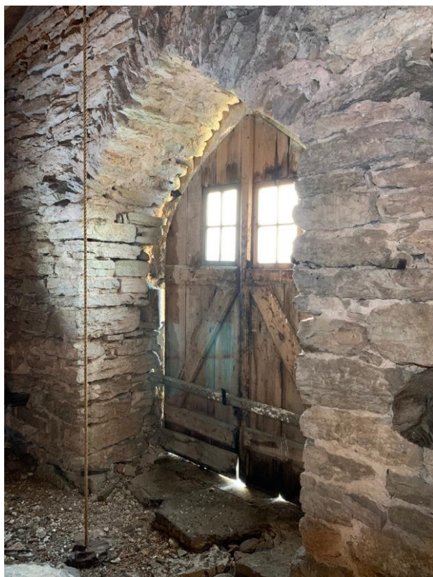
Lastport i västgaveln, avsedd som passage mellan långhuset och det planerade västtornet. Foto JL 2019
