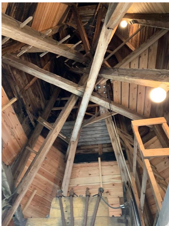
Takryttarens konstruktion från klockrummet och uppåt. Foto JL 2019.
