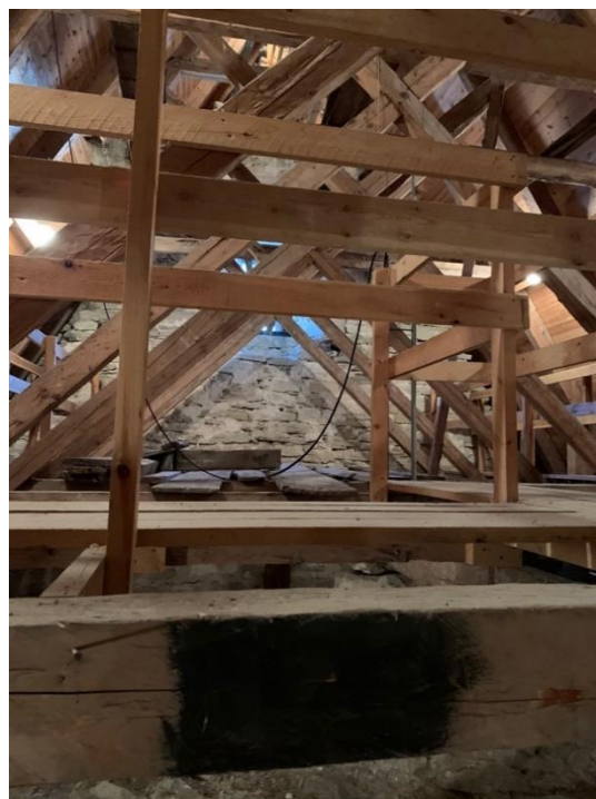
Vinden över koret mot öster. Foto JL 2019.
