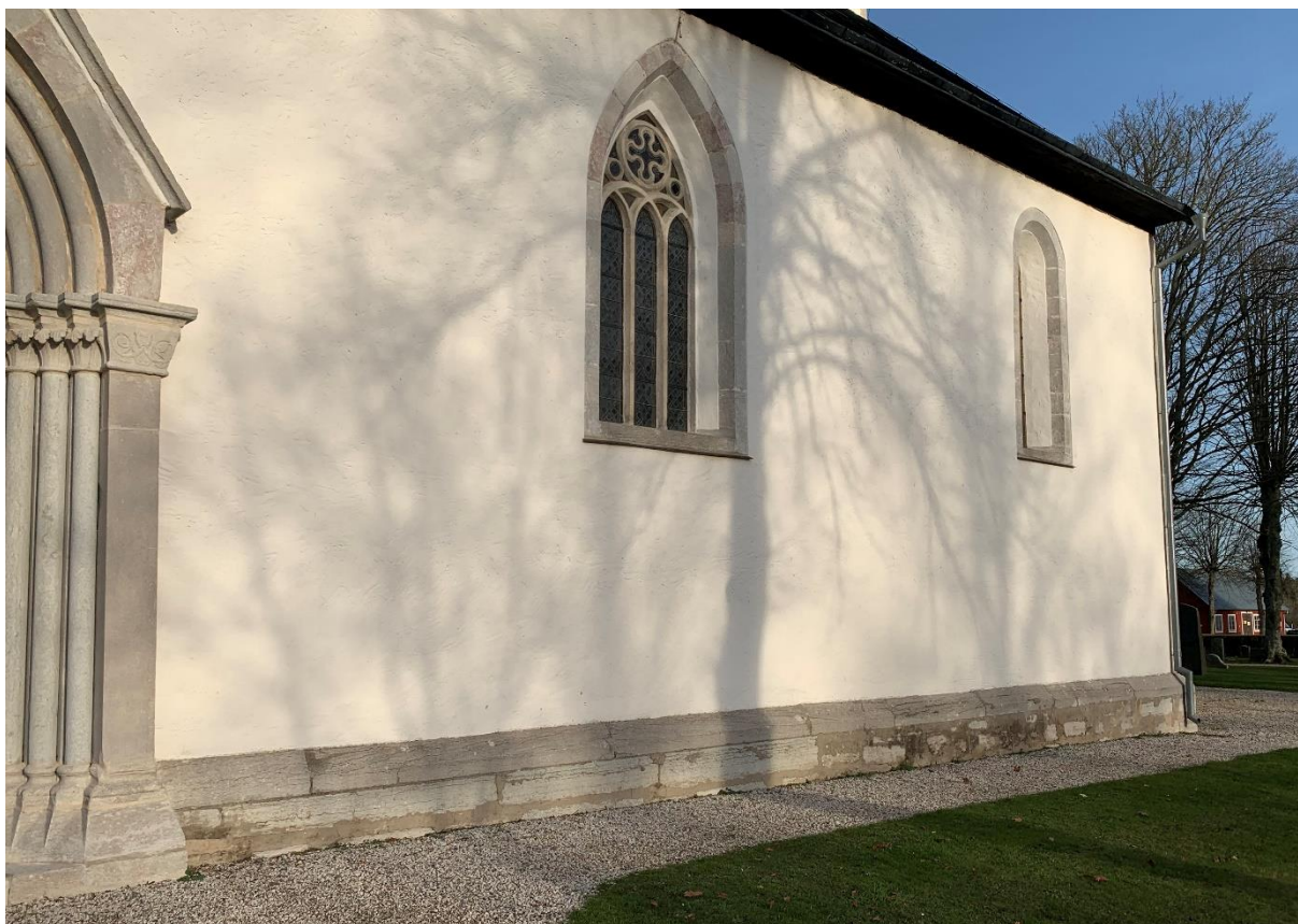
Östra delen av långhusets sydfasad. Fönstrens olika karaktär samt sockelns olika utförande, där partiet till vänster består av större block, visar på skillnaderna mellan de två byggnadsetapperna. Foto JL 2019.
