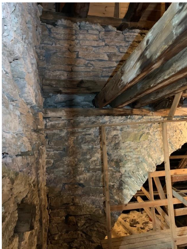
Mittskeppets vind innanför västgaveln. Ett bjälklag under takryttaren kan ha med en tidigare takryttares konstruktion att göra. Foto JL 2019.
