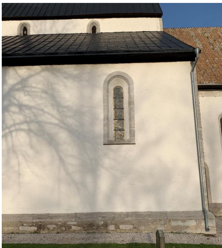
Östra delen av långhusets södra fasad med det östra långhusfönstret. Foto JL 2019.
