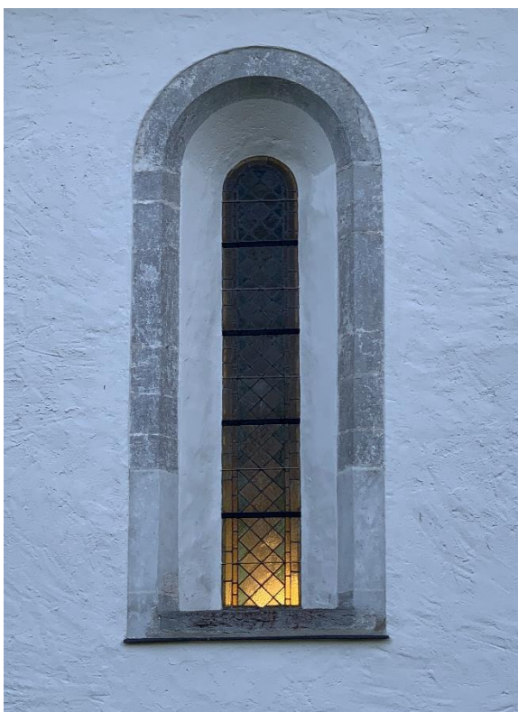
Norra långhusfasadens östra och västra fönster. Det i öster, till vänster, är något äldre, har rundbågigt krön och är synbarligen förstorat nedåt. Det västra, till höger, är spetsbågigt och har, likt övriga fönster i långhusets västra, något yngre del, växelurning i bågen mellan röd och grå kalksten. Foto JL 2019.
