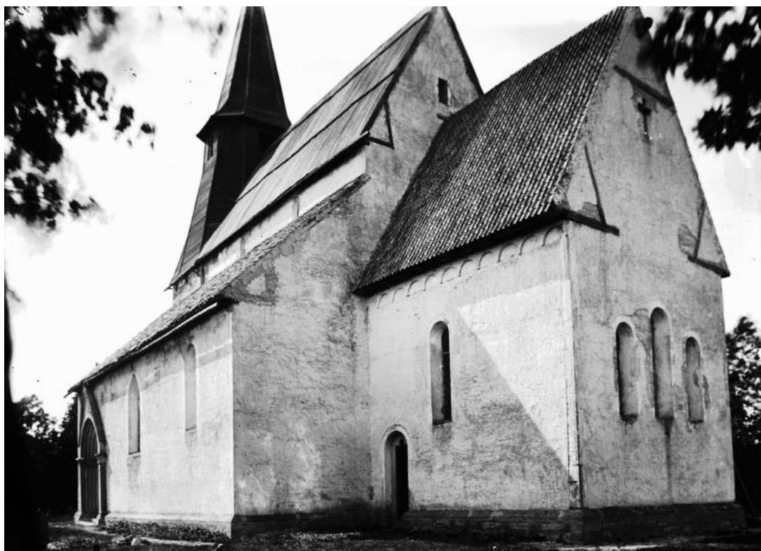
Exteriör från sydost. Långhusets takfall täcks av olika material: mittskeppet av falar, sideskeppen av tegel som koret. Foto Olof Sörling, 1891. RAÄ, Kulturmiljöbild.
