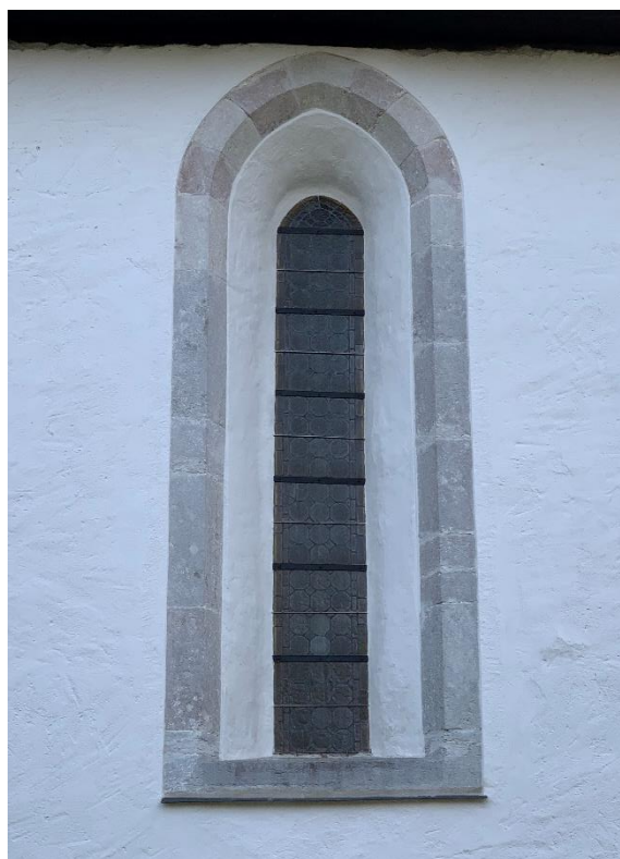
Norra långhusfasadens östra och västra fönster. Det i öster, till vänster, är något äldre, har rundbågigt krön och är synbarligen förstorat nedåt. Det västra, till höger, är spetsbågigt och har, likt övriga fönster i långhusets västra, något yngre del, växelurning i bågen mellan röd och grå kalksten. Foto JL 2019.
