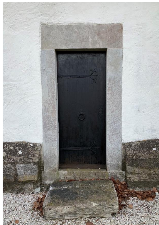
Ingång till tidigare värmekammare i sakristians västra del, tillkommen 1903 efter ritningar av Nils Pettersson. Foto JL 2019.
