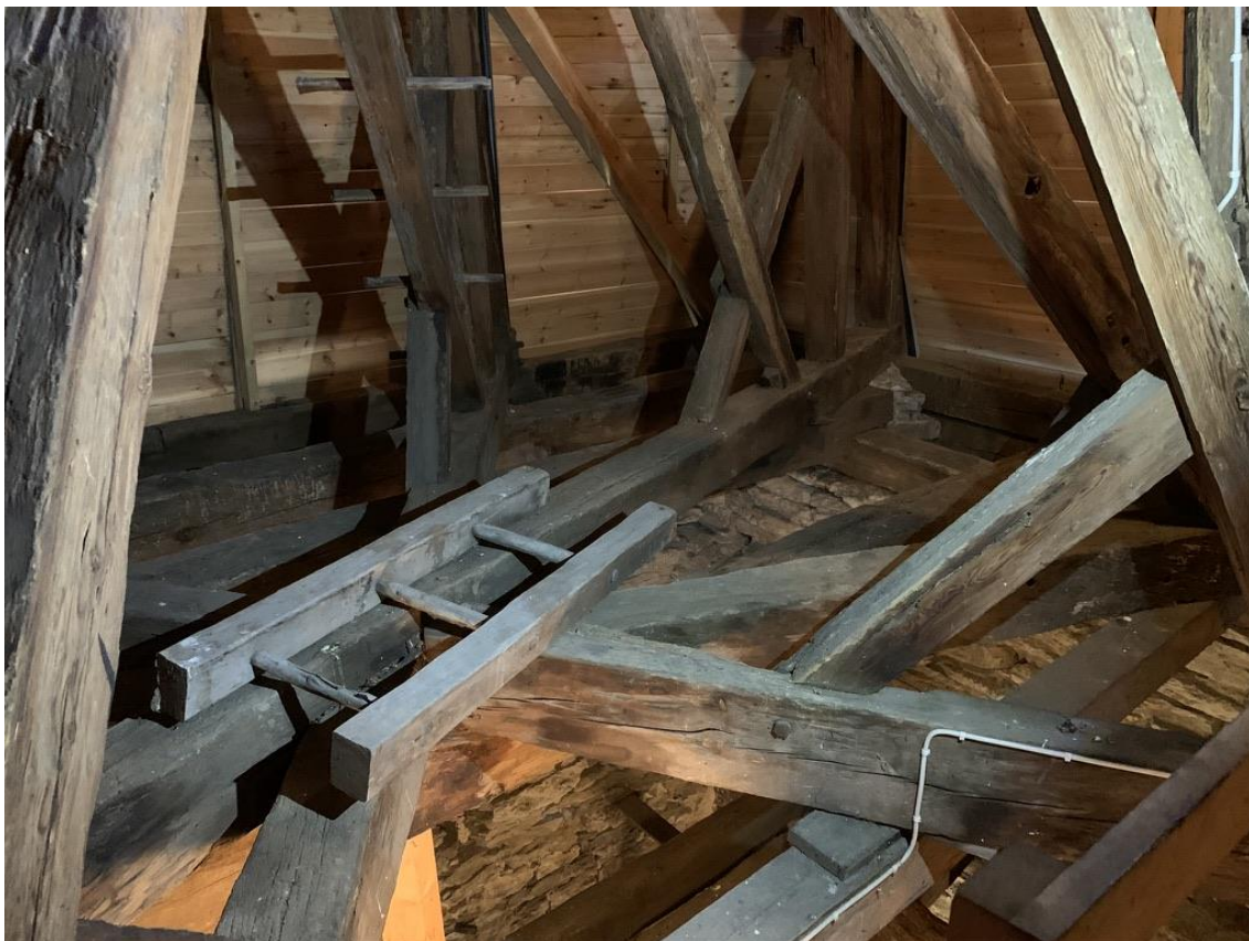
Det stjärnformade bottenbjälklaget under takryttaren. Foto JL 2019.
