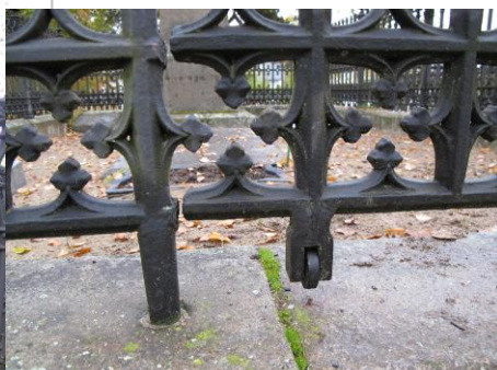
Påkostat staket, troligtvis från 1890-tal. På grinden finns ett hjul som grinden kan rulla på för att inte stöta i marken.
