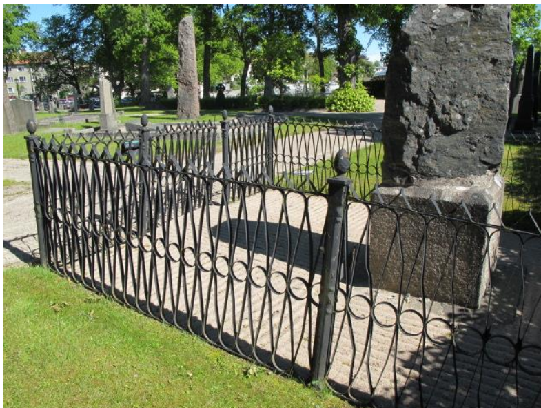
Staket av bandjärn med pollare och detaljer av gjutjärn på Södra kyrkogården i Nora. Bilderna till höger visar detaljer av gjutjärn. I en priskurant från Haddebo Jernverk, tryckår 1895 finns ca 20 varianter på staket av bandjärn, en snarlik den ovan.
