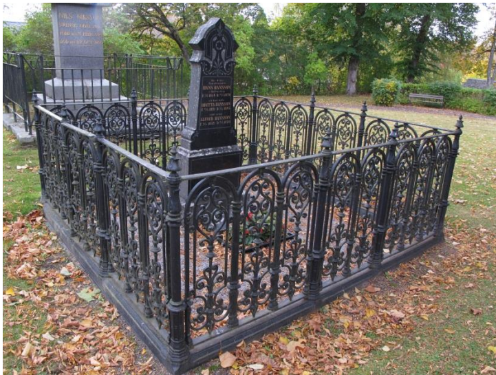
Påkostat gjutjärnsstaket på gjuten sockel och grind med lås, troligtvis uppförd på 1870-talet.
