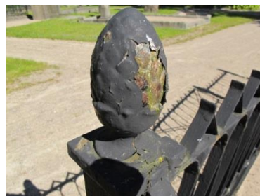
Staket av bandjärn med pollare och detaljer av gjutjärn på Södra kyrkogården i Nora. Bilderna till höger visar detaljer av gjutjärn. I en priskurant från Haddebo Jernverk, tryckår 1895 finns ca 20 varianter på staket av bandjärn, en snarlik den ovan.
