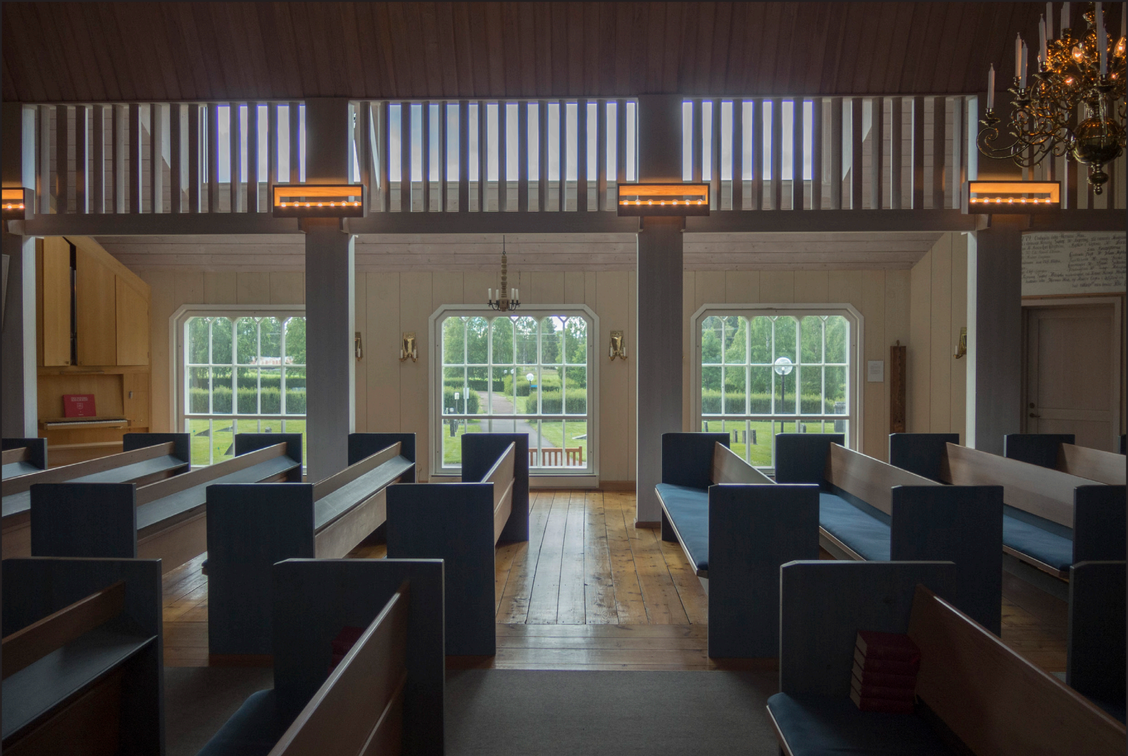
I den del som blev kvar efter rivningen av södra korsarmen sattes det in återbrukade fönster. Perspektivfönstren i takkupan var dock moderna, och har även ersatts i en senare renovering. Lameller framför fönstren dämpar det skarpa ljuset.
