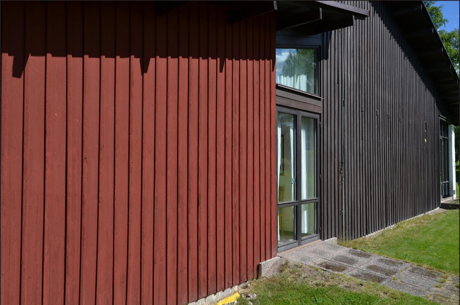
Västfasaden har en fönsterdörr som leder in till den lilla församlingssalen.
