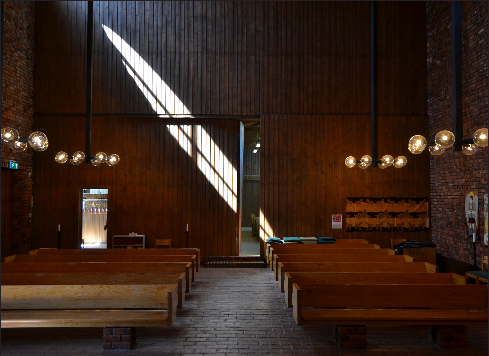
Väggens högra del kan skjutas till vänster för att öppna upp kyrkorummet mot församlingssalen.
