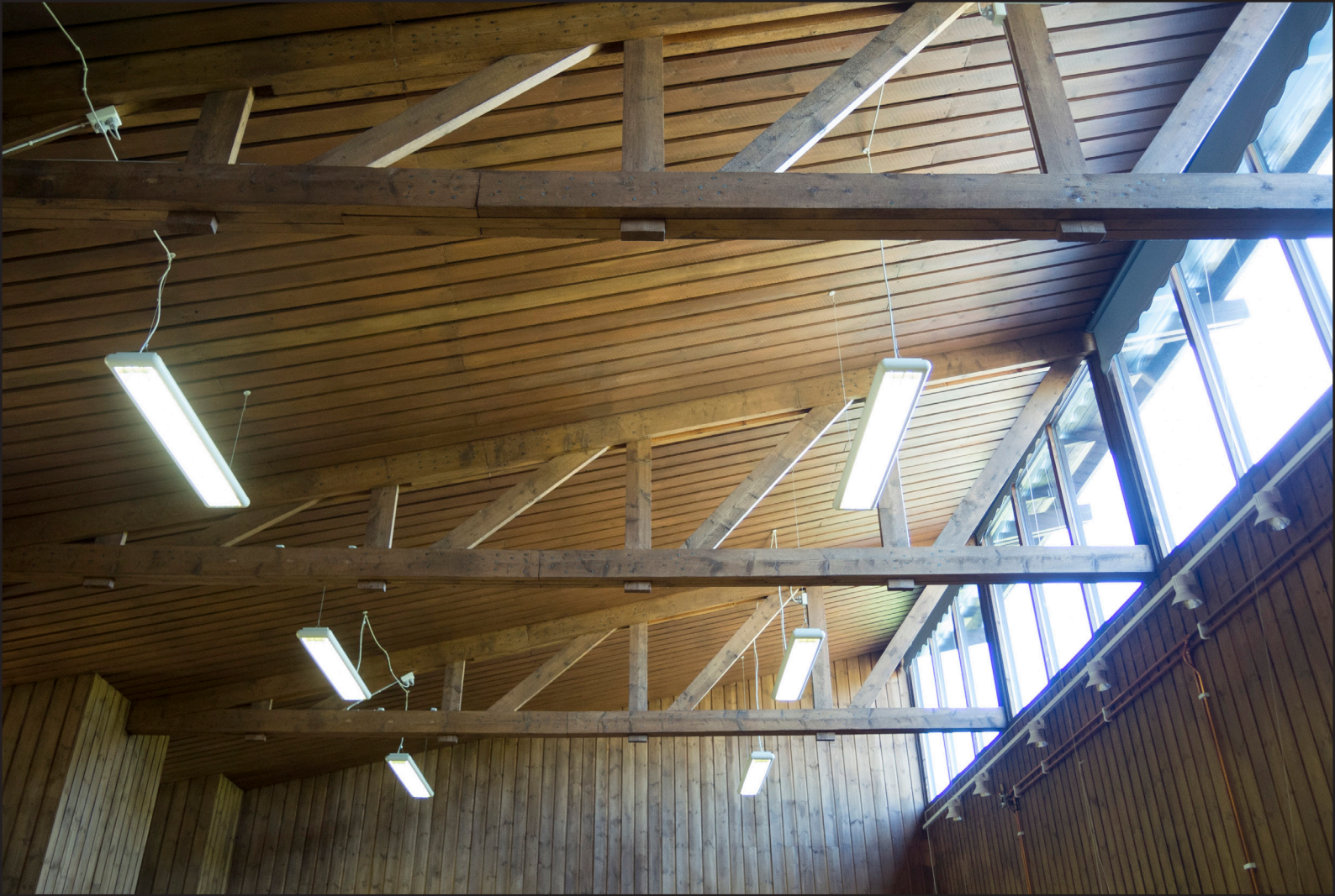
Karaktären i församlingssalen präglas till stor del av vägg- och takmaterialet och av ljuset från det höga fönsterbandet.
