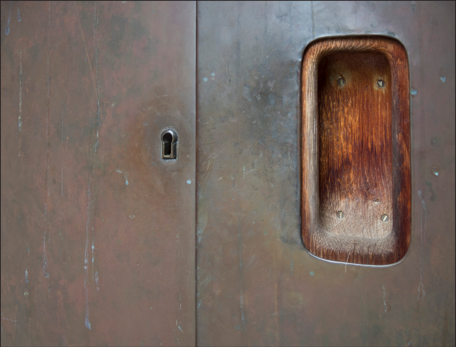
Porten består av enkla, släta, sammanfalsade kopparskivor vars regelbundenhet endast bryts av nyckelhålet och det försänkta handtaget i trä.
