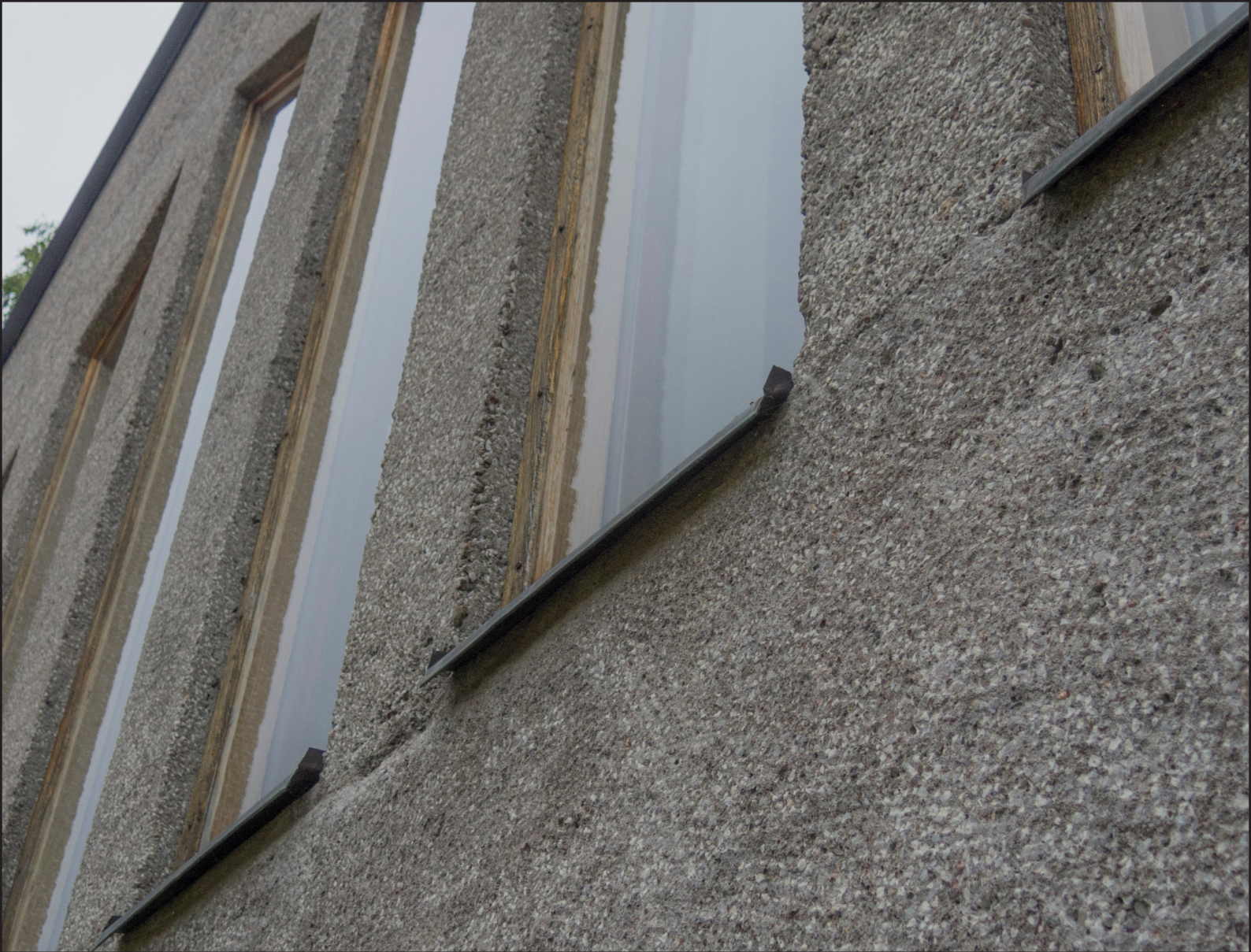
Långsidornas fasadytor består av krysshamrad betong med iblandad marmorkross.
