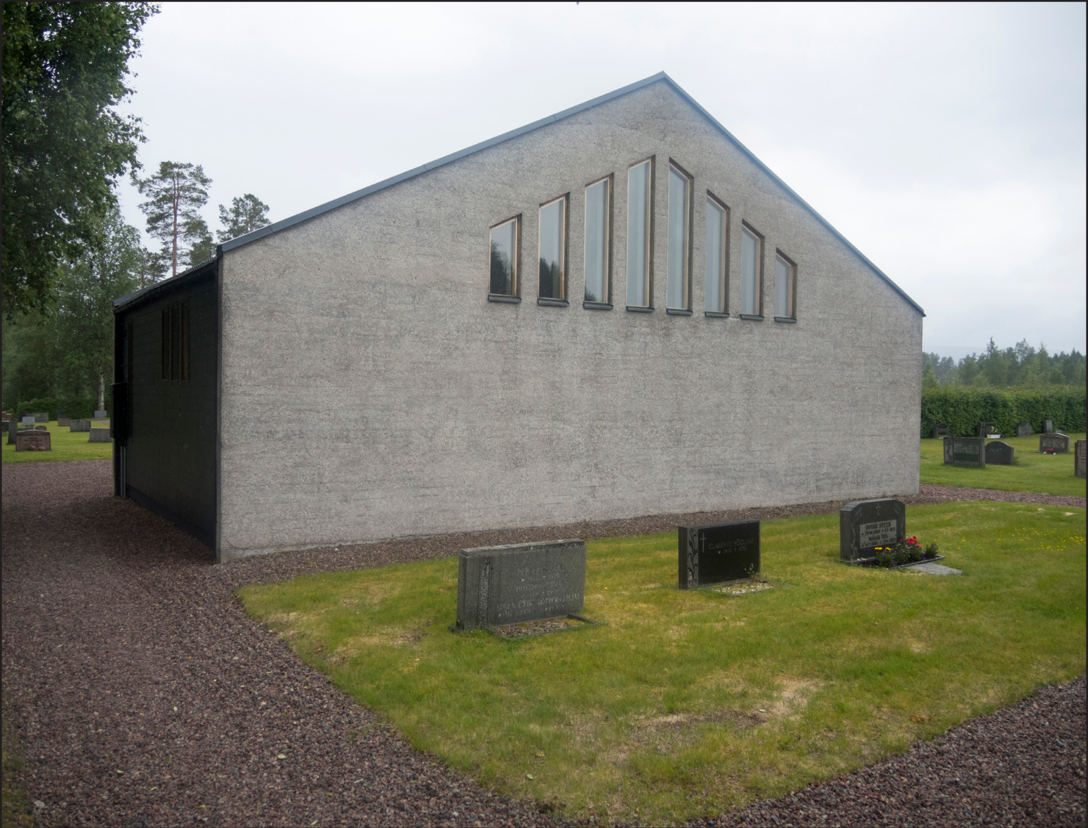
Sörsjöns kapells norrsida karaktäriseras av de uppåtsträvande fönstren och den krysshamrade betongytan.
