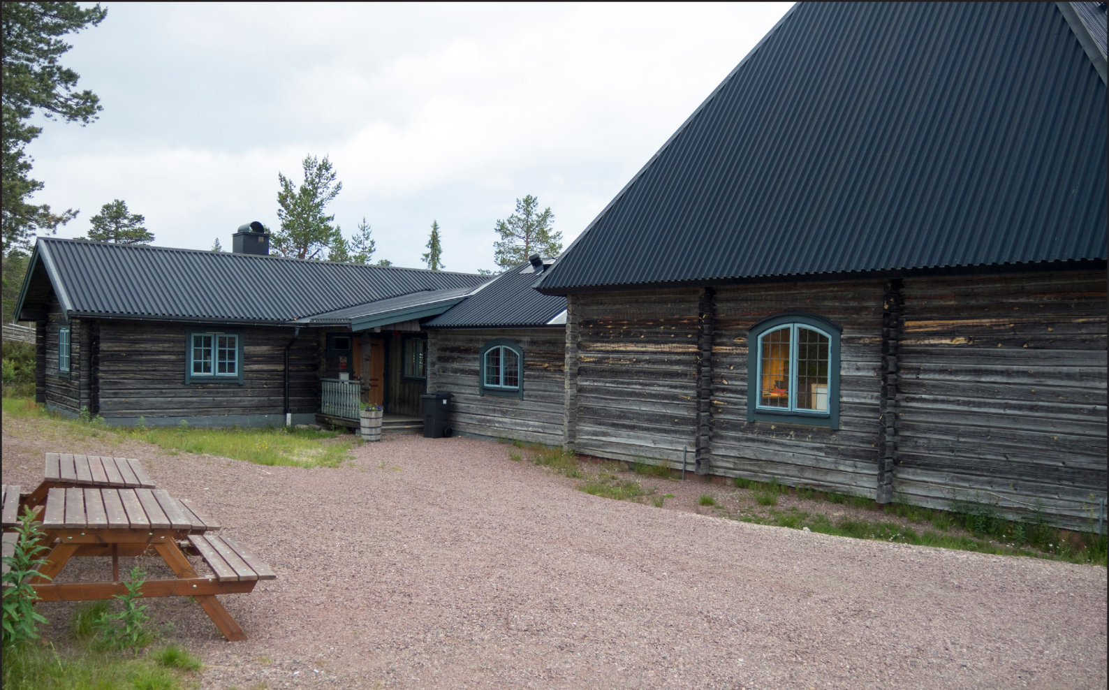
De två tillbyggnaderna syns på baksidan. Sakristian från 1979 har välvt fönster likt den ursprungliga byggnaden.
