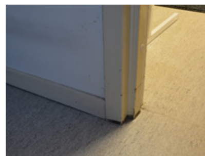
Detalj av linoleumgolvet i grå stenimitation samt list. Vlm_kmvSB-3251.
