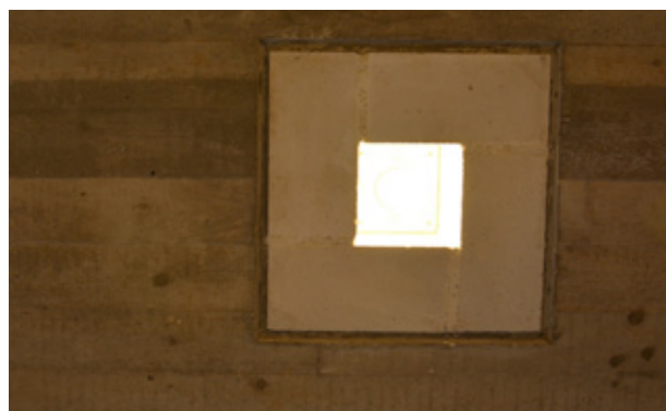
Betongtak med synligt mönster efter träform och armaturanordning. Vlm-modkaEK-3818.
