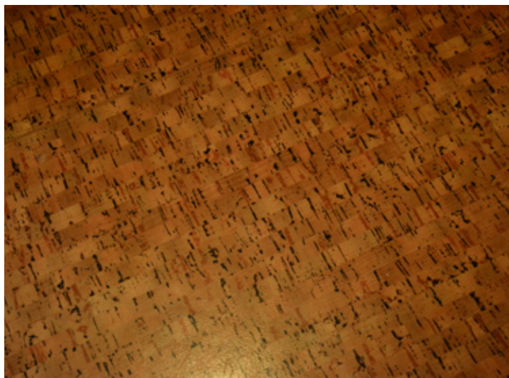
Detalj av linoleumgolvt i korkimitation i skrudkammare. Vlm-kmvEK-3859.
