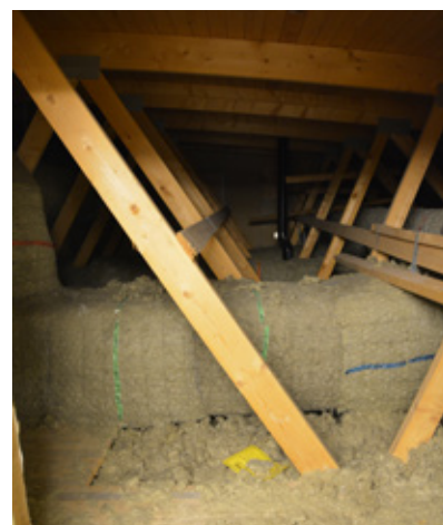
Vindsutrymme i tillbyggnadens. Vlm-modkaVB-1231.
