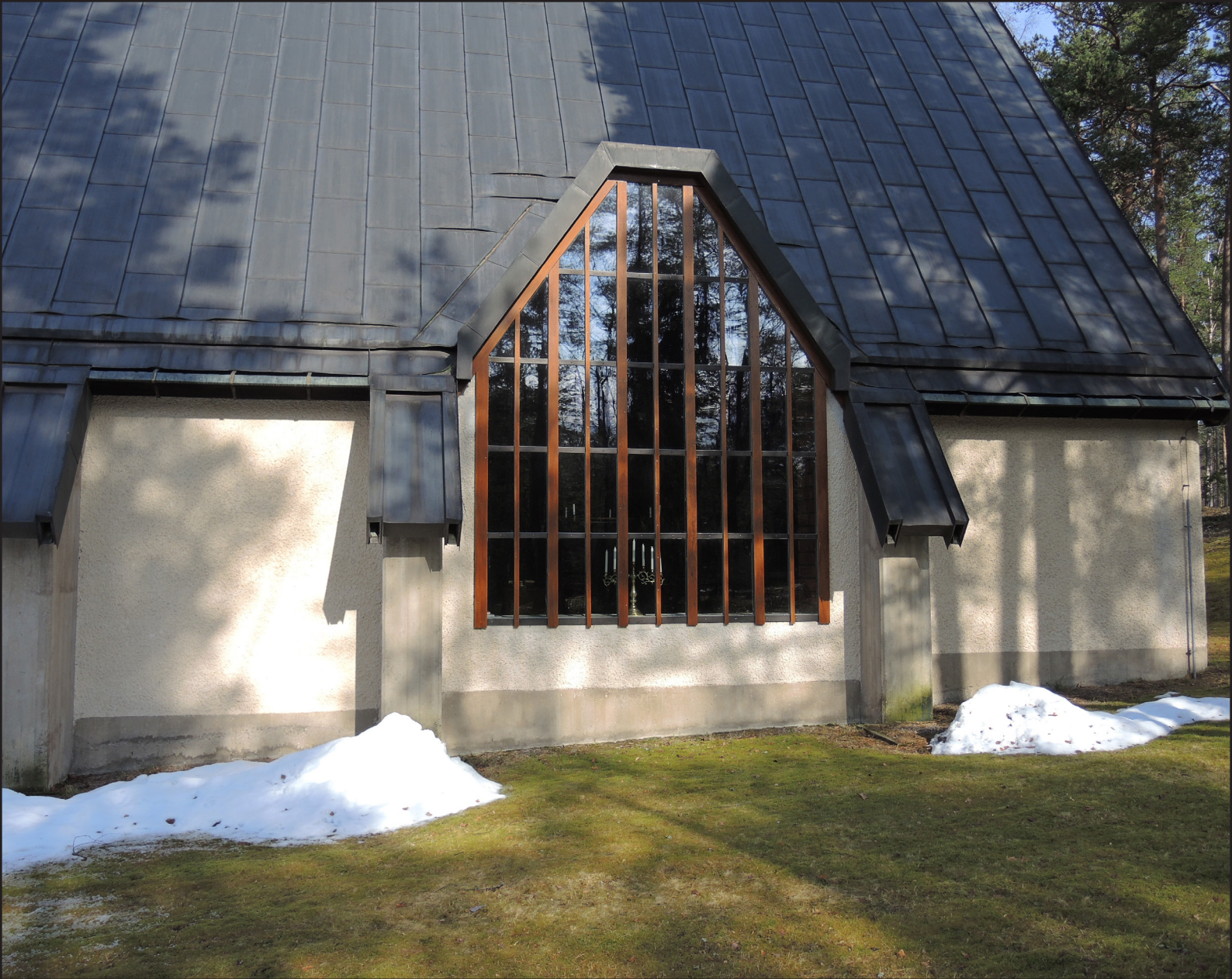
Kyrkorummets rymd möjliggörs av betongsträvpelarna. Exteriört fungerar dessa även som fundament åt vattenkastare. Foto: Lars Jönses, Dalarnas museum.
