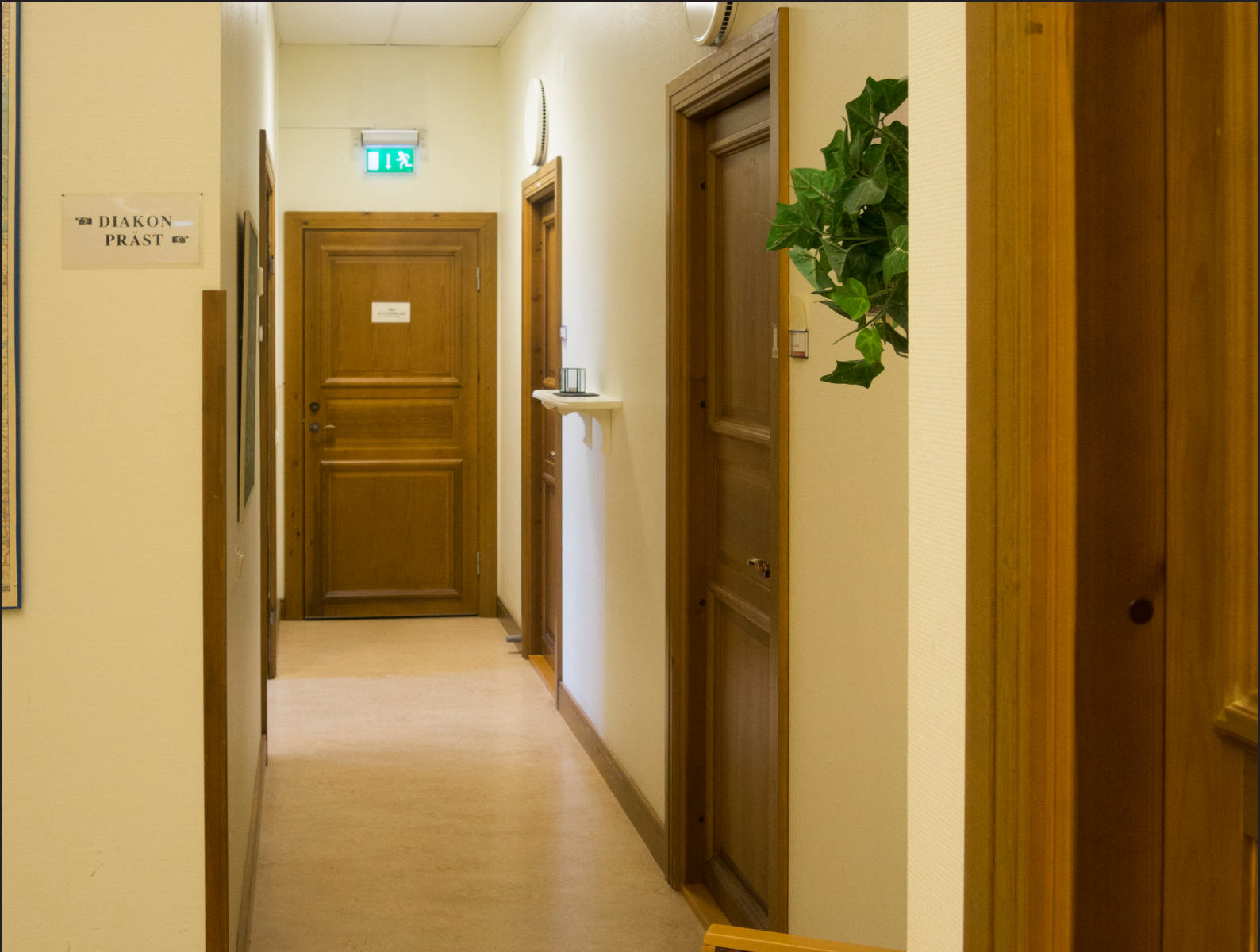
Kontorskorrideren på övervåningen tillkom i sin nuvarande form 1994. Gamla dörrar återanvändes och nya tillverkades med de gamla som förlaga.
