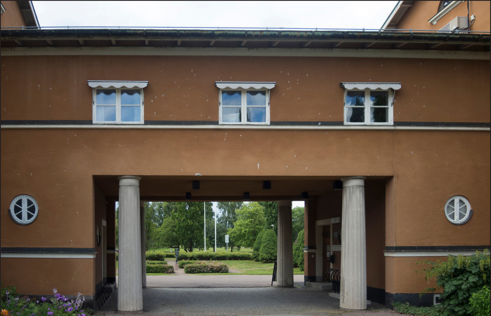
Förbindelsegången som sammanbinder Hagakyrkan och stadshuset. Entréer till respektive byggnad finns på vardera sida i passagen till innergården.
