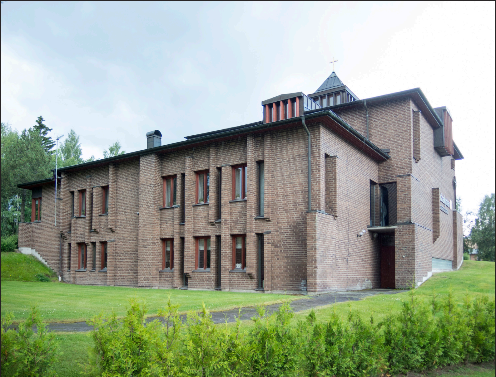
Församlingslokalerna är särskilt betongade i fasaden och skiljer sig från det uppstickande kyrkorummet.
