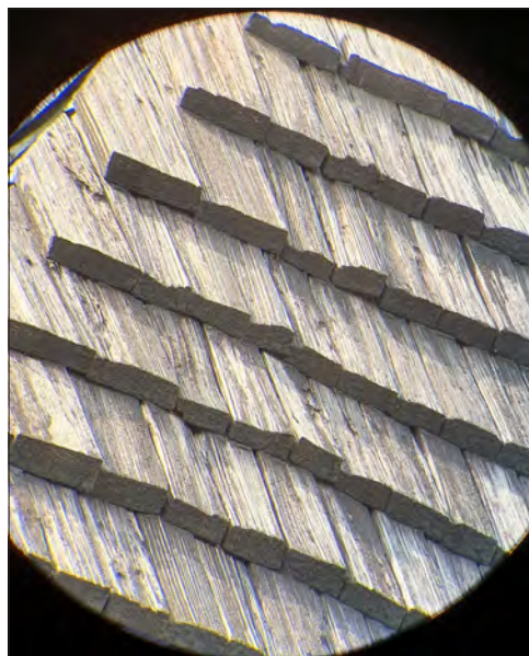
Säby klockstapel. Kikarbild på de sågade ekspånen.
