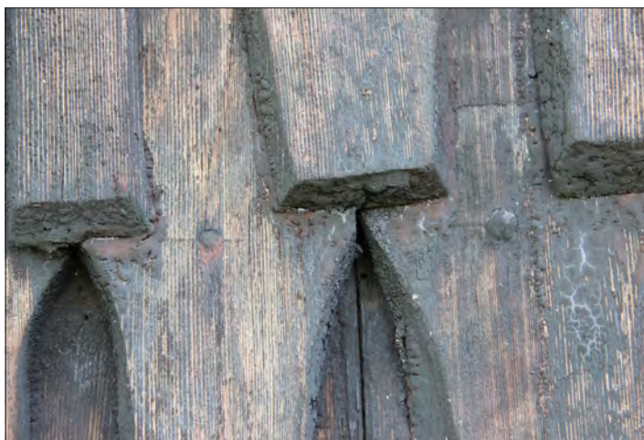
Sura gamla kyrka. Sågade fasadspån från 2003, virket är kvistrikt och har en hel del splintved.
