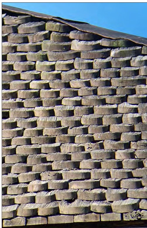
Sala sockenkyrka. På korsarmens övre takfall mot öster ligger kluvna spån uppskattningvis lagda sent under 1900-tal eller tidigt 2000-tal.
