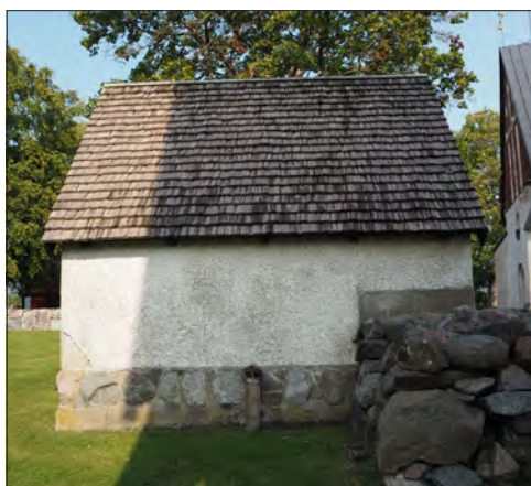
Hubbo kyrka. Bårhusets södra fasad.
