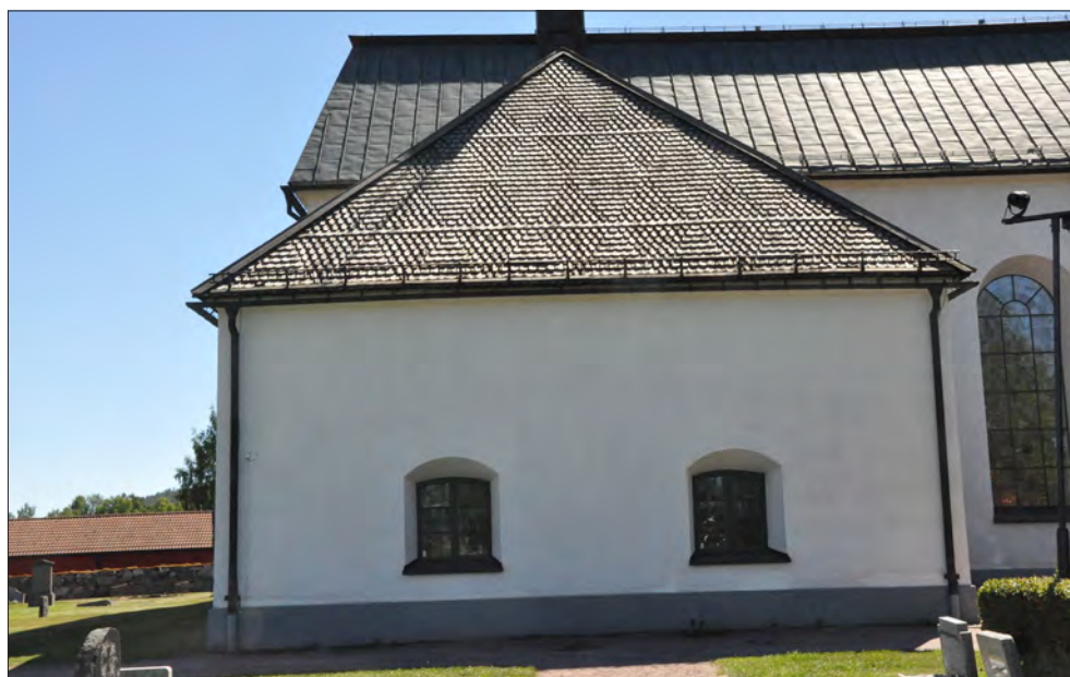
Gagnefs kyrka. Sakristian med rombmönstrad spåntäckning
