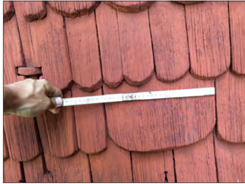
Hjulsjö kyrka. Fasaderna visar prov på stor variation i spånens mått.
