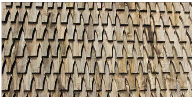
Malma kyrka. Spån på västra fasaden.
