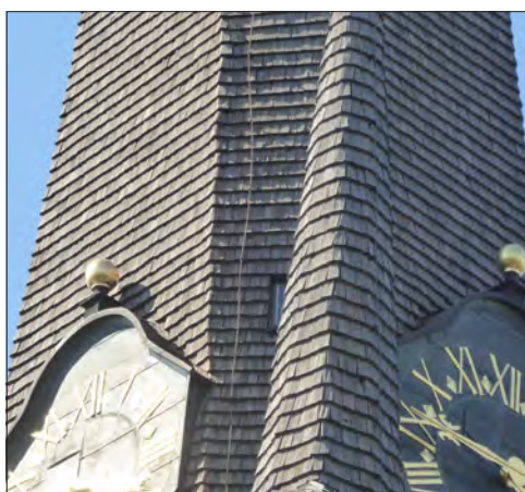
Heliga Trefaldighets kyrka, Arboga. Spåntäckning i närbild.
