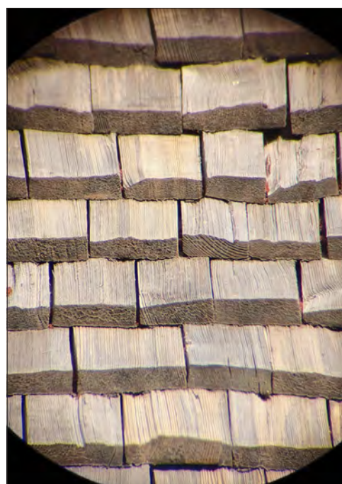
Säby kyrka. Kikarbild på långhusets kluvna spån, södra takfallet.
