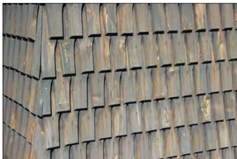
Sura gamla kyrka. Sågade fasadspån från 2003, virket är kvistrikt och har en hel del splintved.
