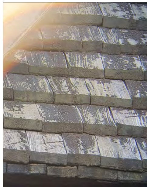
Möklinta klockstapels nedre takfall mot norr, detaljbild på huggna spån
