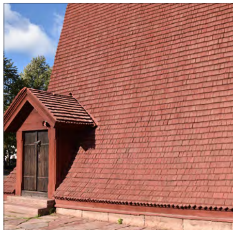
Mora klockstapel. Sydfasaden med spåntäckt entrétak.
