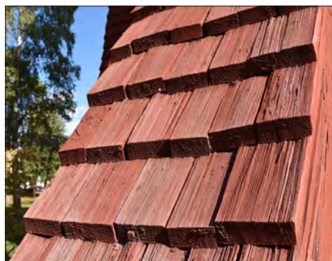
Mora klockstapel. Klockstapelns strävor har raka spån med kluven ovansida, troligen tillkomna på 1900-talet.
