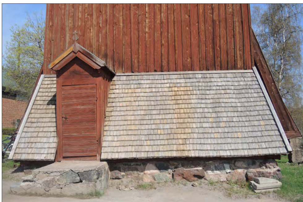
Aspeboda klockstapel. Kransen med sågade och hyvlade spån.
