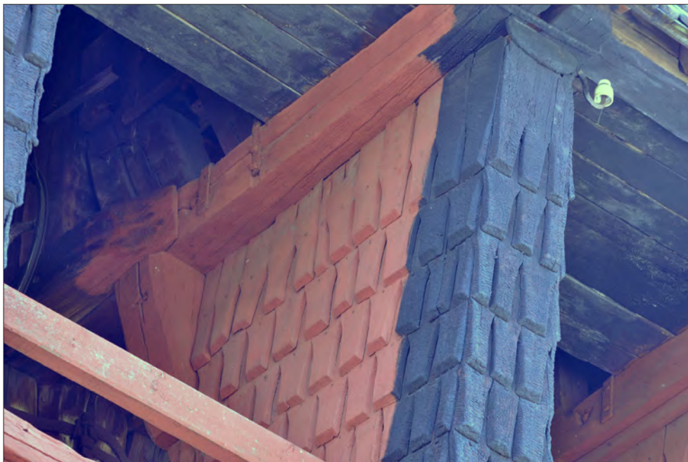
Ljusnarsbergs klockstapel. Spånklädda ljudöppningar i klockhuv.
