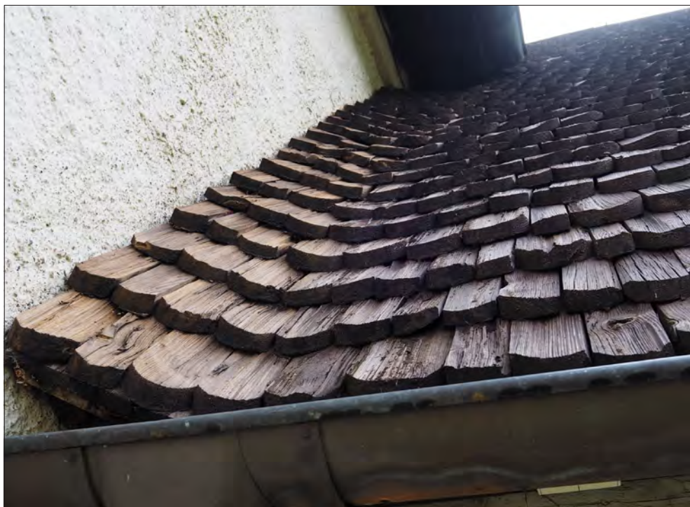
Kärrbo kyrka. Vapenhusets västra takfall.
