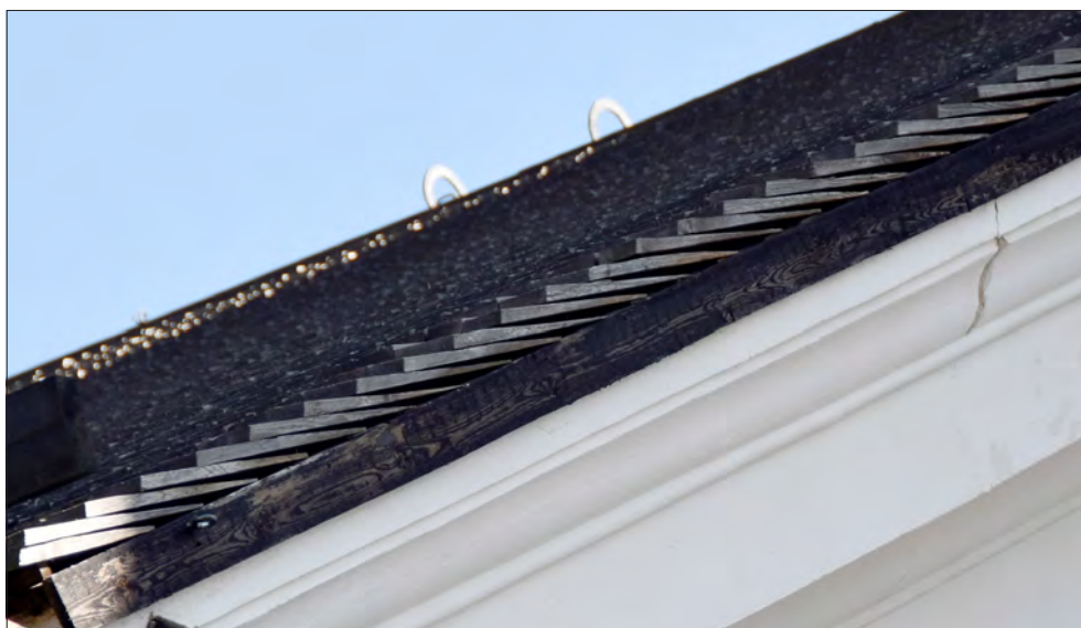
Siljansnäs kyrka. De klyvda spånen på norra längbustakfallet sedda från gaveln.
