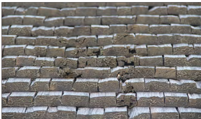
Figur 43. Rötskadade spån på bårhuset vid Bergs kyrka, Västerås stift. Spånen är klurna, tjärdoppade innan läggning och uppskattningsvis lagda under sent 1900-tal eller tidigt 2000-tal. Foto Lisa Skanser.
