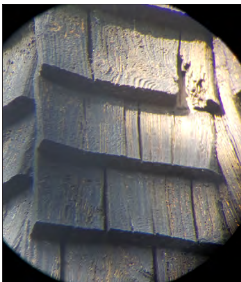
Kvarnsvedens klockstapel. De sågade spånen på tornspiran.
