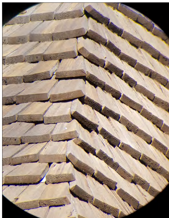
Dala-Floda kyrka. De klyvda spånen på takfallen är från omläggningen 1995. Växelvis läggning är tillämpad över takfallens skarvar.
