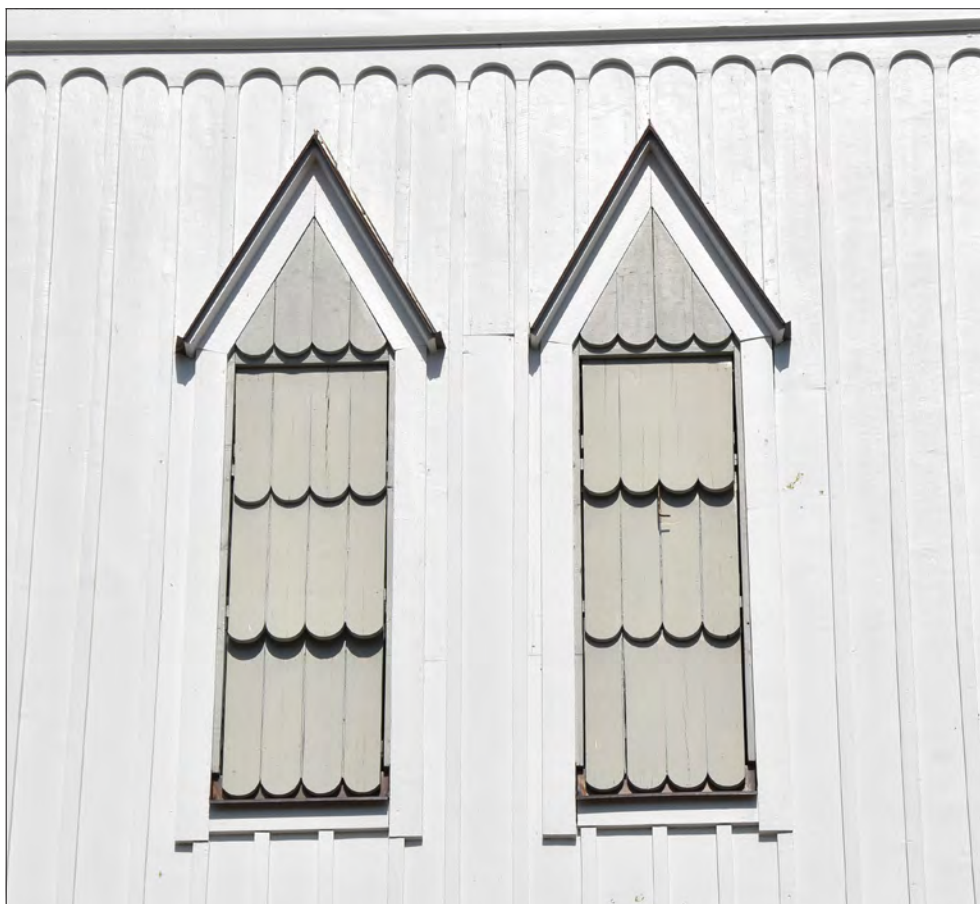
Äppelbo kyrka. Tornets ljudluckor består av rader med vinkelingsbara, rundformade spån.
