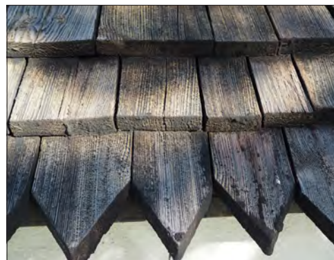
Rytterne bårhus, södra takfallet.
