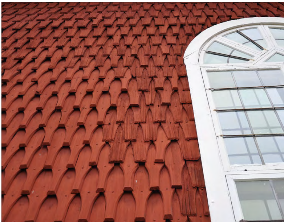
Sundborns kyrka. Nyare spån avtecknar sig som ljusa i fasaden eftersom dessa har bättre upptagningsförmåga av färgen.
