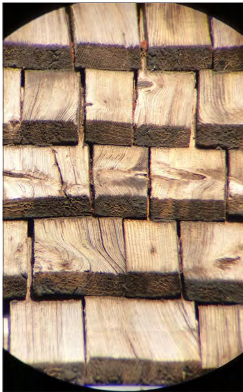
Säby klockstapel. Kikarbild på de sågade ekspånen.
