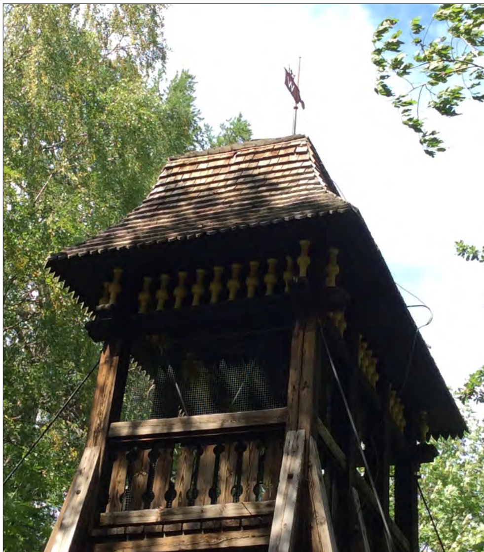
Vedeå's klockstapel. På den svängda buven ligger raka spån med fasad kant.
