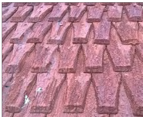
Leksands kyrka. Över 300 år gamla huggna spån från yttertakets tillkomst 1709—15 återfinns på korets nordöstra och östra takfall. Lika gamla spån skall finnas på lökspirans underdel enligt den kartering som gjordes i samband med takomläggningen 1996. Foto Lars Jönnes.
