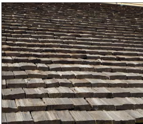
Kumla kyrka. Detalj av vapenhusets östra takfall.
