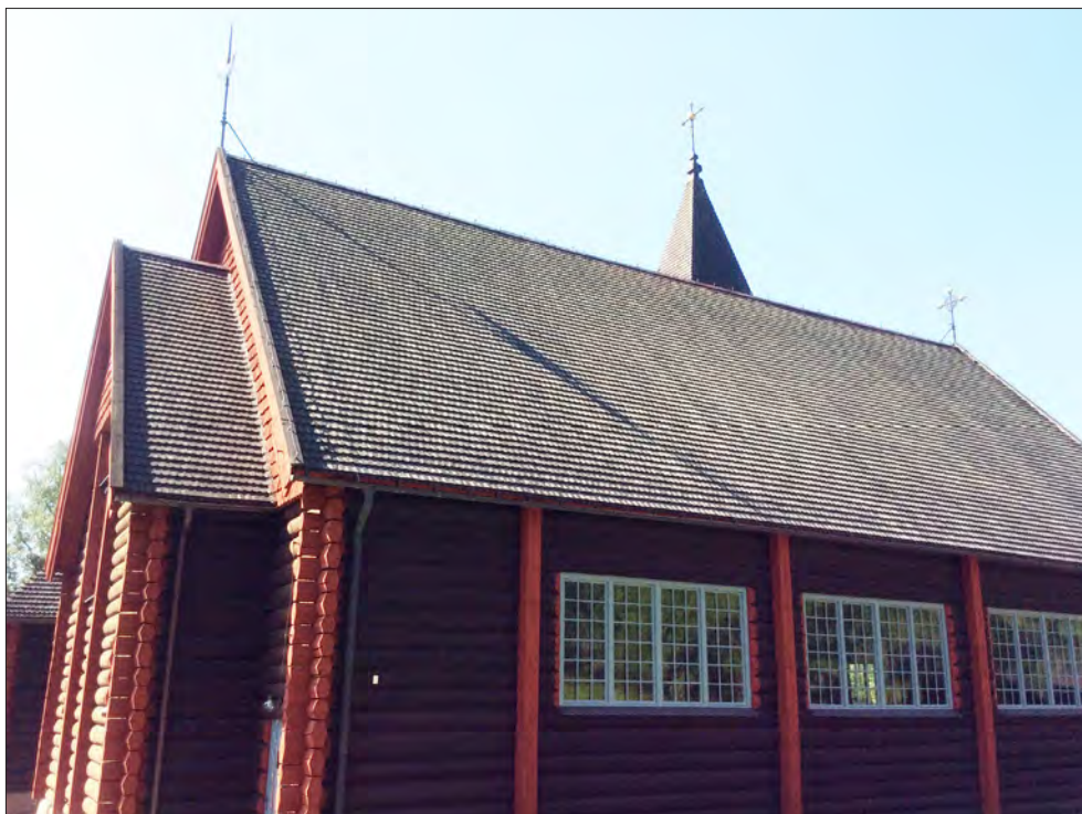
Hörkens kyrka. Kyrkans norra takfall. Spånen är rundade och nedtill finns mönsterläggning med spetsspån och raka spån.
