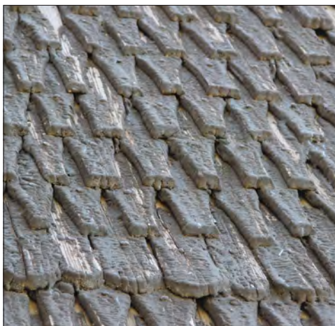
Sala sockenkyrka. På vapenhusets västra takfall ligger huggna näbb- och rundformade spån i mönstertäckning. Taktäckningen är en av de äldsta i Västerås stift och kan vara 1600–1700-tal. Taksån av så hög ålder är unikt.
