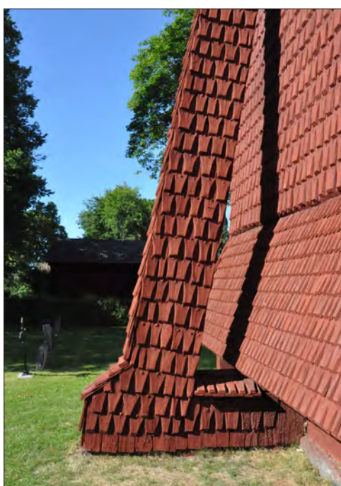
Djura klockstapel. Huggna och sågade spån förekommer över hela fasaden. På strävens sydsida syns främst huggna spån, men även senare, sågade kompletteringar, finns.
