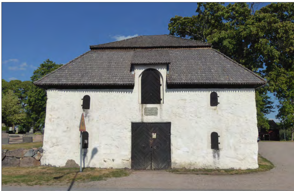
Götlunda kyrka. Sockenmagasinet sett från väster.
