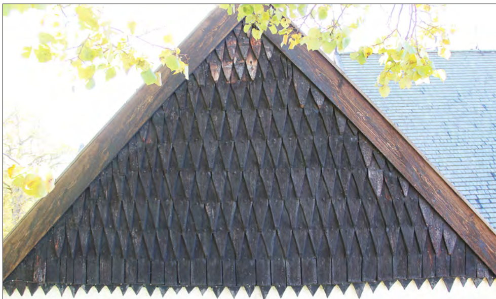
Figur 31. Tångeråsa kyrka, Strängnäs stift. Bild på sakristians gavelspets vars spån bedöms kunna vara från sakristians uppförande omkring 1450. Spånen är tillverkade med omsorg i jämn storlek vilket skapar symmetri i läggningen. Spånens spetsar är mycket noggrant gjorda med helt raka sidor utan antydning till svängar åt något håll. Att bugga alla spån till samma bredd innebär inte bara ett slöseri med material, det för även med sig en hel del merarbete. I praktiken innebär det att alla smala spånämnen som normalt hade använts sorteras bort. Likaså får de ämnen som skulle kunna ge breda spån buggas ner till en smalare form. Spåntäckningen berättar att ett viktigt mål i slutresultatet är att det rombiska mönstret ska följa rätta linjer. Foto Lisa Skanser.
