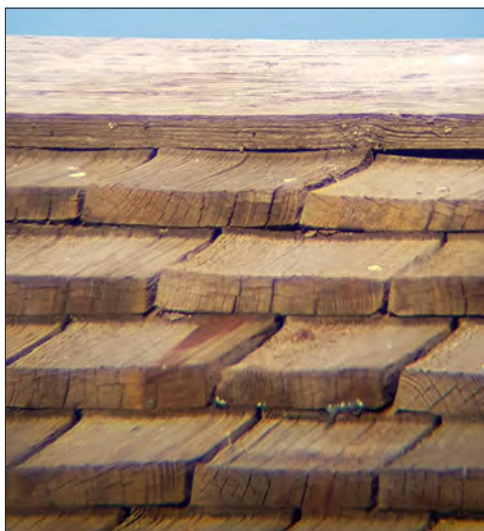
Skattunge kyrka. På kyrktaket ligger sågade spån i breda dimensioner.
