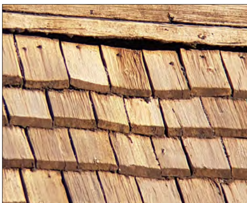
Rättviks kyrka. Sågade spån från en omläggning runt 1900-talets mitt på norra korsarmens västra takfall
