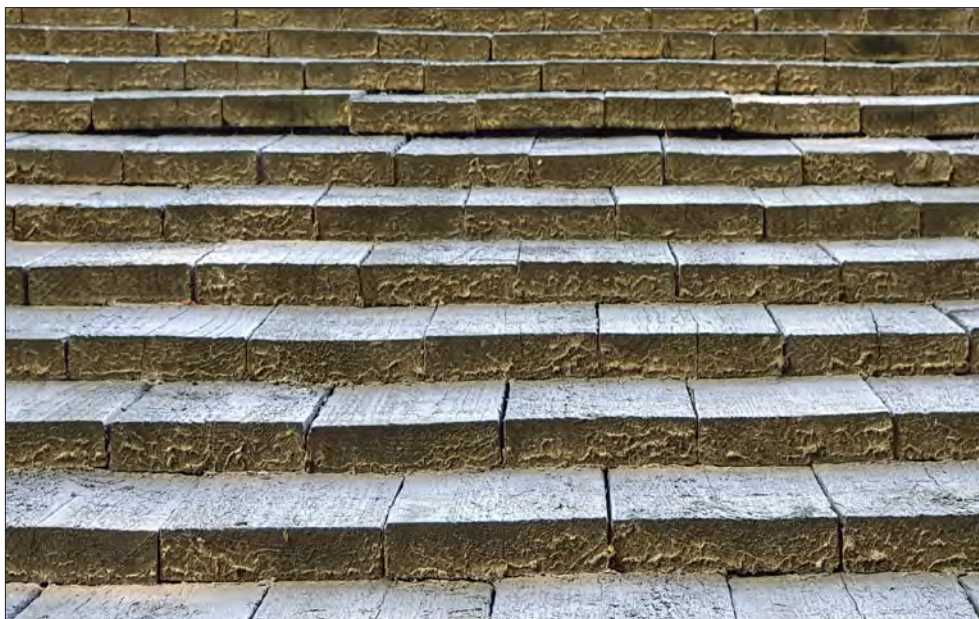
Bro kyrka, stiglucka. Närbild på taktäckningen.
