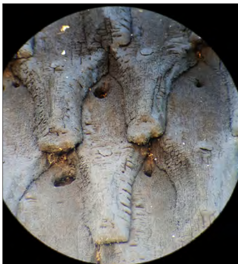
Svedvi klockstapel, sågade spån på östra fasaden.
