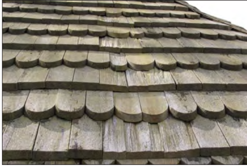
Tillberga kyrka. Sågade spån med ilagningar av kluvna, västra stickluckan.
