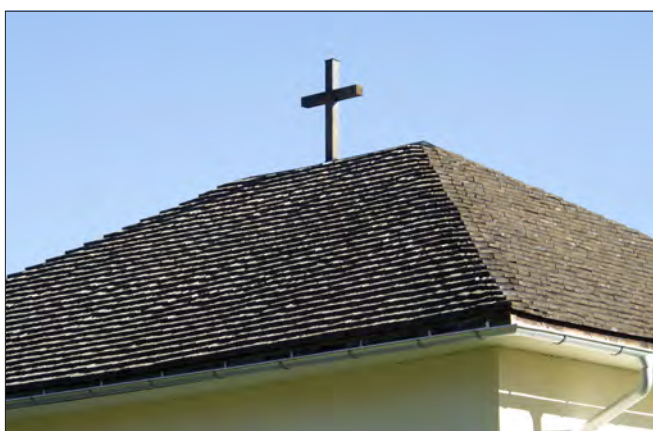
Boda kyrka. Kluvna spån på västra långhustakfallet och äldre spåntäckning på södra gavelgesimsen, foto från södra gaveln.
