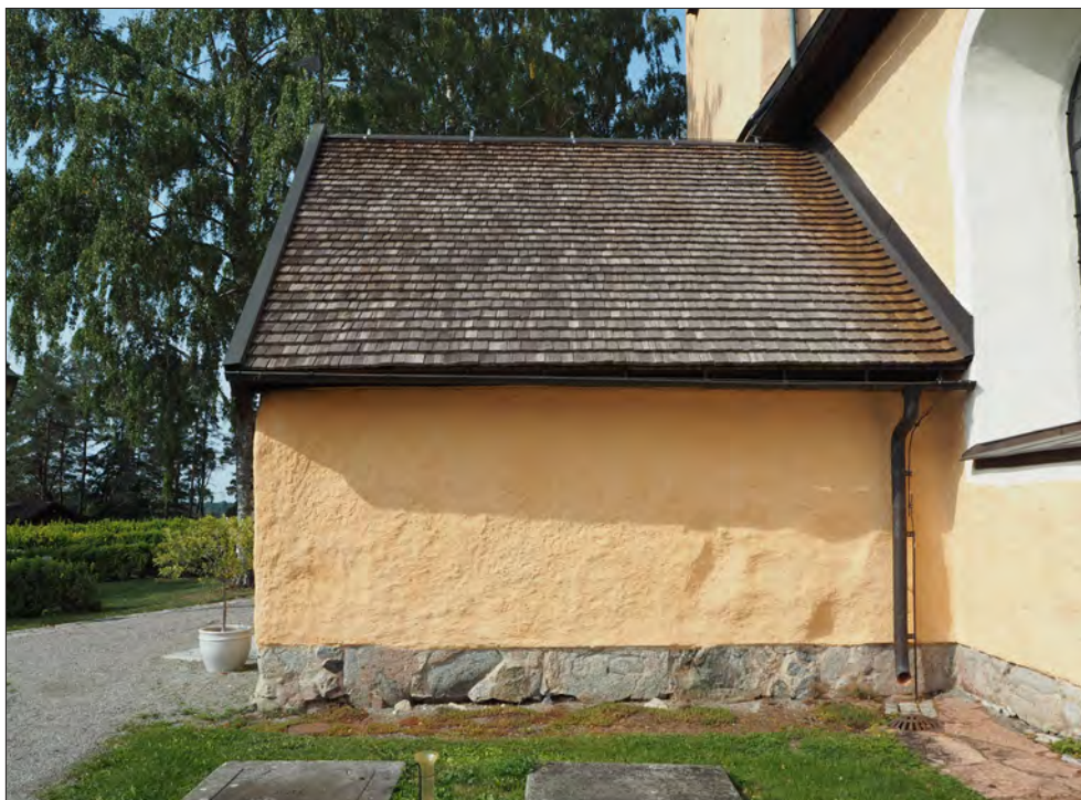
Kumla kyrka. Vapenhusets östra takfall.
