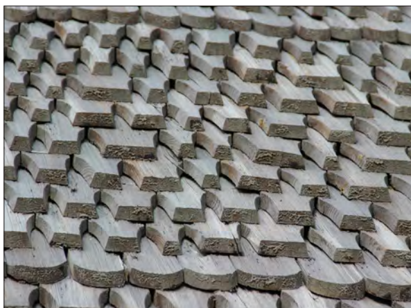
Sala sockenkyrka. På vapenhusets östra takfall lades nya kluvna spån 1998 och enligt entreprenadbandningarna ”spån i likadant utförande som på vapenhusets västra takfall”. De visuella skillnaderna är dock stora på grund av att virke, bearbetning, mått, infästning samt tjärans skikt avviker från den östra sidans.
