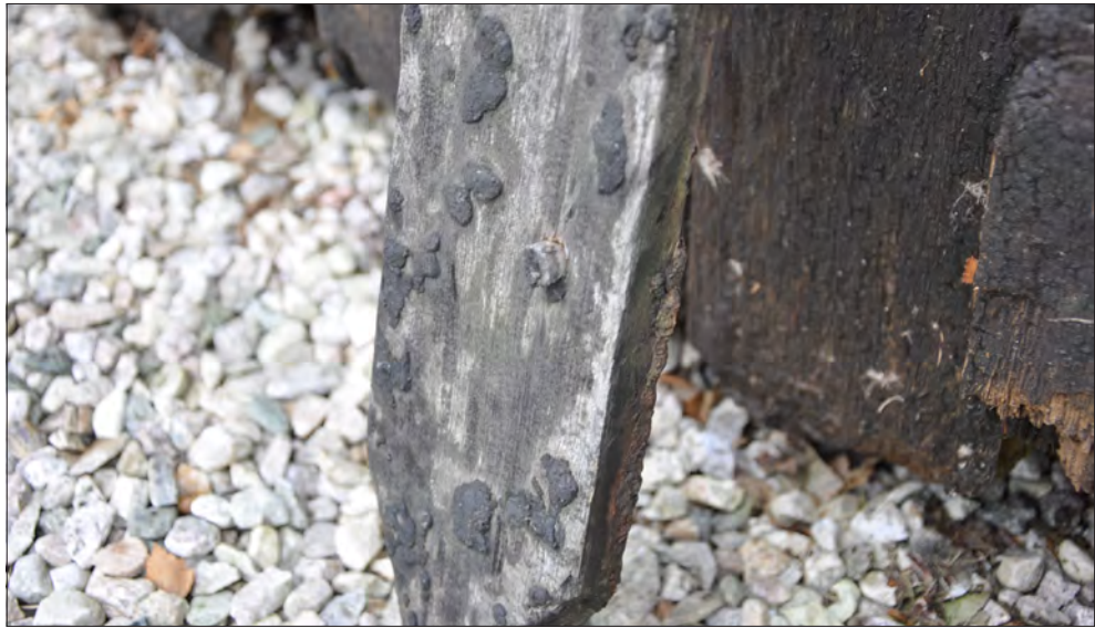
Figur 24. Spån med träplugg för infästning från Kvikene kyrka i Norge. Pluggen är förskjuten från spånets centrum och sitter högre upp i jämförelse med spånspiken som vanligen placeras i spånets centrum längre ner på den synliga delen av bleket. Foto Daniel Eriksson.
