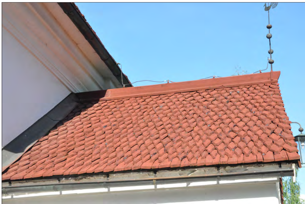
Djura kyrka. Näbbformade, rödtjärade spån är karaktäriserande för Djura kyrka. Här på västra vapenbustakfallet.
