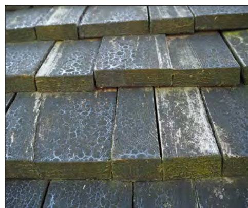
Rytterne bårhus, norra takfallet.
