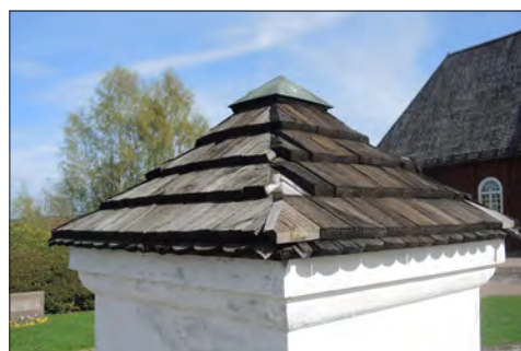
Amsbergs kapell. Sågade spån kröner även grindstolparna på västsidan.
