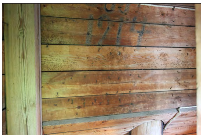
Panel i trappbyggnaden, en generation spånpik. Foto: Lisa Skanser.
