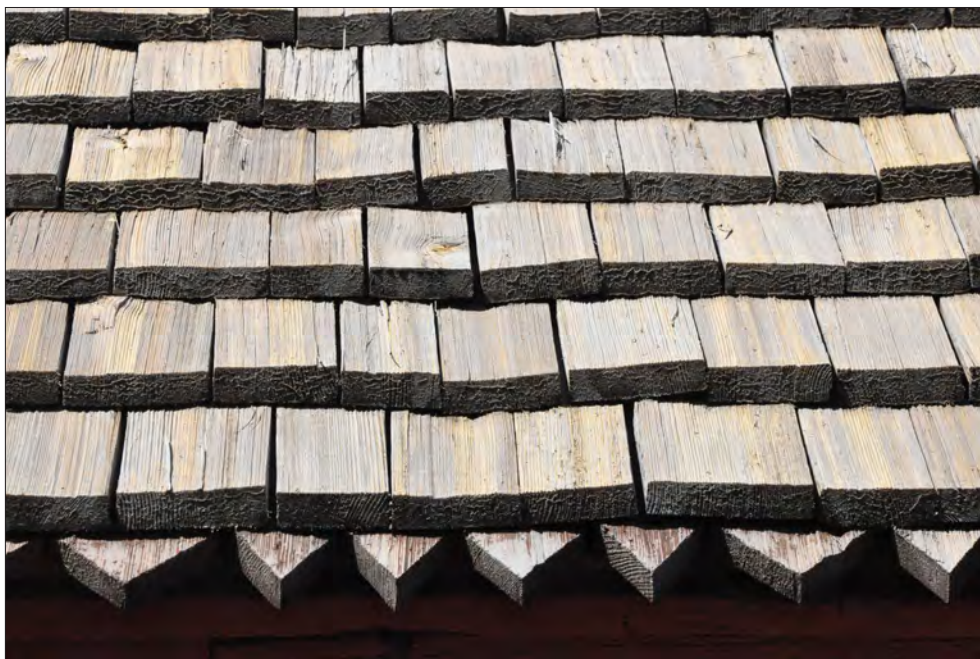
Amsbergs kapell. Klivna spån på vapenhuset
