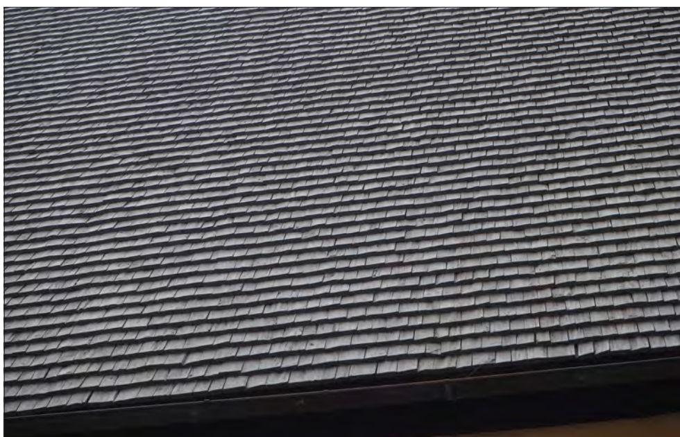
Kumla kyrka. Långhusets norra takfall.
