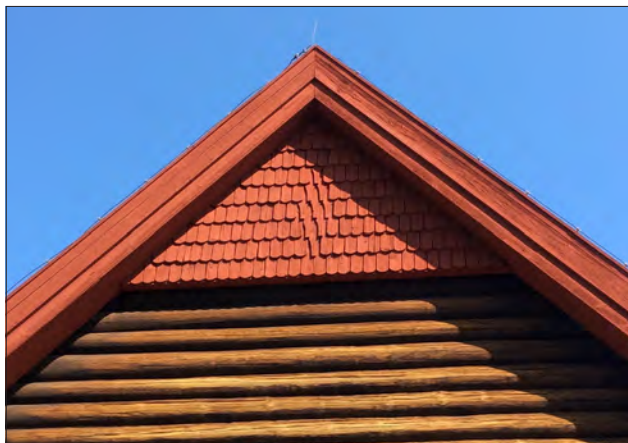
Hörkens kyrka. På den spånklädda gavelspetsen finns ett parti näbbspån i form av en romb.
