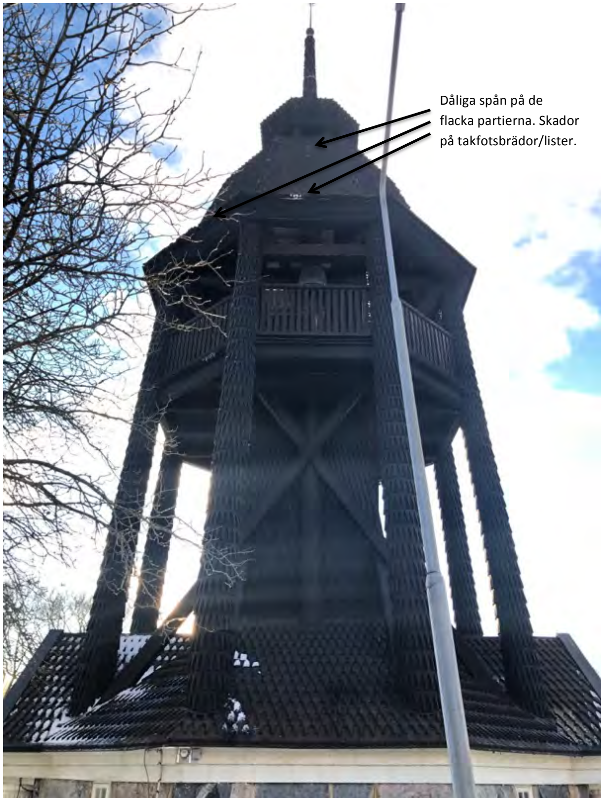
Norr. Enstaka dåliga spån på det lägre taket över stenfoten.
