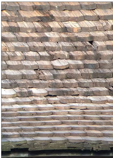
Sala sockenkyrka. På klockstapelns tak ligger eroderade sågade spån. På de nedre slacka partierna har lagningar utförts med sågade spån i tunnare dimensioner.
