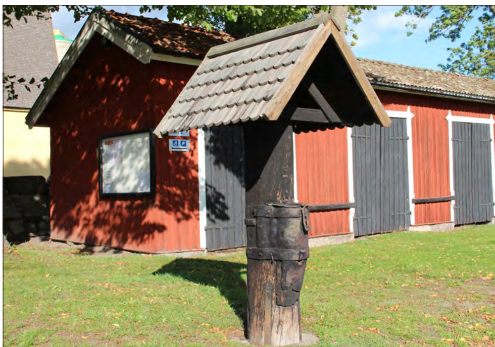
Sala sockenkyrka. Utanför kyrkogårdsmuren i söder finns en gammal fattigböss som har ett skärmtak av sågade spån eller brädlappar.
