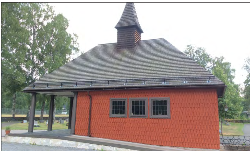
Hällefors gravkapell har raka takspån och näbbformade fasadspån.
