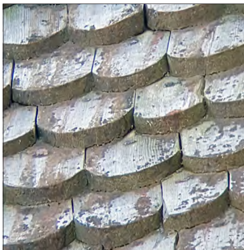
Rättviks kyrka. På kyrkans norra långhustak, närmast tornet, förekommer sågade runda spån. På äldre målningar framkommer att kyrkan tidigare haft runda spån på åtminstone koret och tornet. Kanske har den ursprungliga formen dröjt sig kvar på detta takfall? Även här finns rester av rödtjärasödra korsarmen.
