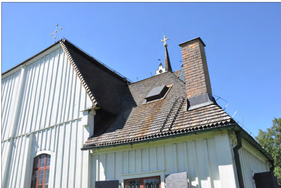
Mockfjärds kyrka. Kyrkans samtliga tak är spåntäckta. Vindskivespån förekommer på hela kyrkan förutom på sakristian.
