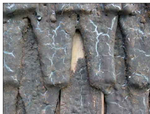
Kungs-Barkarö kyrka. Tornets övre fasad från sydväst. Kring ljudluckorna sitter spån med rak bas. Tornet spånslogs av ryttaren Petter Forsberg år 1784. Spikhål i flera spån tyder på återanvändning så möjligen finns äldre spån.
