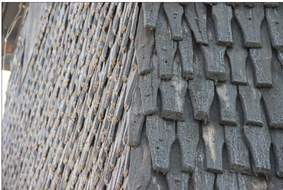
Svedvi klockstapel. Närbild på nordvästra fasadbörn. Läggnings tekniken som använts skapar lätt rundade hörn vilket har stor betydelse i utseendet.
