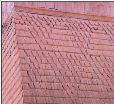
Mora klockstapel. Nordsidans övre fasad bär mönstertäckning i form av triangulära fält, ett mönster som uppges vara ursprungligt.
