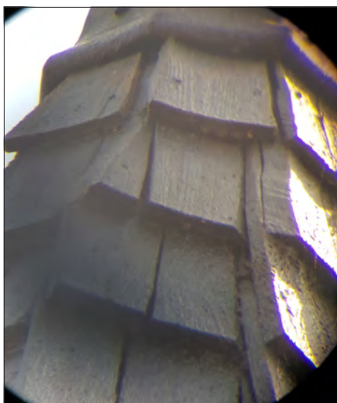
Kvarnsvedens klockstapel. Högre upp på spiran är spånen formbugna i kanterna.
