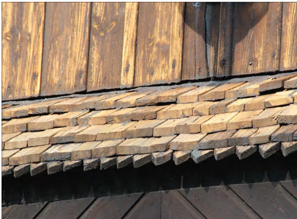
Säby klockstapel. Kluvna ekspån på taket över klockstapelns entré.
