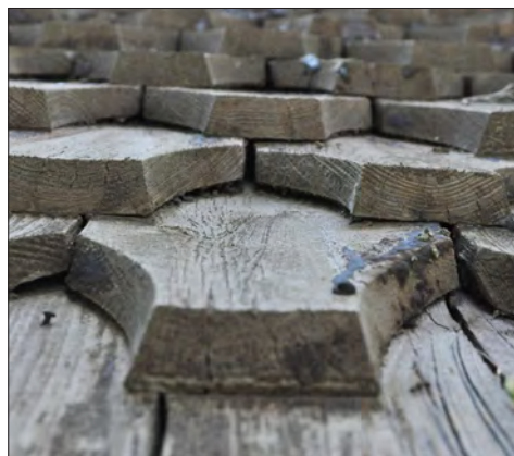
Gagnefs kyrka. Bårhusets sågade, näbbformade spån.
