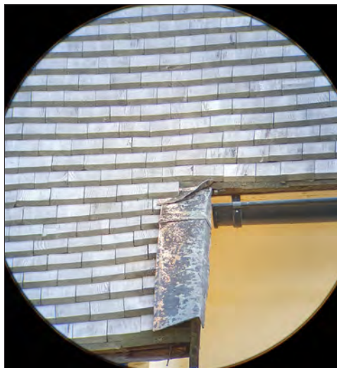
Möklinta kyrka. Sakristian spån, eventuellt från 1982 och behandlade med kreosot.
