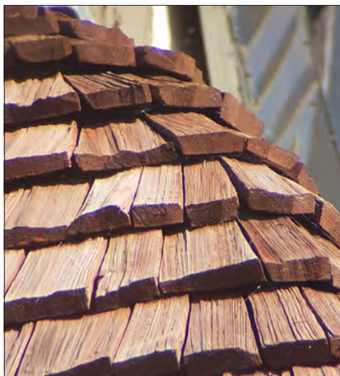
Norrbärke kyrka. Kluwna spån över hörnet på tornbuven.
