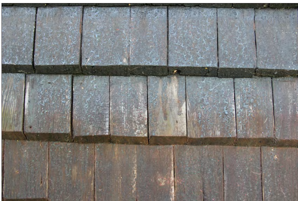
Möklinta klockstapel. Kerosotbehandlade spån på klockstapelns sockel, foto från norr.
