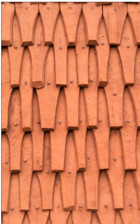
Hällefors kyrka. Fasadspånen är mycket gamla och välbevarade på i stort sett hela kyrkobyggnaden.
