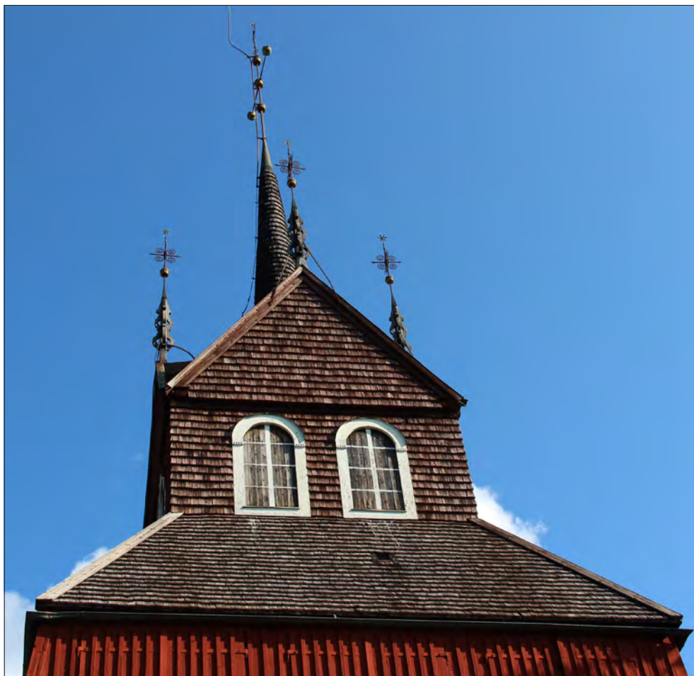
Möklinta klockstapel. Tak och fasad från väster.
