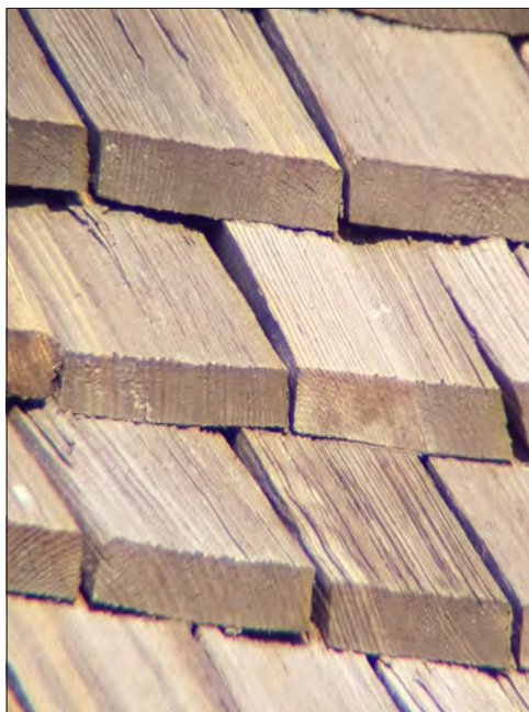
Äppelbo kyrka. Närbild av ett parti på långhusets södra takfall, till sin helhet omlagt senast 1997.
