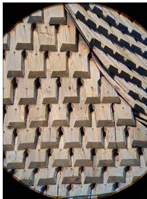
Kungs-Barkarö kyrka. Torntaket taksfall åt söder och öster, mycket liggande årsringar.
