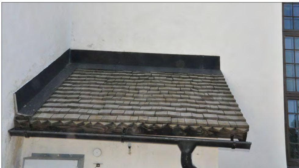
Vika kyrka. Entrétaket med sågade spån.
