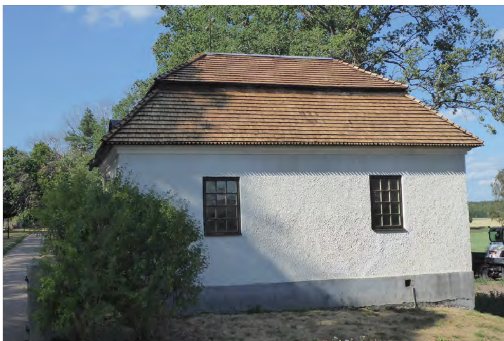
Götlunda kyrka. Bårhusets tak har raka spån med en kant av spetsspån.
