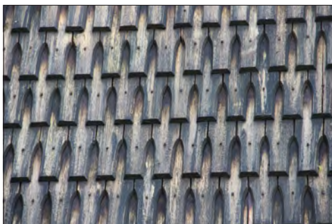
Svedvi klockstapel, sågade spån på östra fasaden.
