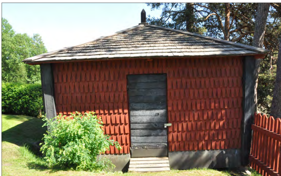
Hosjö kyrka. Redskapsboden har spånklädda fasader och tak. Takspånen har rak kant och hyvlad ovansida, fasadspånen är näbbformade och likadana som på sakristians fasader.
