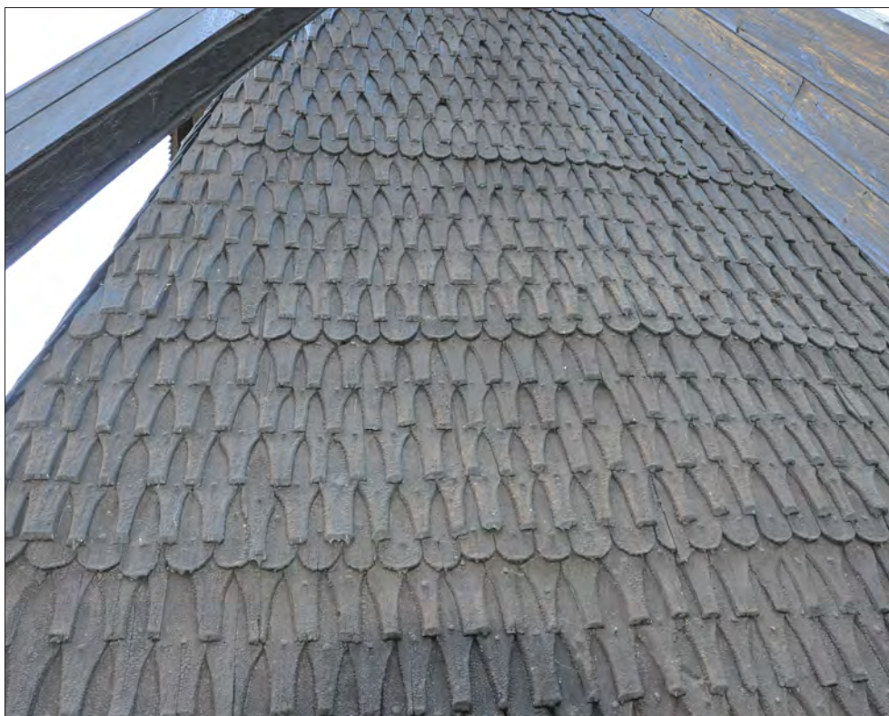
Torsångs klockstapel. Mönsterläggning på västra fasaden.
