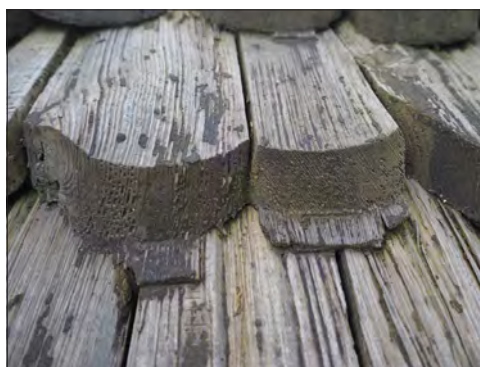
Hovdestalunds begravningsplats. Grindstolpe 1 i söder. Spänens bas har inte sågats ordentligt.
