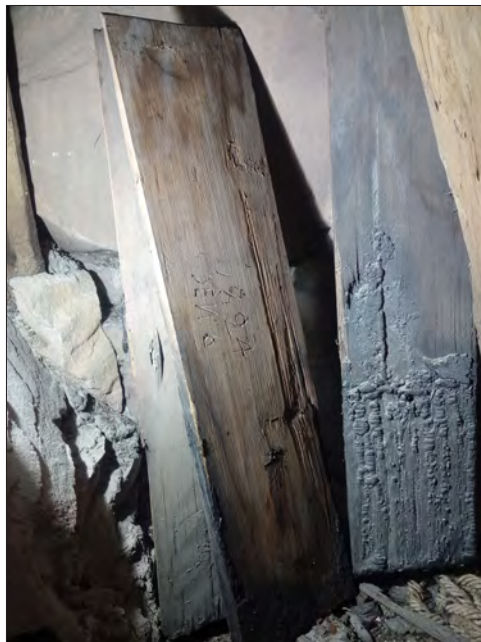
Malungs kyrka. Löst spån på kyrkvinden med årtalet 1824 inristat, bearbetat med hyvel. Foto av Bengt Bygdén 2017.
