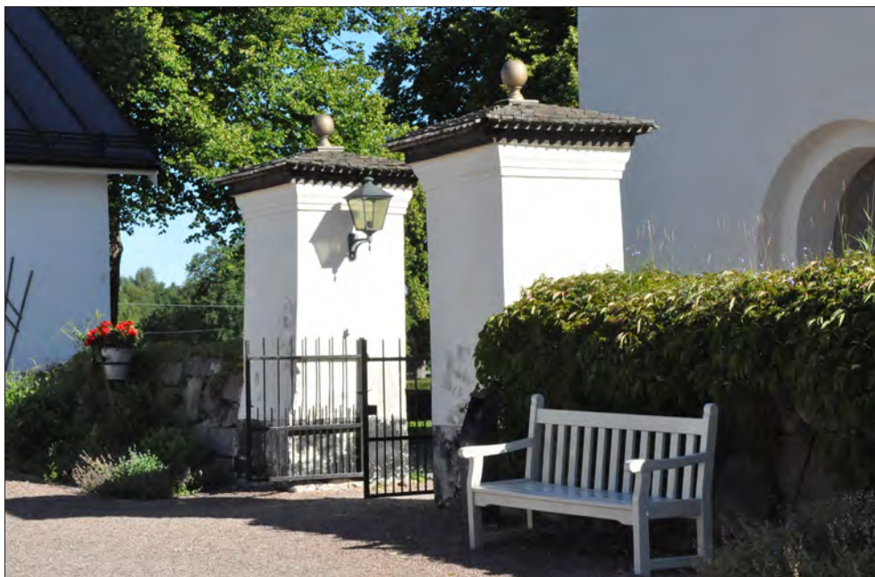
Dala-Floda kyrka. Grindstolpar avtäckta med spån.
