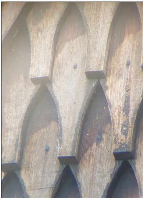
Evertsbergs klockstapel. De näbbformade spånen är sågade och liksom övriga takfall infästa med synlig trädspik.
