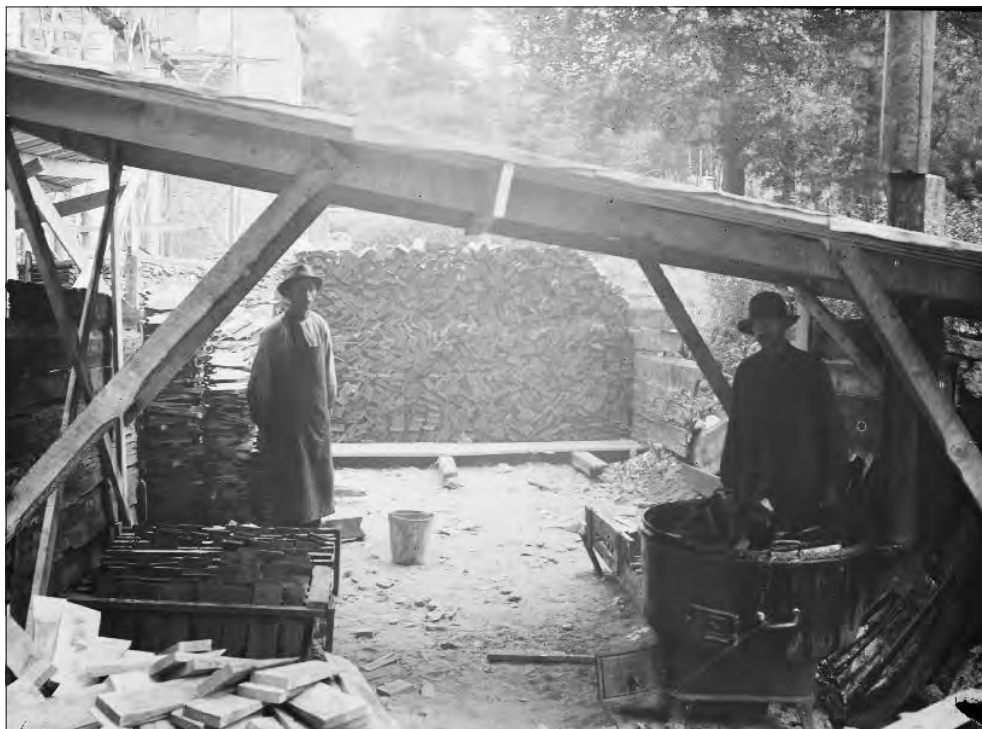
Figur 20. Tjärkokning av takspån vid Varnbems klosterkyrka i samband med kyrkans restaurering, 1910- eller 1920-tal. Foto Axel Forssén. Bildkälla Kulturmiljöbild.
