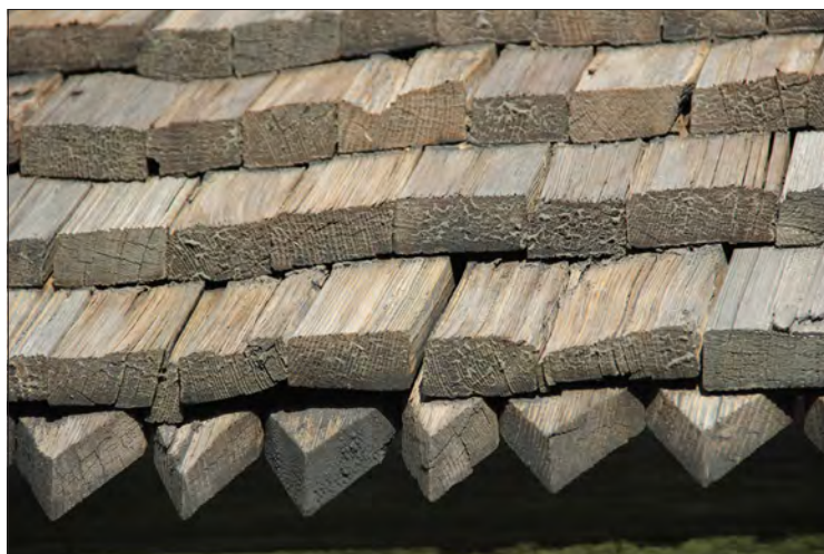
Bergs kyrka, bårhus. Närbild västra takfoten.
