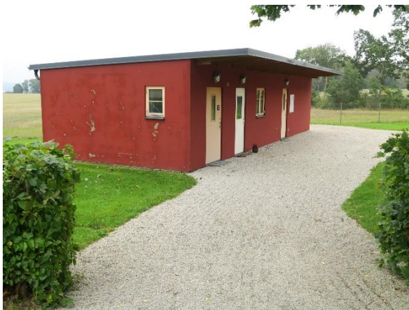
Ekonomibyggnaden vid begravningsplatsen.
