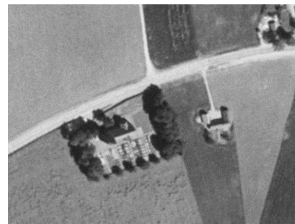
Flygbild från 1975 då vägen norr om kyrkan nyligen var ombyggd. Trädinslaget är i stort sett oförändrat på kortsidorna sedan 1940-talet. En tidigare trädrad norr om kyrkan är borta och sannolikt är raden av lindar i söder planterad.
