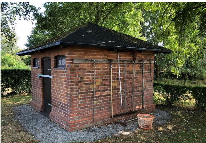
Nya kyrkogårdens förrådsbyggnad i det sydöstra hörnet.
