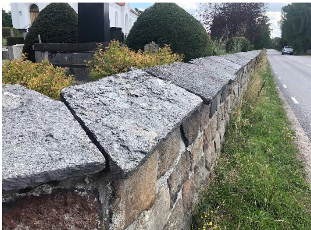
Fogad stenmur utmed Holmbyvägen i söder.
