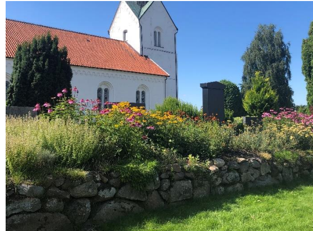
Kallmurad stödmur av fältsten mellan den gamla och nya delen av kyrkogården.
