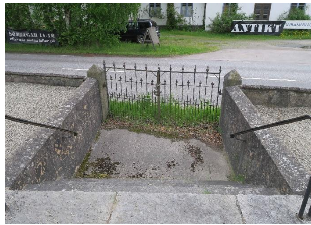
Grind och trappa mitt på den södra långsidan.
