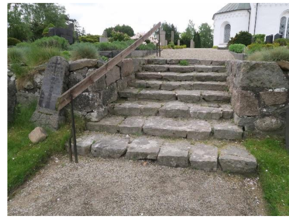
Central stentrappa mellan den nya och gamla delen.
