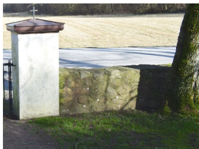
Gamla kyrkogården. Mur mot öster. Inside
