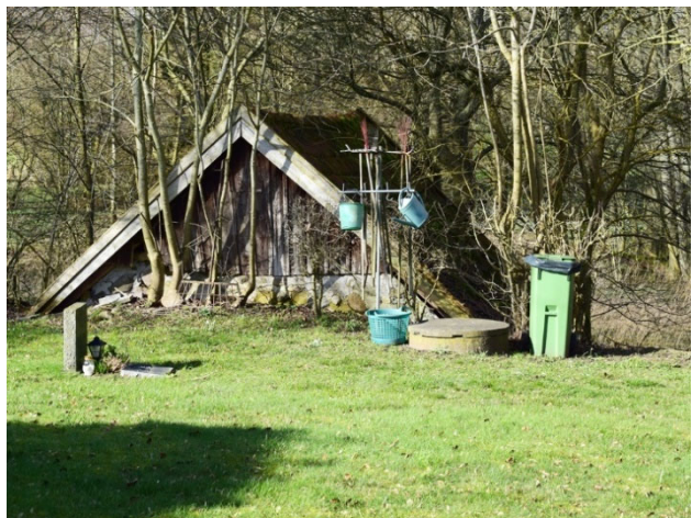
Den gamla förrådsbyggnaden strax norr om kyrkogården
