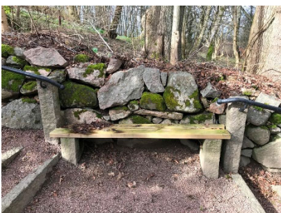
Enkel bänk i trappan i norr
