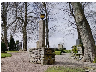
Belysning på granitpelare med kallmurad sockel
