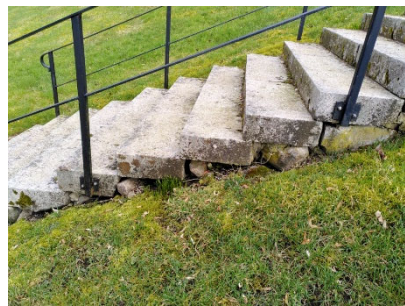
Trappa i väster, av granitblock
