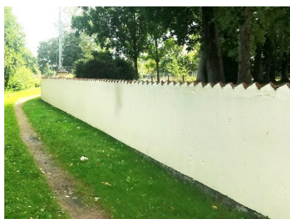
Mur öster om portalen, sedd från utsidan
