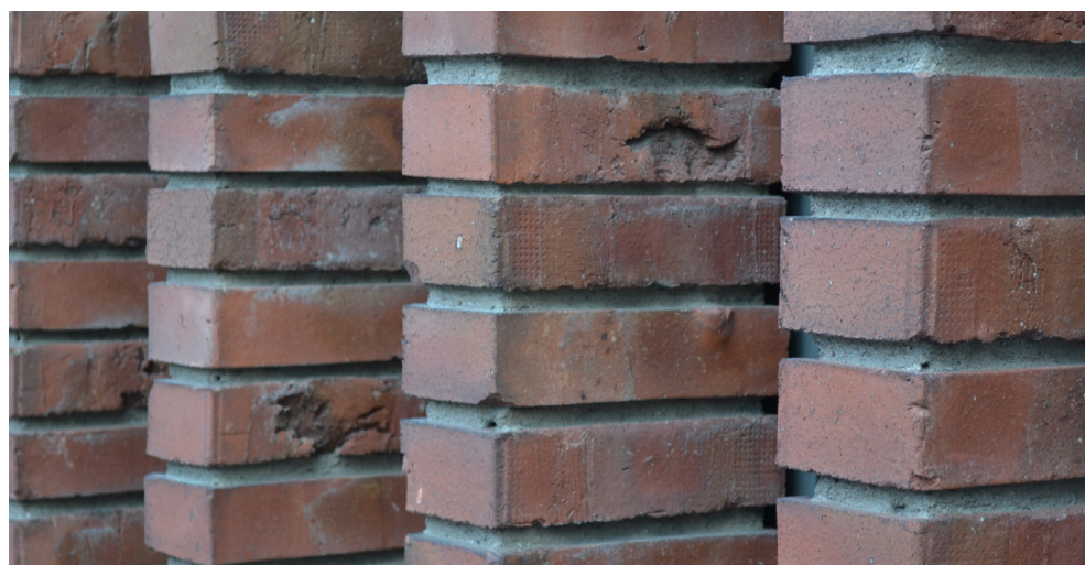
Vantörs kyrkas västra och södra fasad, 2018.
