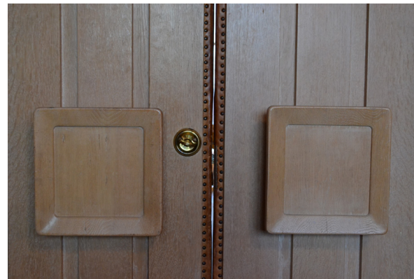
Dörrhandtag och kanter på dörrarna inklädda med fastnitat läder.
