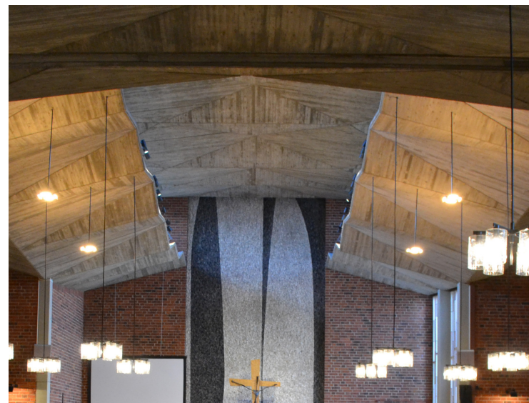
Det veckade taket i betong, 2018.
