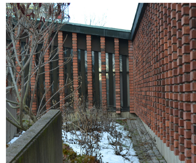
Fönsterpartier på Vantörs kyrkas västra och östra fasad, 2018.
