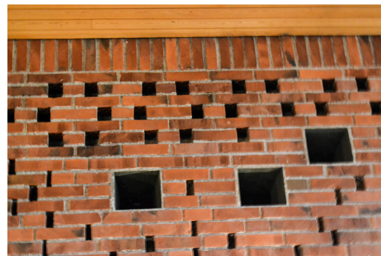
Öppningar i vägg till bakomliggande f.d. maskinistrum i församlingssalen, 2018.
