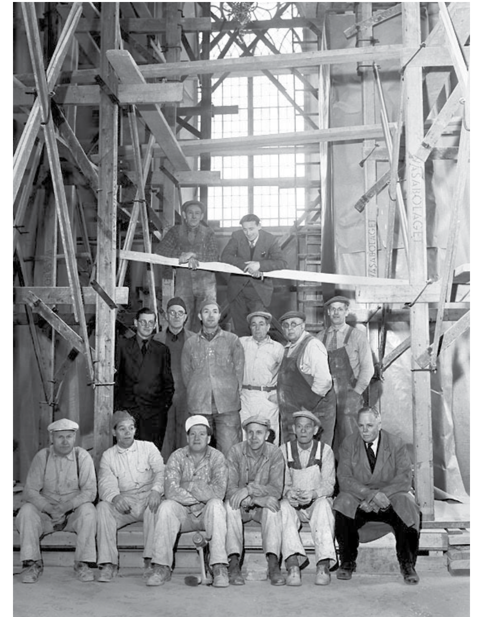
Hantverkare i Storkyrkan vid restaurering av interiören vid 1900-talets mitt.
