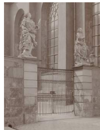
Bilden till vänster visar de ursprungliga grindarna åt Trångsund i väster. Till höger syns östra grindparet som byttes ut 1903. (Foto: SSM).
