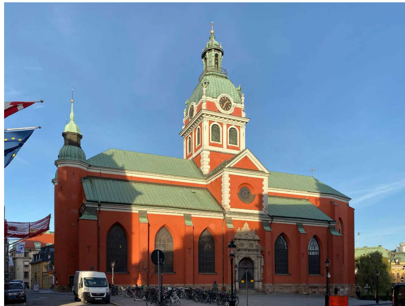
Koppartäckningens sammanhållande effekt för exteriören präglar i hög grad kyrkans arkitektoniska uttryck.
