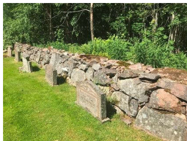
Kyrkogårdsmuren längs nordöstra sidan
