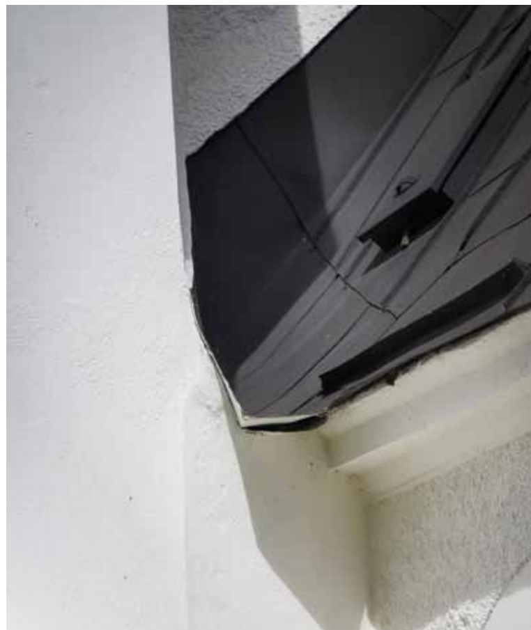
Takfall i hörnet mot en yttervägg där det är extra viktigt att hålla helt och rent. Kontrollera att både ståndsiva mot vägg och taklucka håller tätt.
