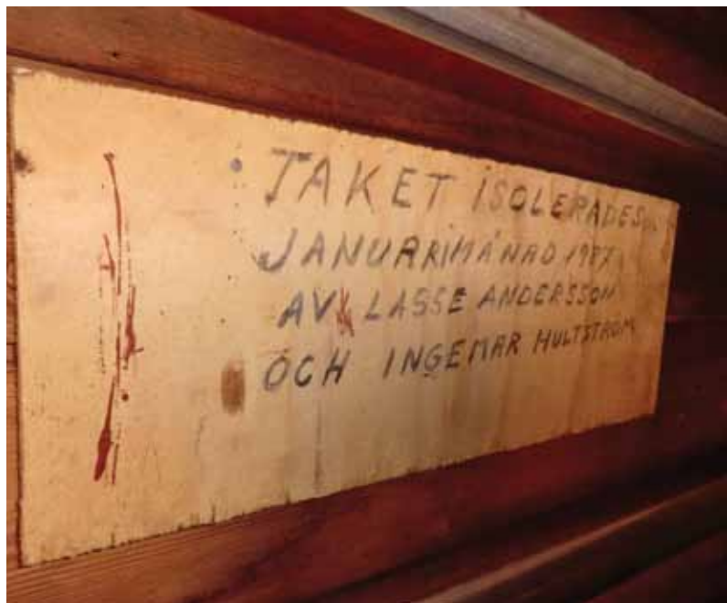
Tydlig dokumentation av tilläggsisolering.
