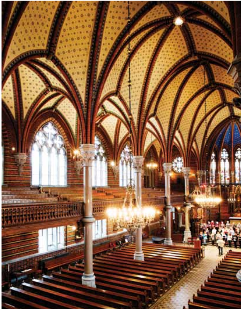
Valvbågar i Allhelgonakyrkan i Lund.
