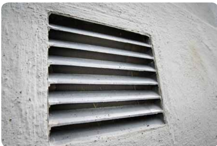
Ventil med insektsnät i grundmuren.
