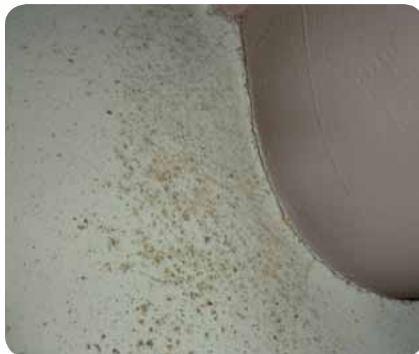
Infästningen, i närbild, där det bildats ett mikroklimat med mögelpåväxt som följd.
