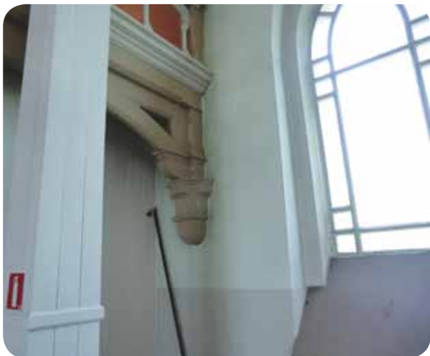
Infästning av läktaren vid yttervägg i Nya Bokenäsets kyrka.
