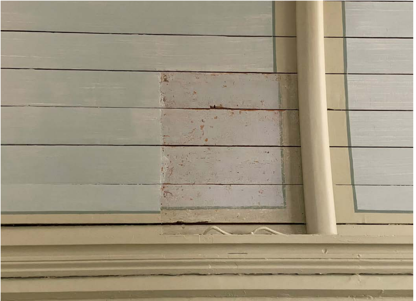
En lite ruta sparades av de ursprungliga färglagren. Läktaren, österut invid tornmuren.
