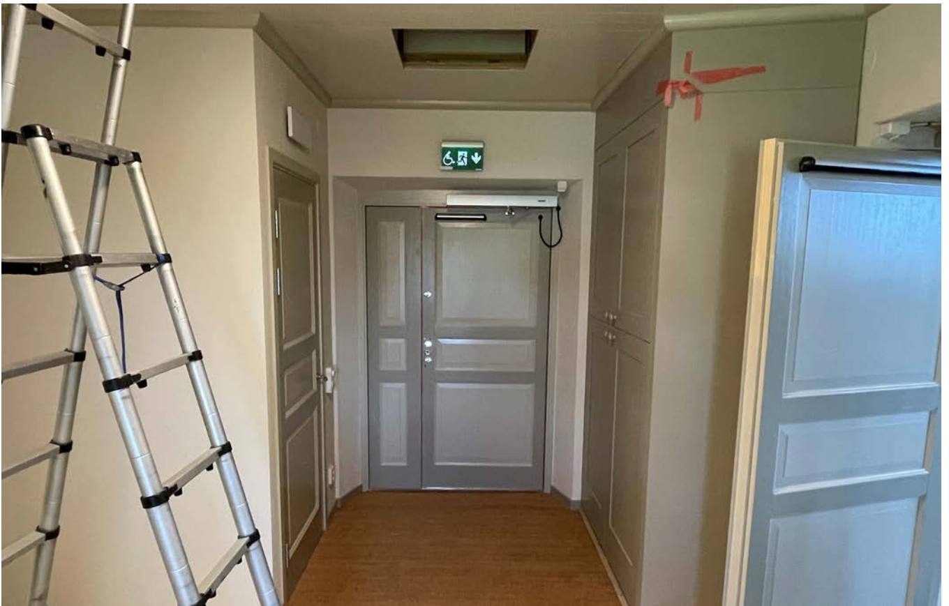
Utrymningsskyltarna är hämtade från biografmiljön, för att även passa i kyrkor. De är lite lågmält belysta vid normaldrift, men om strömmen går, lysas de upp starkare (med hjälp av batteribackupen).
