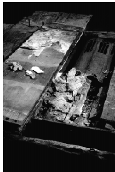
Altarskåp, Uppsala domkyrka. Gammalt angrepp av hussvamp som blommat upp på grund av kondensvatten från fönster bakom skåpet. Foto: H.P. Hedlund.
