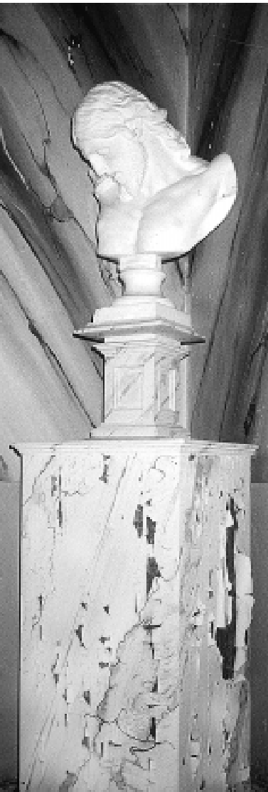
Flagnande spackelgrund i sakristian på Strömholms slott. Foto: H.P. Hedlund.
