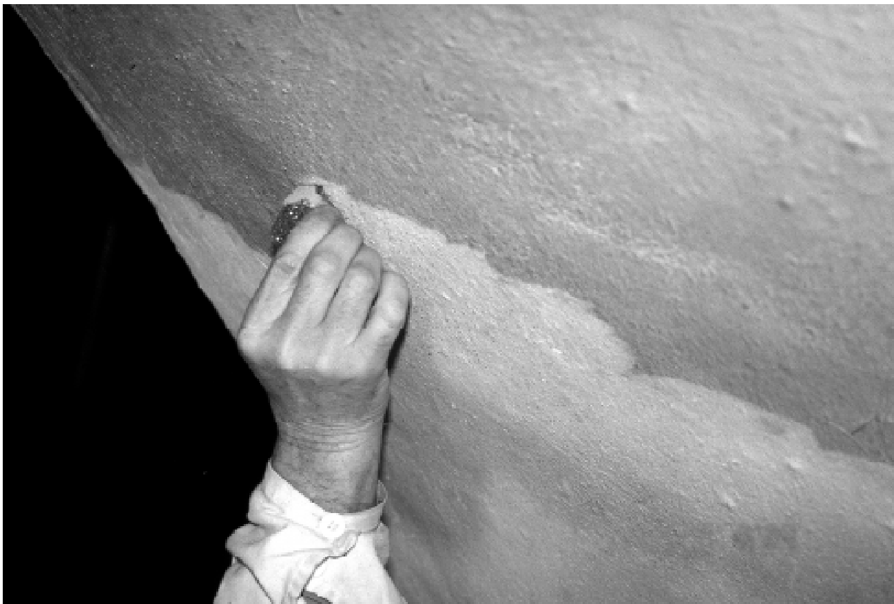
Den viktigaste åtgärden för kalkmålningarnas del inför en längre periods avstängning av värmen är att ytsmutsen avlägsnas. Här ett exempel på torrengöring. En metod som är lämplig för porösa ytor. Foto: I. Hemgren.
