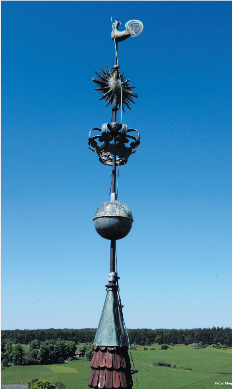
Tornspiran före renovering.
