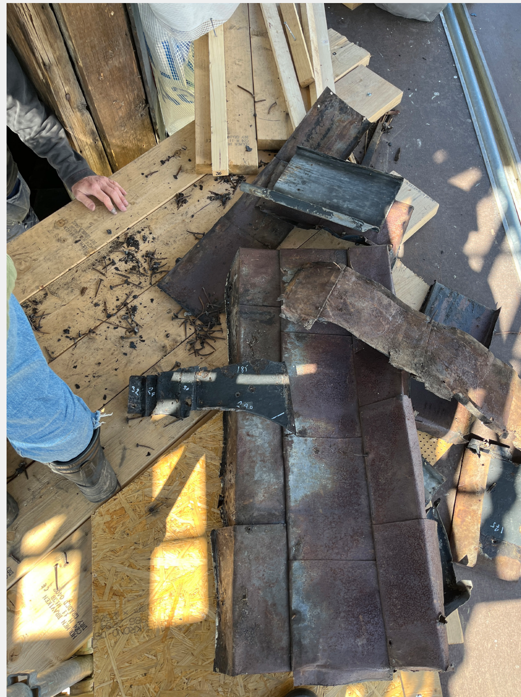
Krönlistens plåt demonterad.
