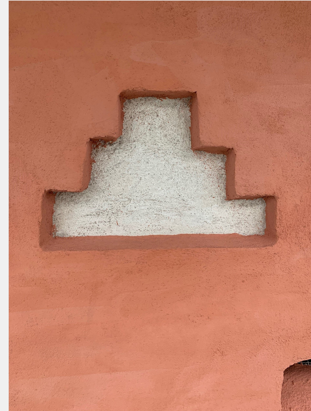
Ny kalkputs på tornets övre del.
