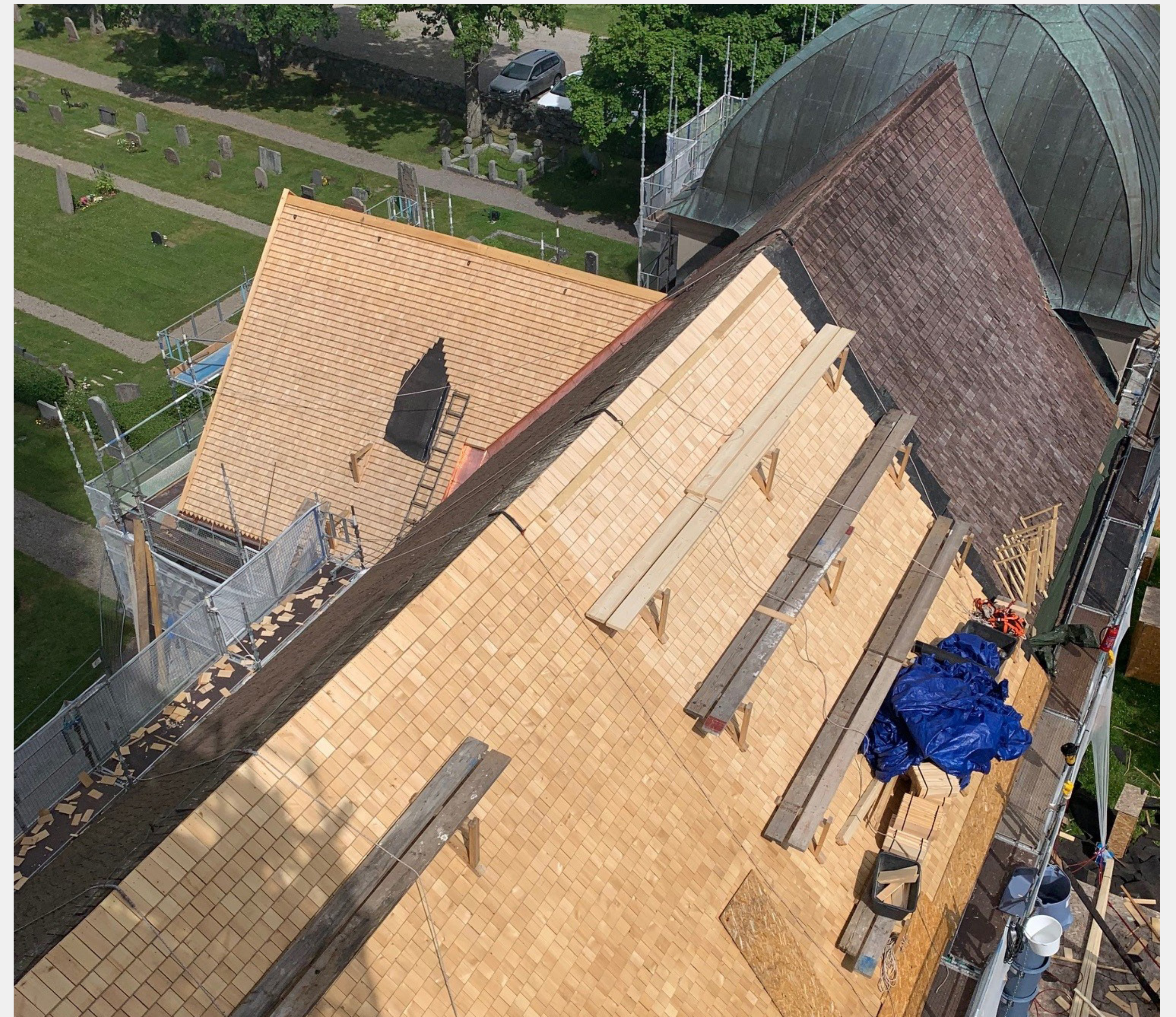
Långhusets och sakristians tak under restaureringen.
