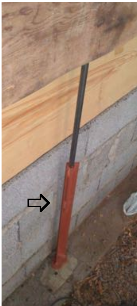
Det svetsade nedre förankringsjärnet.
