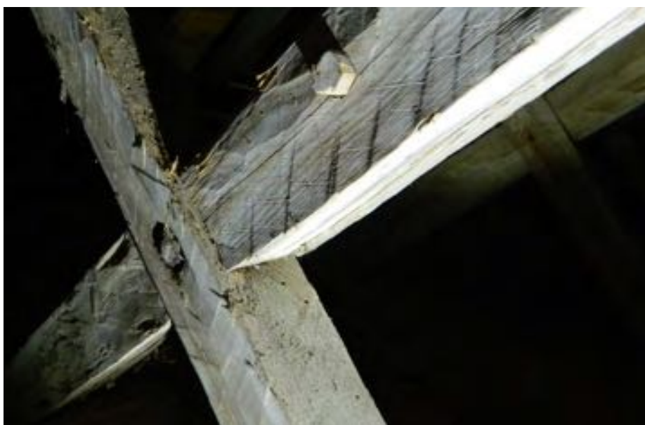
Sprätthuggning från 1110-talet med skadad yxegg.
