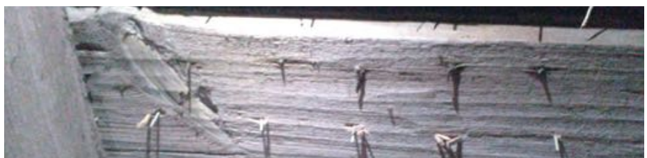
Trobrädor bearbetade med skave. De moderna spånpikarna har gått igenom trobrädan.
