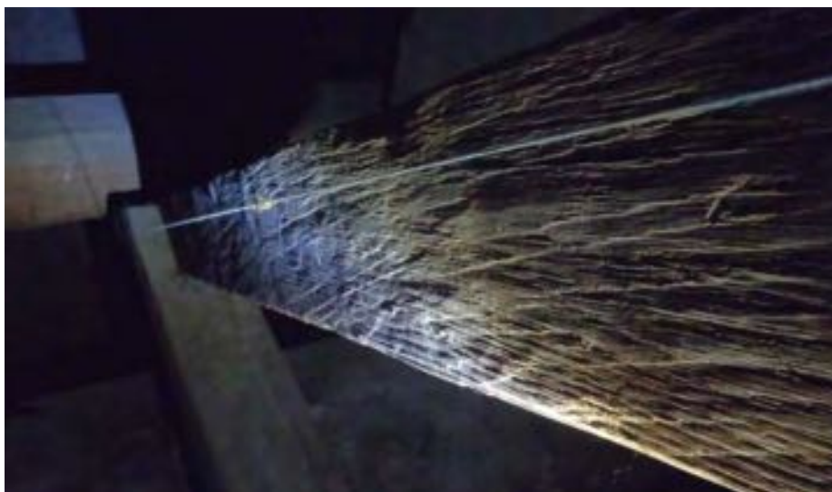
Skrädning eller bilning tvärs fibrerna, högben, Forshems kyrka.
