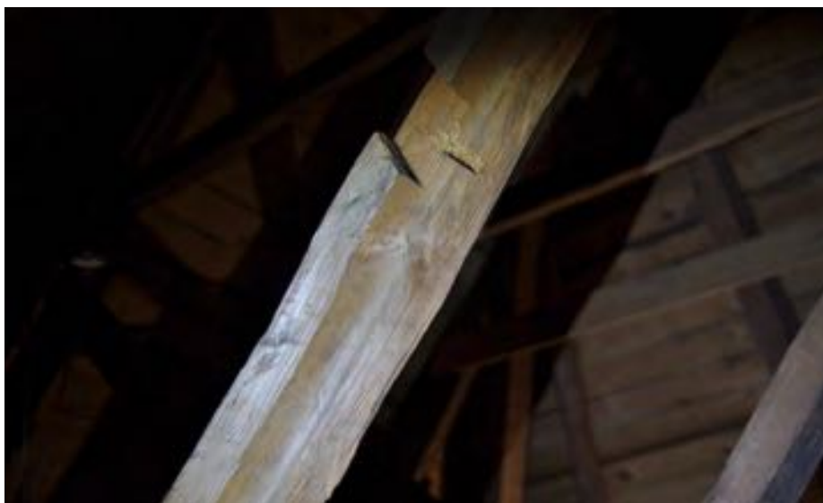
Återanvänd stötta i långhuset i Mofalla kyrka.
