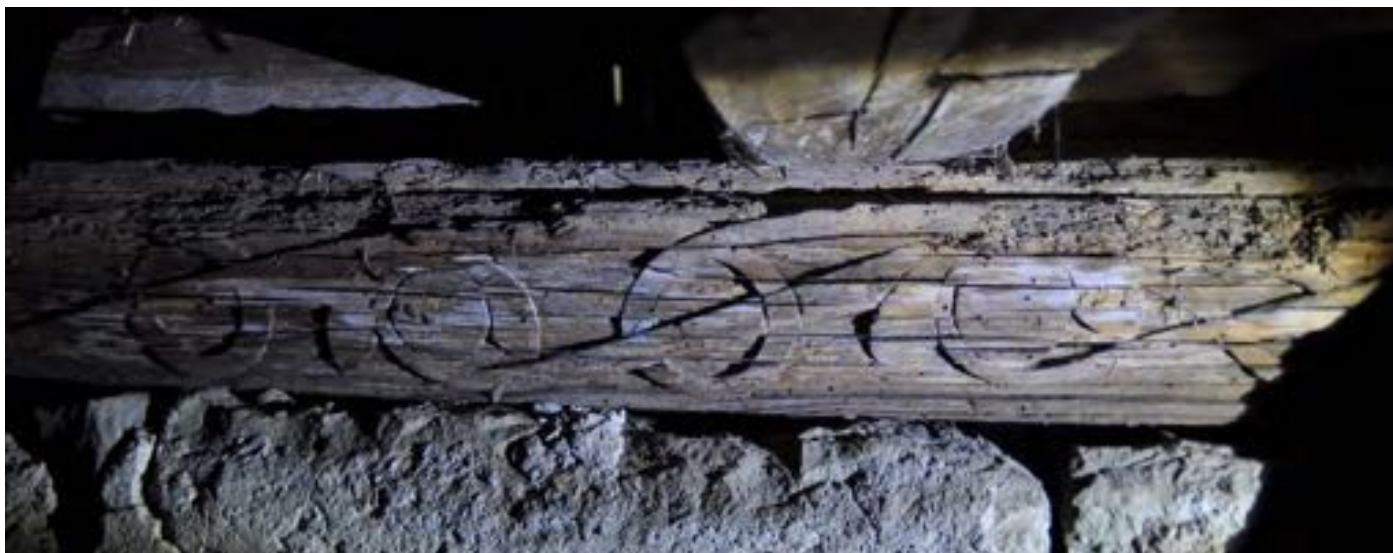
Ornamenterat remstycke mot sakristian i Skalunda kyrka.
