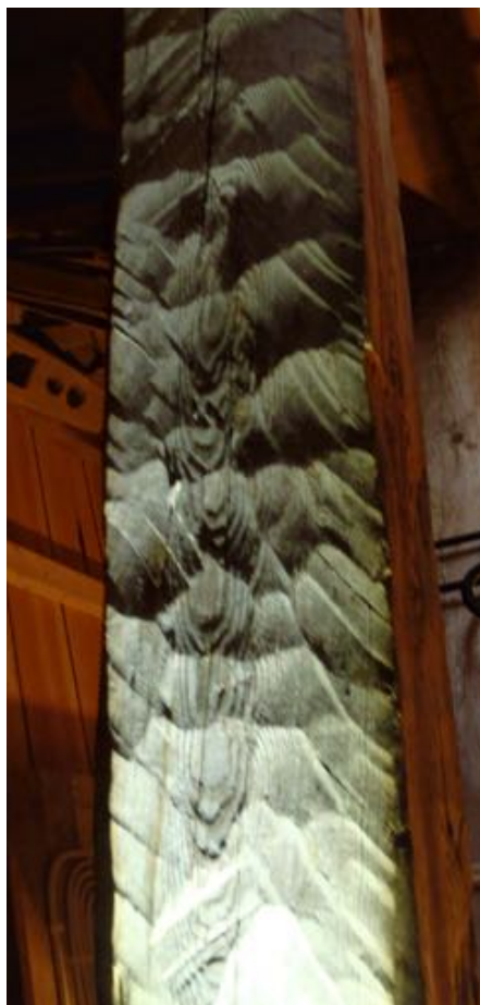
Hjärtstocken med svårdefinierad behuggning.
