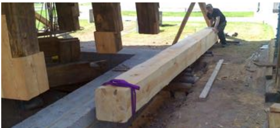
Här drar Jörgen syllen för handkraft på rullen sakta men säkert.
