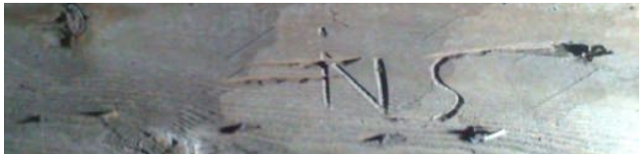
Timmermansmärkning på trobrädor.
