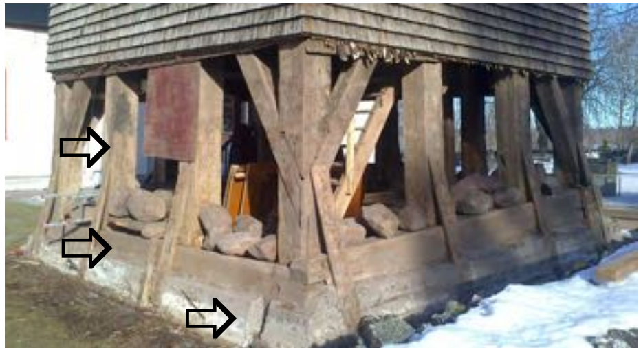
Pilarna markerar de medeltida benen, reparationssyllarna och betonggrunden.
