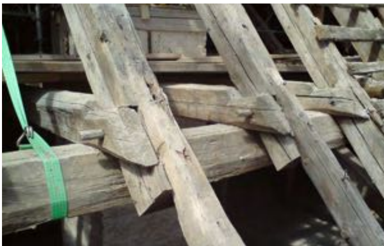
Avkapade högben med ”tillfälliga” iskarvade ben nedtill.
