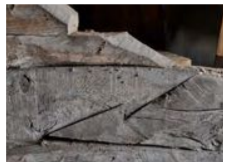
Snyggt blixtskarvad dubbelsyll, sågat möter skrätt virke.
