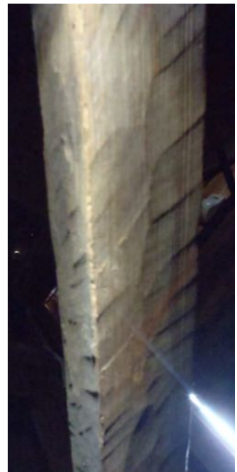
Sprätthuggen konsolsträva gjord av kvartsklova, troligen återanvänd från äldre stapel eller kyrka.
