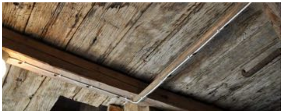
Det övre golvets undersida med återanvända brädor.
