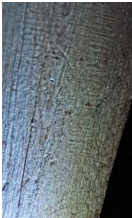
Vibrationsspår efter hyvel/skave på stapelns stomme.
