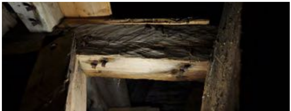
Slinthuggen/sprätthuggen yta och skarpa hörn på klockbjälken.
