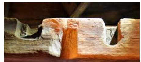
Gamla urtag för klockupphängning i stapelns bjälkar.
