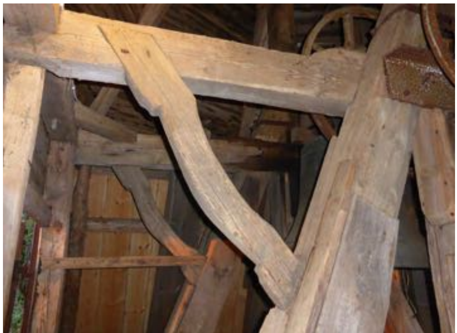
Marka klockstapel – utsmyckad konsolsträva med husad knut i klockbjälken.
