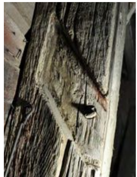
Bortplockad kryssräva visar knutens insida.
