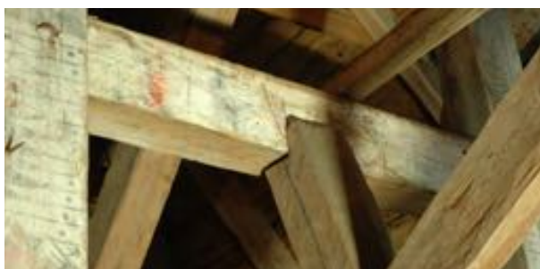
Återanvänt, bemålat timmer från äldre kyrka.
