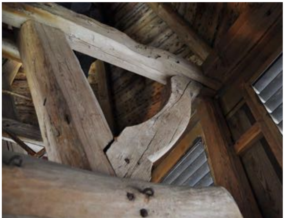
Konsolsträva med fin bågform.
