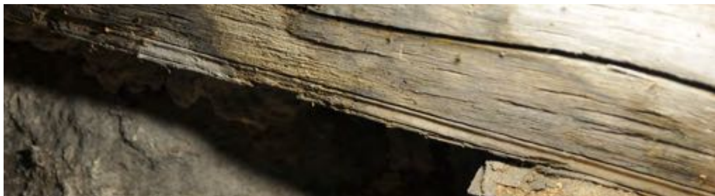
Profil på bindbjälke i Ods kyrka.
