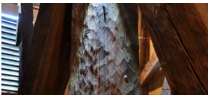
De äldsta bjälkarna är bilade med små hugg.
