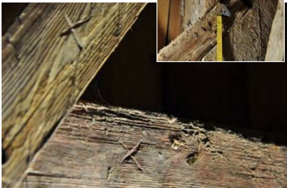
Timmermansmärkning med x. Vid tumstocken: "Hel-i-halvt"-husad knut.
