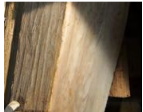
Handhyvlade bjälkar i stommen.
