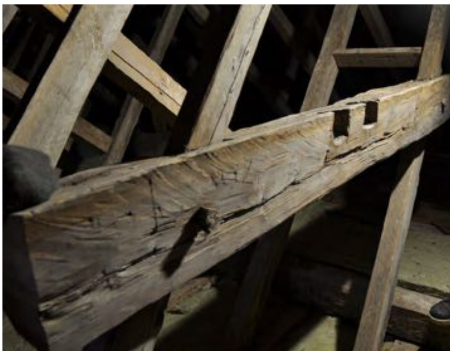
Trolig klockupphängningsanordning i takstol i Ekeskogs kyrka.
