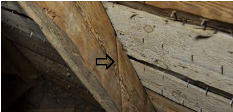
En bjälke bär spår av slitage från repet tillklockorna.
