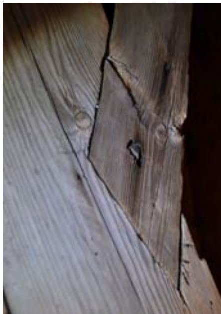
Konsolsträvorna är fästa med smidd spik.
