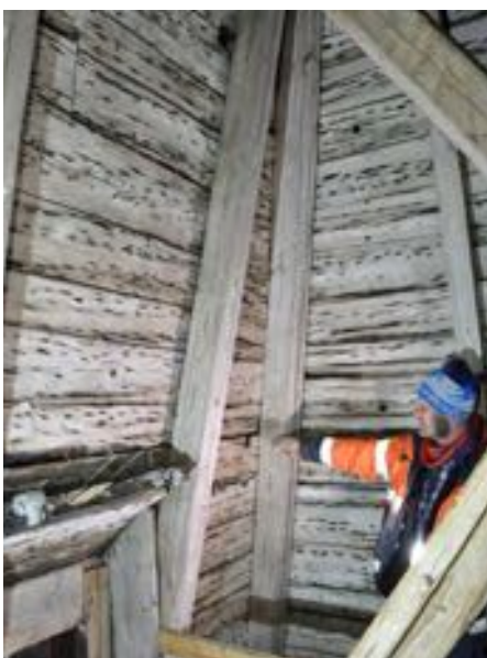
Trobrädor av asp med hål för byggnadsställning.
