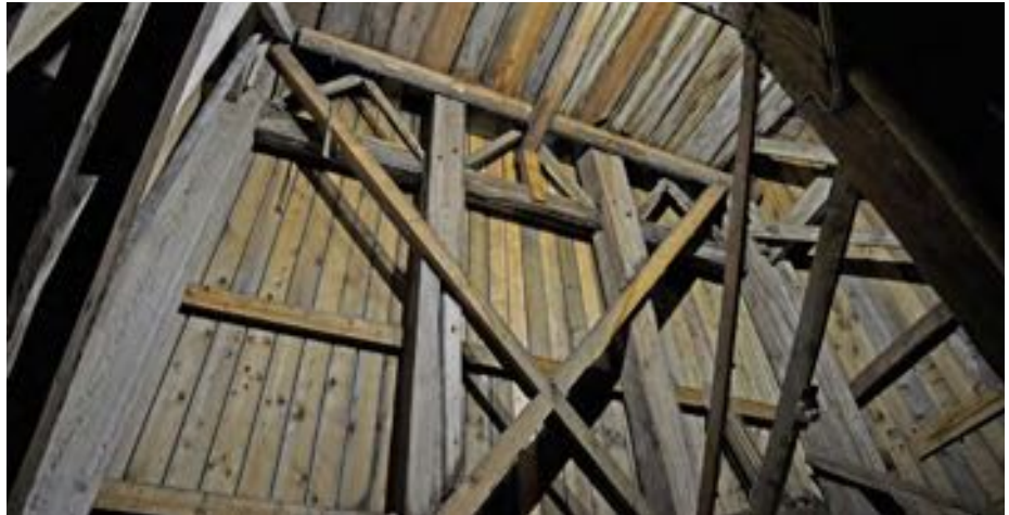
Del av tornets monumentala konstruktion.
