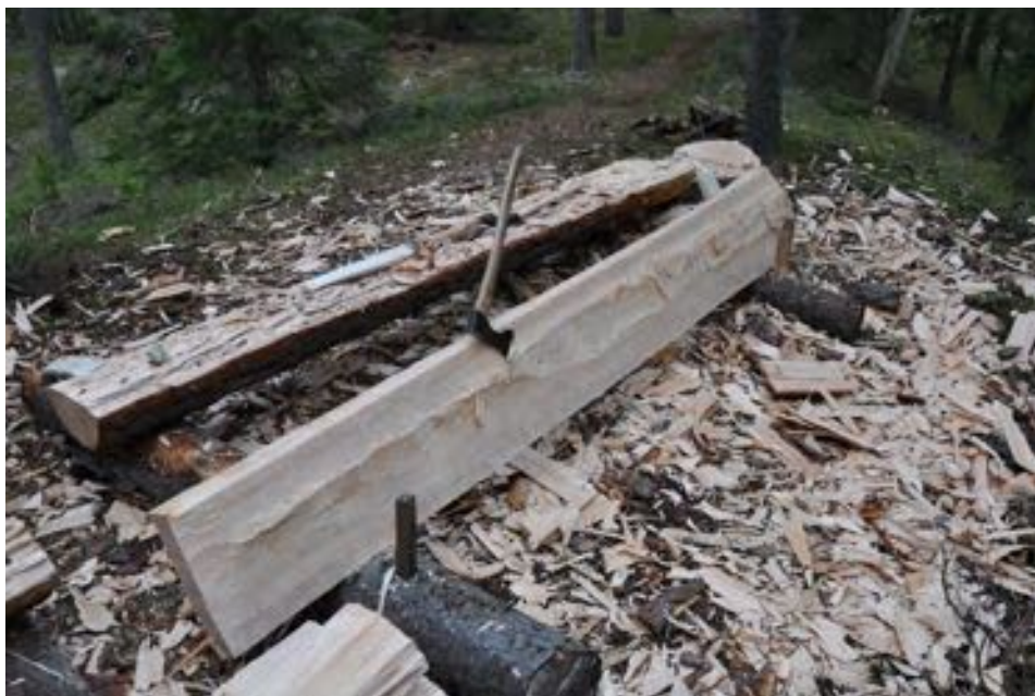
Sprätthuggning till kyrkbygget i Södra Råda.
