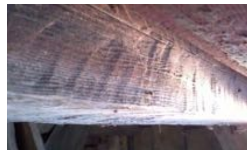
Spår av sprätthugning – återanvänt virke?
