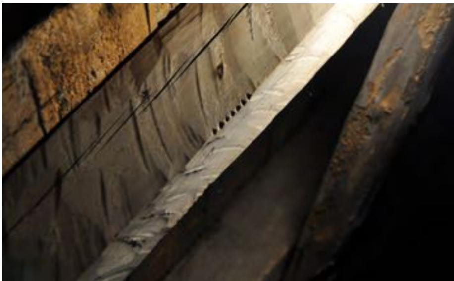
Takstol nummer 8 med timmermansmärkning. Ekeskogs kyrka.
