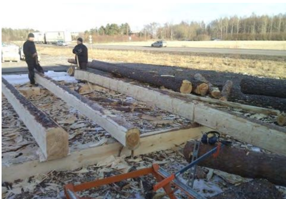
Bilder från när träd fälls och timmer huggs till Marka klockstapel.
