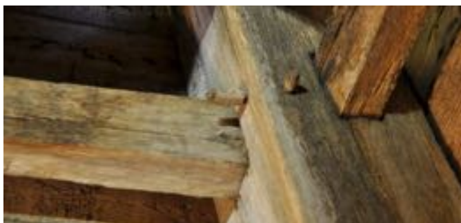
Utsmyckade dymlingar i hörnstolparna.
