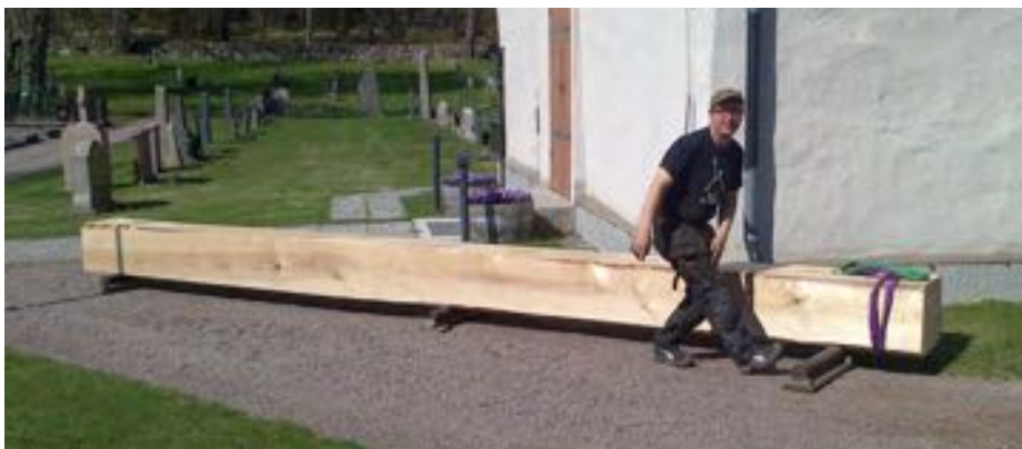
Här drar Jörgen syllen för handkraft på rullen sakta men säkert.
