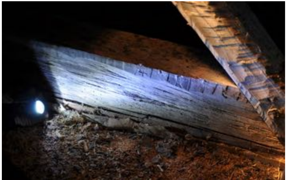
Exempel på "efterbredbilning". Med bilyxa borthuggen sprätthuggning.
