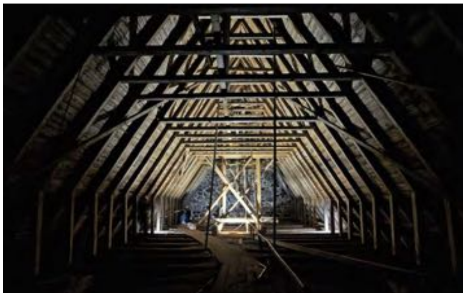
I mitten, i ljuset, syns fundamentet till takryttaren som funnits tidigare.
