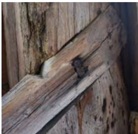
Möte tornben-krysssträvans övre del.
