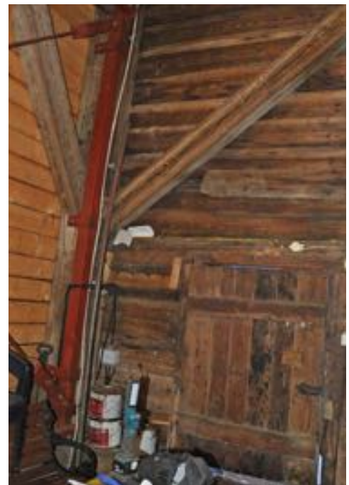
Förstärkning med järnbalkar och stag.
