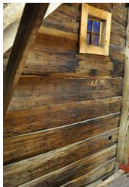
Panelens insida. Panelen är nu spånklädd på utsidan men var tidigare oklädd, så kallad panel på förvandring.
