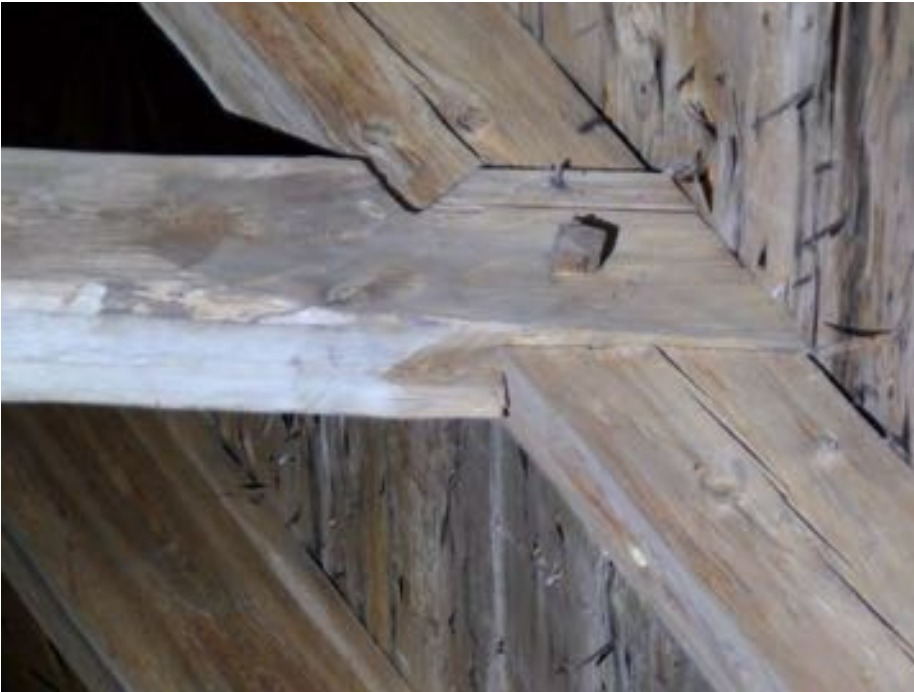
Långhuskonstruktionens knutpunkter med nacke i Breviks kyrka.
