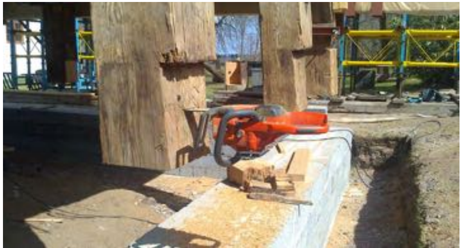
Här figursågas några av benen för att repareras.
