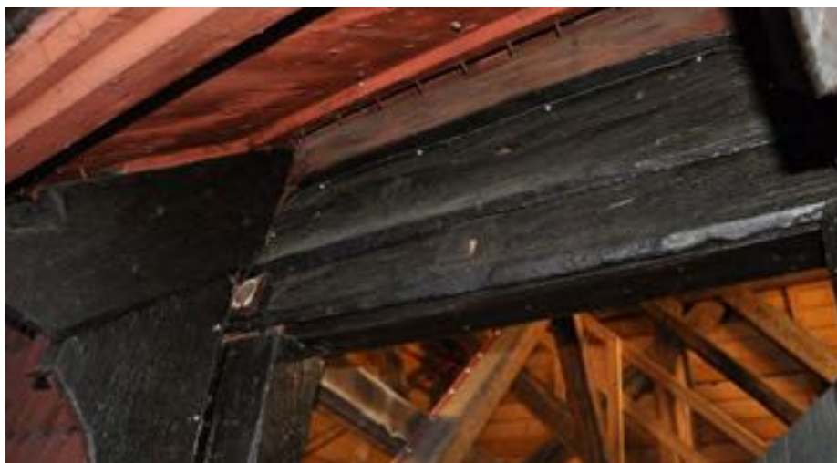
De svarta brädorna är rester av en äldre ytterpanel från tiden då stapeln inte var spånklädd.
