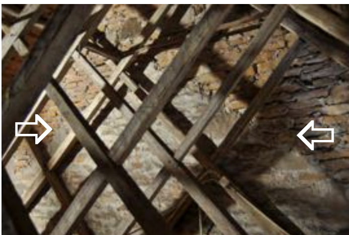
I gavelröstet syns spår av ett äldre takfall.
