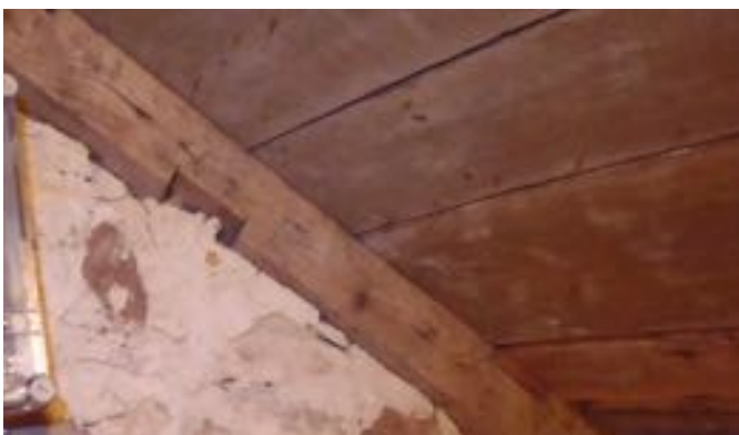
En återanvänd bjälke på kyrkans vind.
