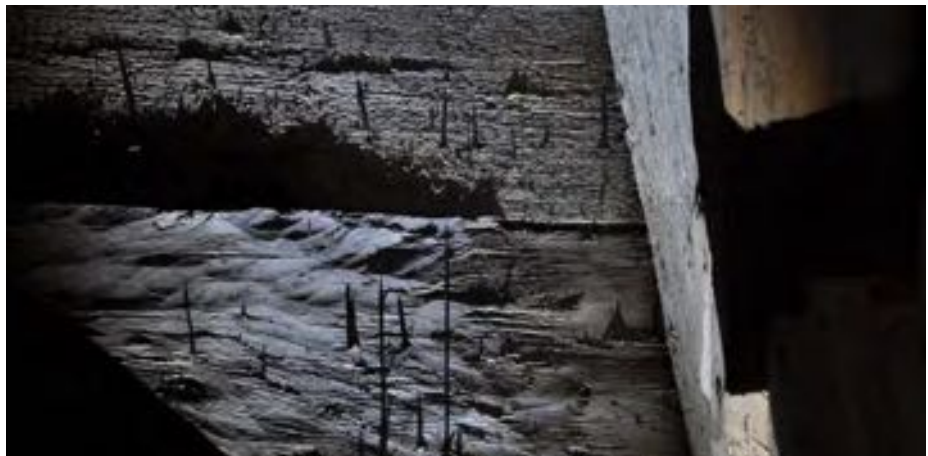
Underbrädorna som kläder tornets sidor och tak är av varierande sort. Vissa är kluvna eller huggna medan andra är ramsågade.
