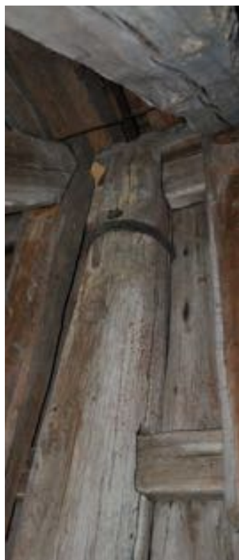
Tornets ben är runda ekstolpar. Även tvärplankorna är av ek.
