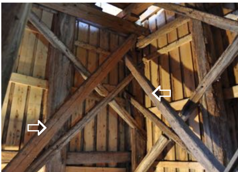
Extra bjälkar har satts in som förstärkning.
