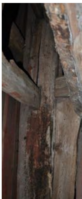
Tornets ben är runda ekstolpar. Även tvärplankorna är av ek.
