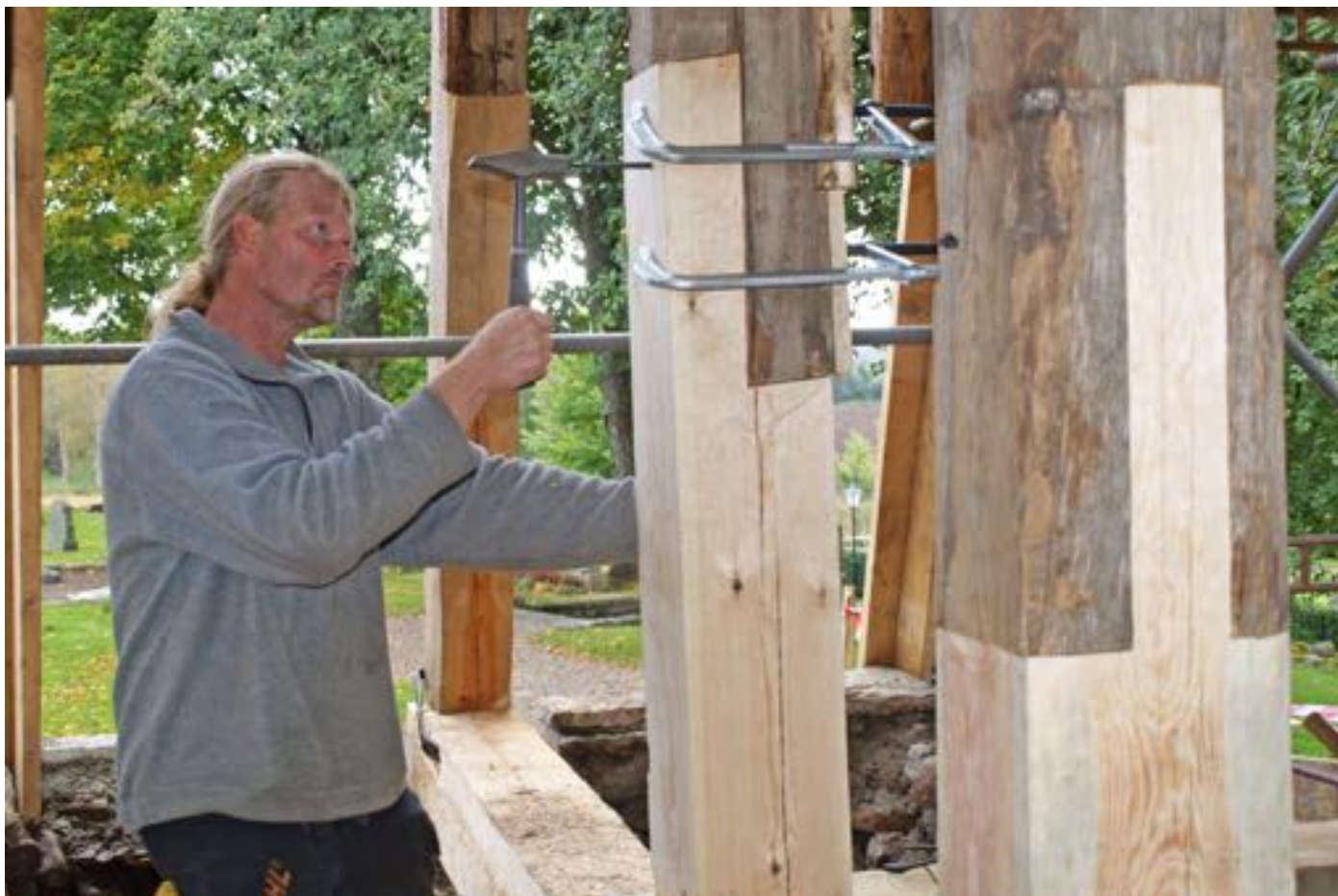
Bengt Bygdén skarvar högbenen på Marka klockstapel.
