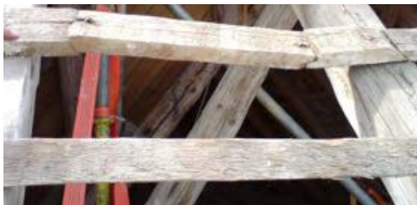
Extremt skarvad läkt berättar om tidigare underhåll.
