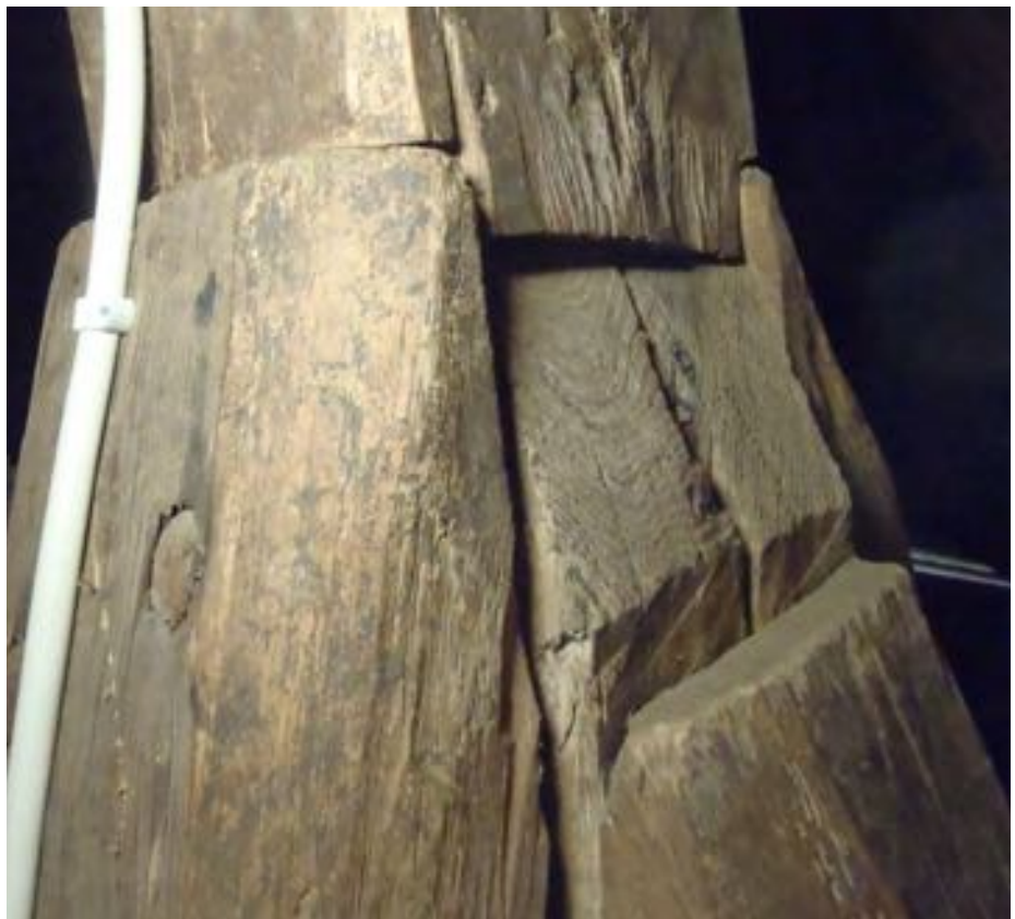
Bock och strävor möter hjärtstocken i en rak skarv.
