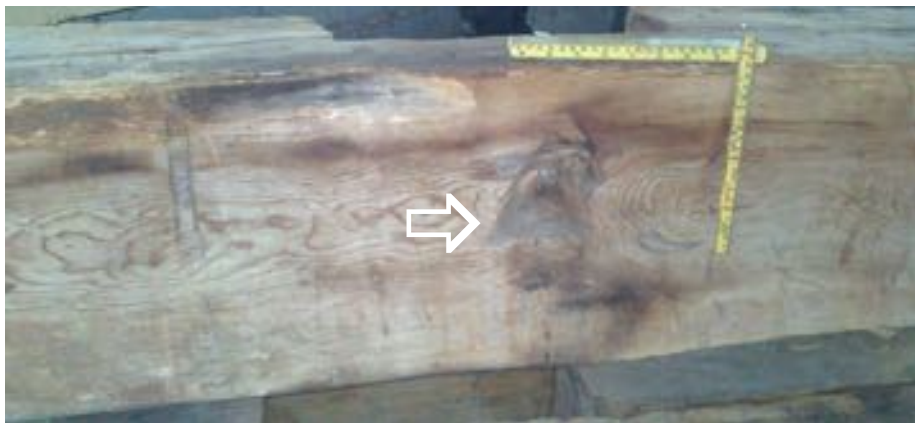
Spår av skrädning med relativt rakeggade, stora yxor.
