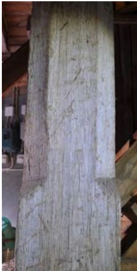
Fint fasade kanter på hjärtstocken.
