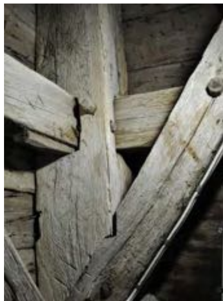
Knutar i ek och bjälkar med timmermansmärkning.
