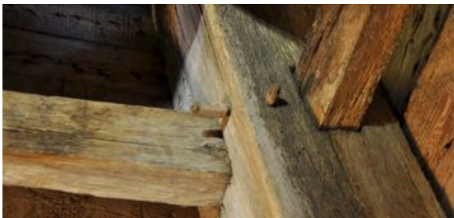
Tvärplankorna möts i hörnstolparna.
