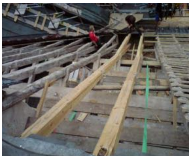
Avkapade högben med ”tillfälliga” iskarvade ben nedtill.
