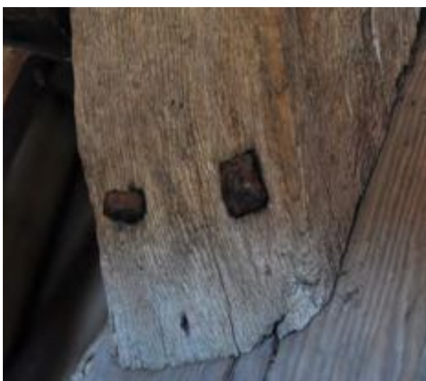
Två tidstypiska, stora spikar, en med karolinerhuvud och en med stor fyrkantig toppig fasett.
