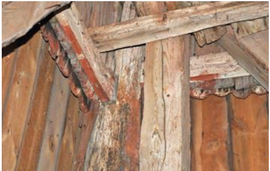
Äldre brädklädsel med spån, sett från stapelns insida.
