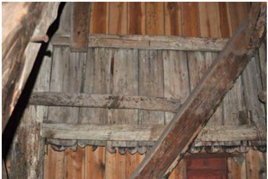
Den gamla och den nyare stapelkonstruktionen sida vid sida.
