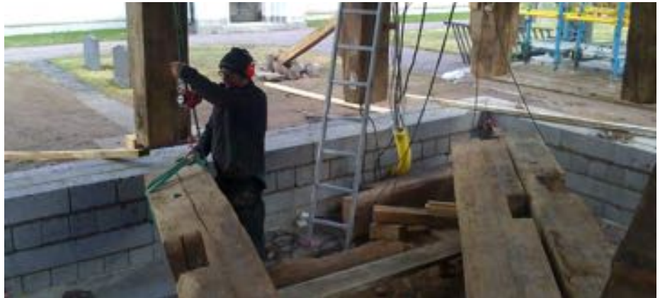
Här demonteras de inre klämsyllarna som förvarades inne i tornet under reparationen.
