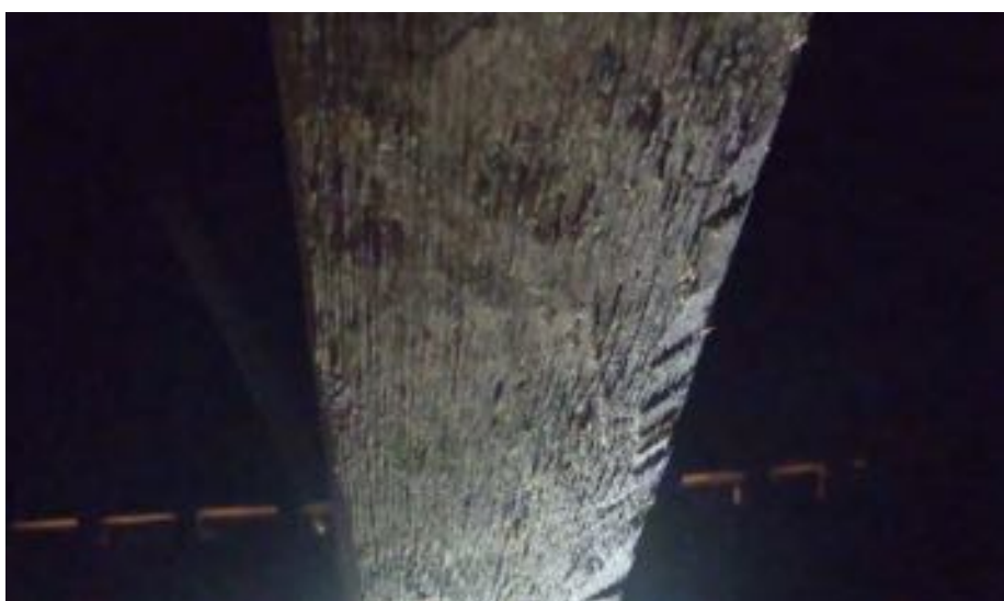
"Efterbreddbilad" sträva, Forshems kyrka.
