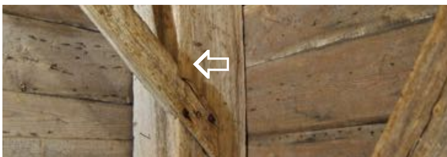
Hörnstolpen är ca 35cm i fyrkant, och kryssträvorna är 15cm x 8cm. Det krävs virke av den dimensionen för att tygla klockornas krafter i nära 650 år. Knut med låsande nacke.
