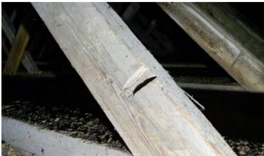
Spår av behuggningsprocess, klamphuggning i Marums kyrka.
