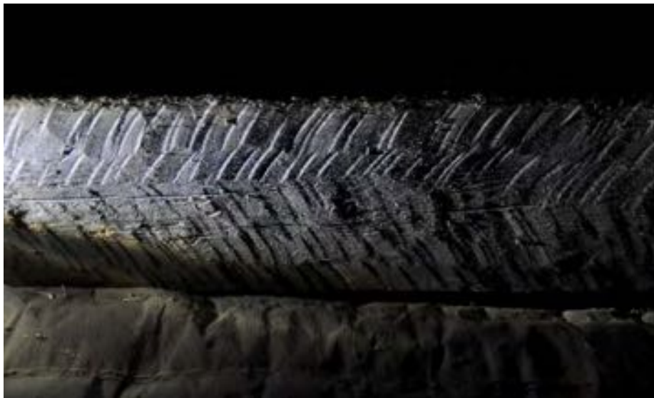
Sprätthuggning i band, bindbjälke, Skälunda kyrka.
