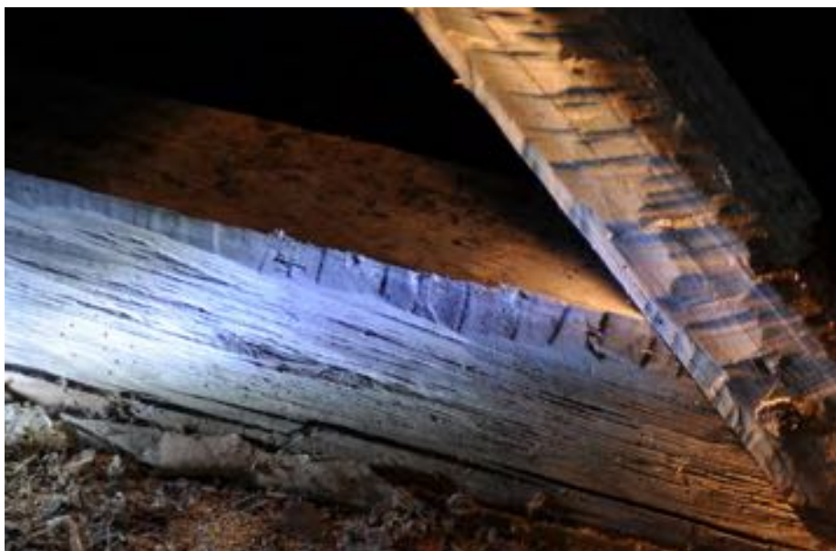
Efterbreddbilat på bindbjälke, Sveneby kyrka.
