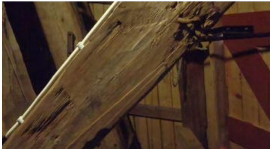
Hjälpligt handhyvlade bjälkar.
