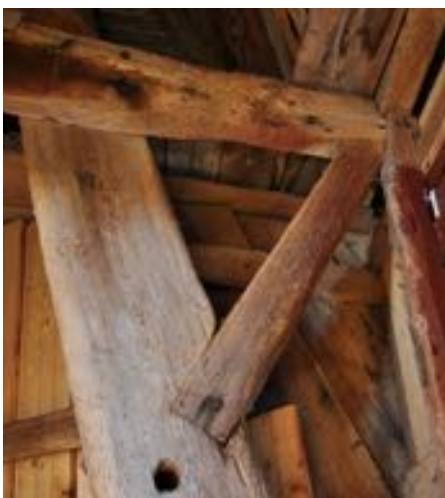
Konsolsträvorna är fästa med en stor spik i en rakt husad knut.
