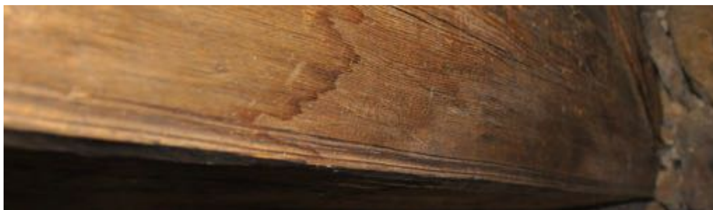
Profil på bjälke i Gökhemms kyrka.
