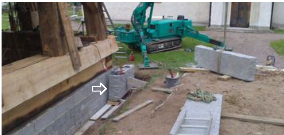
Luftspalt mellan lecablock och granitsockel.
