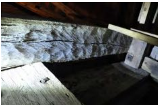
Notera och dokumentera verktygsspår som berättar om teknik och hantverkarens arbetssätt.
