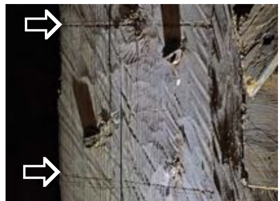
Ritsar utan exakthet för att visa var tvärplankans hål ska huggas. Vanligt i medeltida konstruktioner.
