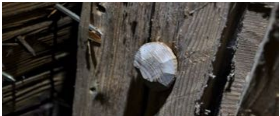
Dymling med huvud täjlt som spikskalle.
