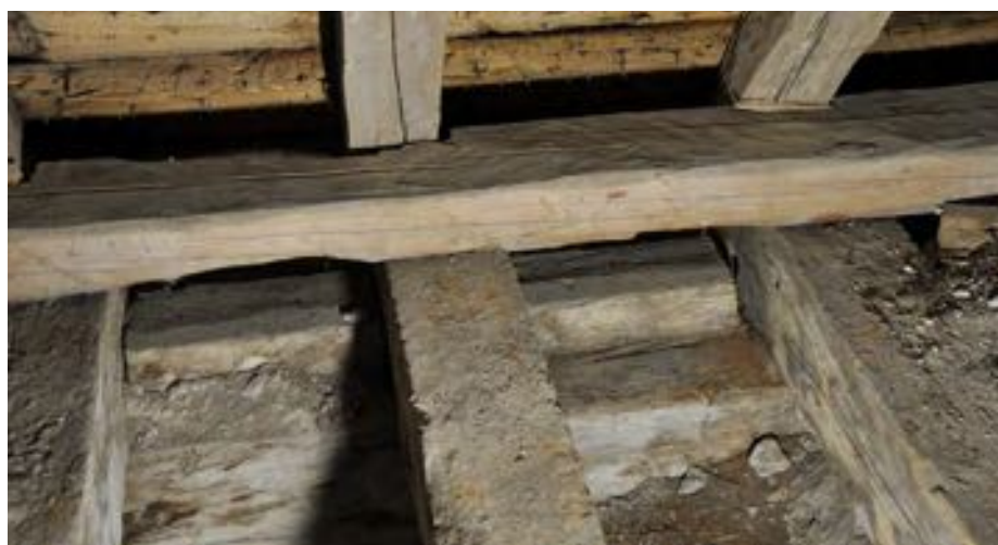
Remstycke och bindbjälkar i Ods kyrka.
