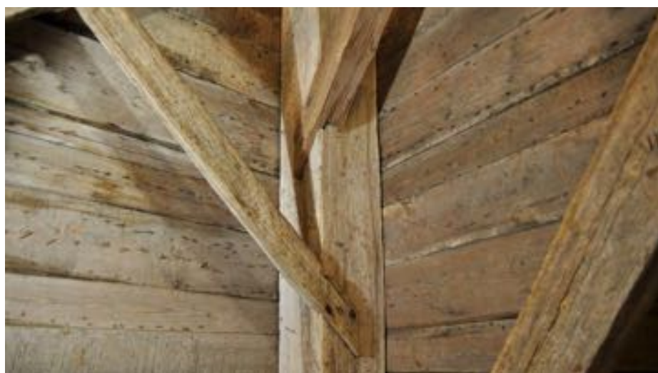
Knutpunkter med låsande nacke.
