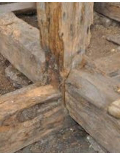
Möte mellan bocksyll, tvärsyll och mittstock. Rötsakadat virke.
